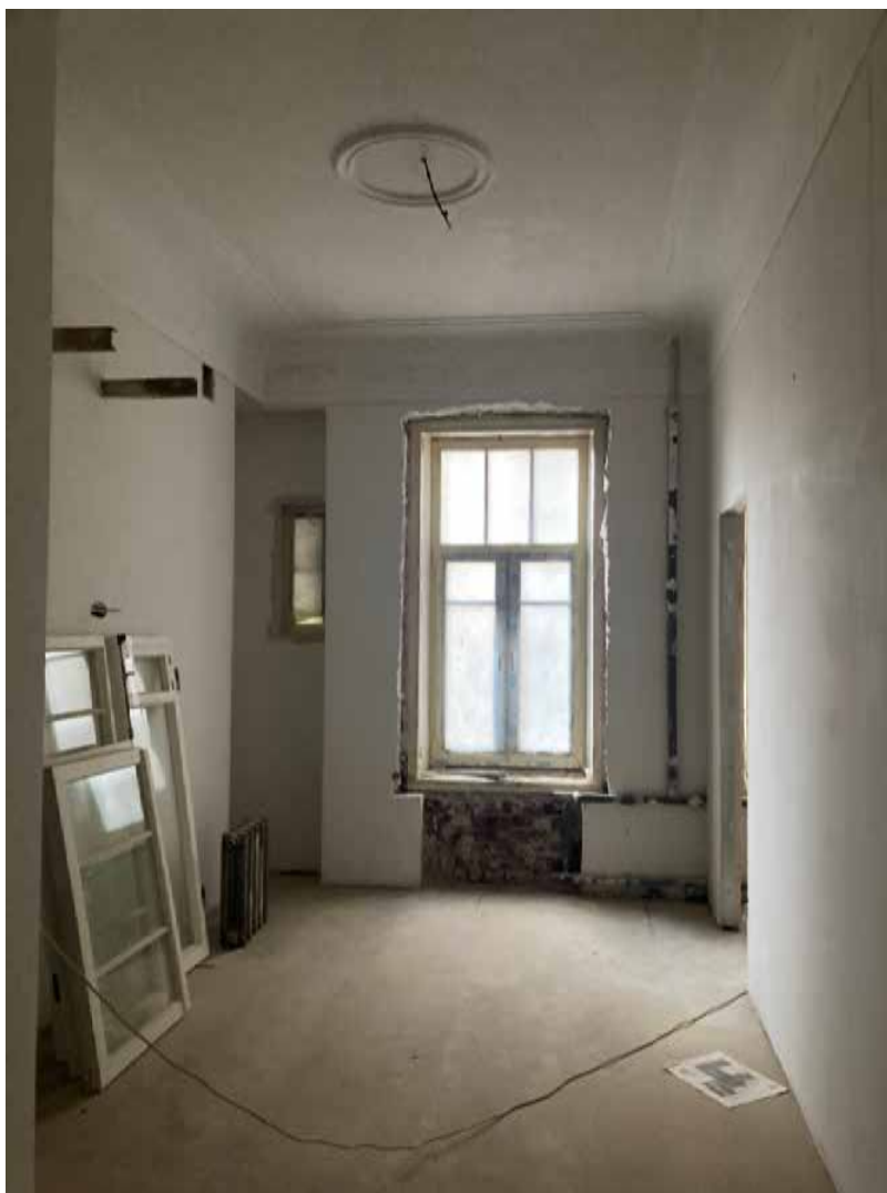
41. Помещение в квартире №17. Общий вид. Дата съемки: 10.03.2025
