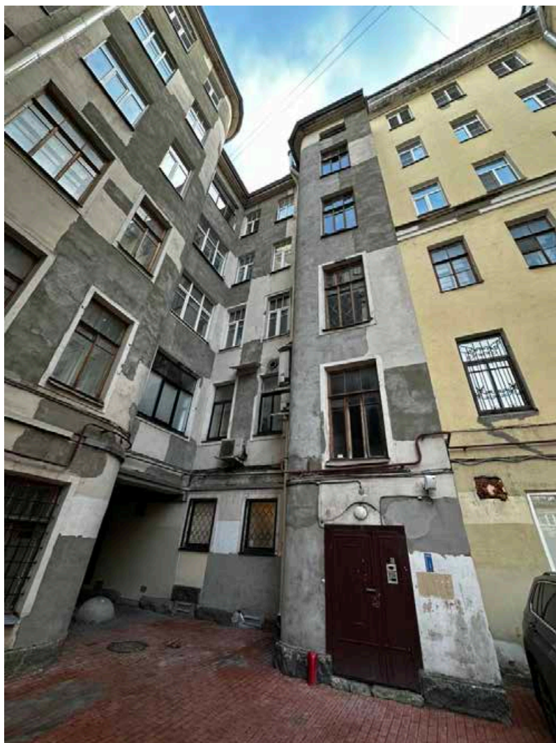
54. Дворовой фасад. Общий вид. Дата съемки: 10.03.2025
