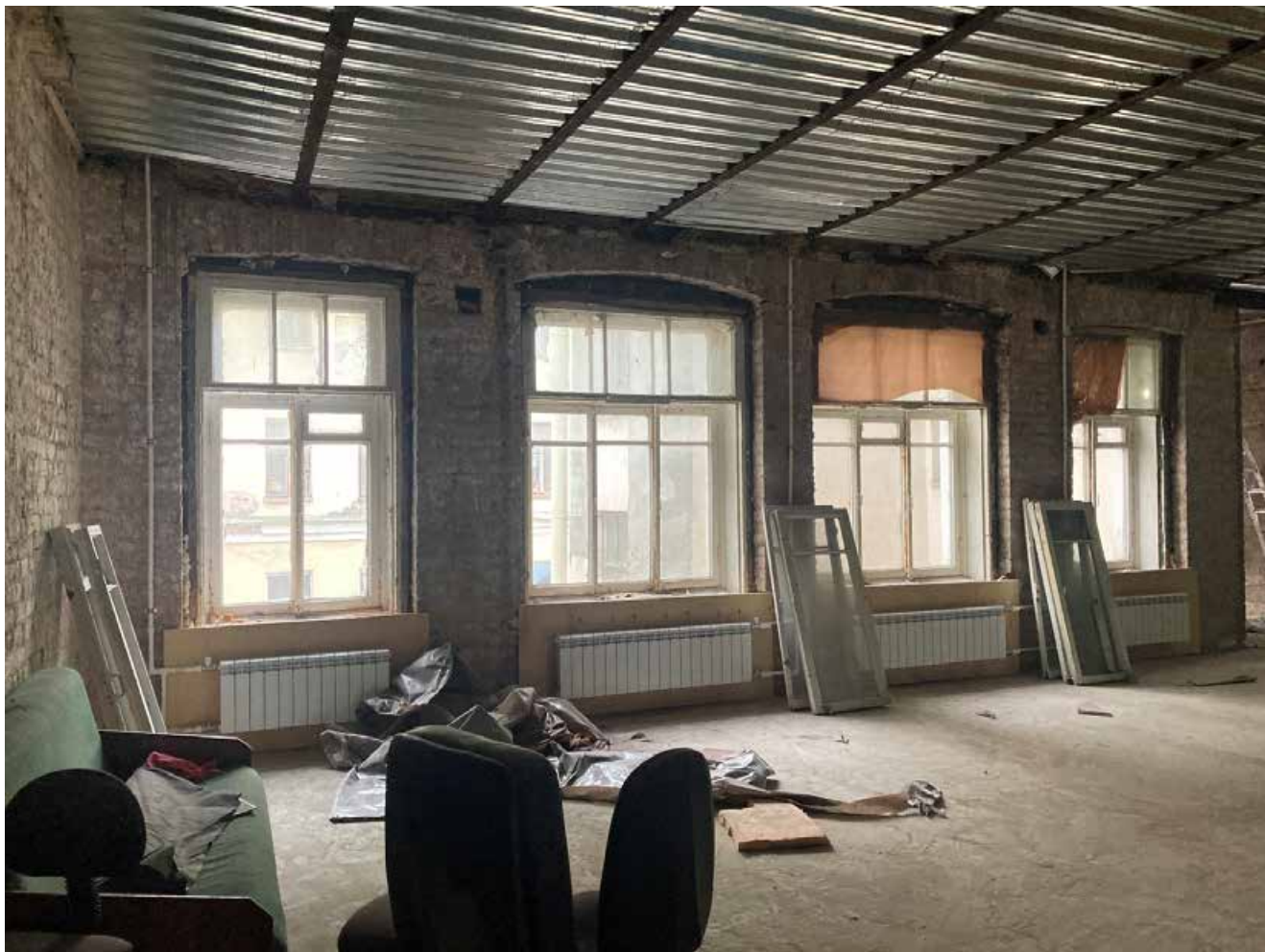
29. Помещение в квартире №19. Общий вид. Дата съемки: 10.03.2025
