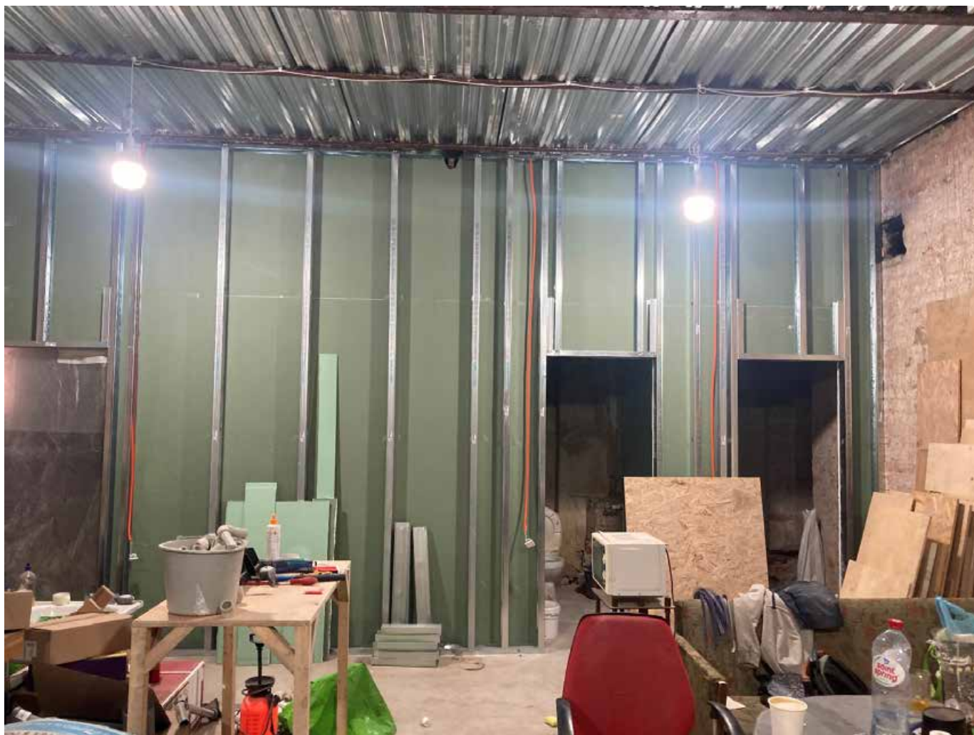
50. Помещение в квартире №12. Общий вид. Дата съемки: 10.03.2025
