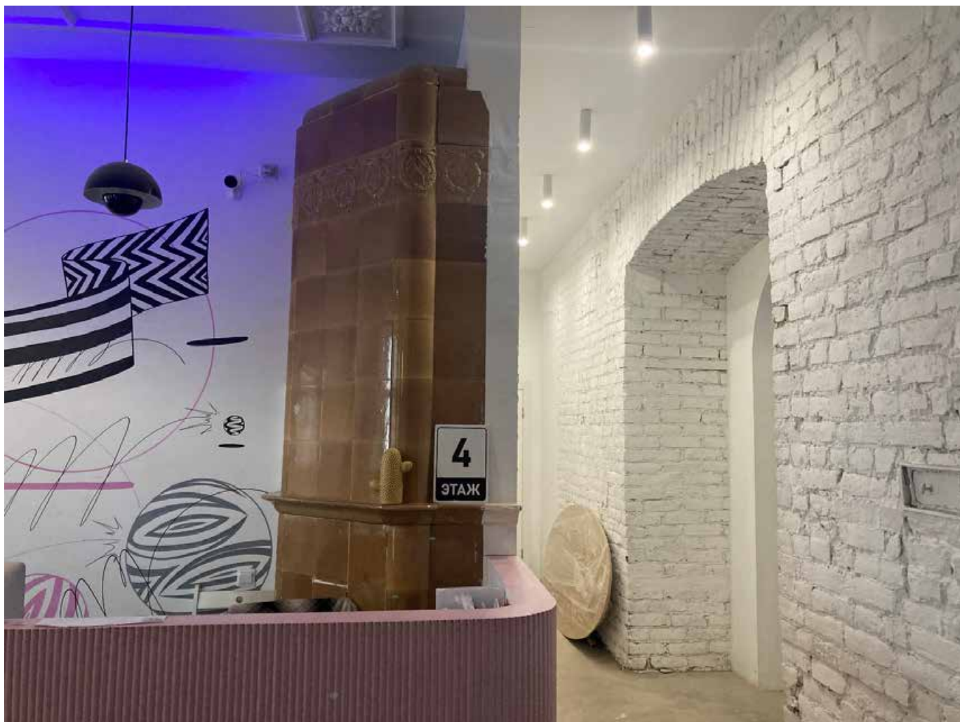
23. Помещение в квартире №21. Общий вид. Дата съемки: 10.03.2025
