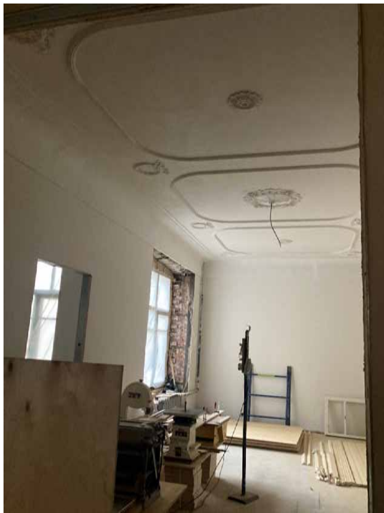
42. Помещение в квартире №17. Общий вид. Дата съемки: 10.03.2025
