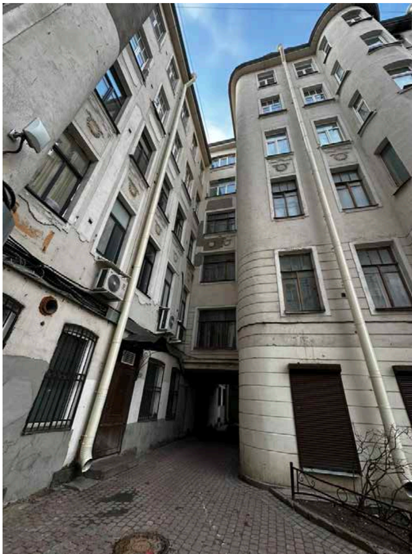
53. Дворовой фасад. Общий вид. Дата съемки: 10.03.2025
