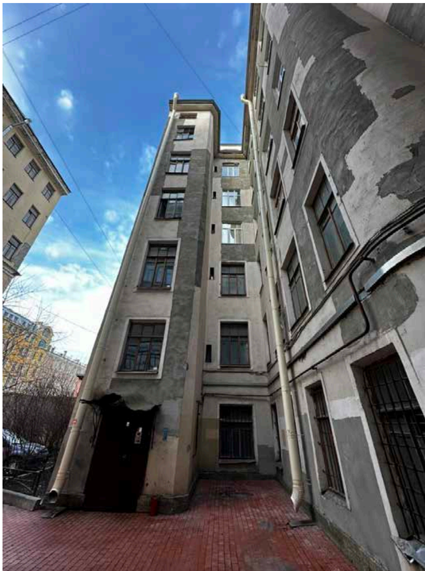
55. Дворовой фасад. Общий вид. Дата съемки: 10.03.2025
