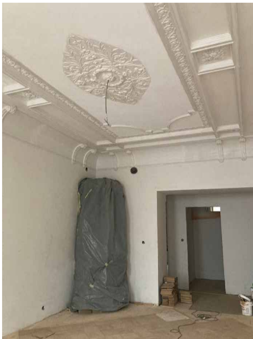
38. Помещение в квартире №17. Общий вид. Дата съемки: 10.03.2025
