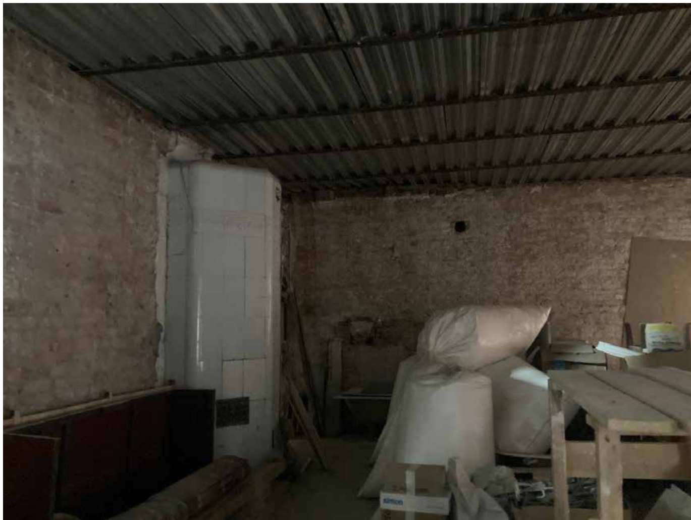
49. Помещение в квартире №12. Общий вид. Дата съемки: 10.03.2025
