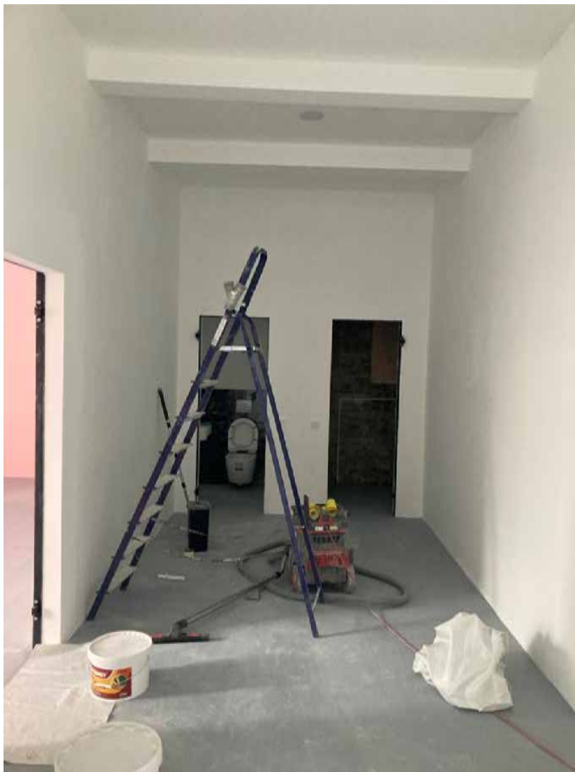
14. Помещение в квартире №25. Общий вид. Дата съемки: 10.03.2025
