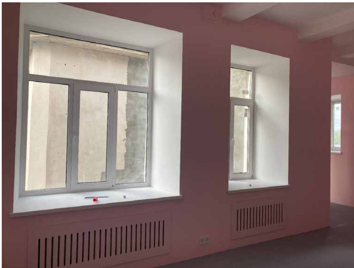
16. Помещение в квартире №25. Общий вид. Дата съемки: 10.03.2025
