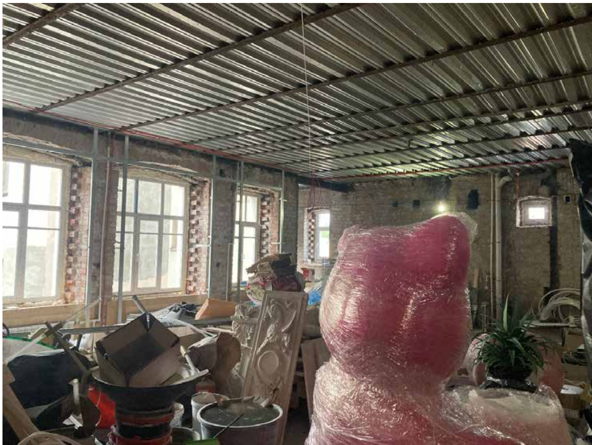
18. Помещение в квартире №22. Общий вид. Дата съемки: 10.03.2025
