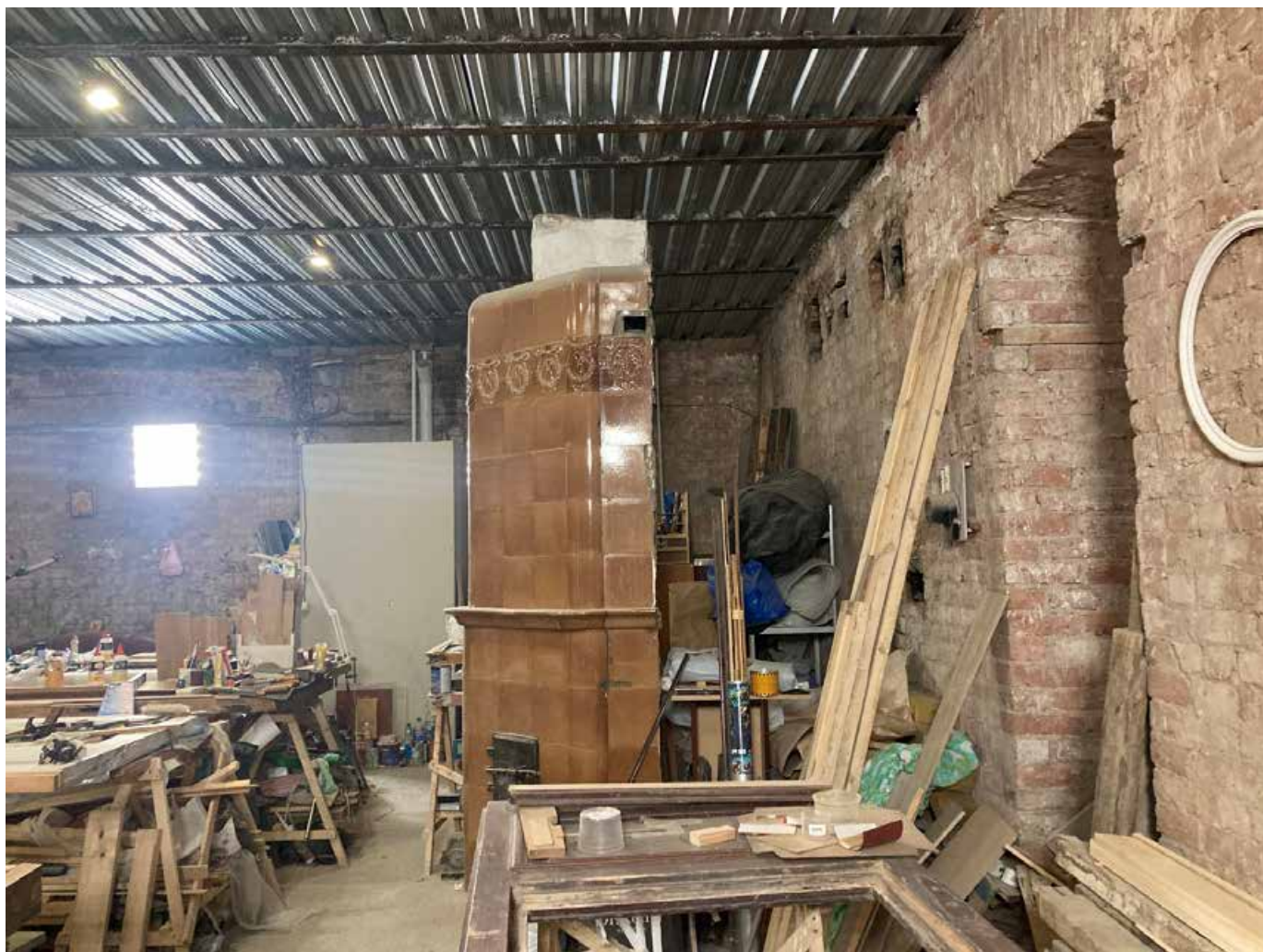
44. Помещение в квартире №15-16. Общий вид. Дата съемки: 10.03.2025
