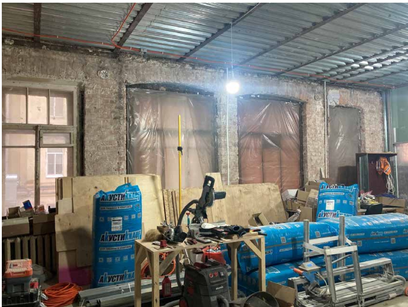
47. Помещение в квартире №12. Общий вид. Дата съемки: 10.03.2025
