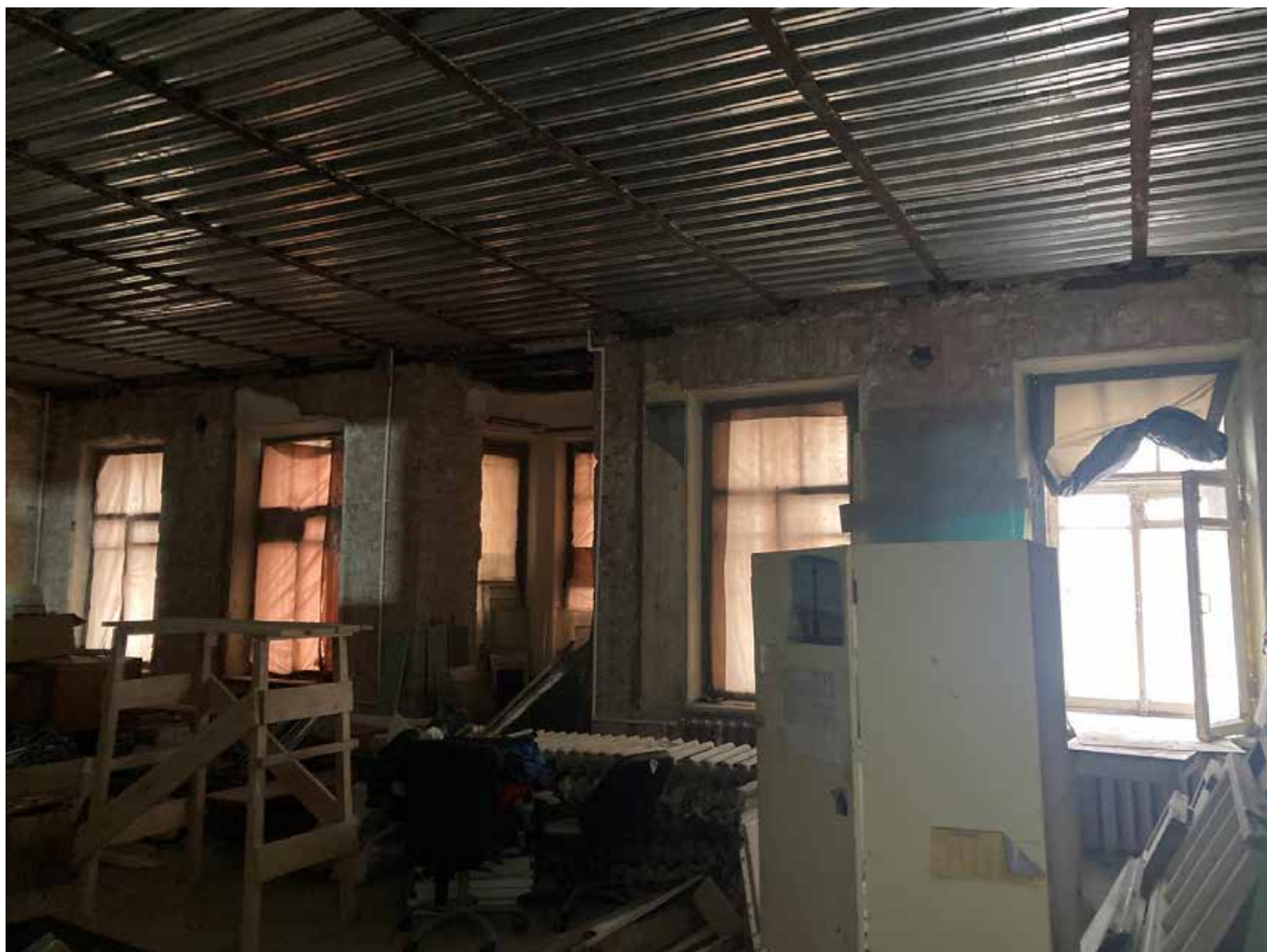
48. Помещение в квартире №12. Общий вид. Дата съемки: 10.03.2025
