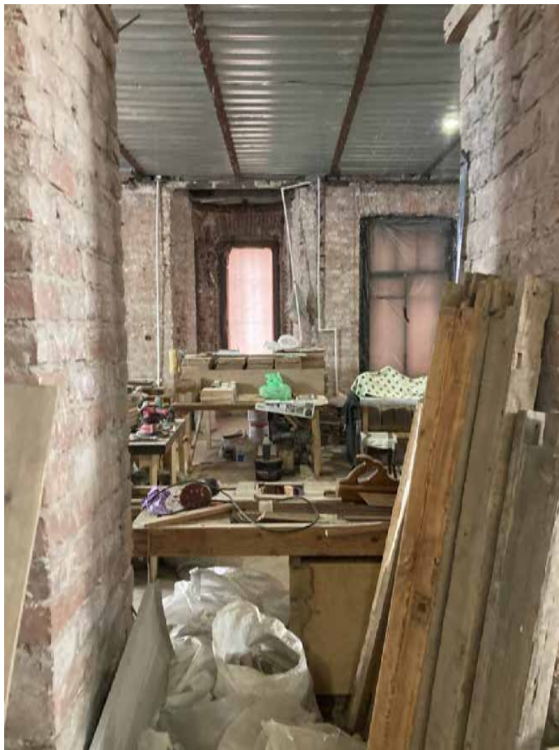
46. Помещение в квартире №15-16. Общий вид. Дата съемки: 10.03.2025
