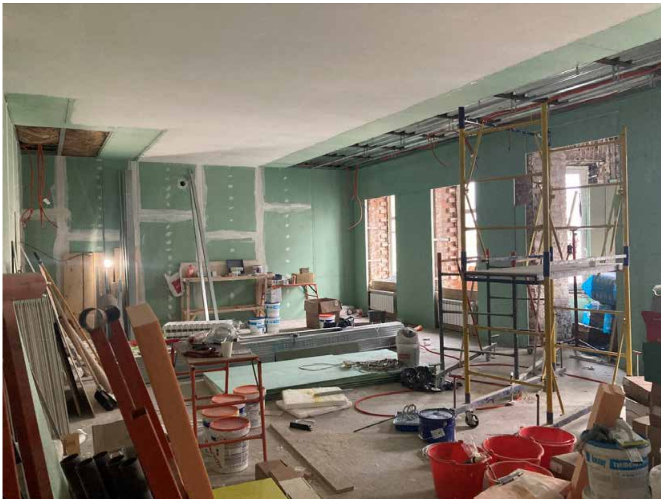
19. Помещение в квартире №22. Общий вид. Дата съемки: 10.03.2025
