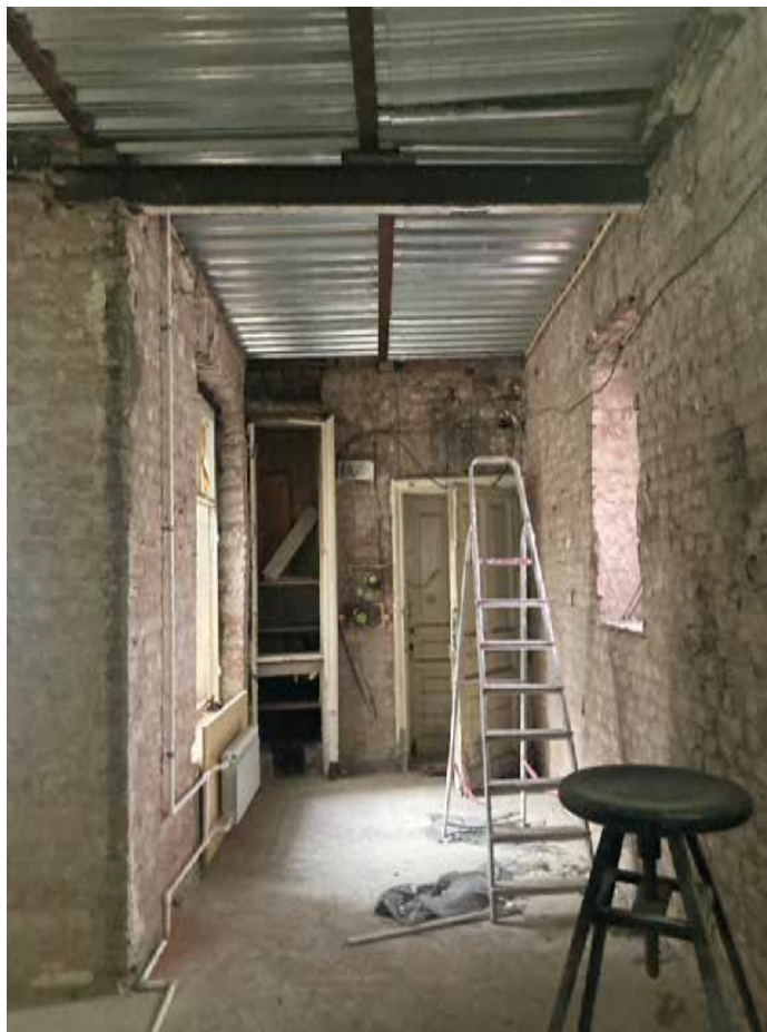
30. Помещение в квартире №19. Общий вид. Дата съемки: 10.03.2025
