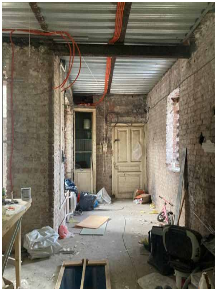
20. Помещение в квартире №22. Общий вид. Дата съемки: 10.03.2025
