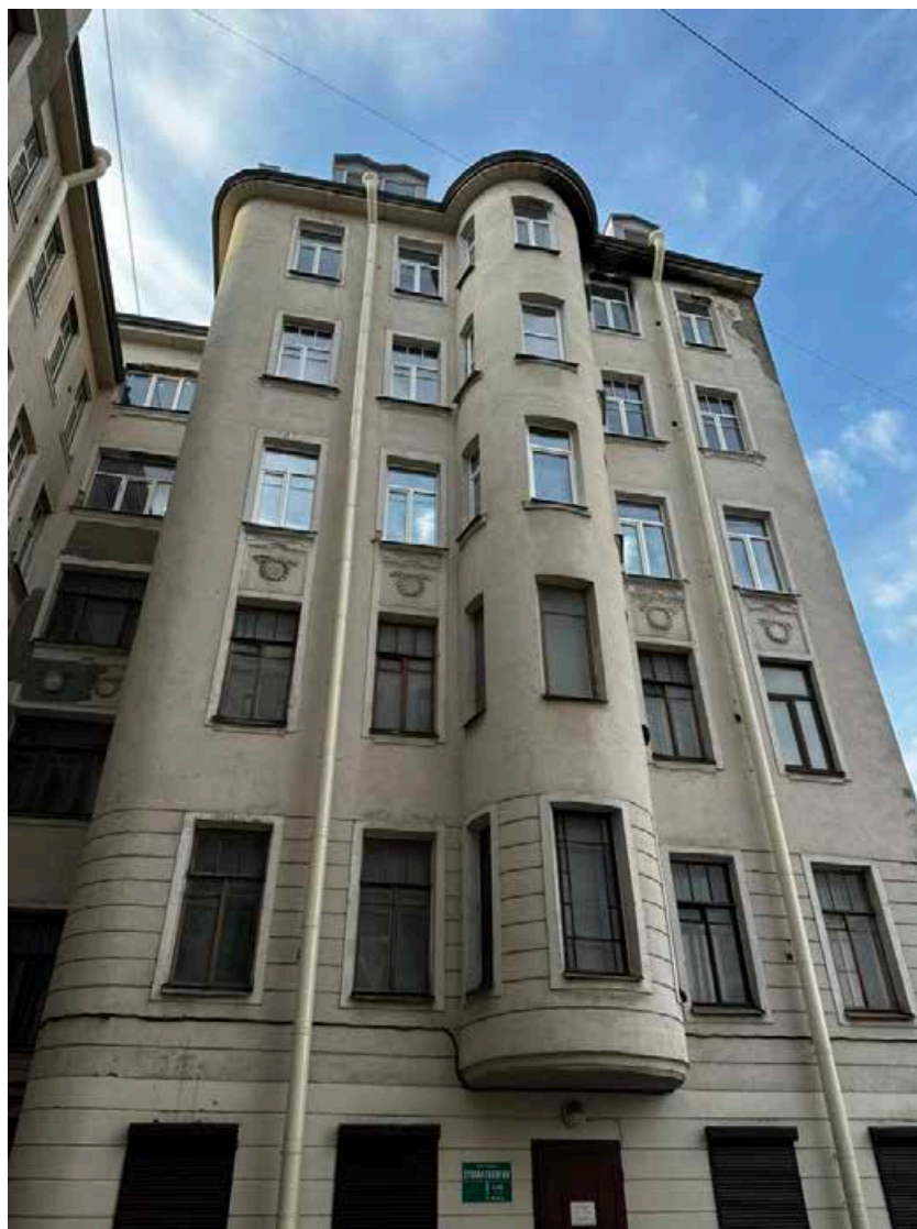
51. Дворовой фасад. Общий вид. Дата съемки: 10.03.2025
