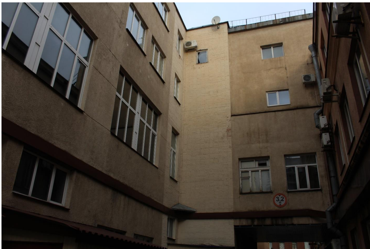
Фото 27. Вид на переход, соединяющий нежилые здания по адресу: Малый Сампсониевский пр., д. 4, лит. А и Малый Сампсониевский пр., д. 2, лит. А.
