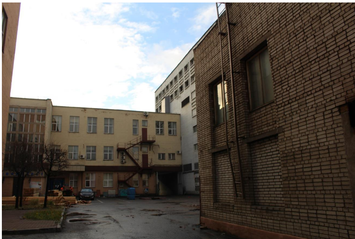
Фото 19. Вид на северный фасад юго-западной части нежилого здания по адресу: Большой Сампсониевский пр., д. 32, лит. А и восточный фасад нежилого здания по адресу: ул. Фокина, д. 1, корп. 2, лит. А.
