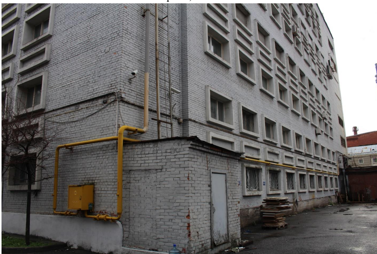
Фото 22. Вид на западный фасад нежилого здания по адресу: ул. Фокина, д. 1, корп. 1, лит. А.
