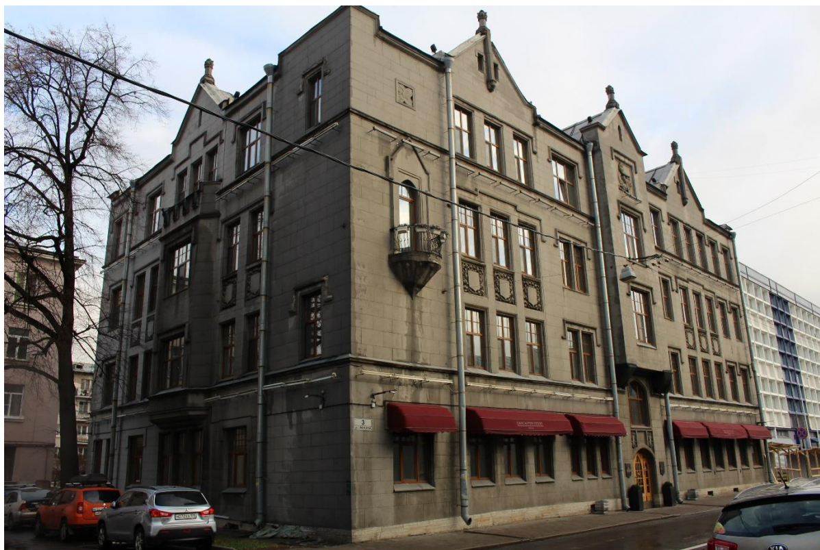
Фото 3. Вид на западный и южный фасады выявленного объекта культурного наследия «Жилое и конторское здание Товарищества Сампсониевской бумагопрядильной мануфактуры».
