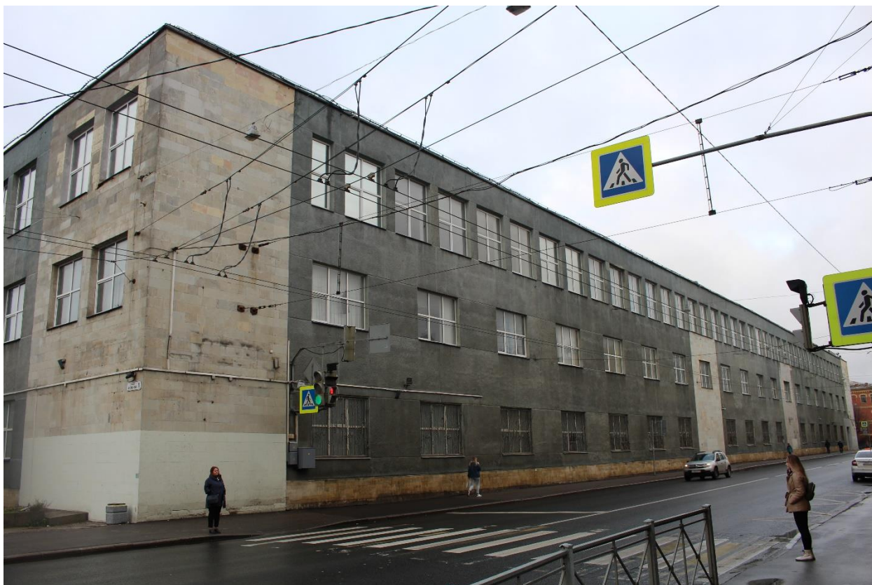
Фото 11. Вид на восточный фасад нежилого здания по адресу: Большой Сампсониевский пр., д. 32, лит. А.
