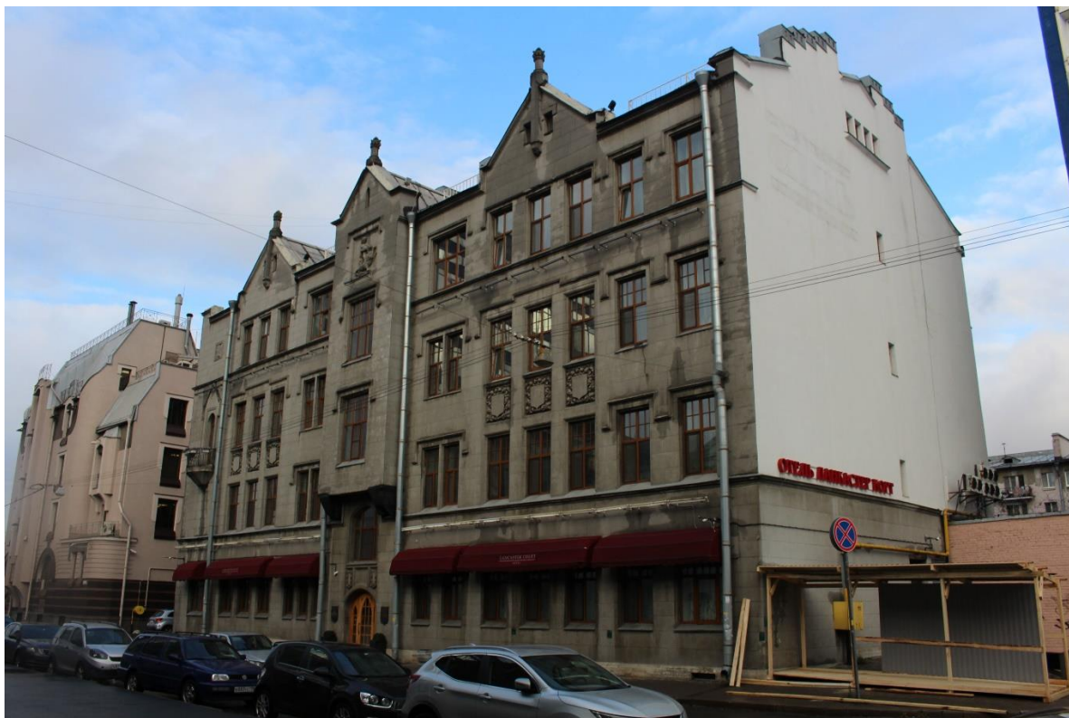
Фото 1. Вид на южный и восточный фасады выявленного объекта культурного наследия «Жилое и конторское здание Товарищества Сампсониевской бумагопрядильной мануфактуры».
