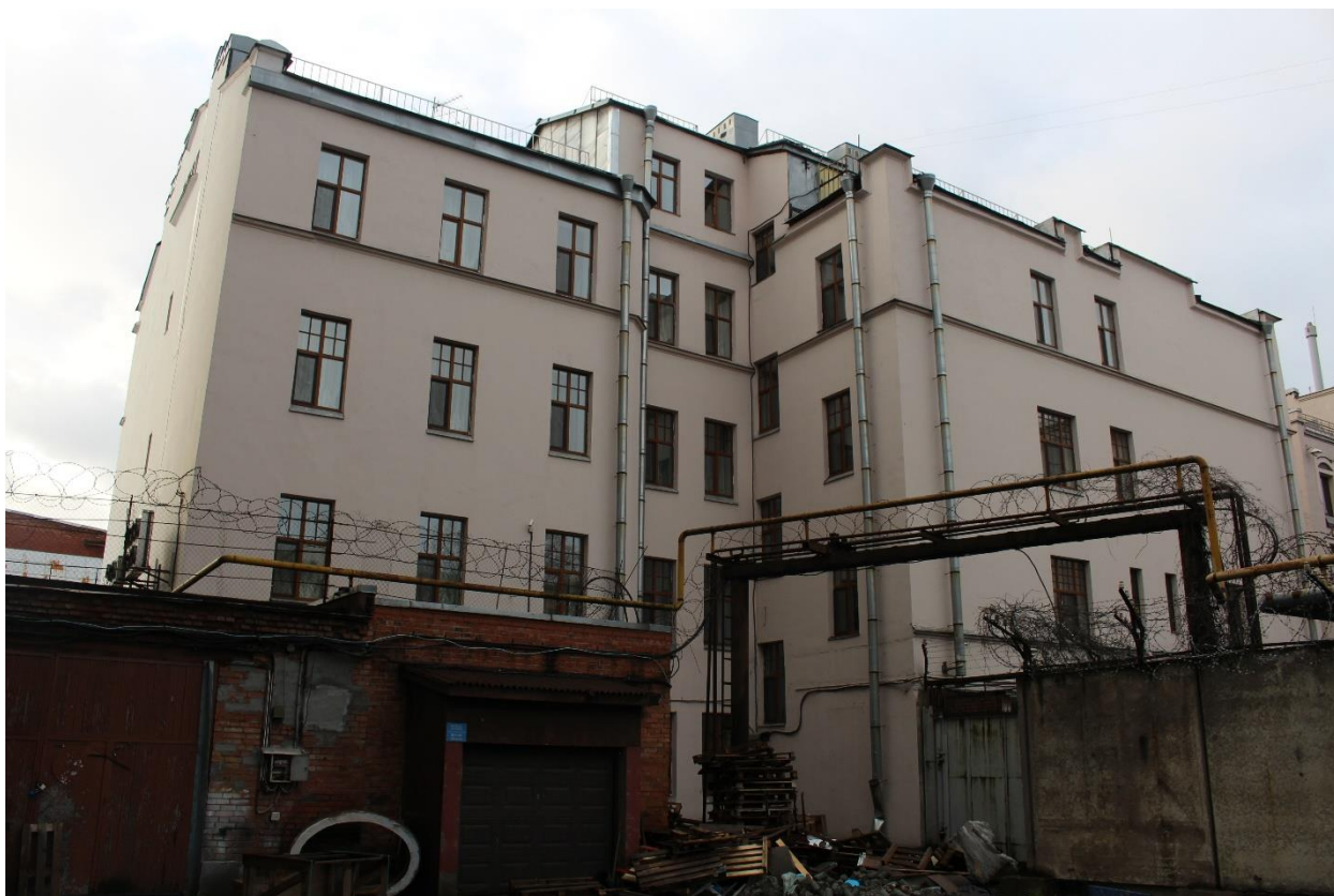
Фото 23. Вид на северный фасад выявленного объекта культурного наследия «Жилое и конторское здание Товарищества Сампсониевской бумагопрядильной мануфактуры».
