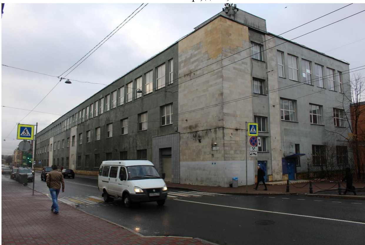
Фото 10. Вид на восточный и северный фасады нежилого здания по адресу: Большой Сампсониевский пр., д. 32, лит. А.
