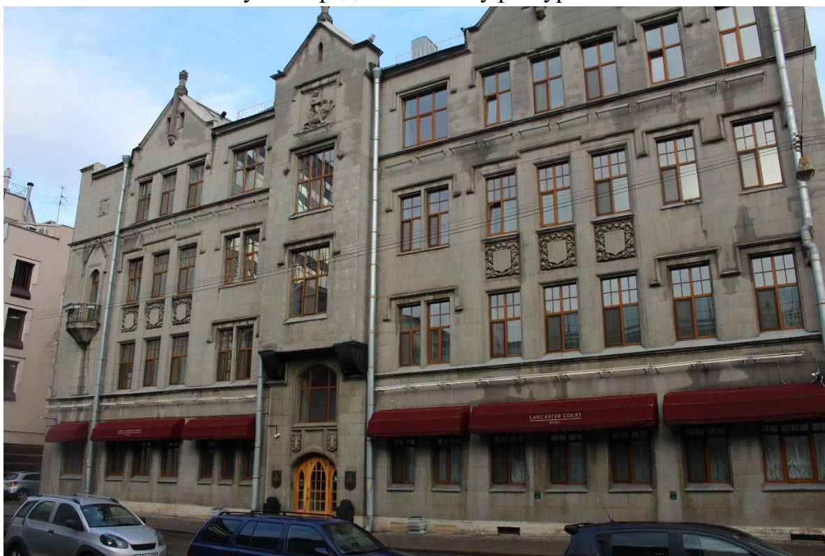
Фото 2. Вид на южный фасад выявленного объекта культурного наследия «Жилое и конторское здание Товарищества Сампсониевской бумагопрядильной мануфактуры».
