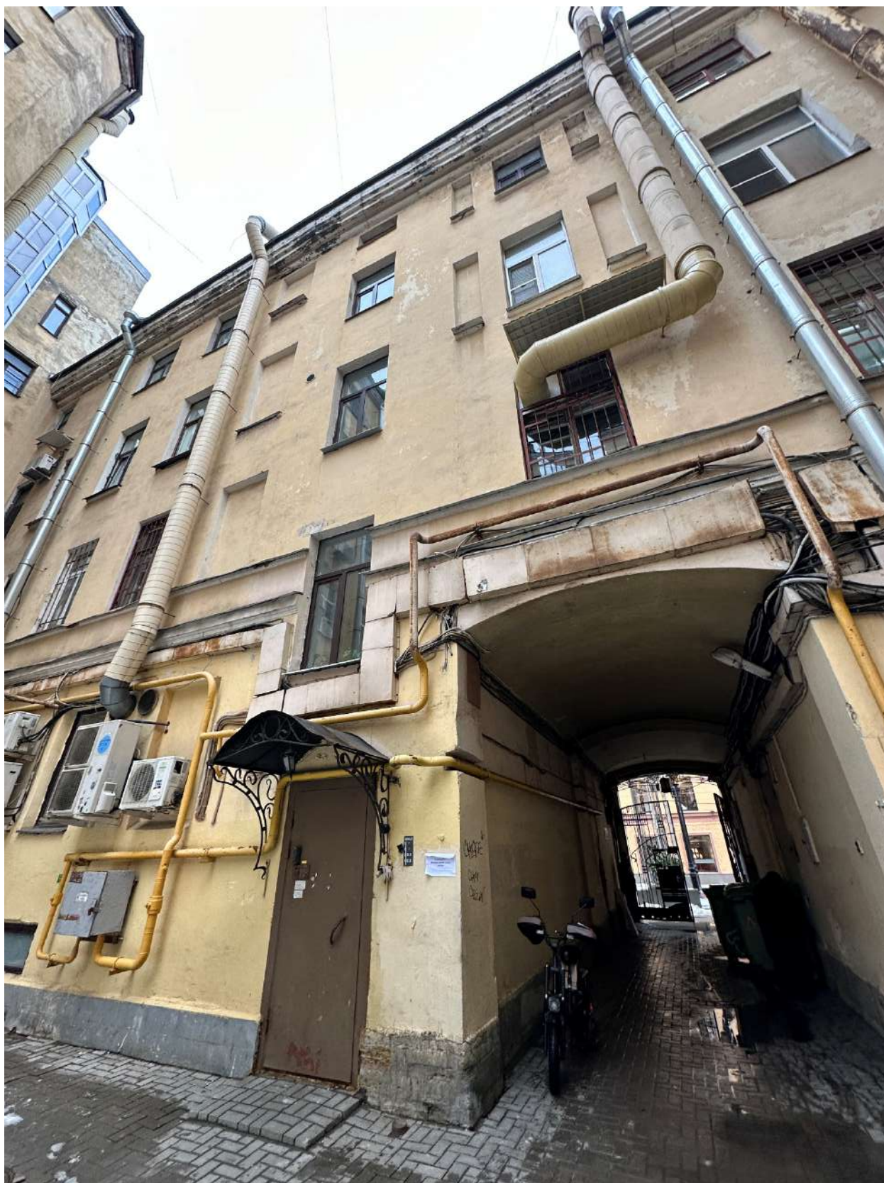
Фото 16. Общий вид на объект со стороны дворового фасада.
