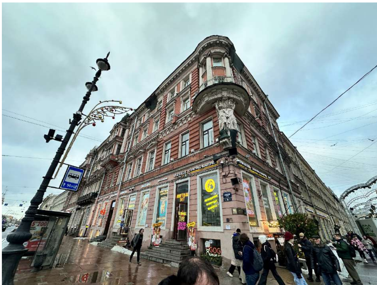
Фото 3. Общий вид на объект. Лицевой фасад со стороны Невского пр. и Малой Садовой ул.
