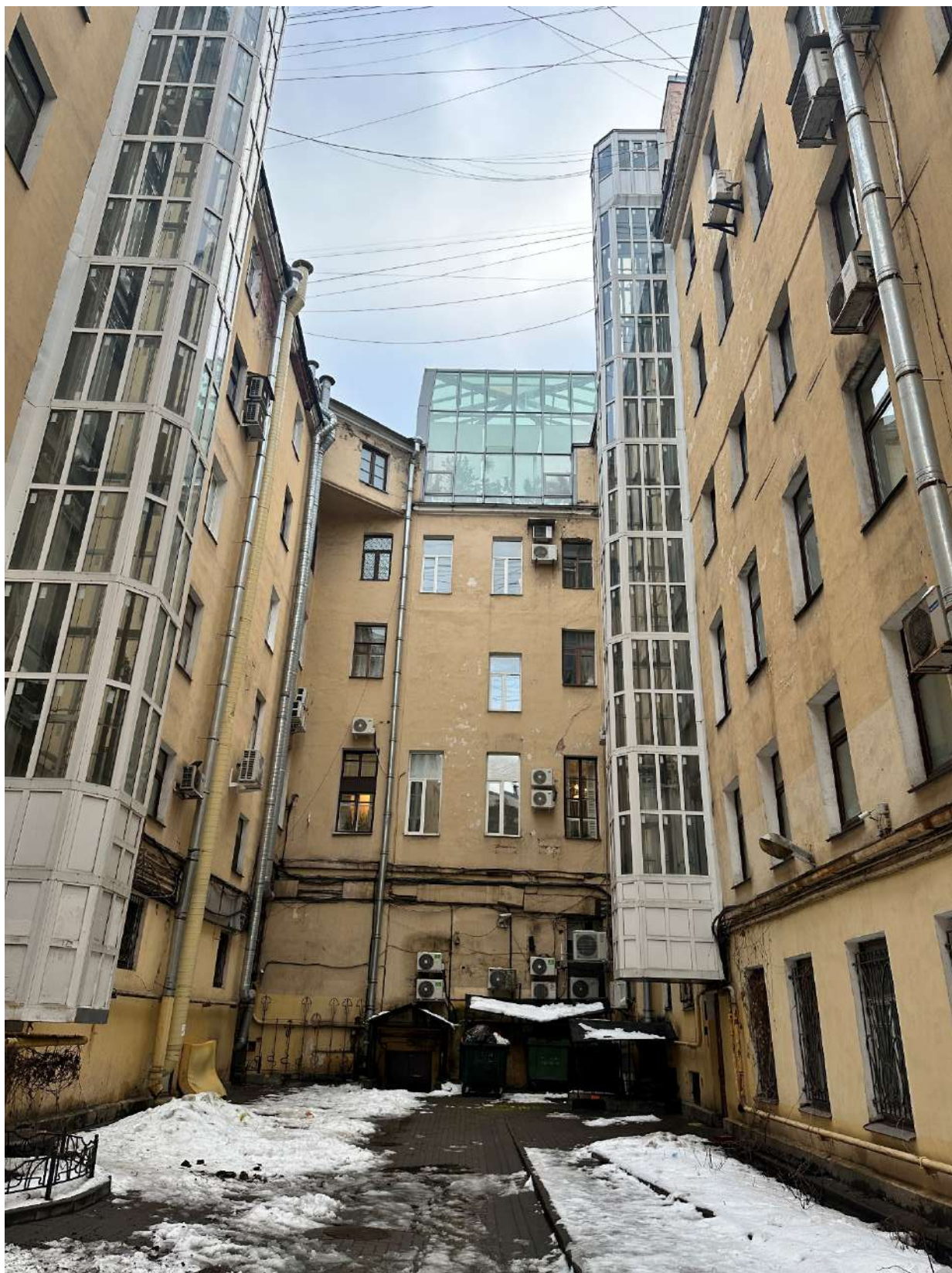
Фото 18. Общий вид на объект со стороны дворового фасада.
