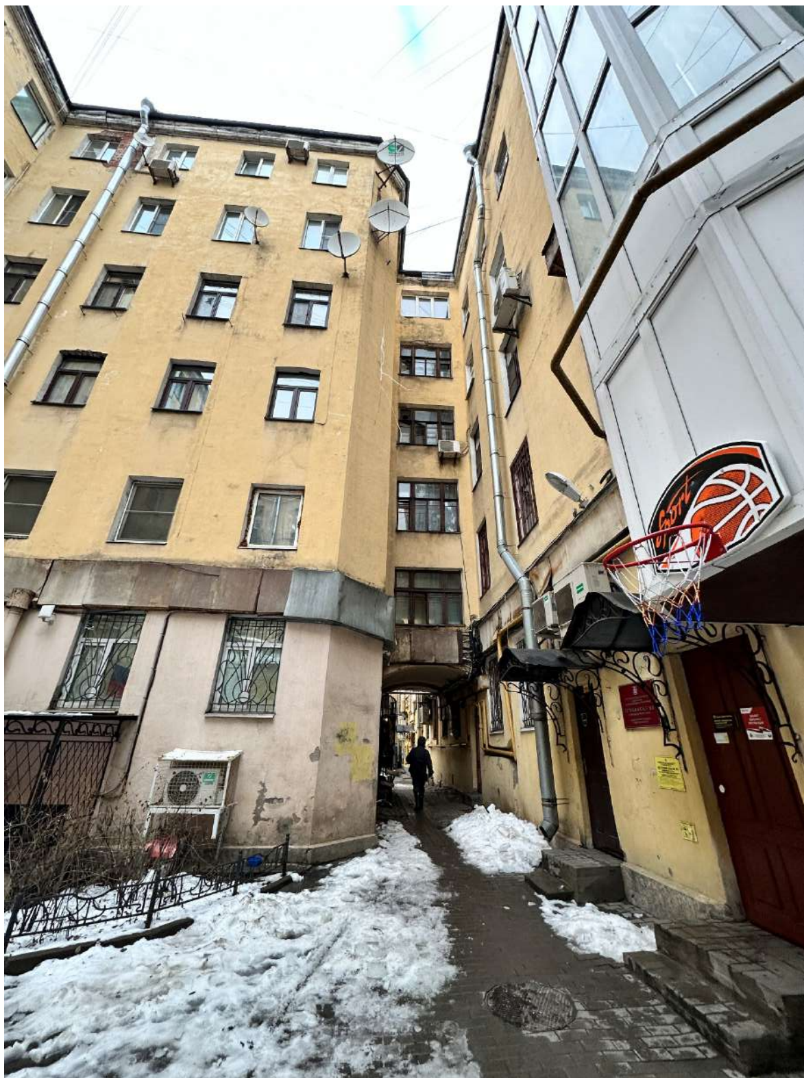
Фото 12. Общий вид на объект со стороны дворового фасада.
