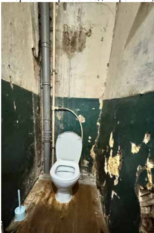
Фото 8. Интерьер квартиры №39 объекта культурного наследия регионального значения «Дом по наб. р. Мойки (с флигелями)», входящего в состав объекта культурного наследия регионального значения «Доходные дома фон Дервиза П.П. (великих князей Бориса и Кирилла Владимировичей)»
