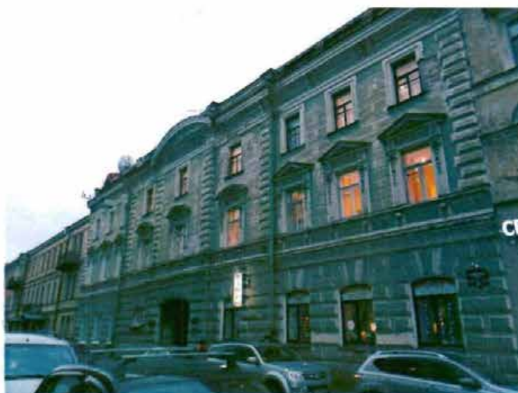
4, 5. Южный двор. Южный и северный фасады
