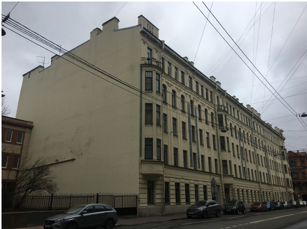
3. Вид лицевого фасада с ул. Бородинской в направлении пр. Загородного.
