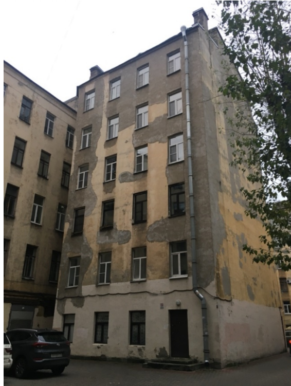
4. Вид дворового фасада. Направление съемки юго-восток.
