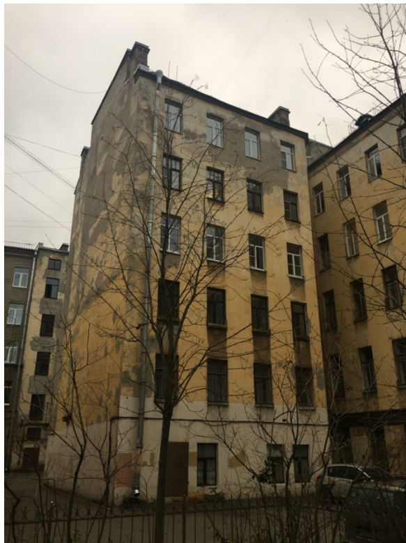
5. Вид дворового фасада. Направление съемки юго-восток.
