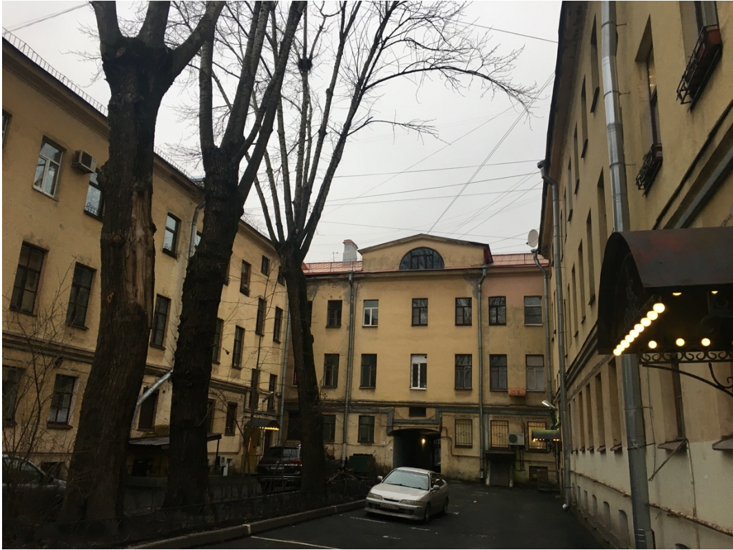
5. Вид дворового фасада дома. Направление съемки северо-запад.
