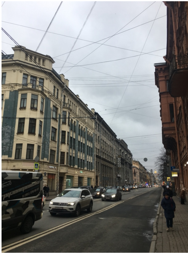
2. Вид лицевого фасада с пр. Загородного
