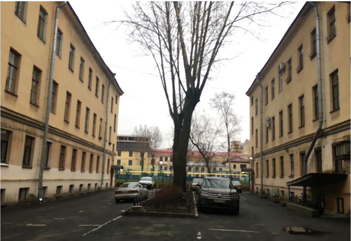
4. Вид дворового фасада дома № 36. Направление съемки юг-восток.
