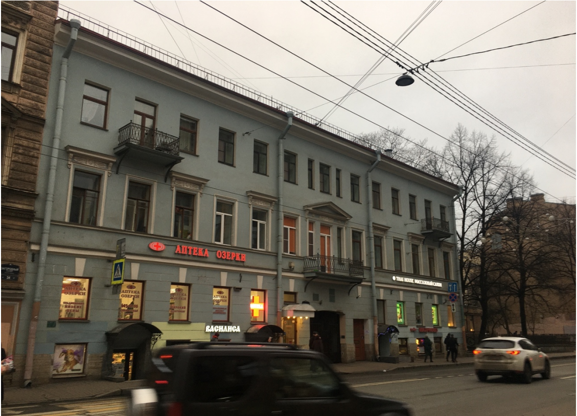
3. Вид лицевого фасада дома № 36 с пр. Загородного
