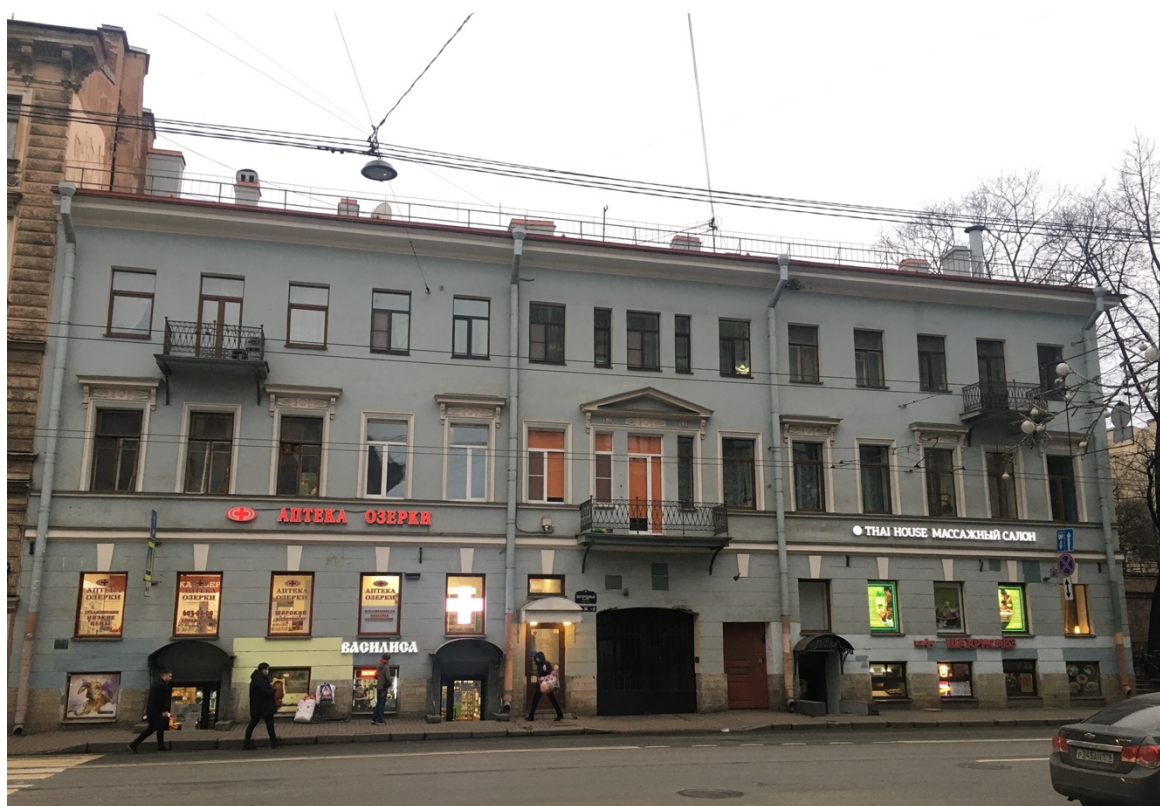
2. Вид лицевого фасада дома № 36 с пр. Загородного.
