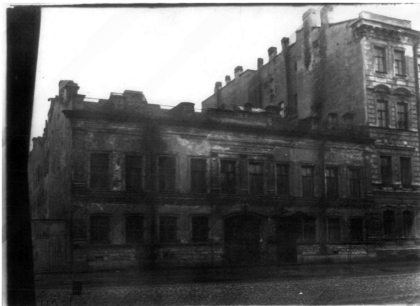
22. Вид фасада жилого дома №28 на 5-й линии Васильевского острова, справа – дом №30. Автор фото неизвестен. 1947 г. // Источник: ЦГАКФФД СПб Вр 75122. [Электронный ресурс] URL: https://spbarchives.ru/infres/-/archive/cgakffd/photo/vr75122 (дата обращения: 06.05.2024).
