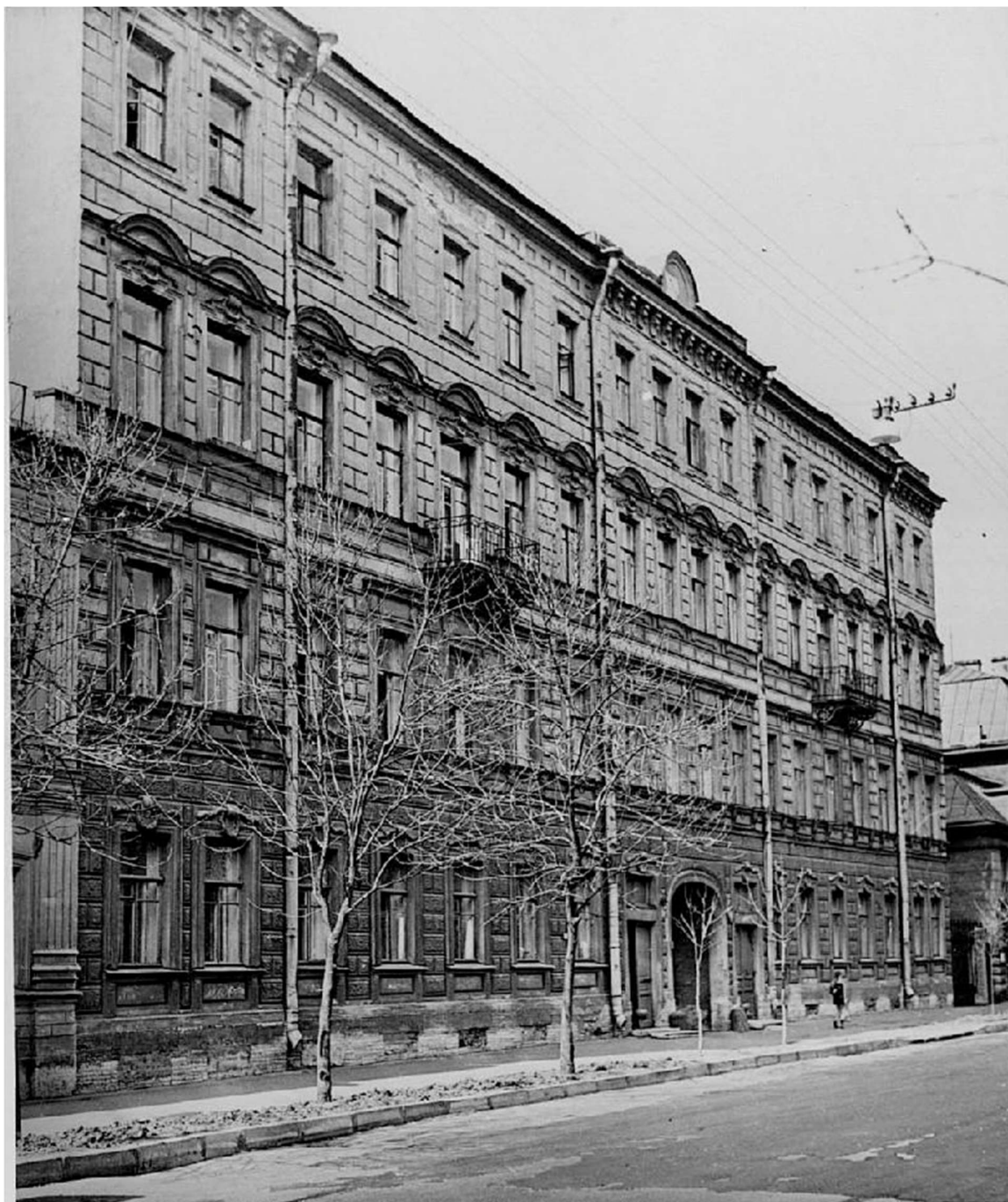
25. Василеостровский район, 5-я линия, дом 30. Автор фото – Куприянова В.И.
