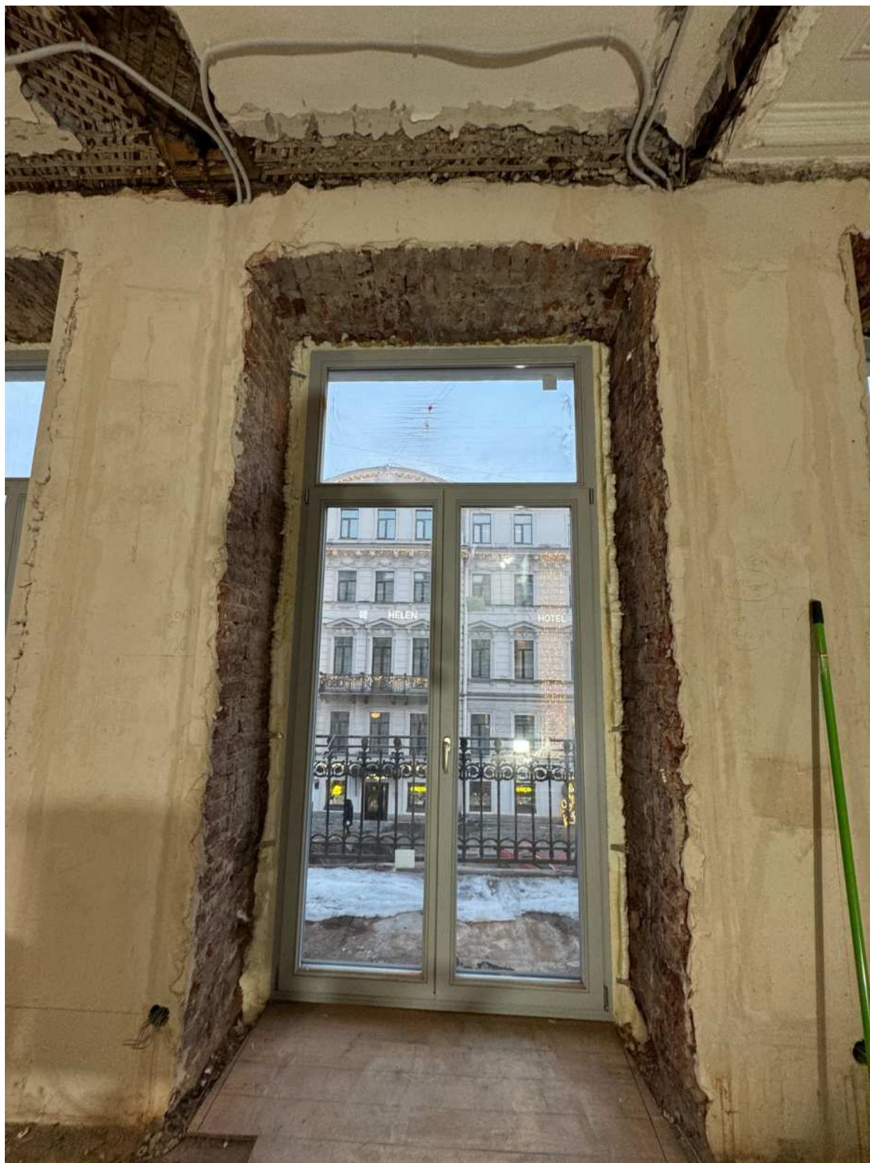
Фото 30. Вид на балконное дверное заполнение квартиры № 44 объекта культурного наследия.
