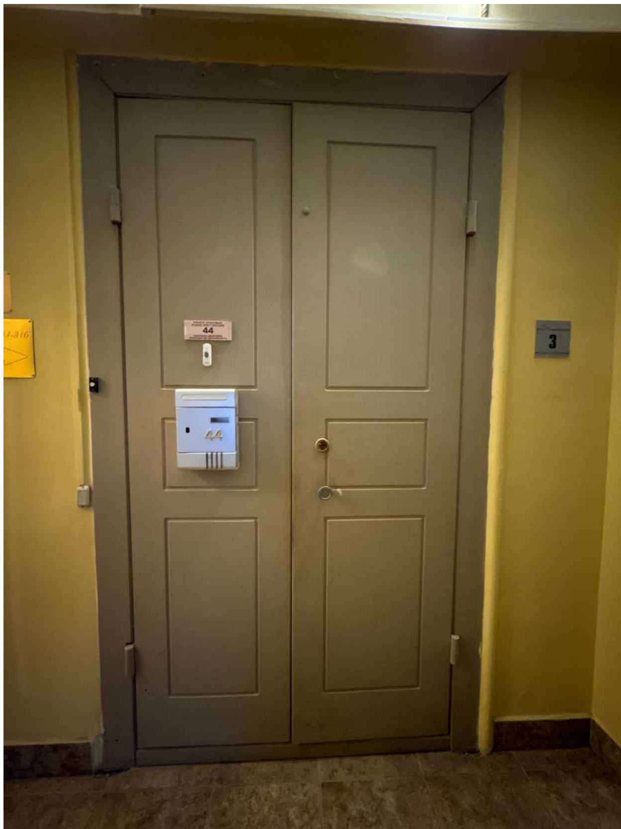
Фото 12. Вид на входное дверное заполнение квартиры № 44 объекта культурного наследия.
