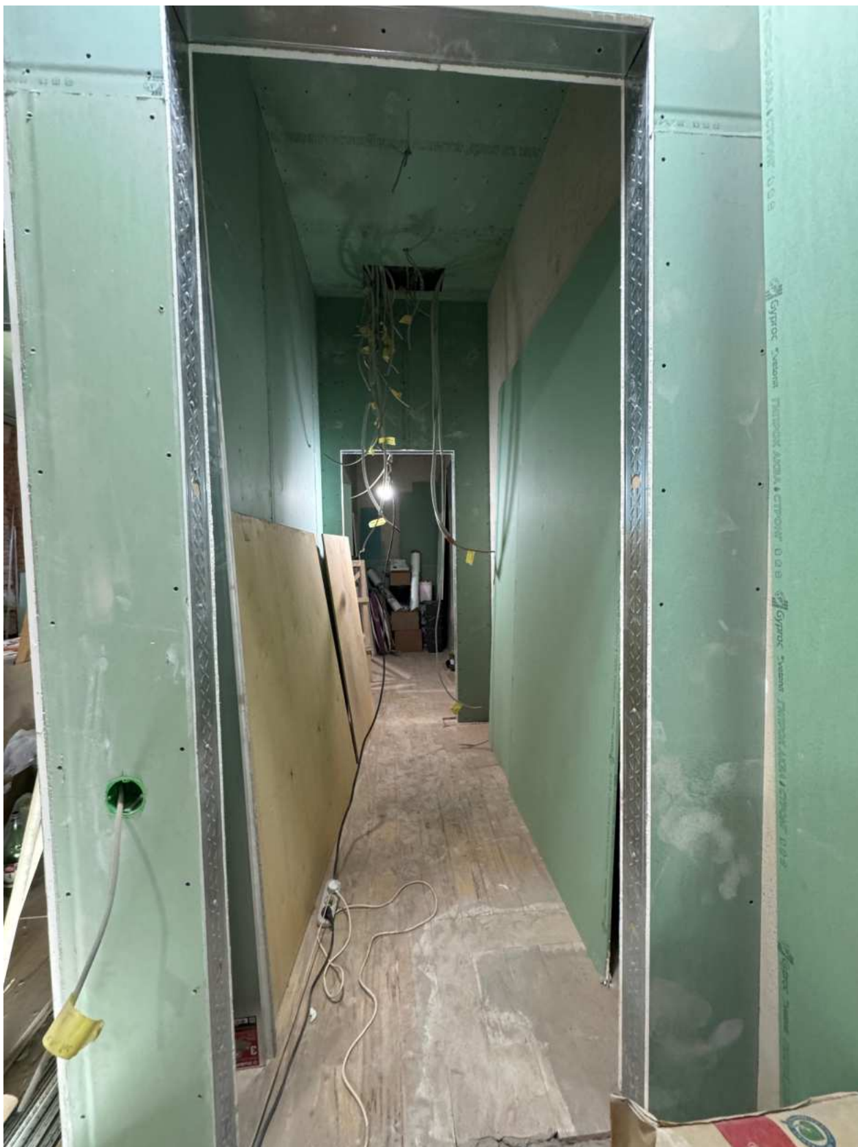
Фото 15. Вид на помещение квартиры № 44 объекта культурного наследия.
