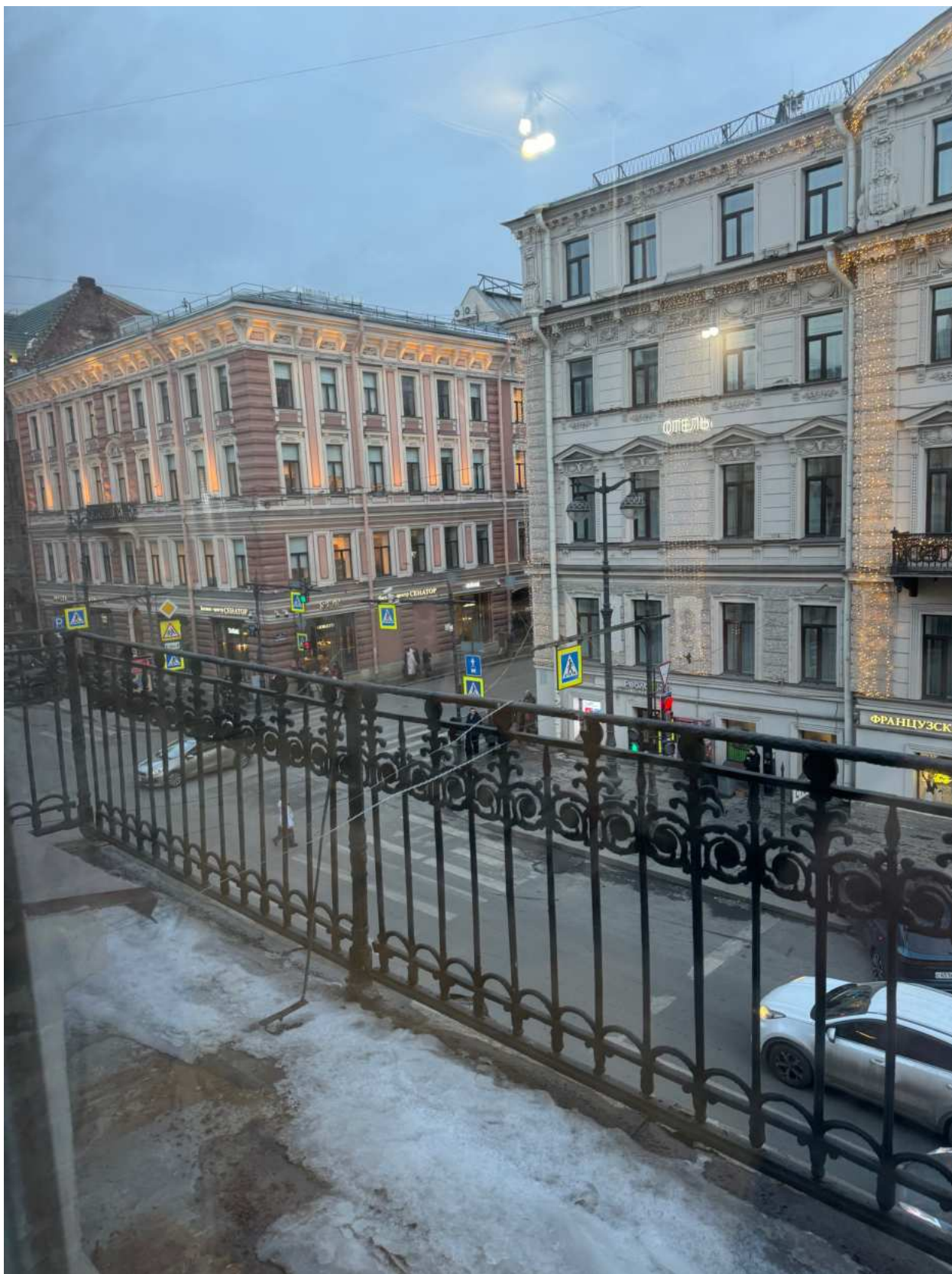
Фото 21. Вид на балконное ограждение и балкон квартиры № 44 объекта культурного наследия.
