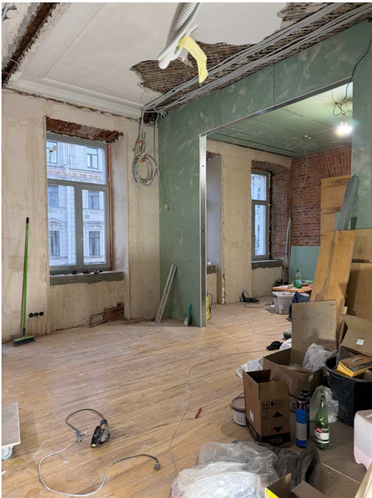
Фото 16. Вид на помещение квартиры № 44 объекта культурного наследия.
