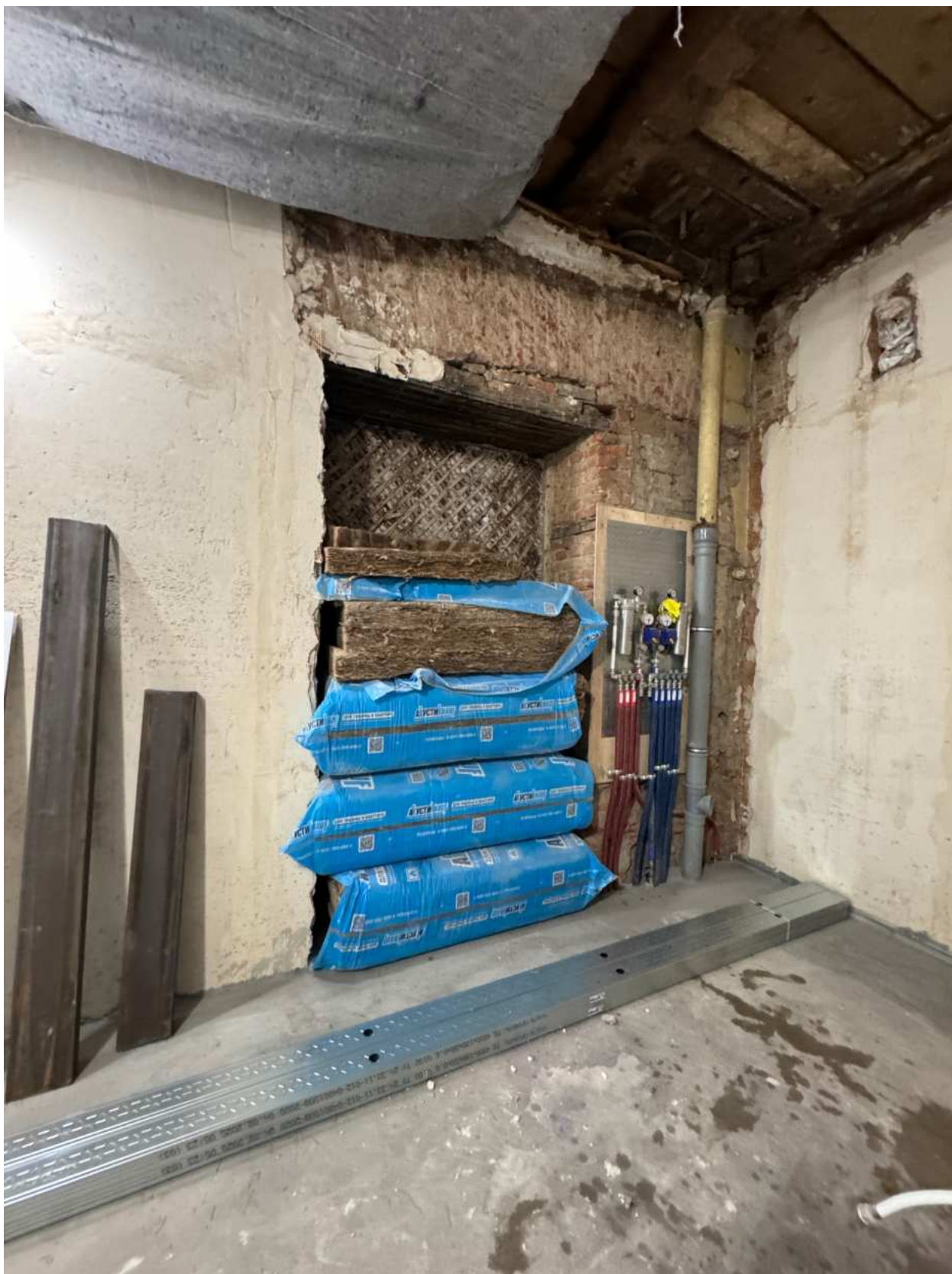
Фото 18. Вид на помещение квартиры № 44 объекта культурного наследия.
