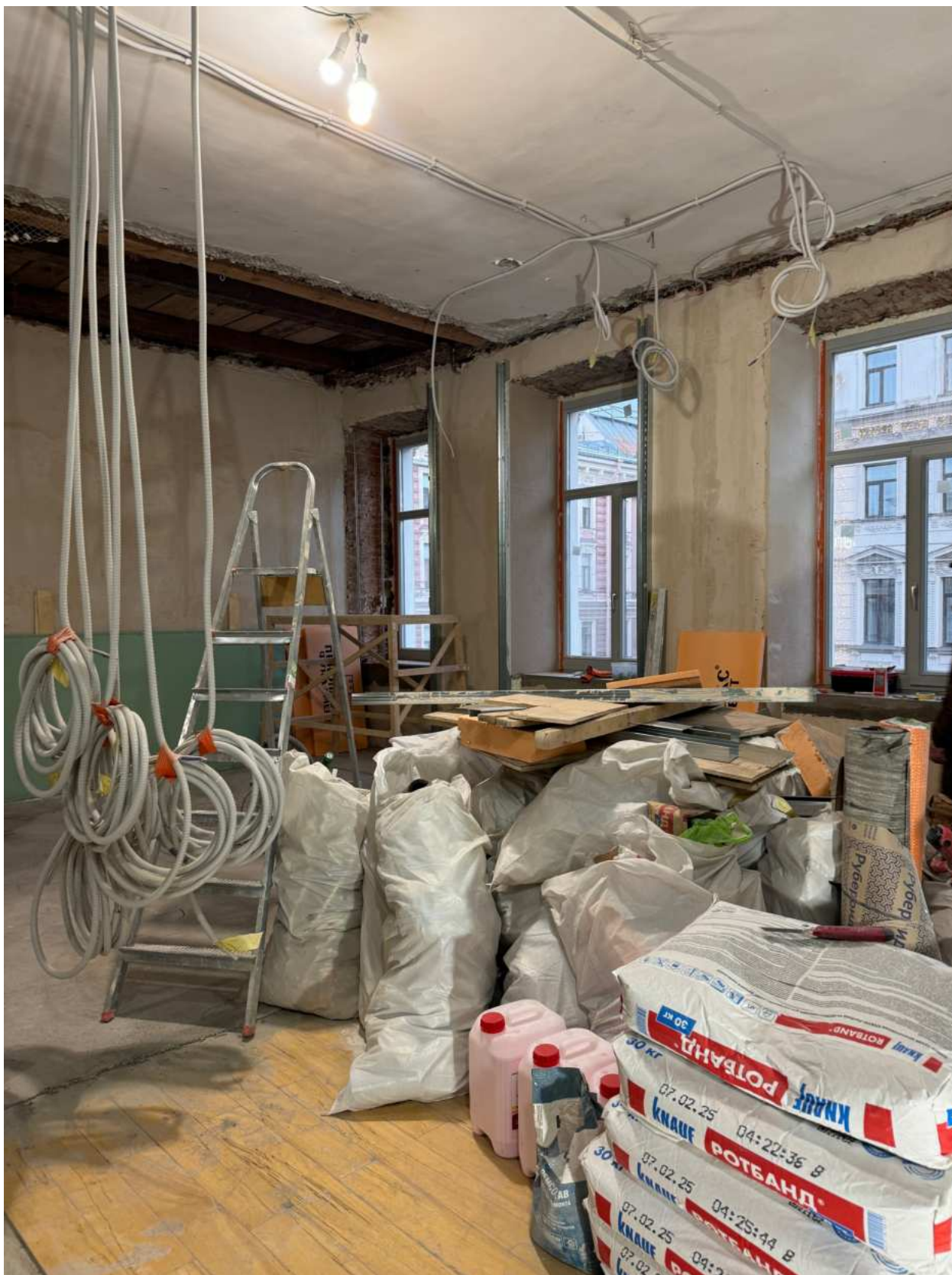
Фото 17. Вид на помещение квартиры № 44 объекта культурного наследия.
