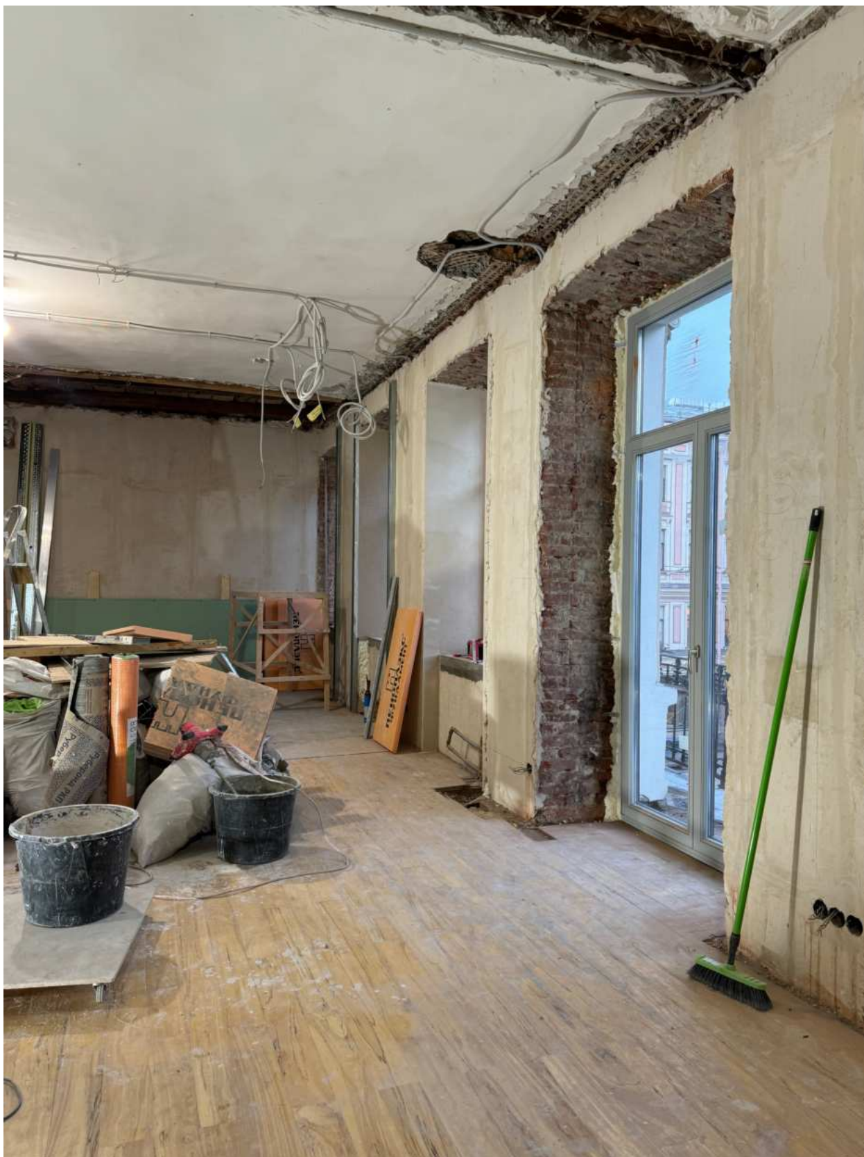
Фото 20. Вид на балконное дверное заполнение квартиры № 44 объекта культурного наследия.
