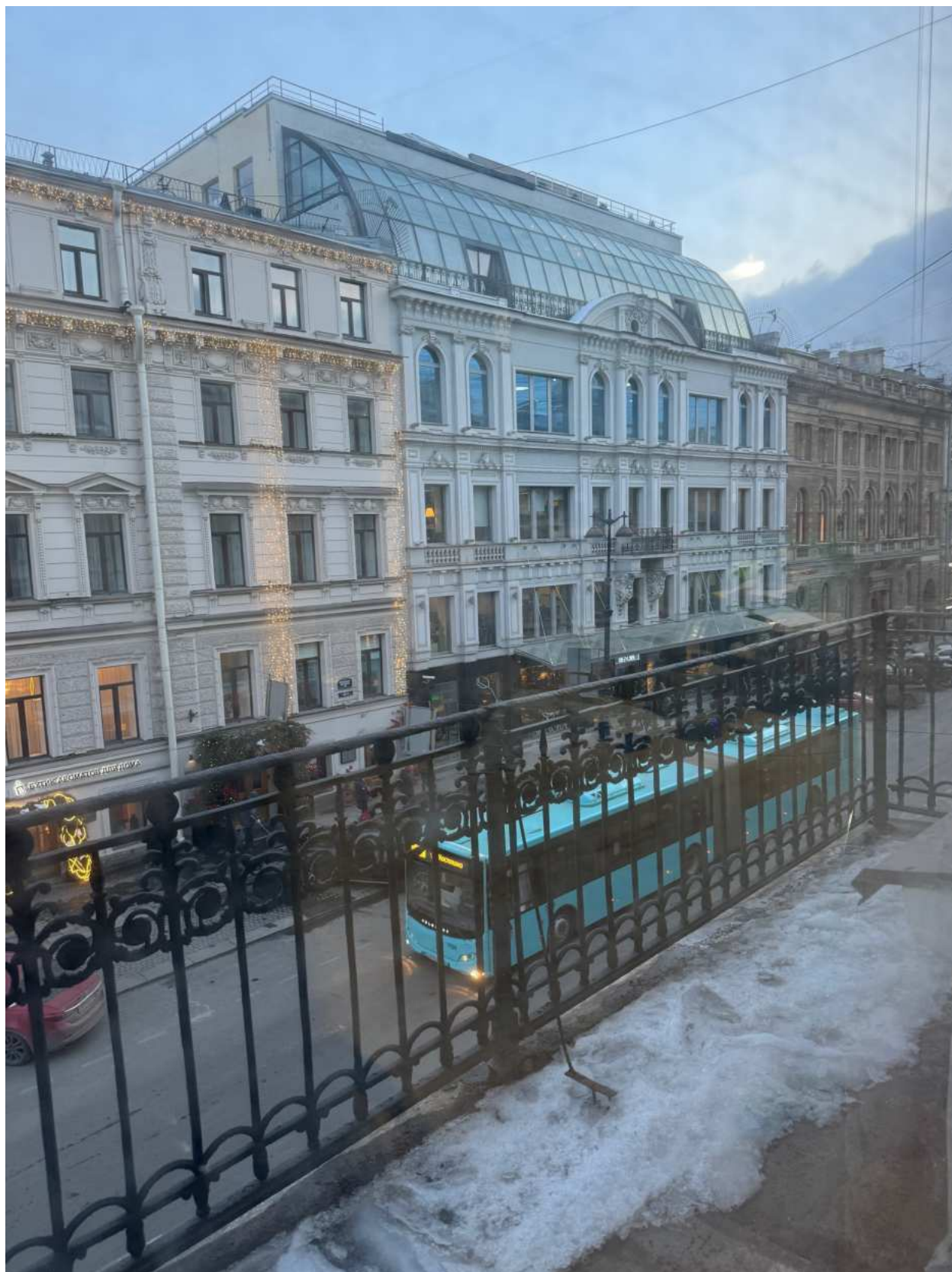
Фото 22. Вид на балконное ограждение и балкон квартиры № 44 объекта культурного наследия.
