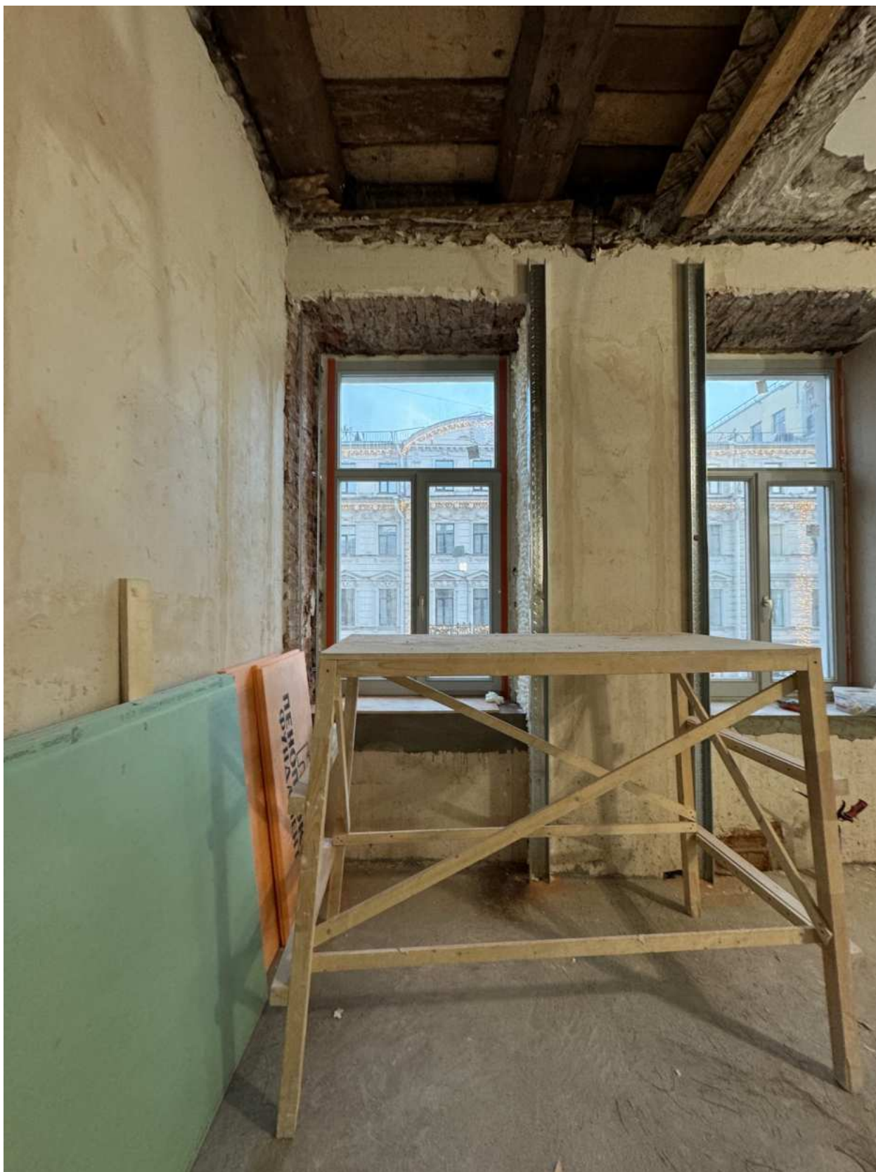
Фото 19. Вид на оконное заполнение квартиры № 44 объекта культурного наследия.
