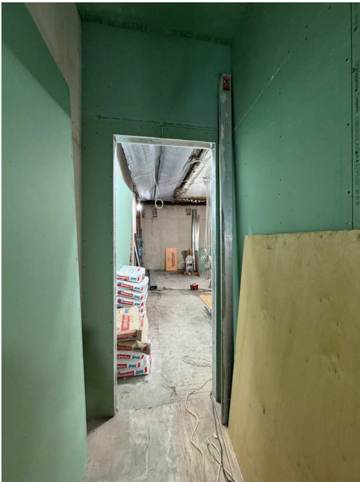
Фото 28. Вид на помещение квартиры № 44 объекта культурного наследия.
