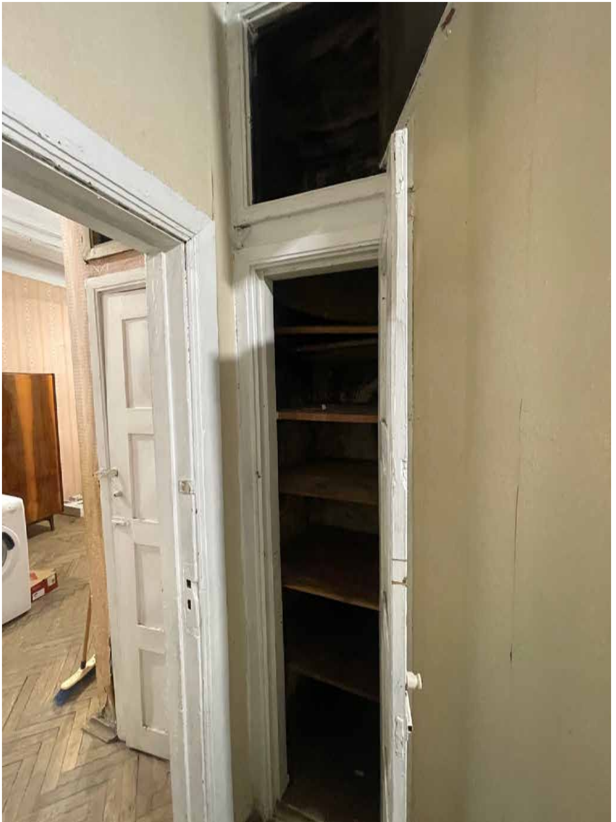
11. Вид на встроенный шкаф (помещение 4/0.5);
