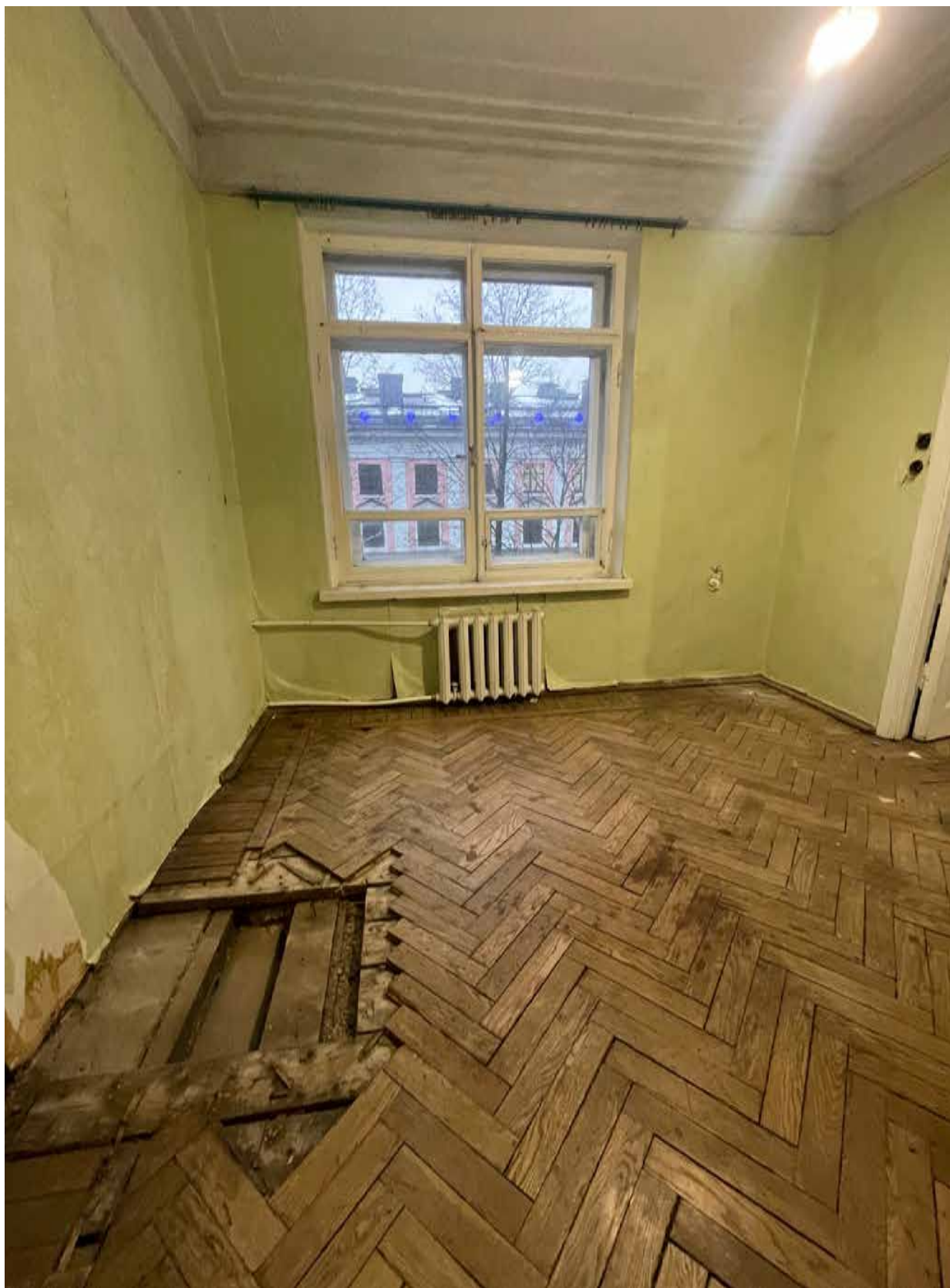
18.Фрагмент интерьера комнаты (помещение 9/14.7).
