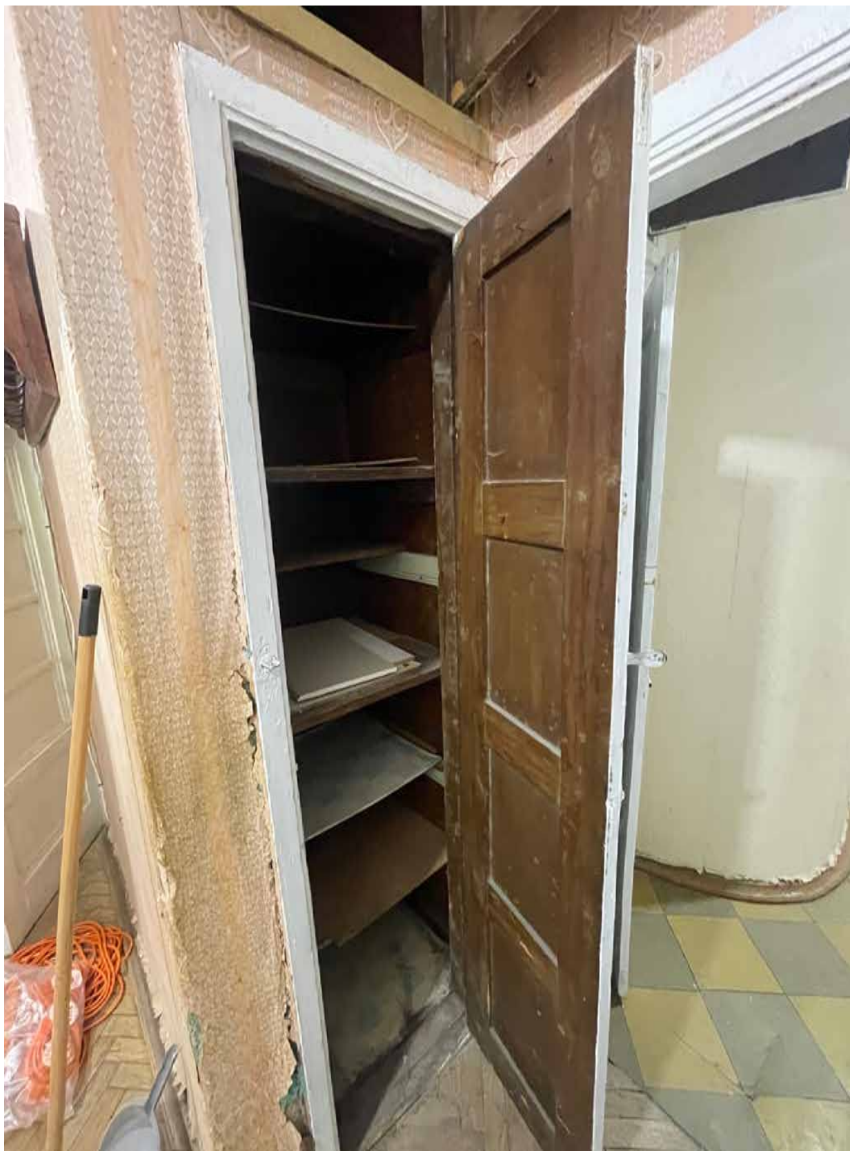
8. Вид на встроенный шкаф (помещение 3/0.4);
