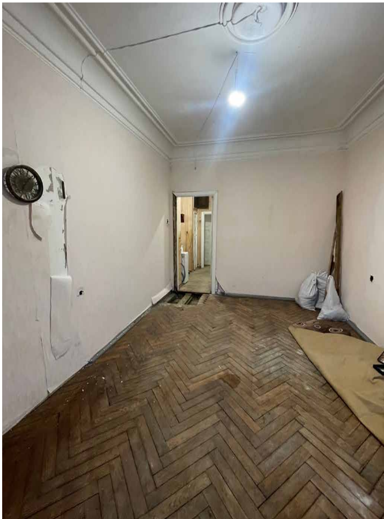
15.Фрагмент интерьера комнаты (помещение 8/17.7);
