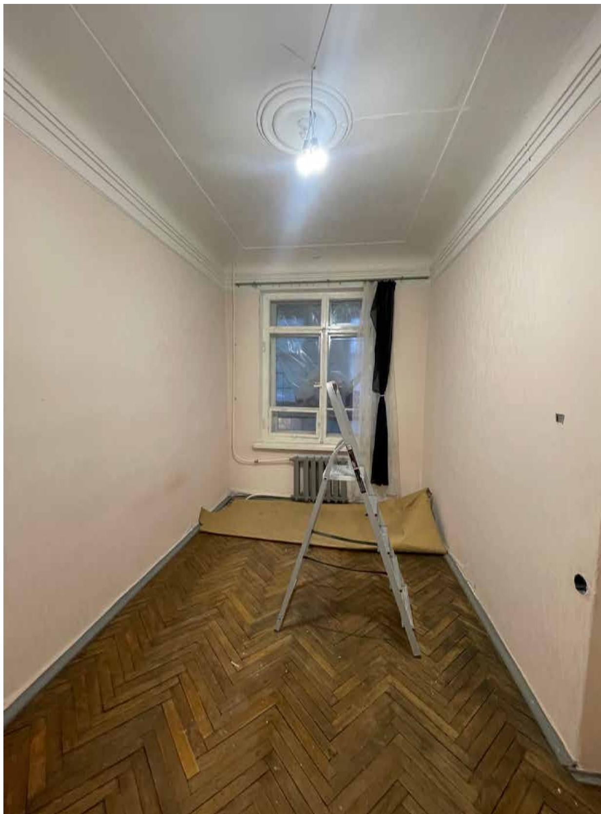
6. Фрагмент интерьера комнаты (помещение 2/11.7);
