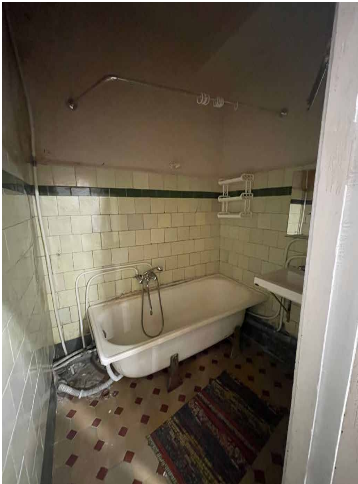
13.Фрагмент интерьера ванной (помещение 7/2.8);
