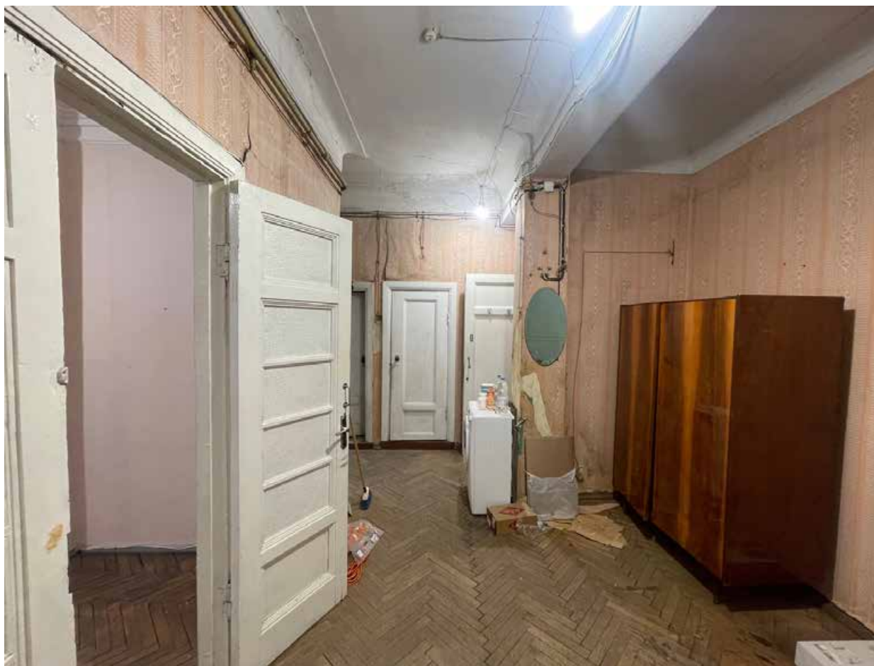
5. Фрагмент интерьера коридора (помещение 1/14.7);
