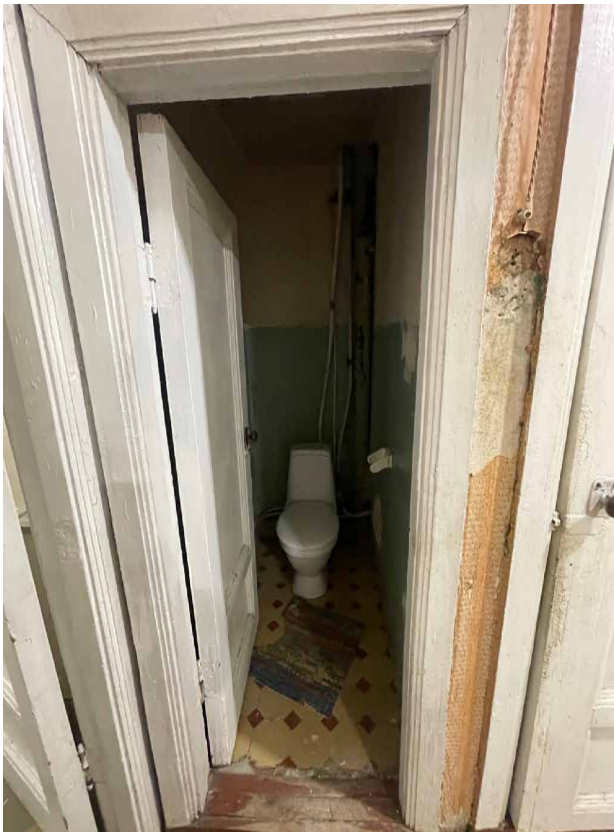
12.Фрагмент интерьера туалета (помещение 6/1.4);
