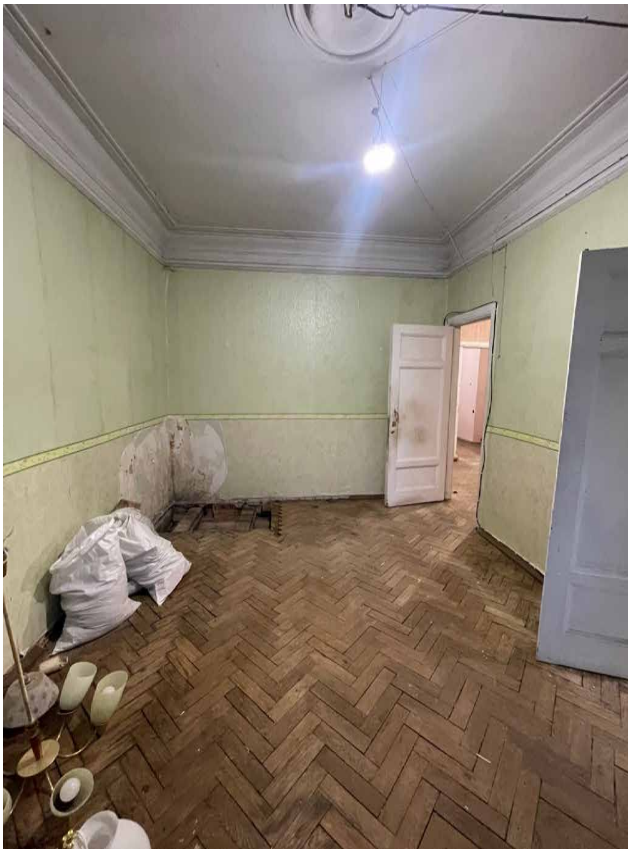
17.Фрагмент интерьера комнаты (помещение 10/17.9);
