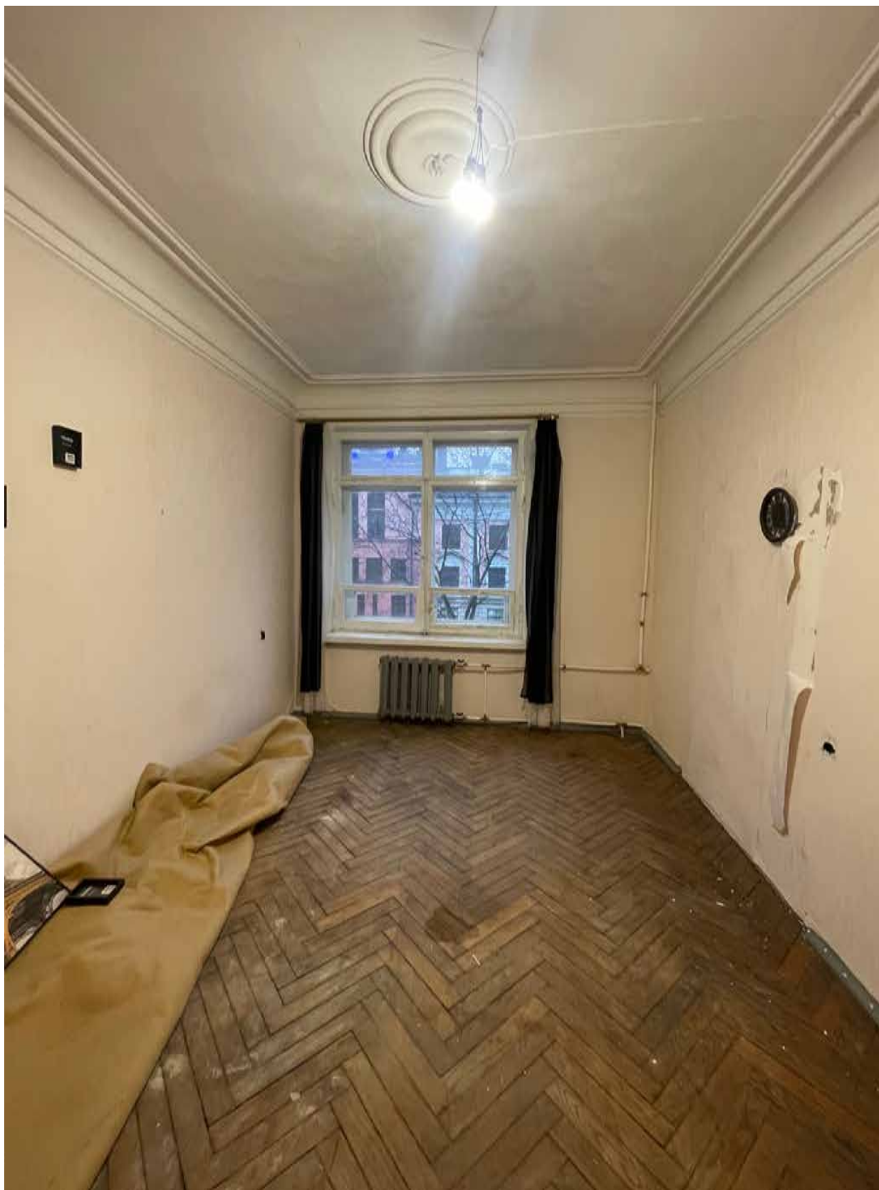
14.Фрагмент интерьера комнаты (помещение 8/17.7);
