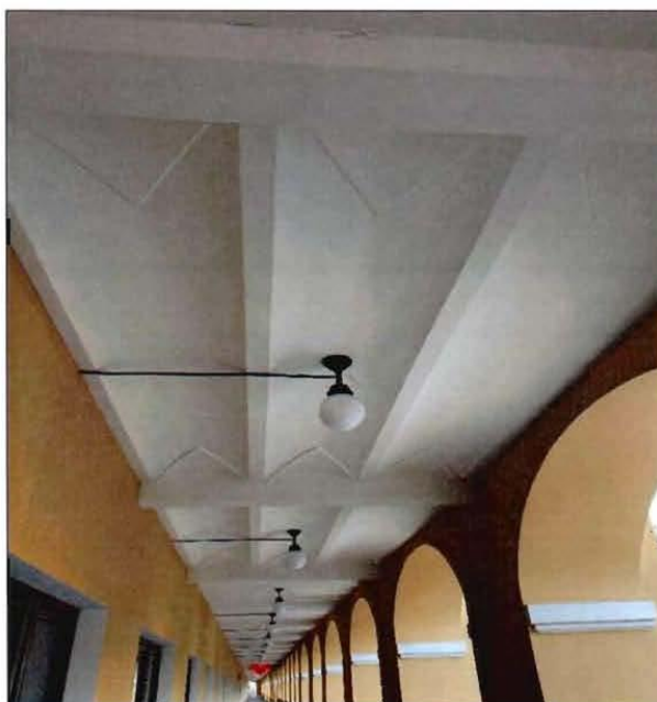
11. Фрагмент обходной галереи вдоль ул. Садовой. Своды
