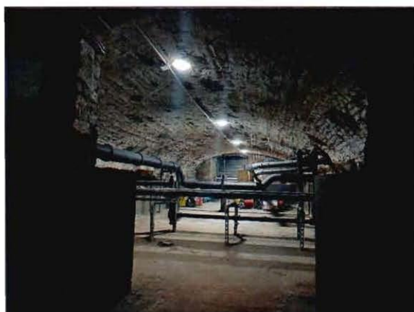
5. Подвалы объекта культурного наследия. Своды.
