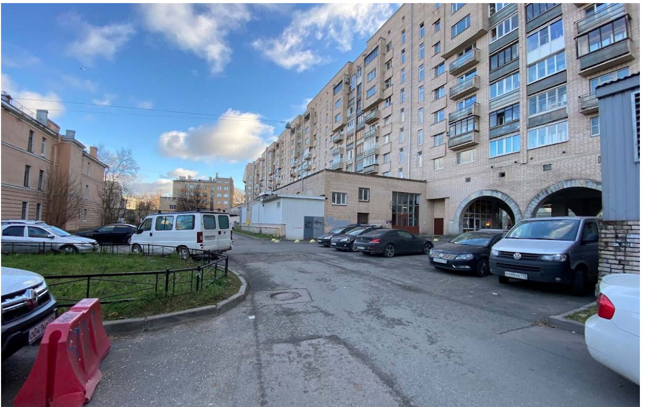
Фото 10. Вид по трассе теплосети проходящей по внутридворовому проезду в восточном направлении вдоль д.1 по Финляндскому пр. и входящему в его корпуса.
