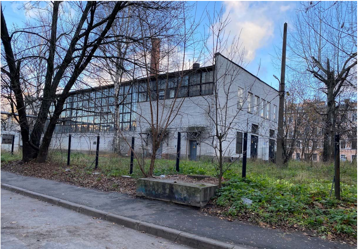
Фото 12. Вид на котельную – западный фасад, участок ввода теплосети.
