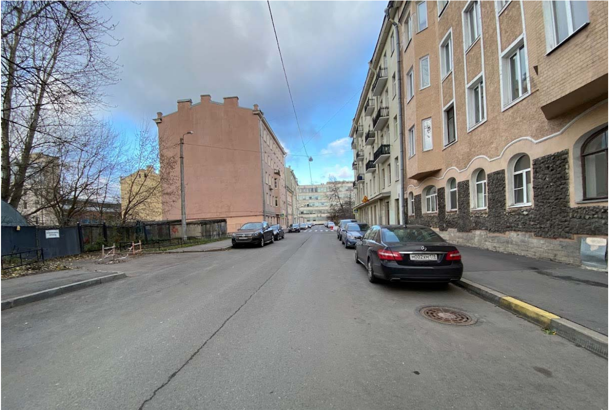
Фото 1. Вид по трассе теплосети по Астраханской ул. в северном направлении в сторону Сахарного пер.
