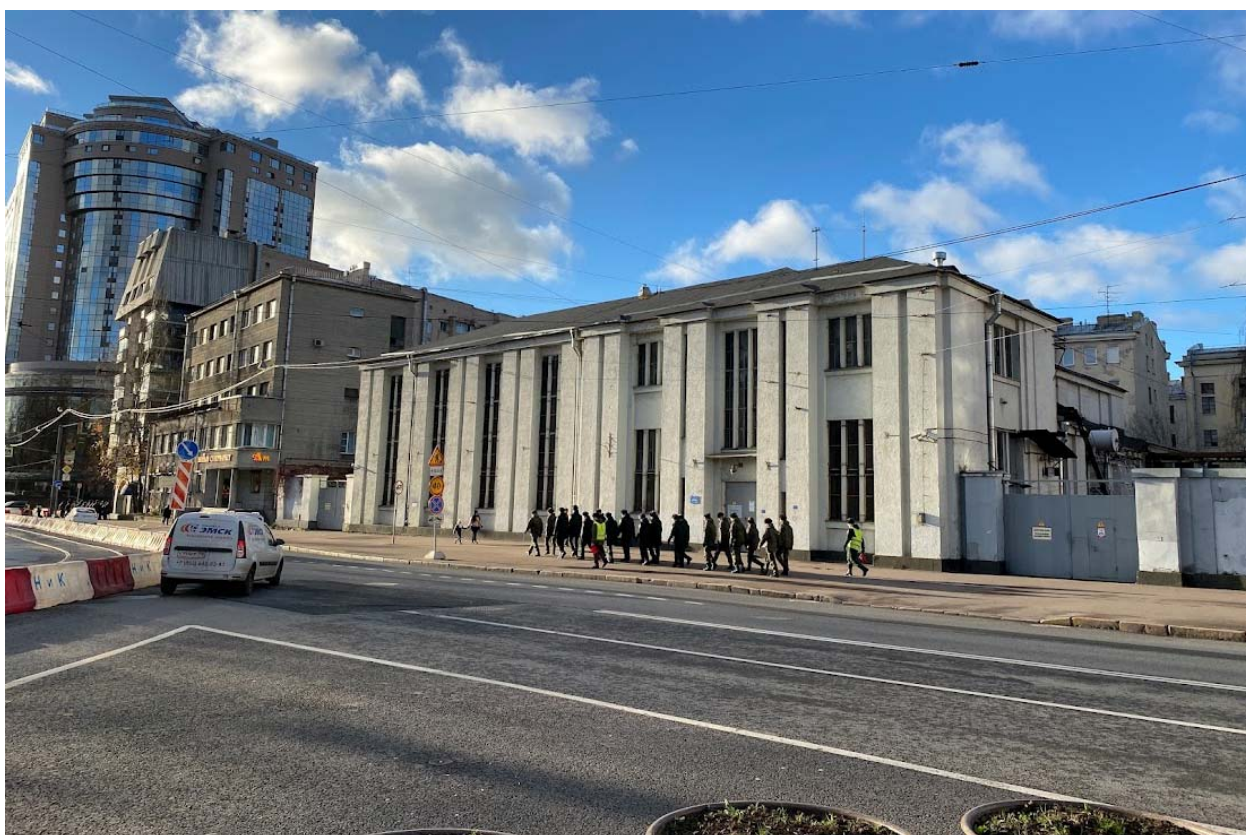
Фото 14. Вид на территорию по трассе теплосети.
