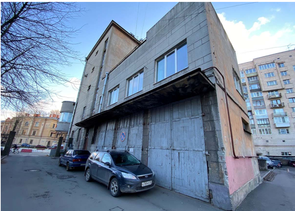
Фото 7. Вид на северо-западный фасад здания Ленэнерготока.
