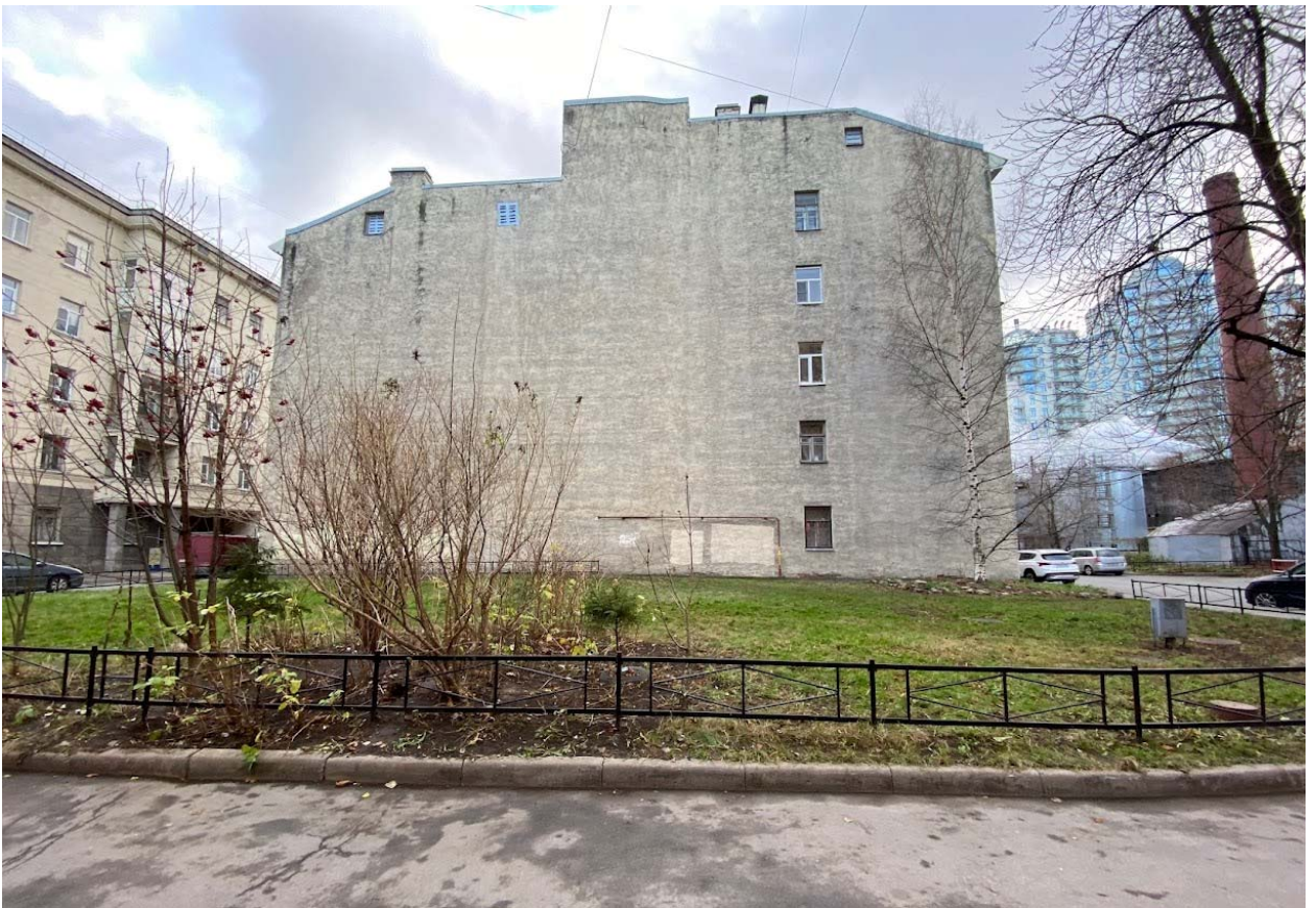
Фото 2. Вид по трассе теплосети по Саратовской ул., на д. 19/20.
