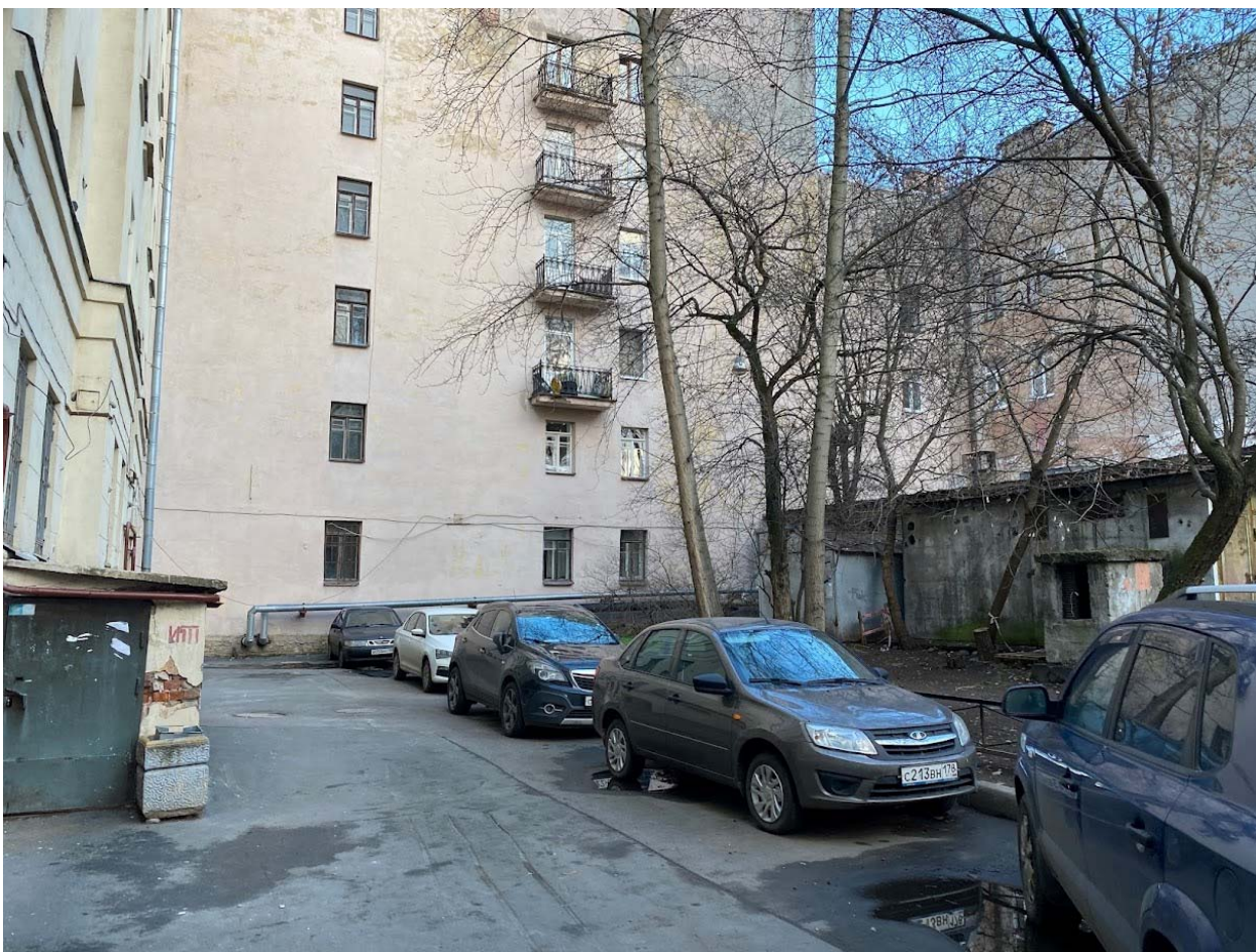
Фото 4. Вид на участок прокладки теплосети во дворе ул. Саратовская д.29.
