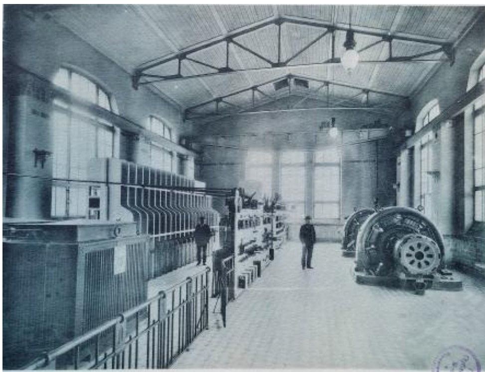
12. Машинный зал одной из подстанций I очереди постройки. Фотография до 1909 года. // Отчет по сооружению С.-Петербургского городского электрического трамвая, 1905–1908. Т. 2: техническое описание с приложением расчетов сооружений. Санкт-Петербургская городская типография, 1909. Вклейка б/н. Илл. № 86.
