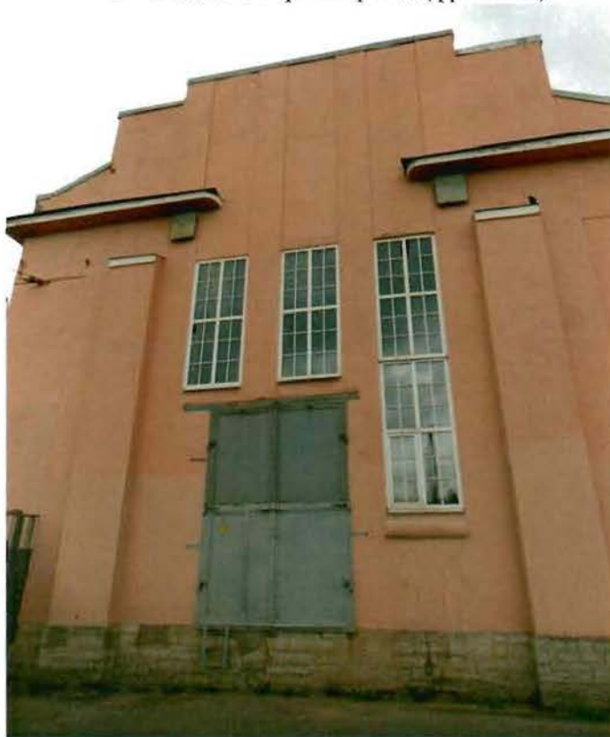
3. Вид на северный фасад (фрагмент).
