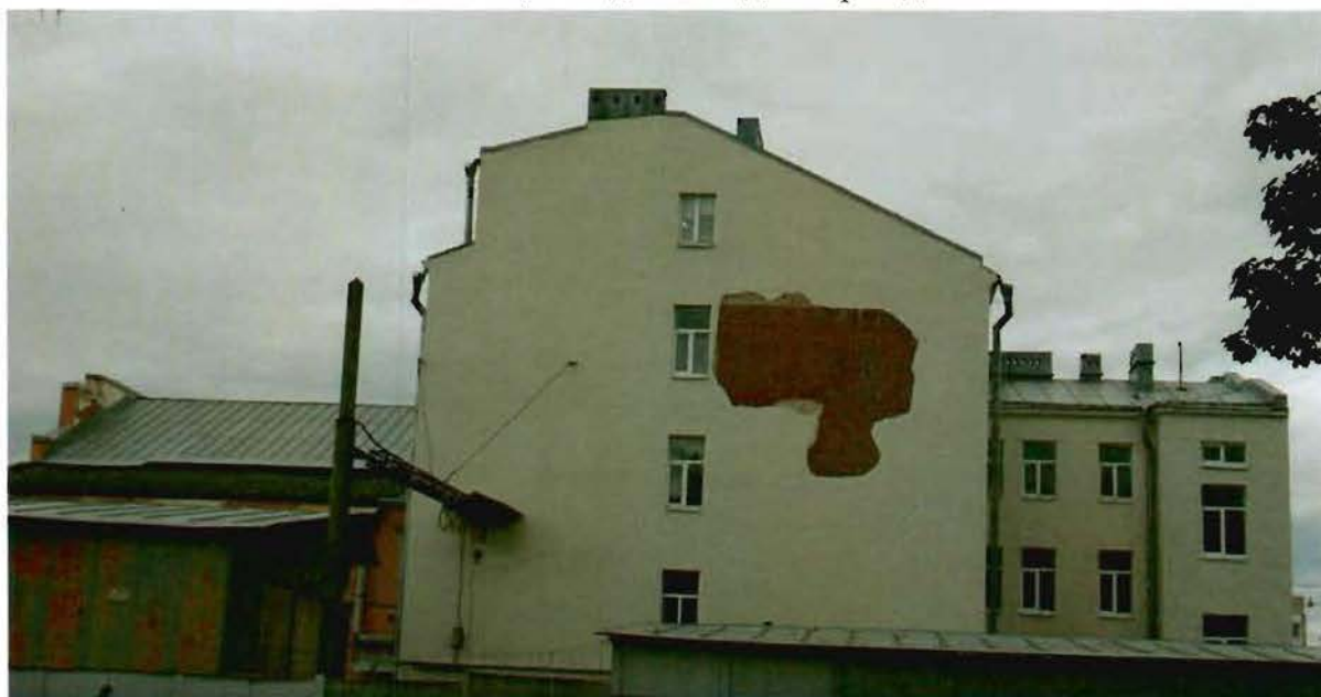
4. Общий вид на западный фасад.
