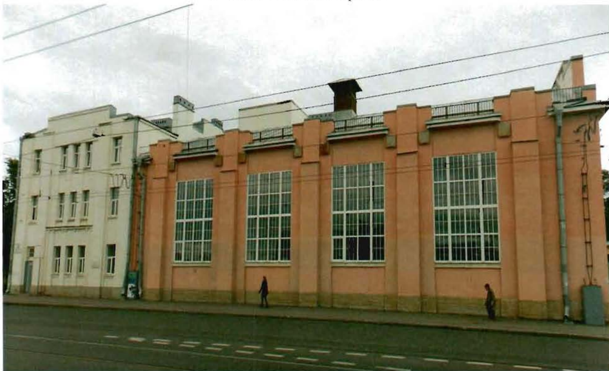
1. Вид на восточный фасад.
