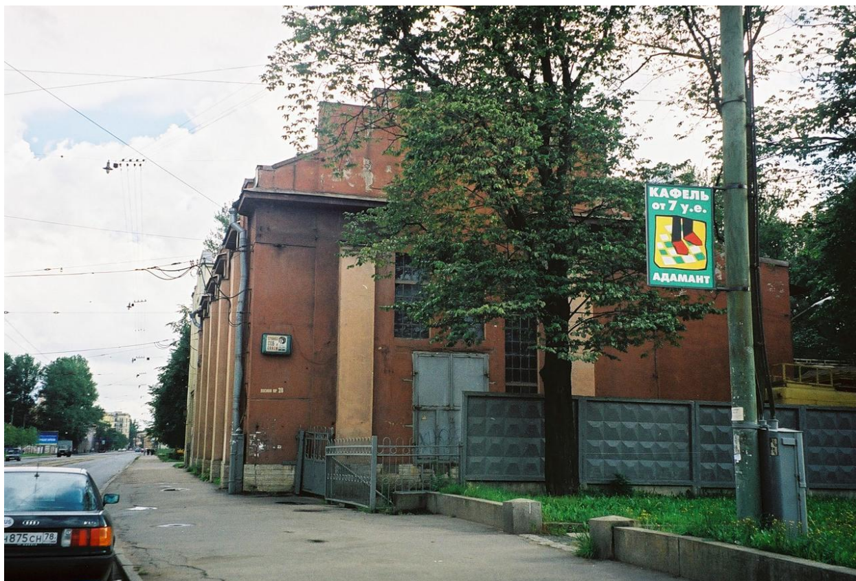
20. Выборгская трансформаторная подстанции городского трамвая. 2000 г. — «PastVu» – ретро-фотографии стран и городов [Электронный ресурс]. URL: https://pastvu.com/p/283623 .
