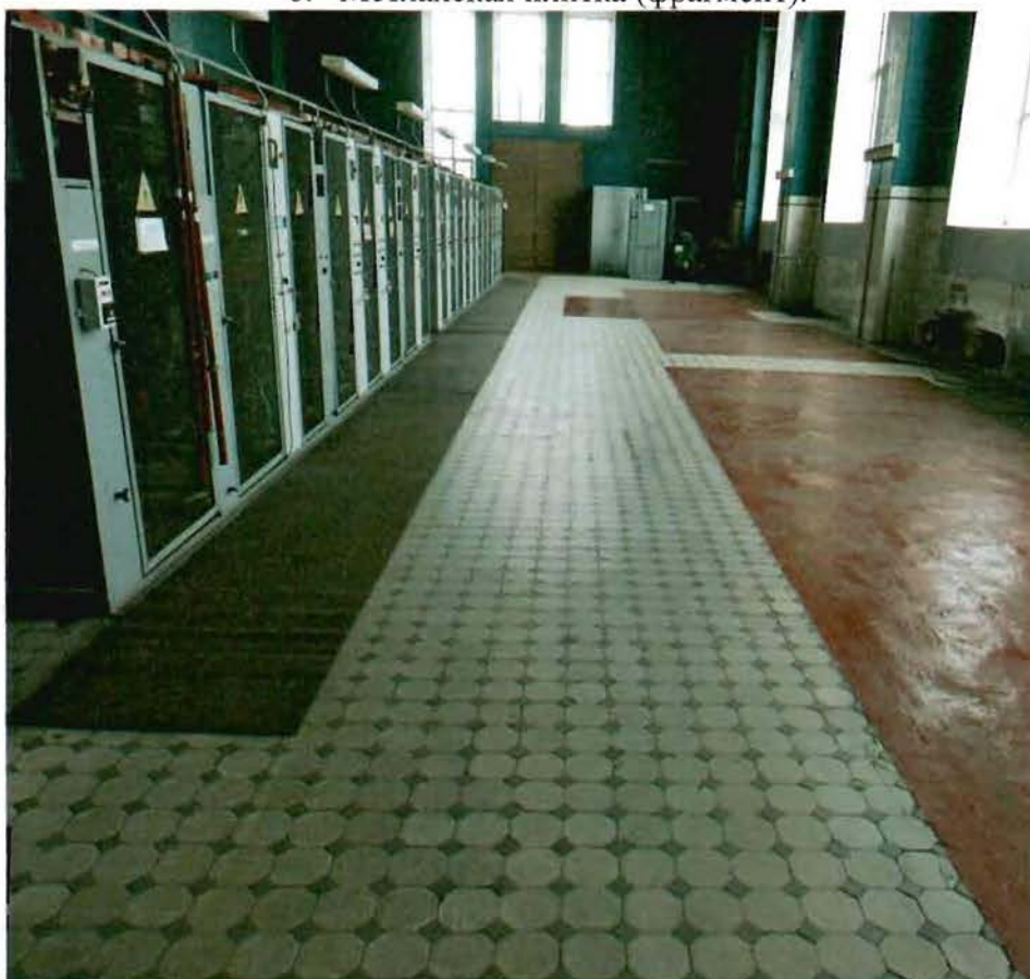
6. Метлахская плитка (фрагмент).
