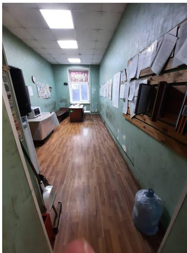
Фото 38. Интерьер 3 этажа объекта культурного наследия регионального значения «Здание Выборгской понижающей подстанции городского трамвая»
