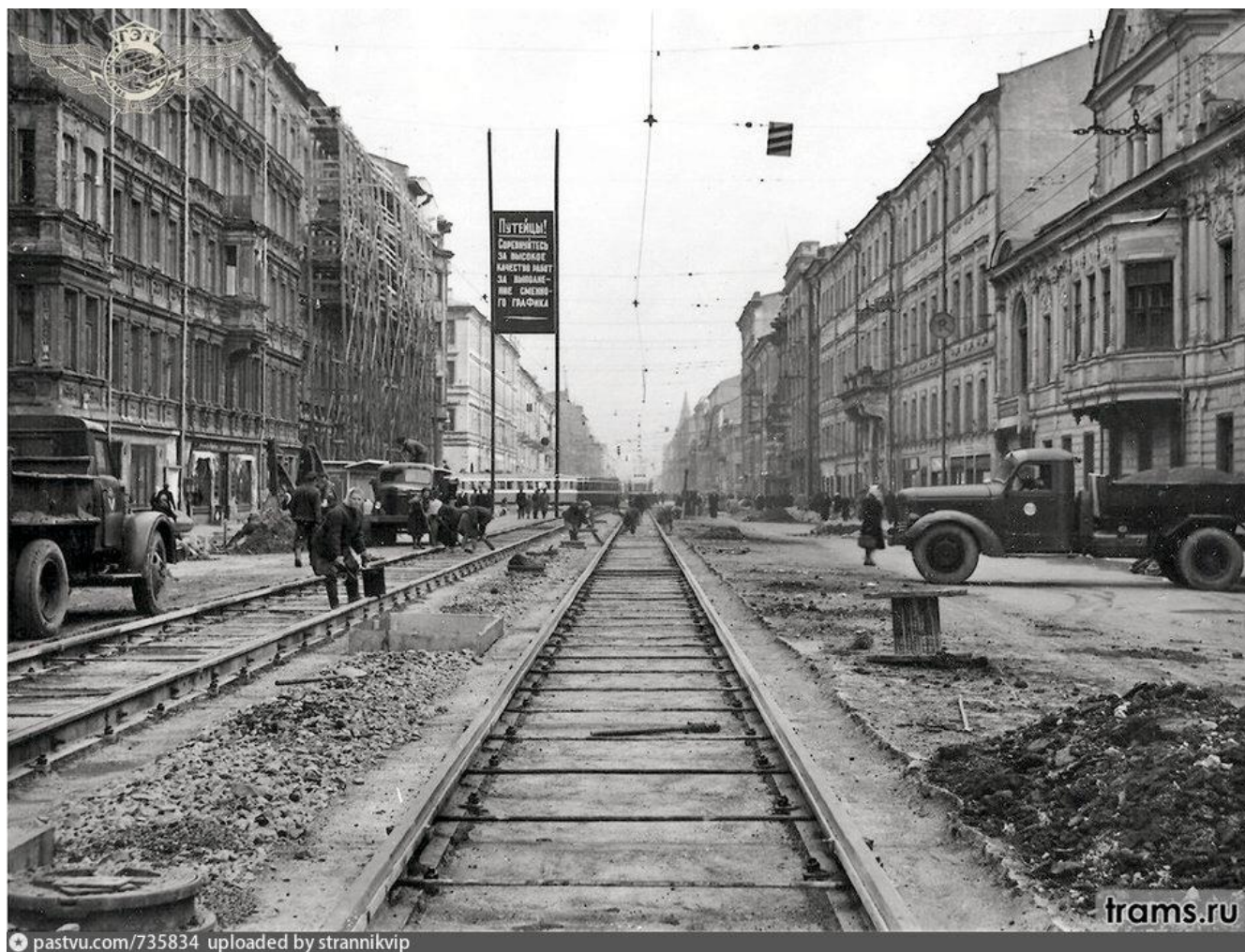
Илл. 28. Укладка трамвайных путей у дома № 51 по Литейному проспекту. 1952-1953 гг. Интернет-ресурс https://pastvu.com/p/735834 .
