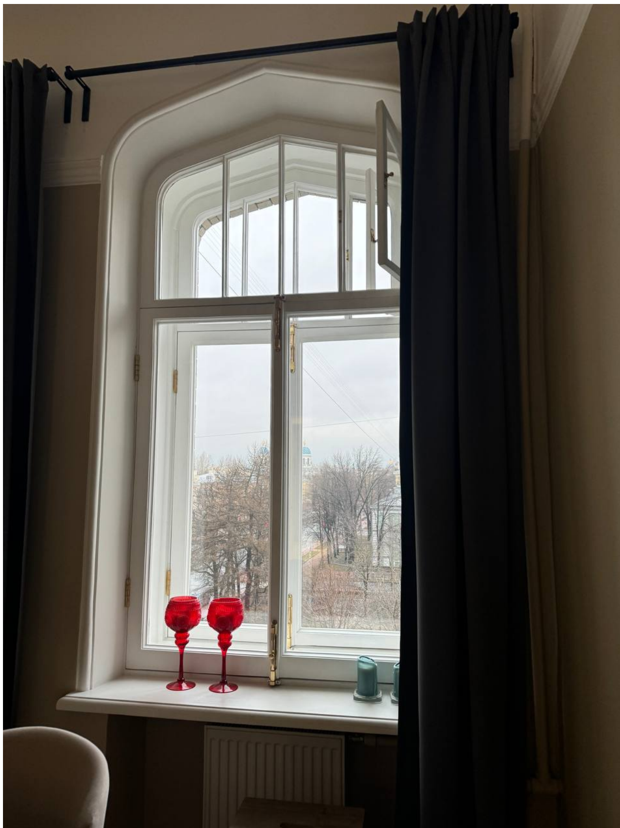
Фото 39. Вид на оконное заполнение квартиры № 39 объекта культурного наследия.
