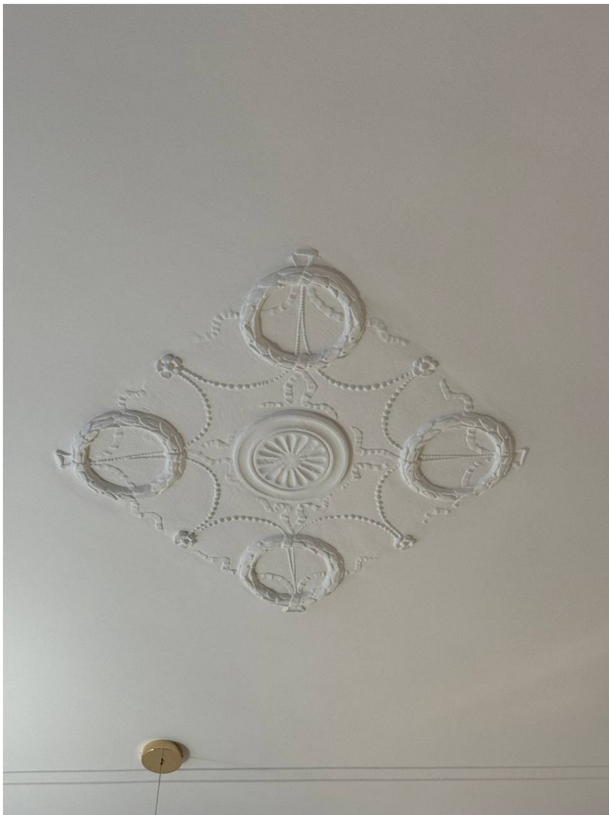
Фото 54. Вид на потолок в помещении квартиры № 39 объекта культурного наследия.
