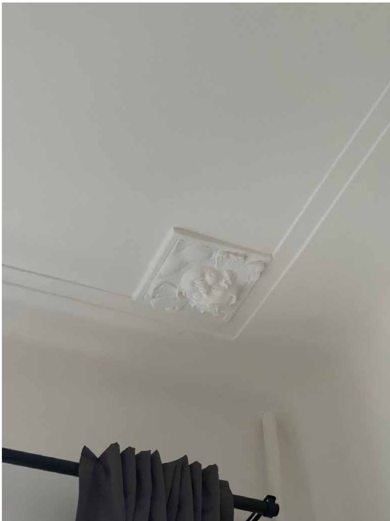
Фото 26. Вид на потолок в помещении квартиры № 39 объекта культурного наследия.
