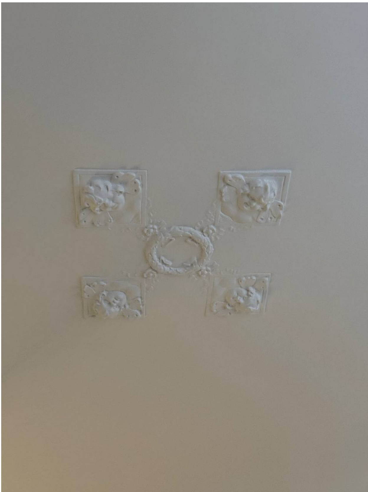
Фото 40. Вид на потолок в помещении квартиры № 39 объекта культурного наследия.
