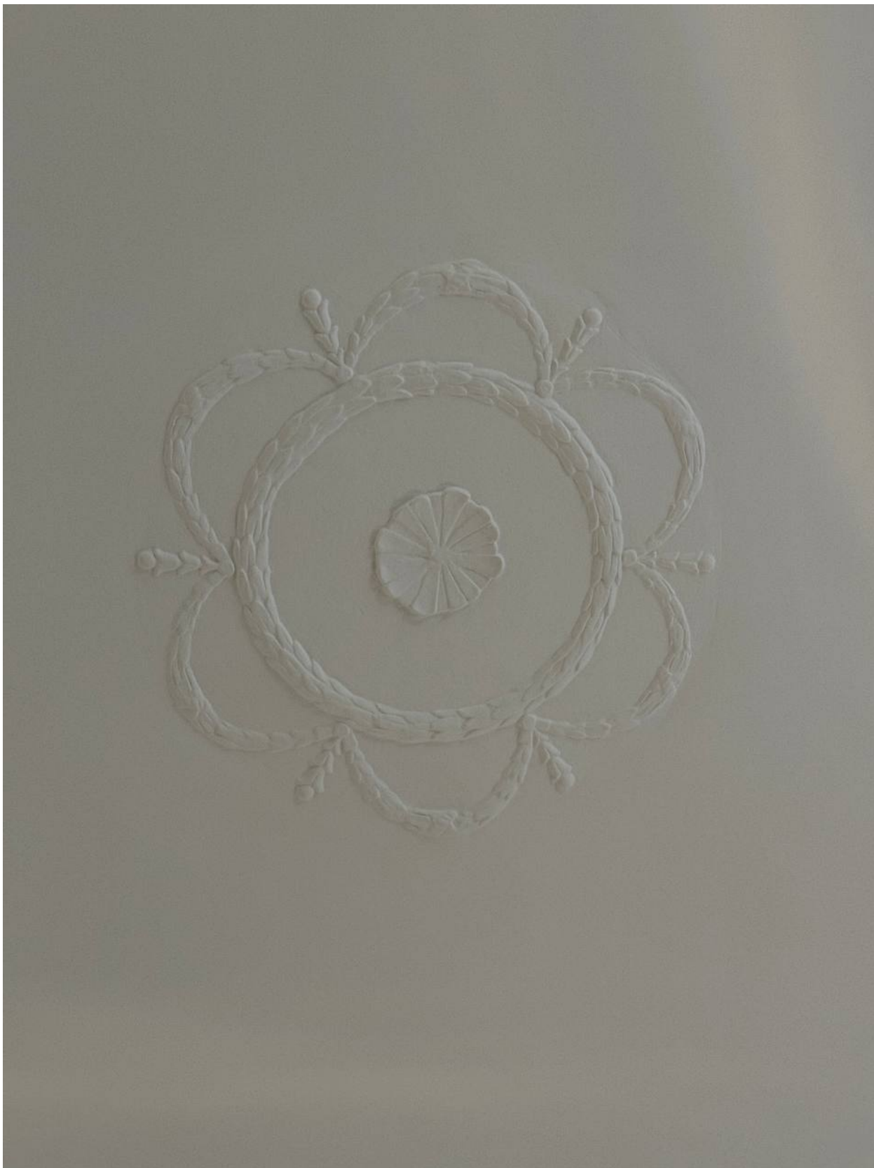
Фото 55. Вид на потолок в помещении квартиры № 39 объекта культурного наследия.
