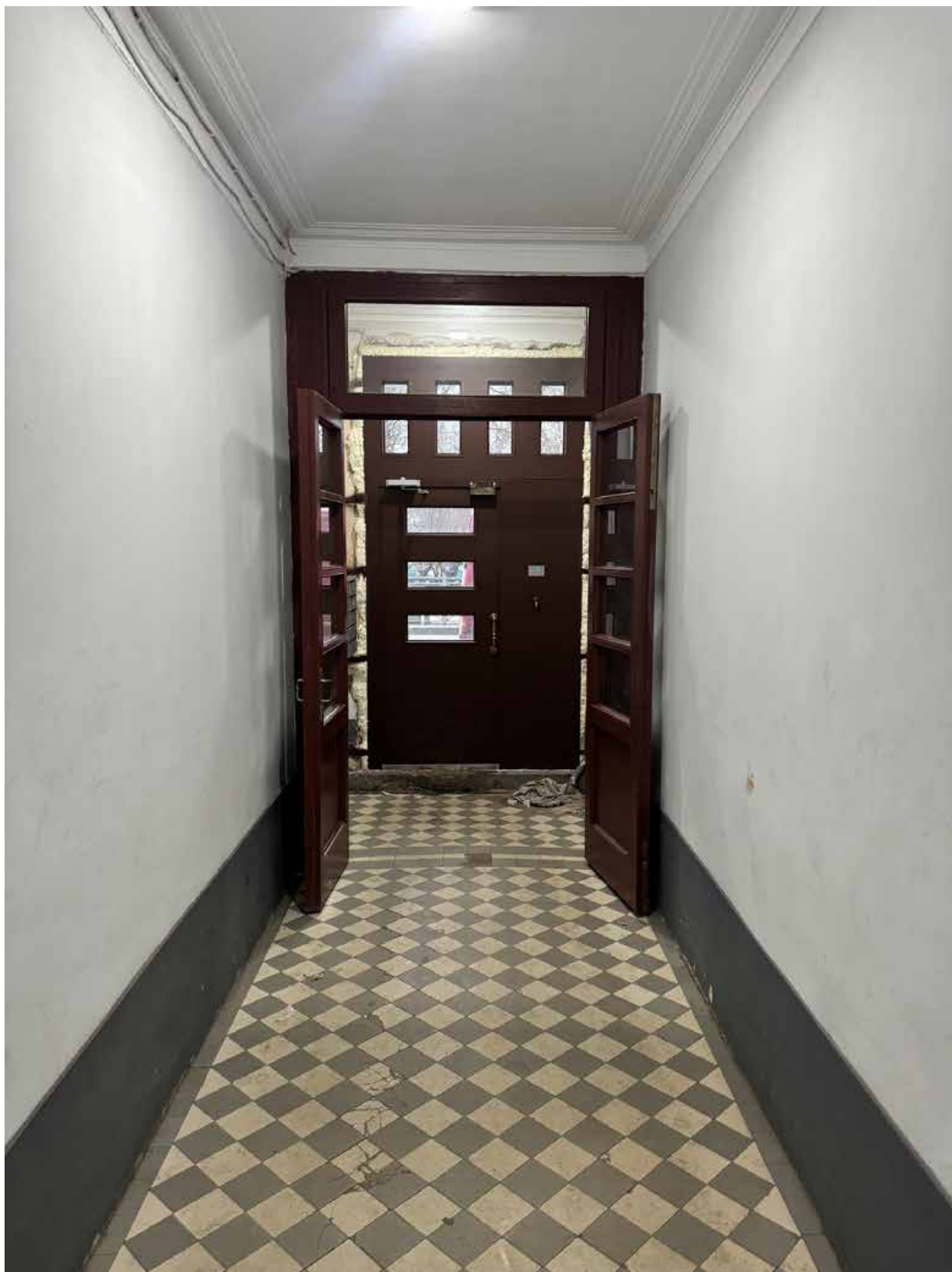
Фото 10. Вид на интерьер вестибюля, ведущего к квартире № 39, объекта культурного наследия.
