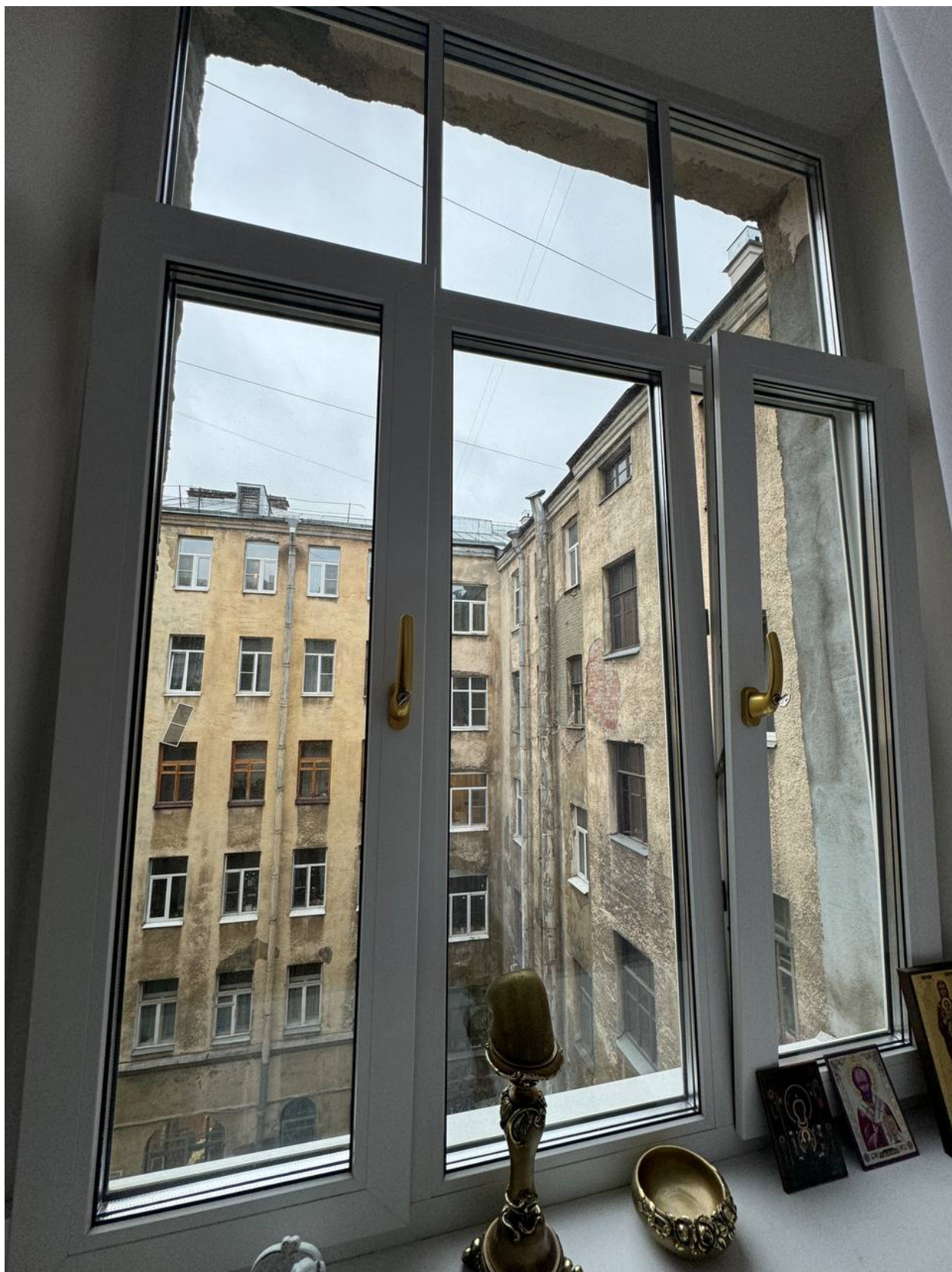
Фото 57. Вид на оконное заполнение квартиры № 39 объекта культурного наследия.
