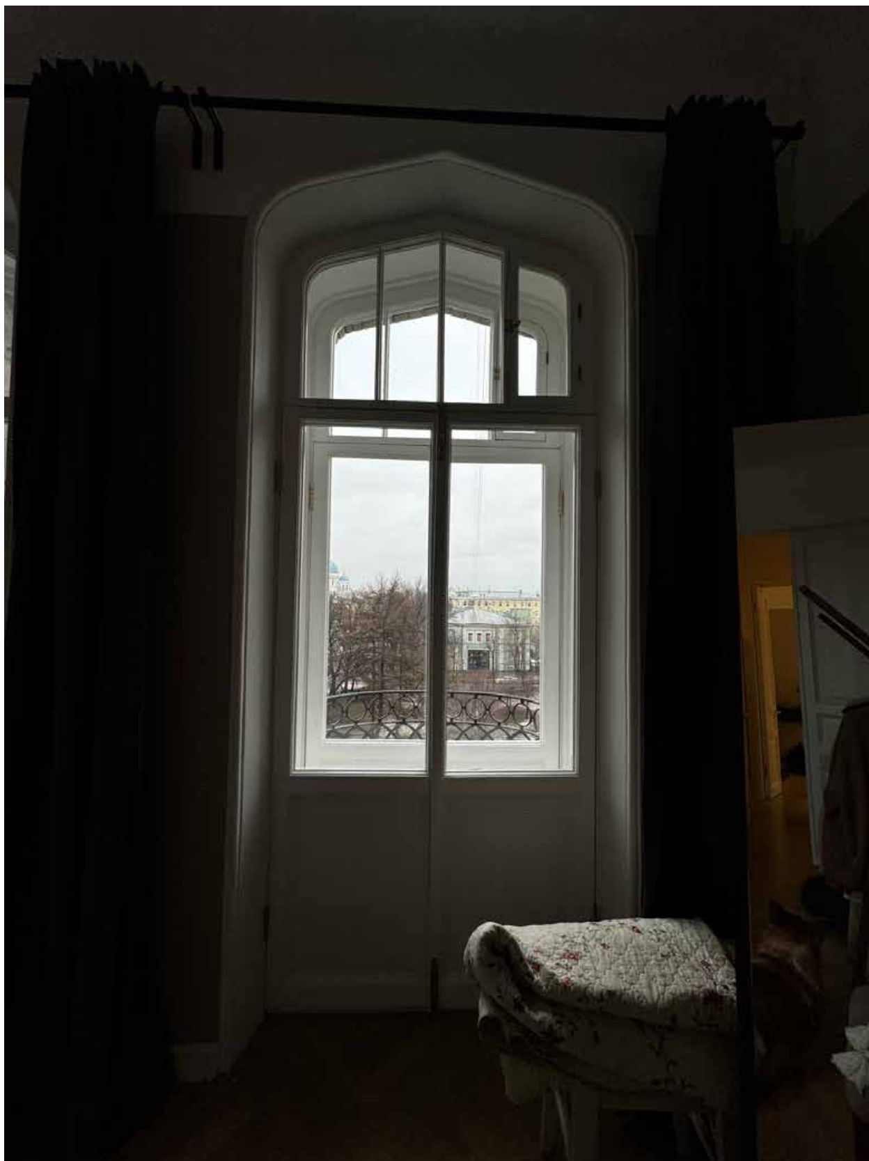
Фото 21. Вид на балконное дверное заполнение квартиры № 39 объекта культурного наследия.
