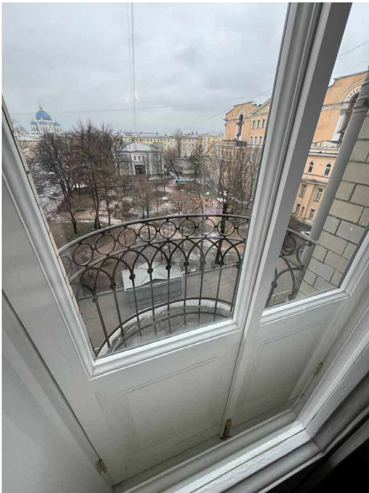
Фото 23. Вид на балконное ограждение квартиры № 39 объекта культурного наследия.
