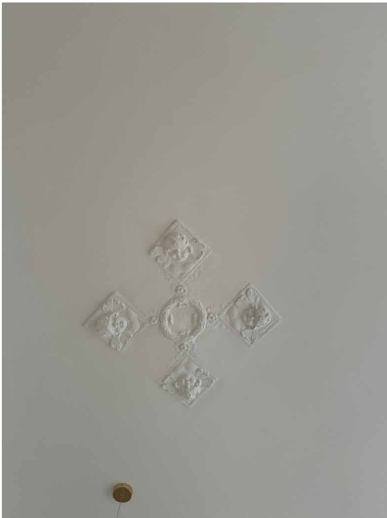
Фото 25. Вид на потолок в помещении квартиры № 39 объекта культурного наследия.
