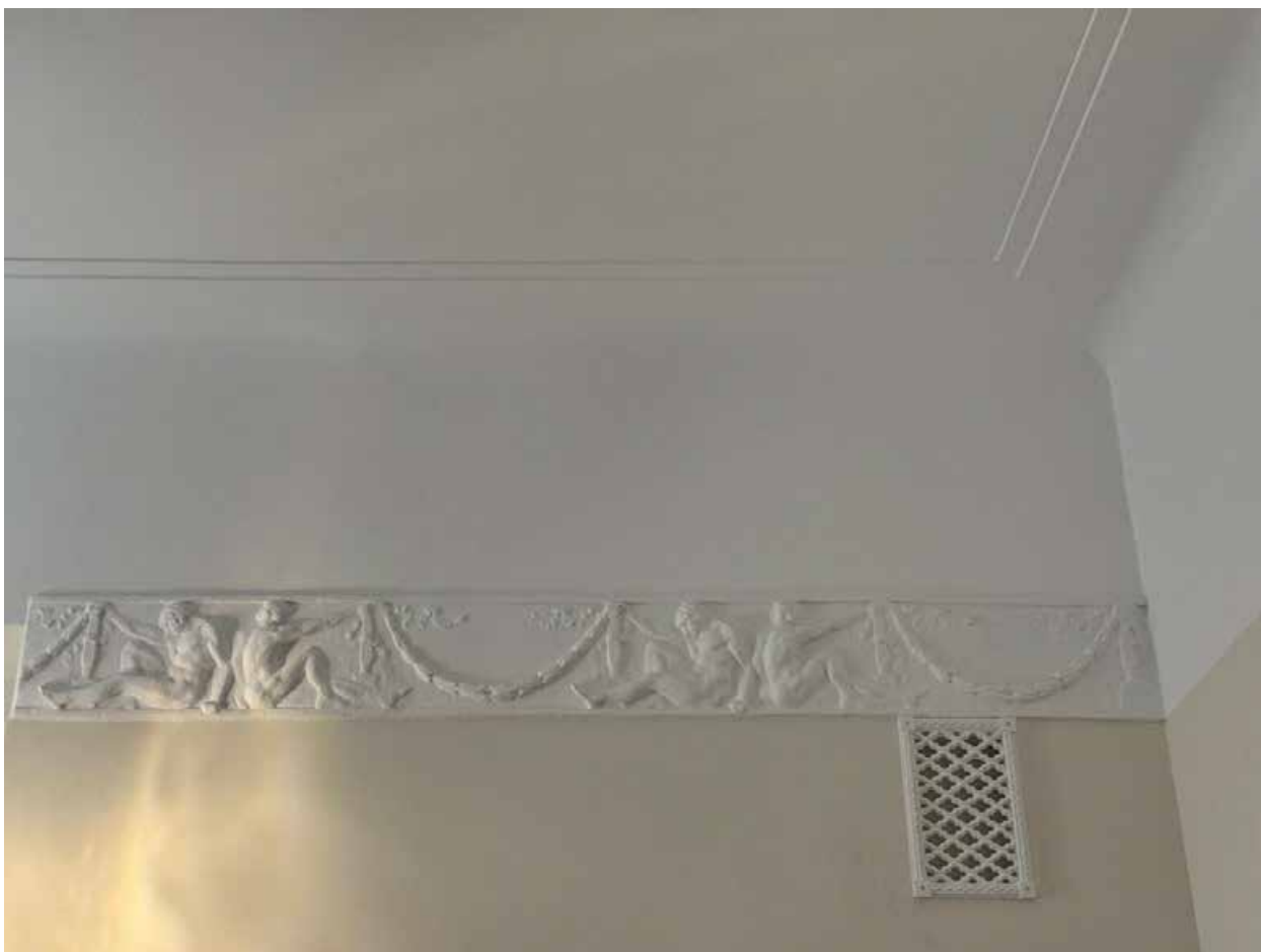
Фото 53. Вид на лепные элементы квартиры № 39 объекта культурного наследия.
