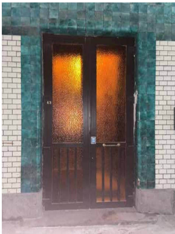
Фото 1. Вид на входную дверь с улицы.
