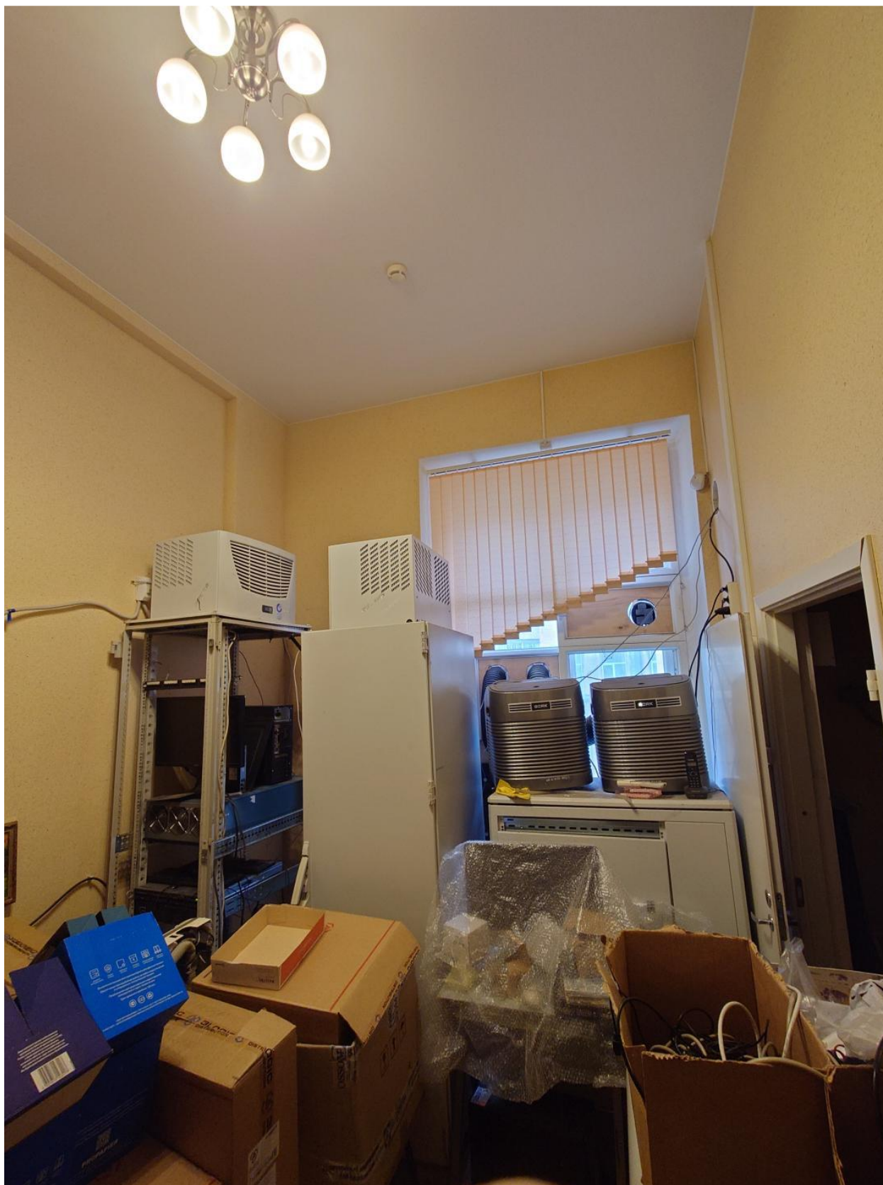
9. Пом. 20, вид на место предполагаемой установки кондиционера.
