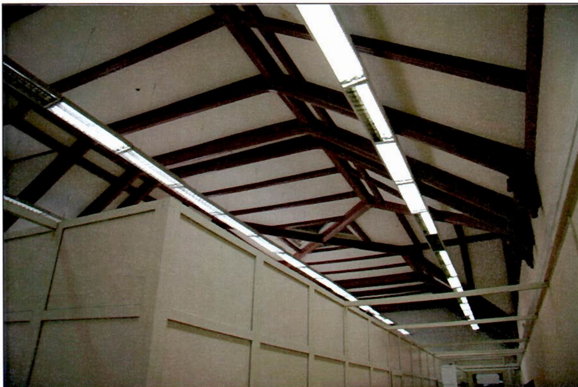
17. Интерьер. Помещение (Рекреационный зал) 29Н (42-48).
