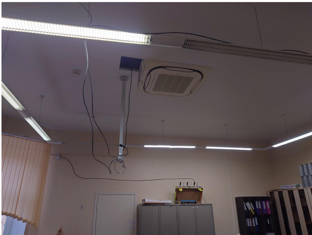
10. Пом. 21, вид на место предполагаемой установки кондиционера.
