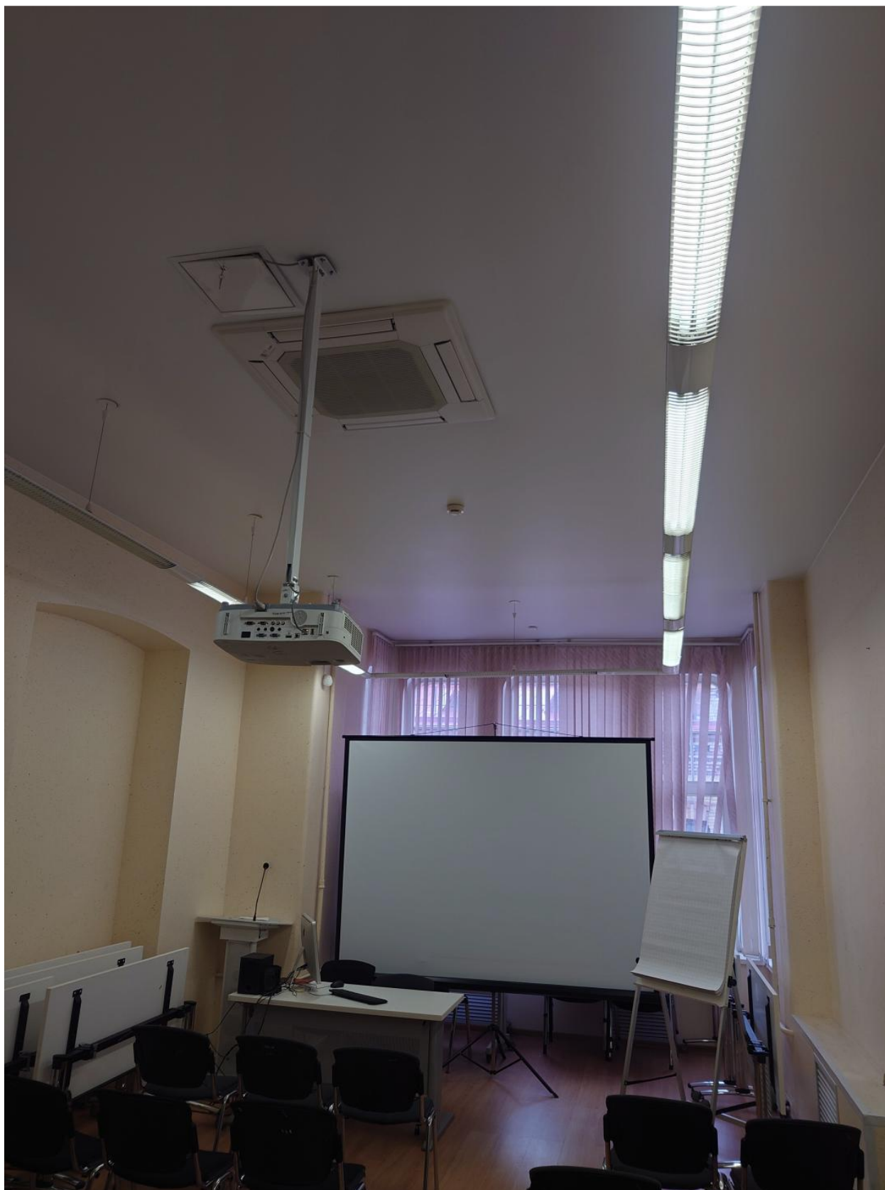
8. Пом. 11, вид на место предполагаемой установки кондиционера.
