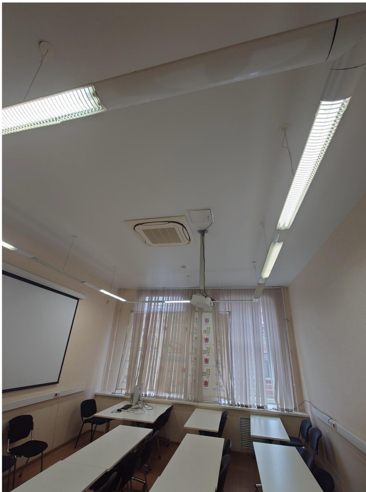
7. Пом. 9, вид на место предполагаемой установки кондиционера.
