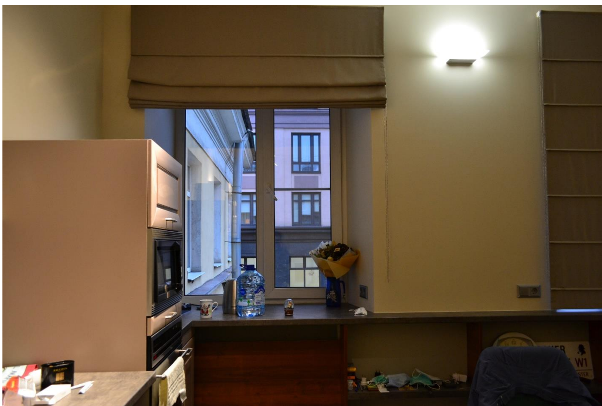
Фото 10. Вид на оконное заполнение в бывшем помещении №5 – кухня (согласно техническому паспорту № 3284/18 от 17.09.2018 г.)
