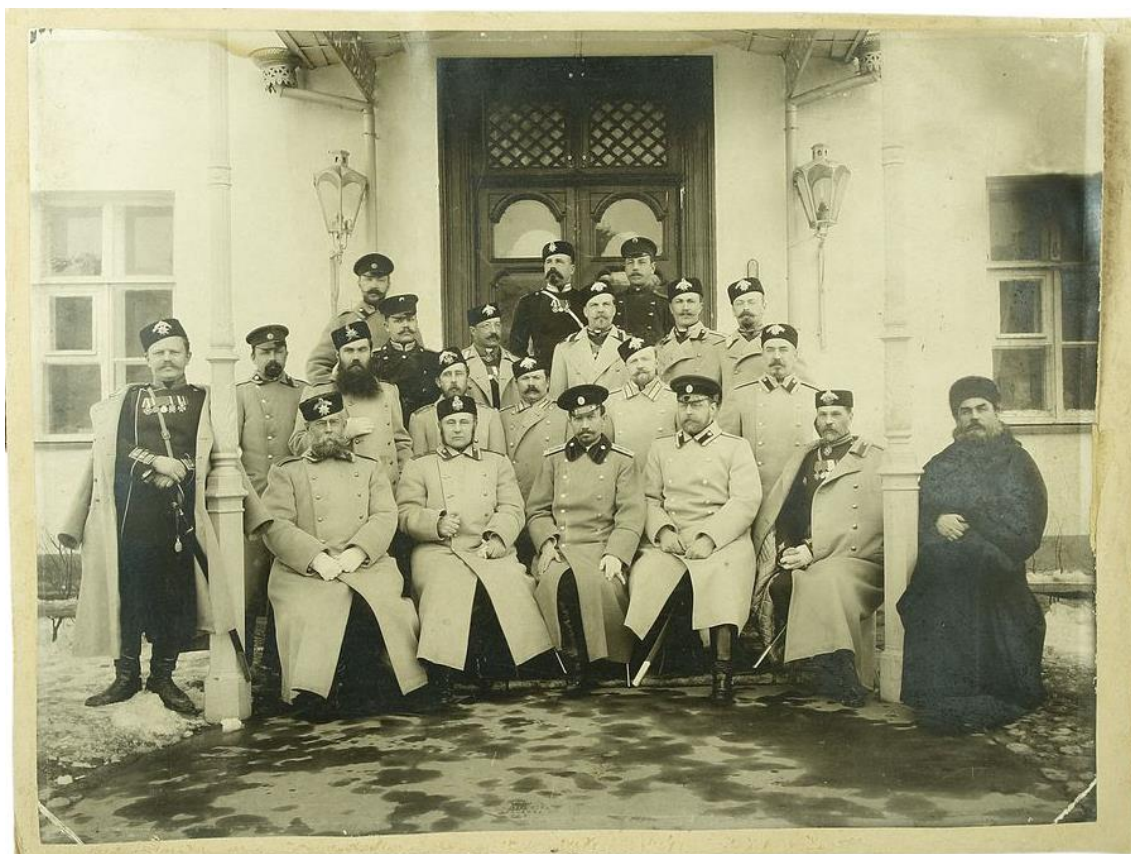
Илл. 4. Офицеры Лейб-Гвардии Саперного батальона у Третьего офицерского корпуса. Фото от 1906 г. (источник: https://pastvu.com/p/141568 )
