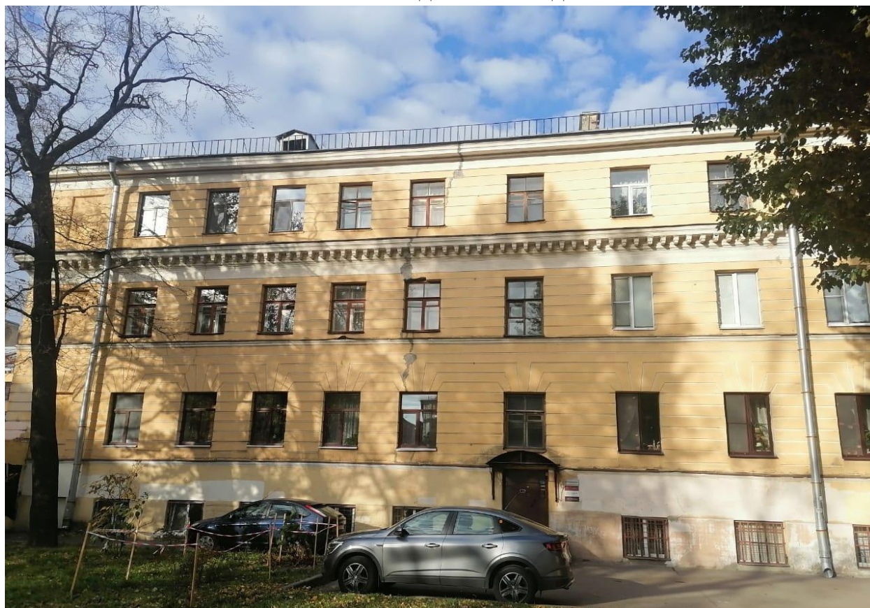
Фото 2. Фрагмент бокового (южного) фасада. Вид с юга.
