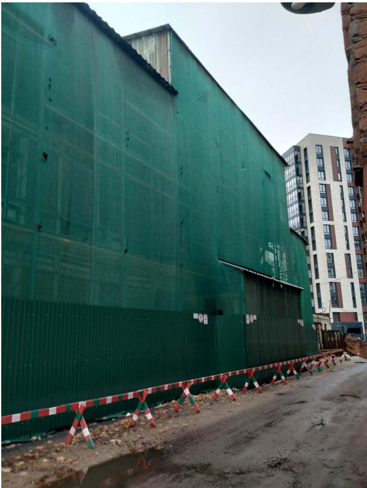
7. Фото 03 марта 2024г. Общий вид противоаварийного укрепления и временной кровли Особняка Н.Н. Струка. Комплекс машиностроительного завода.
