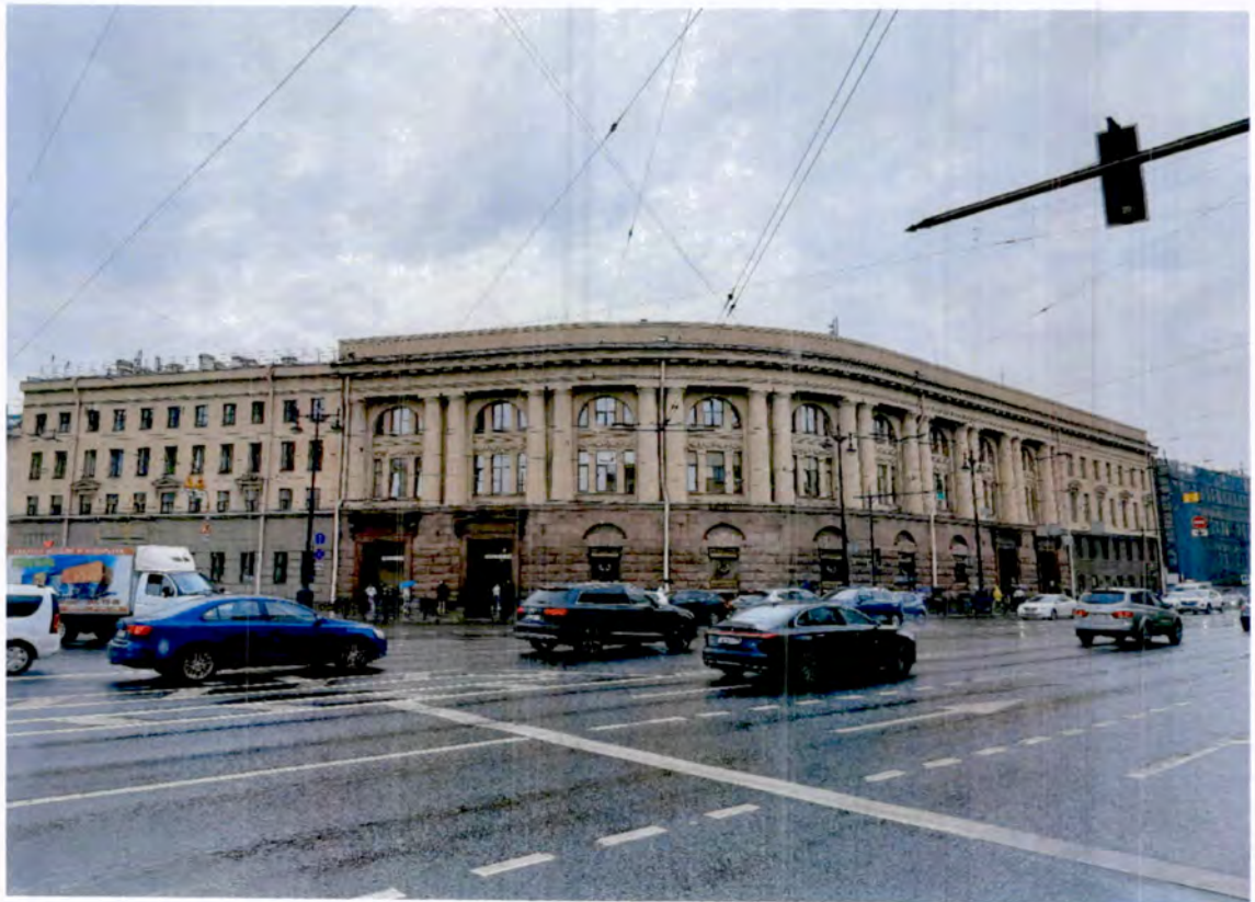
1. Общий вид на объект культурного наследия.
