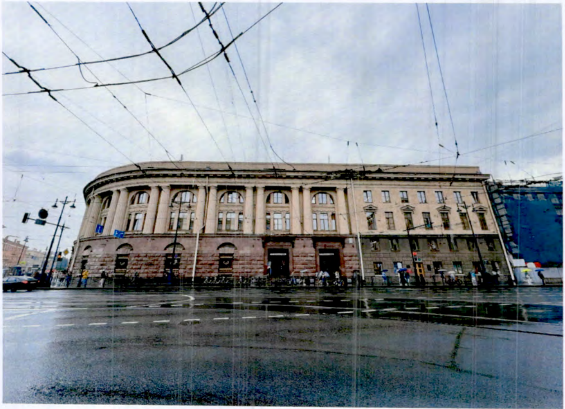
2. Общий вид на объект культурного наследия.
