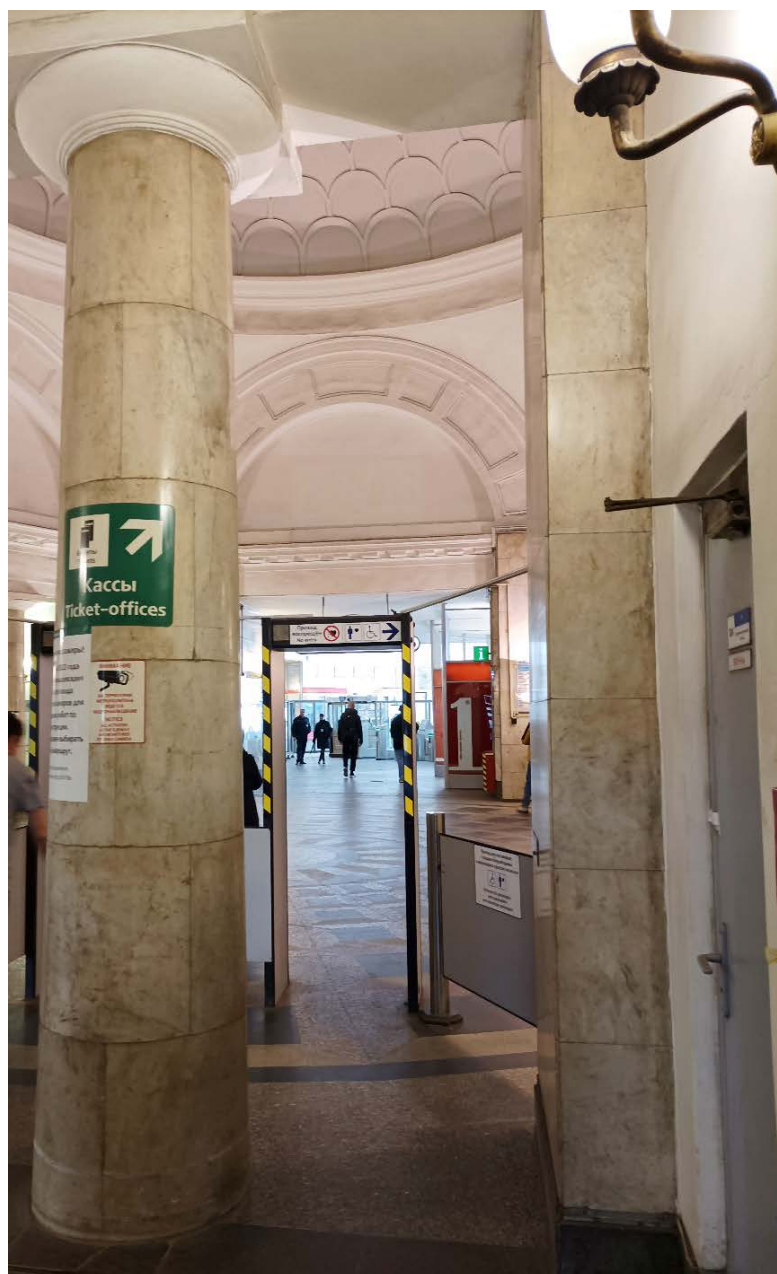
7. Объект культурного наследия регионального значения: «Станция метро «Технологический институт» (с перронным залом)», по адресу: Санкт-Петербург, Московский пр., д. 28, литера А. Вестибюль «Вход». Дата съемки: 21.03.2024г.
