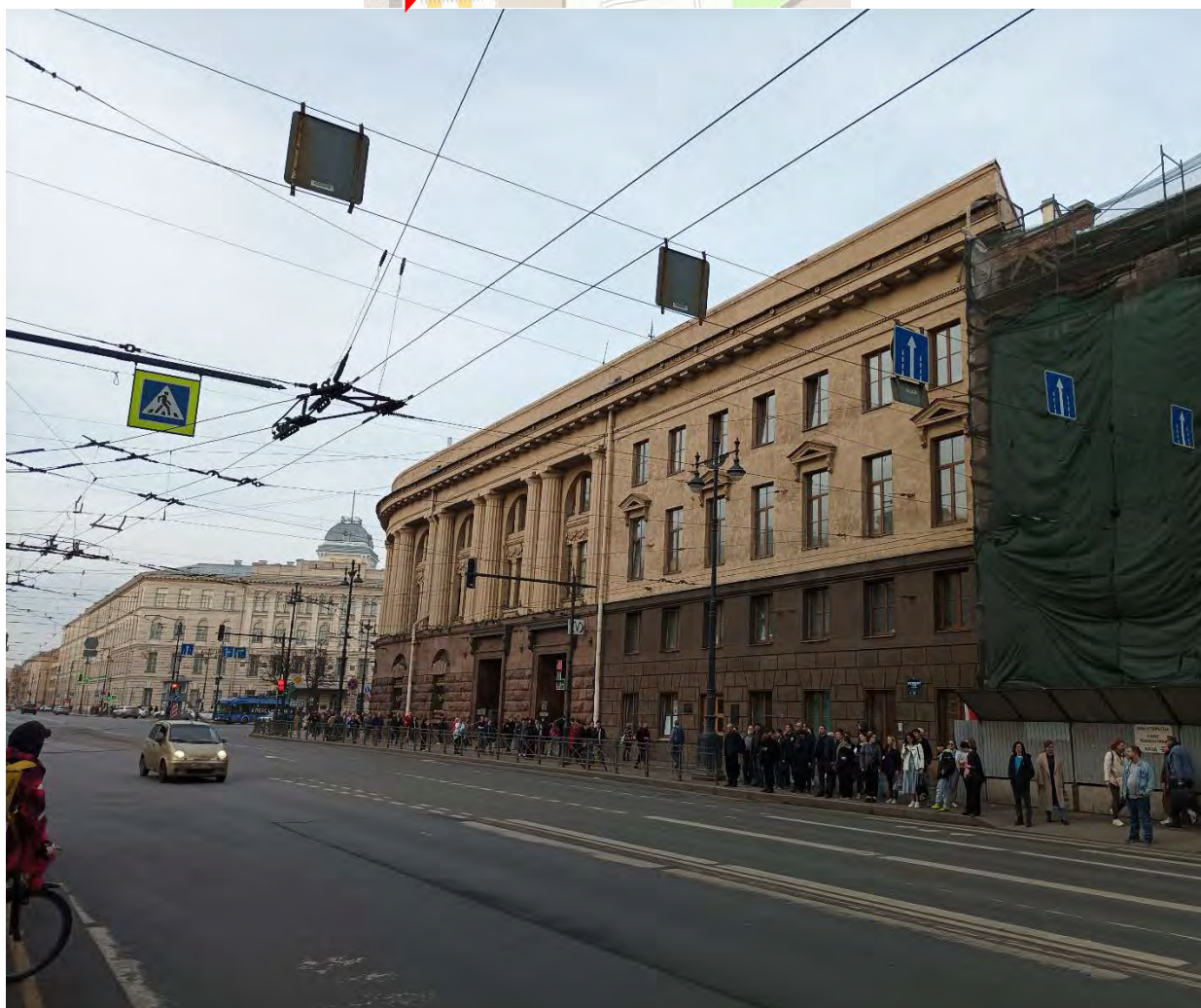
2. Объект культурного наследия регионального значения: «Станция метро «Технологический институт» (с перронным залом)», по адресу: Санкт-Петербург, Московский пр., д. 28, литера А. Общий вид объекта. Дата съемки: 21.03.2024г.
