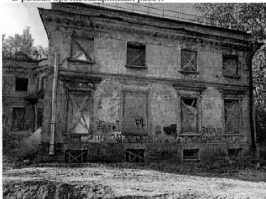
3. Северо-восточный фасад. Оконные проемы укреплены В рамках противоаварийных работ.
