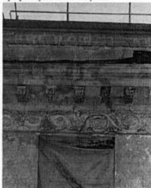
8. Северо-восточный фасад. Декоративный фриз и выносной профилированный карниз.
