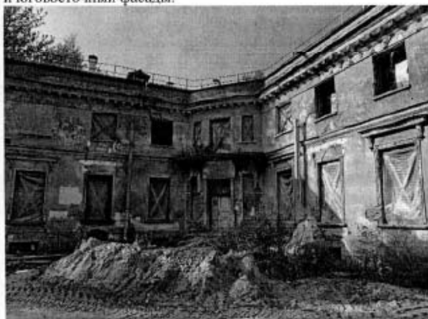
5. Угловой восточный, северо-восточный и юго-восточный фасады.
