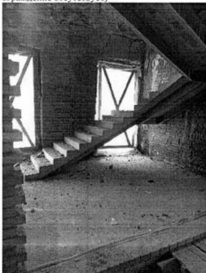
14. Позднейшая лестница (ступени – бетон, ограждение отсутствует)
