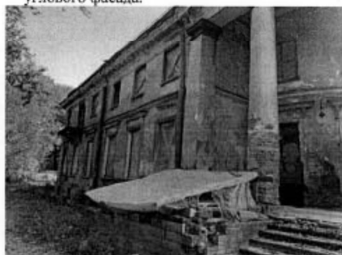
2. Северо-западный фасад. Крыльцо западного углового фасада.
