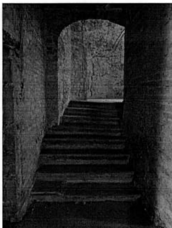
15. Средистенная лестница 2-го этажа.
