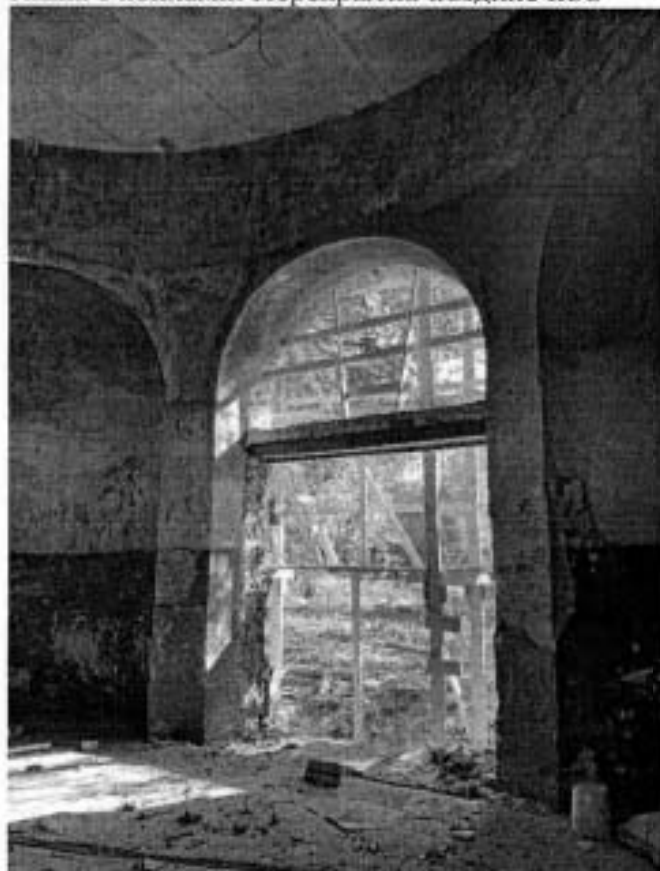
7. Пом. 3-Н (6). Ниши. Оконное заполнение демонтировано в ходе реставрационных работ. Ниша с конхами. Перекрытия поздние Ж/б
