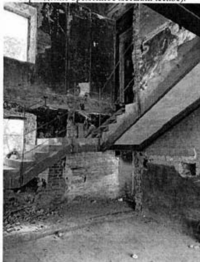
10. Позднейшая лестница. (Ступени – бетон Ограждение временное металлическое).
