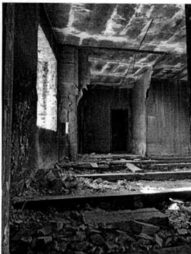
9. Состояние помещений объекта.
