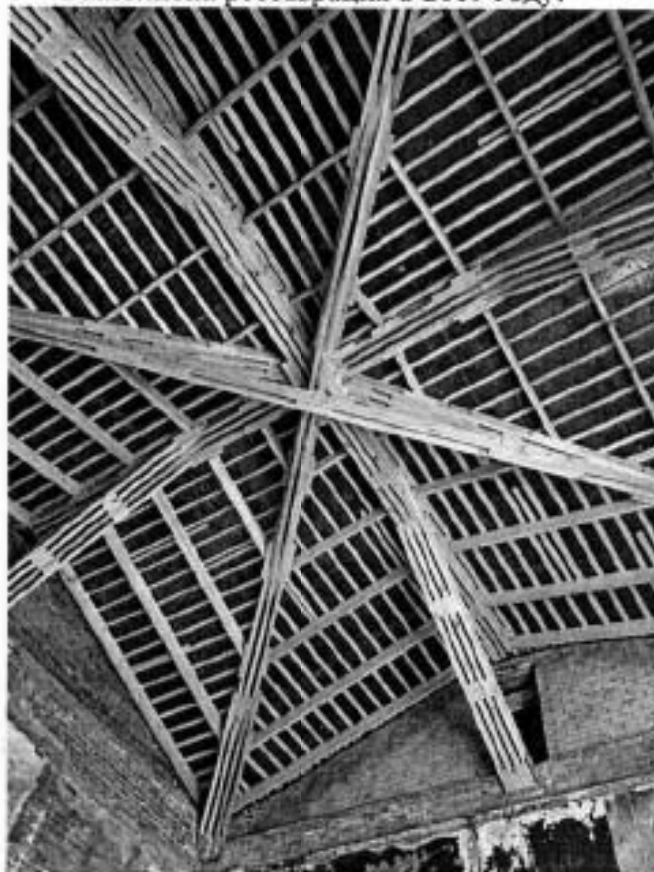
11. Конструкция крыши (из помещения) Выполнена реставрация в 2019 году.
