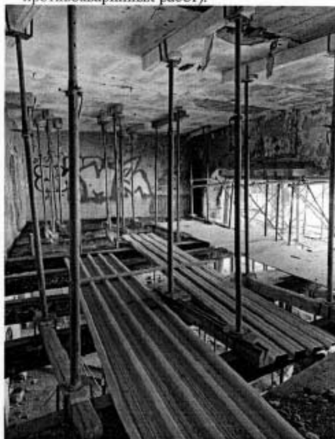
8. Помещение 2-го этажа. Укрепление перекрытий (частично демонтированы в ходе противоаварийных работ).
