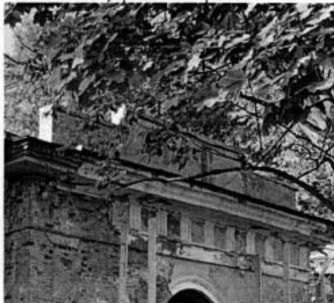
6. Восточный фасад (северная часть). Ступенчатый аттик (угловой элемент) В рамках работ по реставрации крыши выполнено укрепление карниза.
