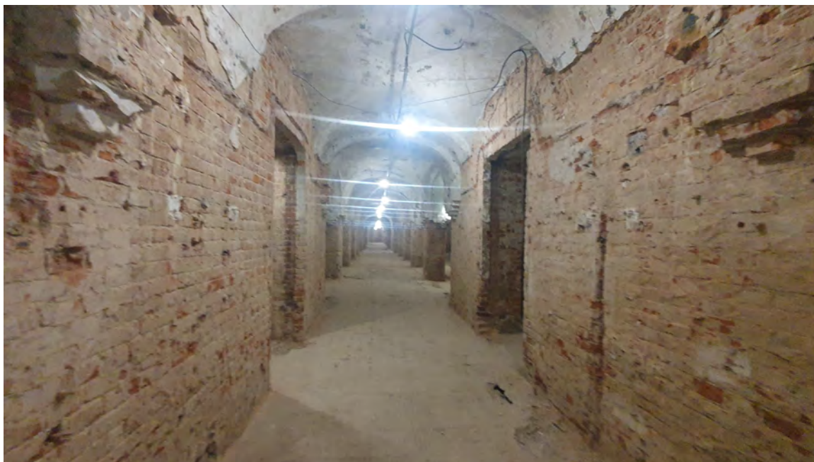
11. ОКН регионального значения «Главный производственный корпус Карточной фабрики» по адресу: г. Санкт-Петербург, пр. Обуховской Обороны, д. 110, лит. Б Коридор 1 этажа дата съемки: 11.10.2021
