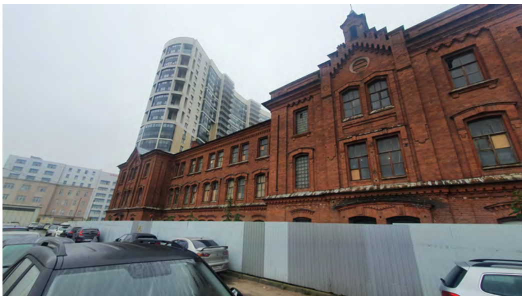
1. ОКН регионального значения «Главный производственный корпус Карточной фабрики» по адресу: г. Санкт-Петербург, пр. Обуховской Обороны, д. 110, лит. Б Вид на северный и западный фасады дата съемки: 11.10.2021
