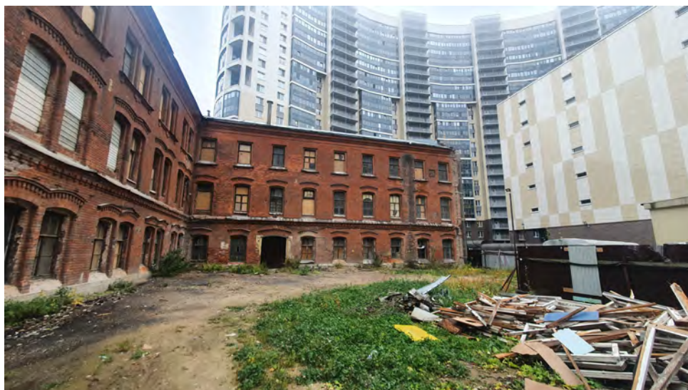
3. ОКН регионального значения «Главный производственный корпус Карточной фабрики» по адресу: г. Санкт-Петербург, пр. Обуховской Обороны, д. 110, лит. Б Южный фасад дата съемки: 11.10.2021
