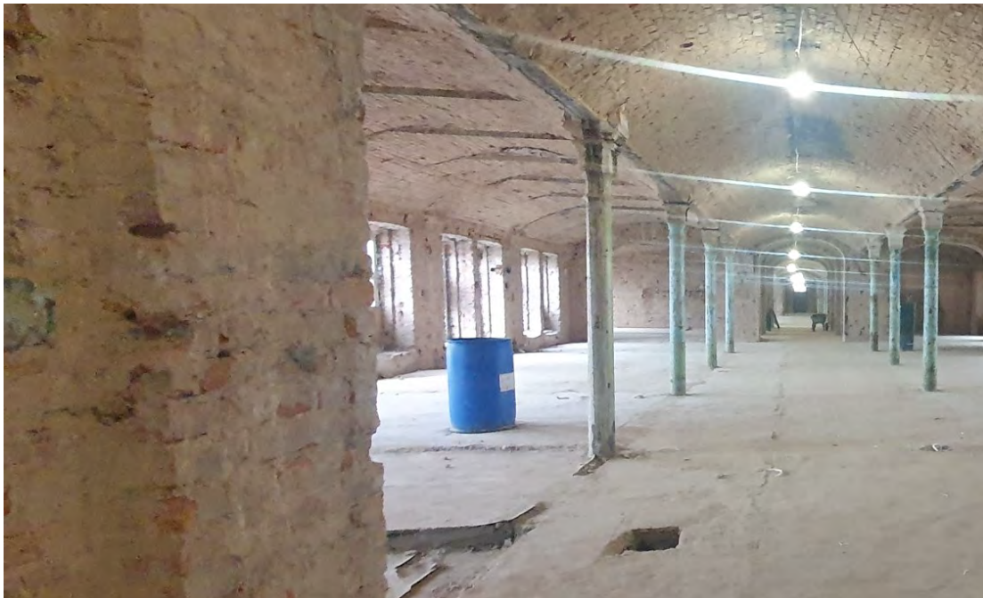
21. ОКН регионального значения «Главный производственный корпус Карточной фабрики» по адресу: г. Санкт-Петербург, пр. Обуховской Обороны, д. 110, лит. Б Коридор 3 этажа дата съемки: 11.10.2021
