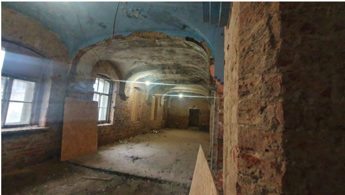
13. ОКН регионального значения «Главный производственный корпус Карточной фабрики» по адресу: г. Санкт-Петербург, пр. Обуховской Обороны, д. 110, лит. Б Коридор 1 этажа дата съемки: 11.10.2021
