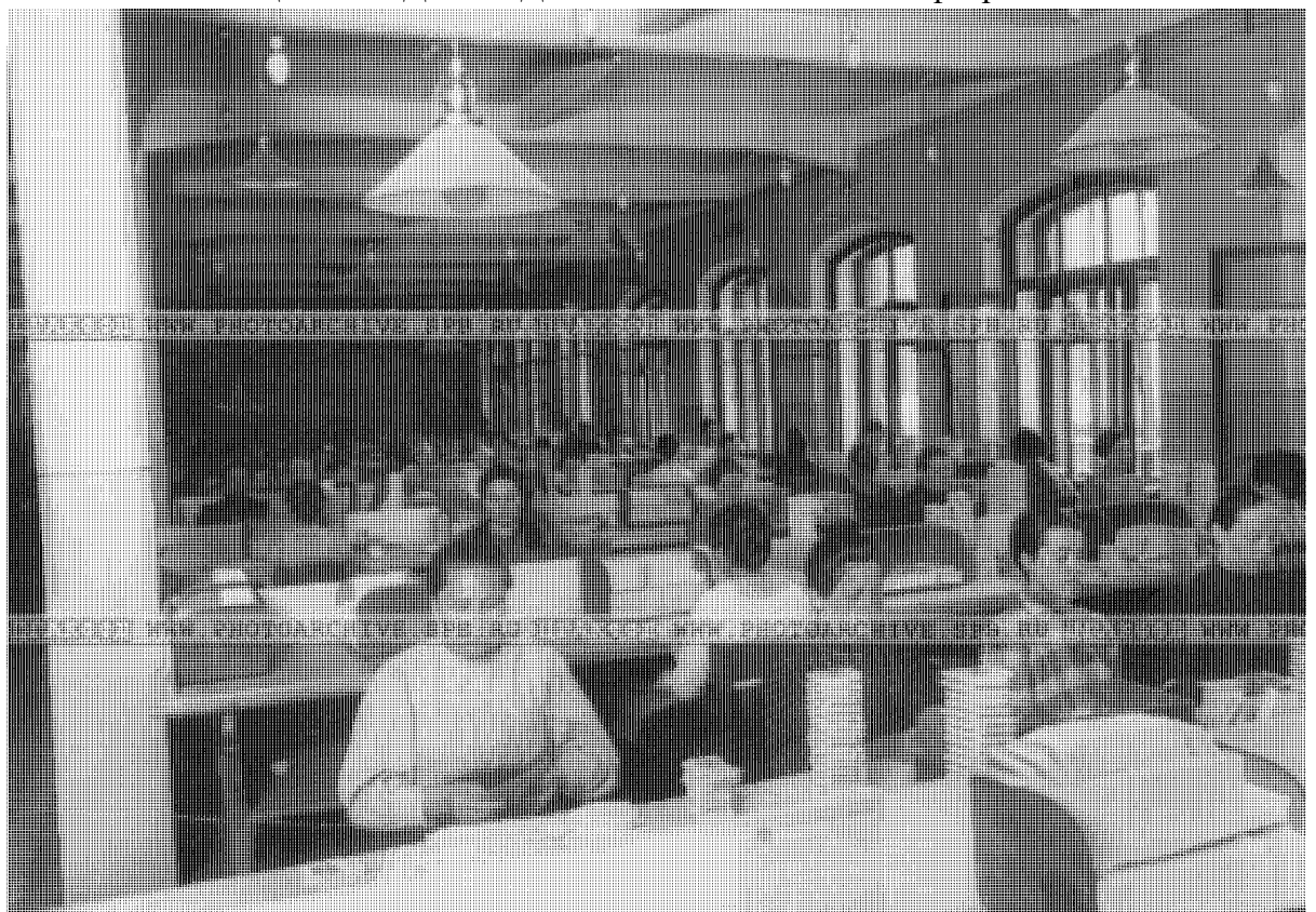
Илл. 12. ЦГАКФФД СПб. Д-17434. 1913 г. Вид части фабричного цеха. Пристройка 1909 г.
