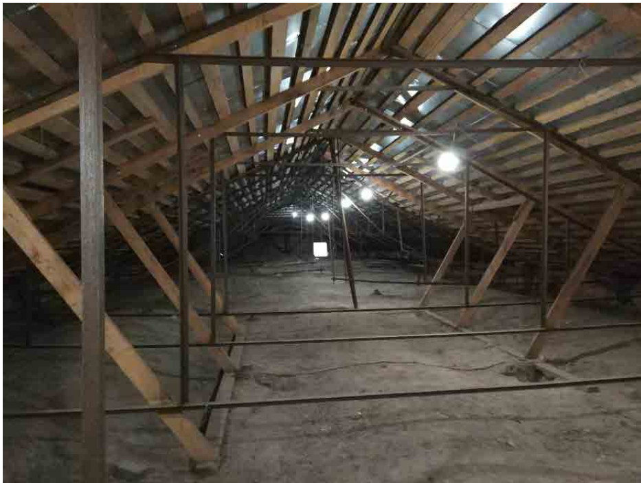
23. ОКН регионального значения «Главный производственный корпус Карточной фабрики» по адресу: г. Санкт-Петербург, пр. Обуховской Обороны, д. 110, лит. Б Чердак дата съемки: 11.10.2021
