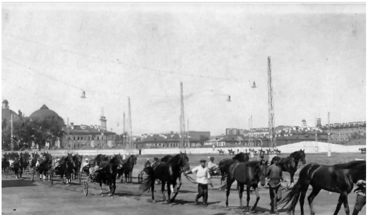
Илл.10. Ипподром на Семёновском плацу (участок производства работ). Фото 1920-1940 гг. Retro View of Mankind's Habitat [Электронный ресурс]. Режим доступа: https://pastvu.com/ .
