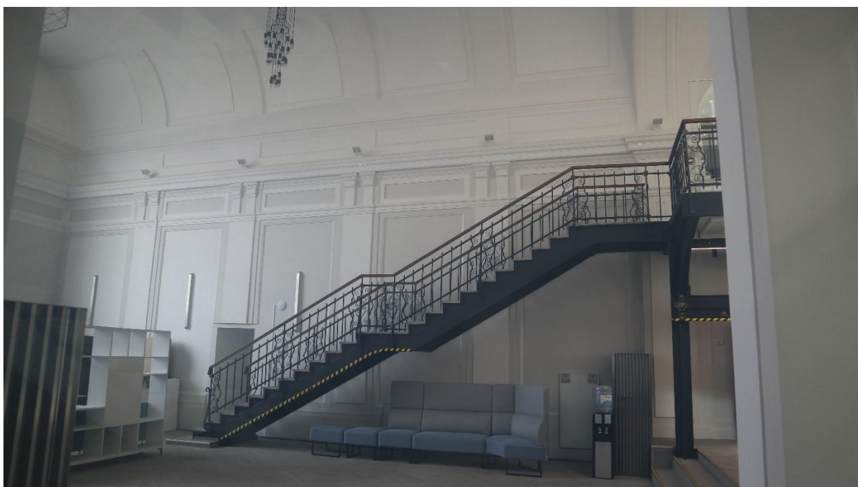
Фото 28. Помещение (б. телефонной станции). 4 этаж. Лестница металлической антресоли.
