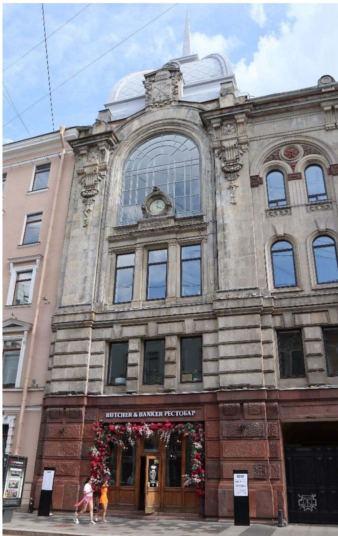
Фото 6. Лицевой фасад. Левая часть.
