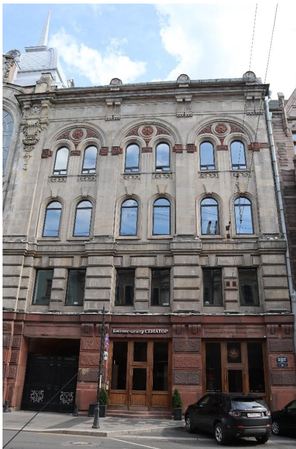
Фото 2. Лицевой фасад. Правая часть.
