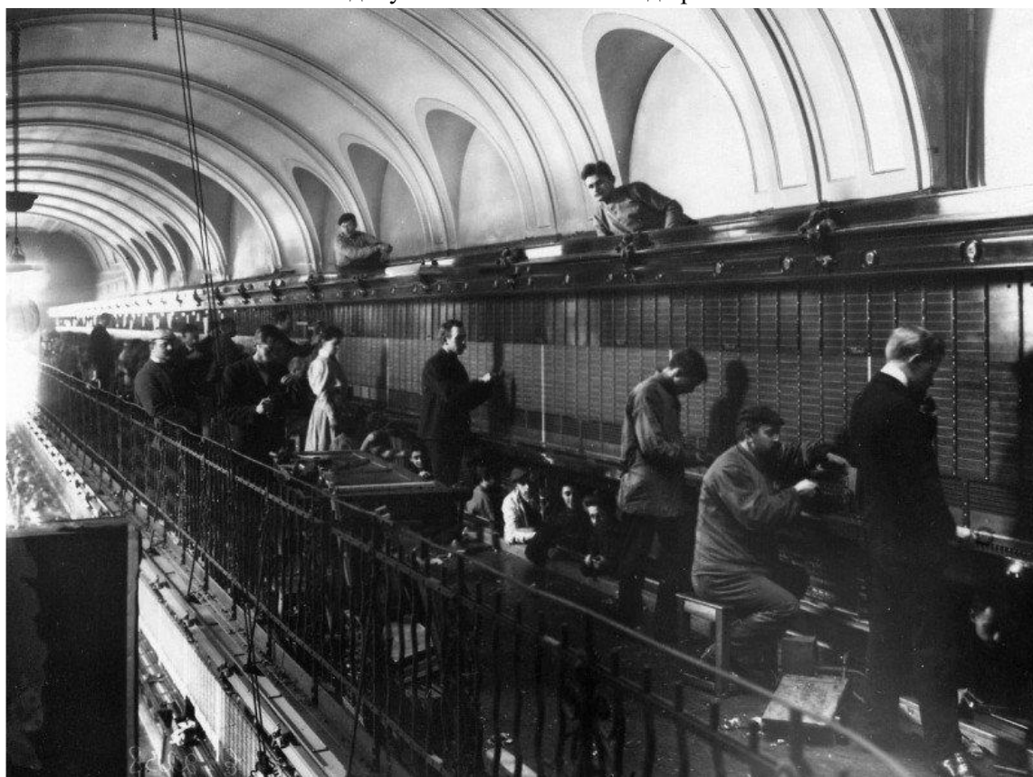
Илл. 72. Монтаж коммутаторов городской телефонной станции. Дата съемки: 1911 г. Фотография ателье К. Буллы. // ЦГАКФФД СПб. Фотодокументы. Описание 1Е-3. Ед.хр.2238
