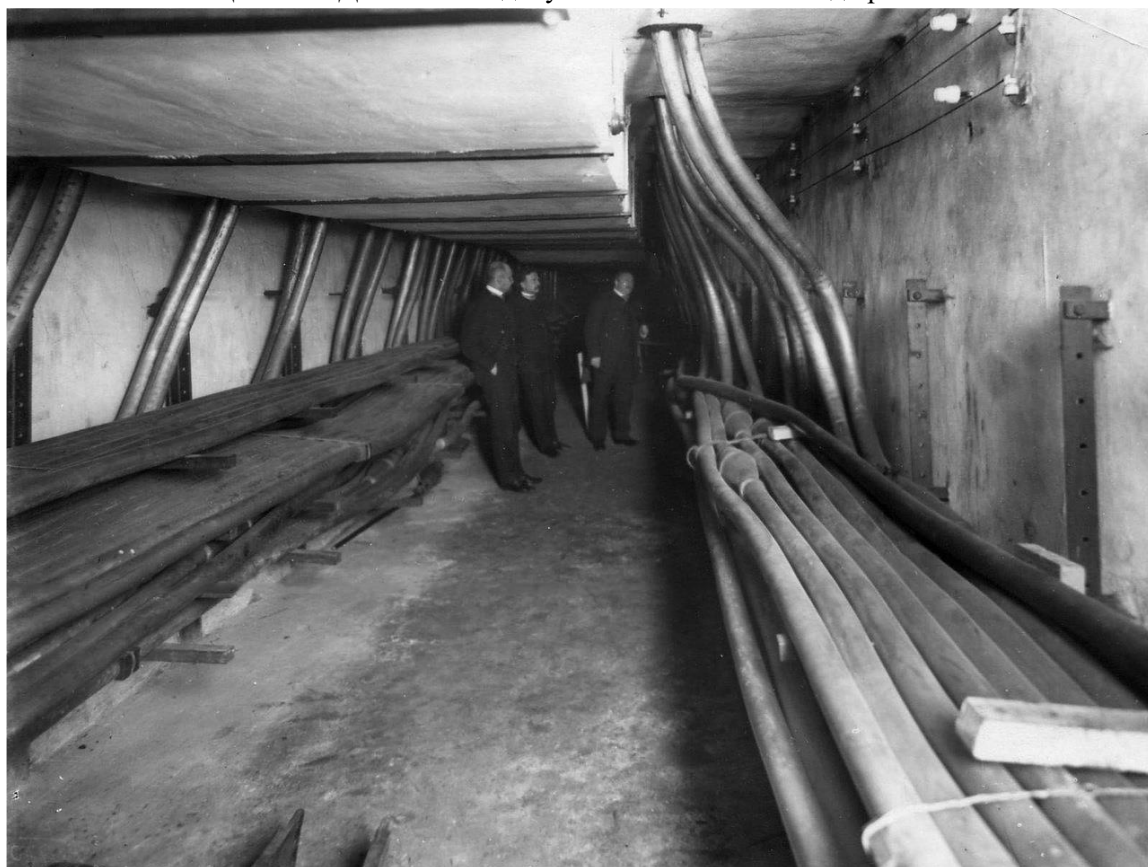
Илл. 70. Вывод подземных кабелей. Дата съемки: 1911 г. Фотография ателье К. Буллы. // ЦГАКФФД СПб. Фотодокументы. Опись 1Е-3. Ед.хр.2246
