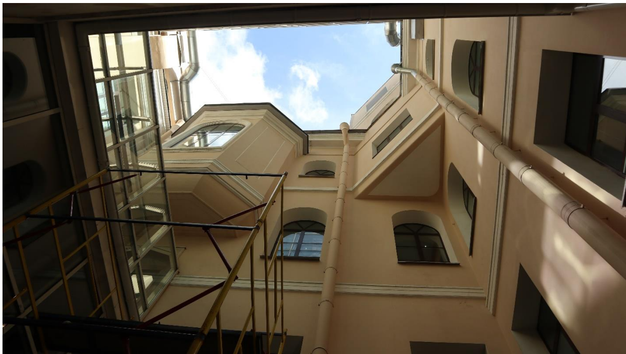
Фото 14. Дворовый фасад южного корпуса.
