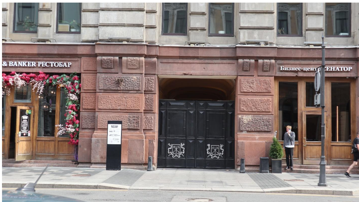
Фото 5. Лицевой фасад в уровне 1 этажа в центральной части – воротный проезд.
