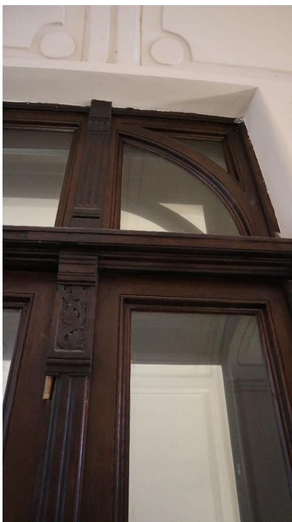
Фото 19. Фрагмент дверного заполнения.
