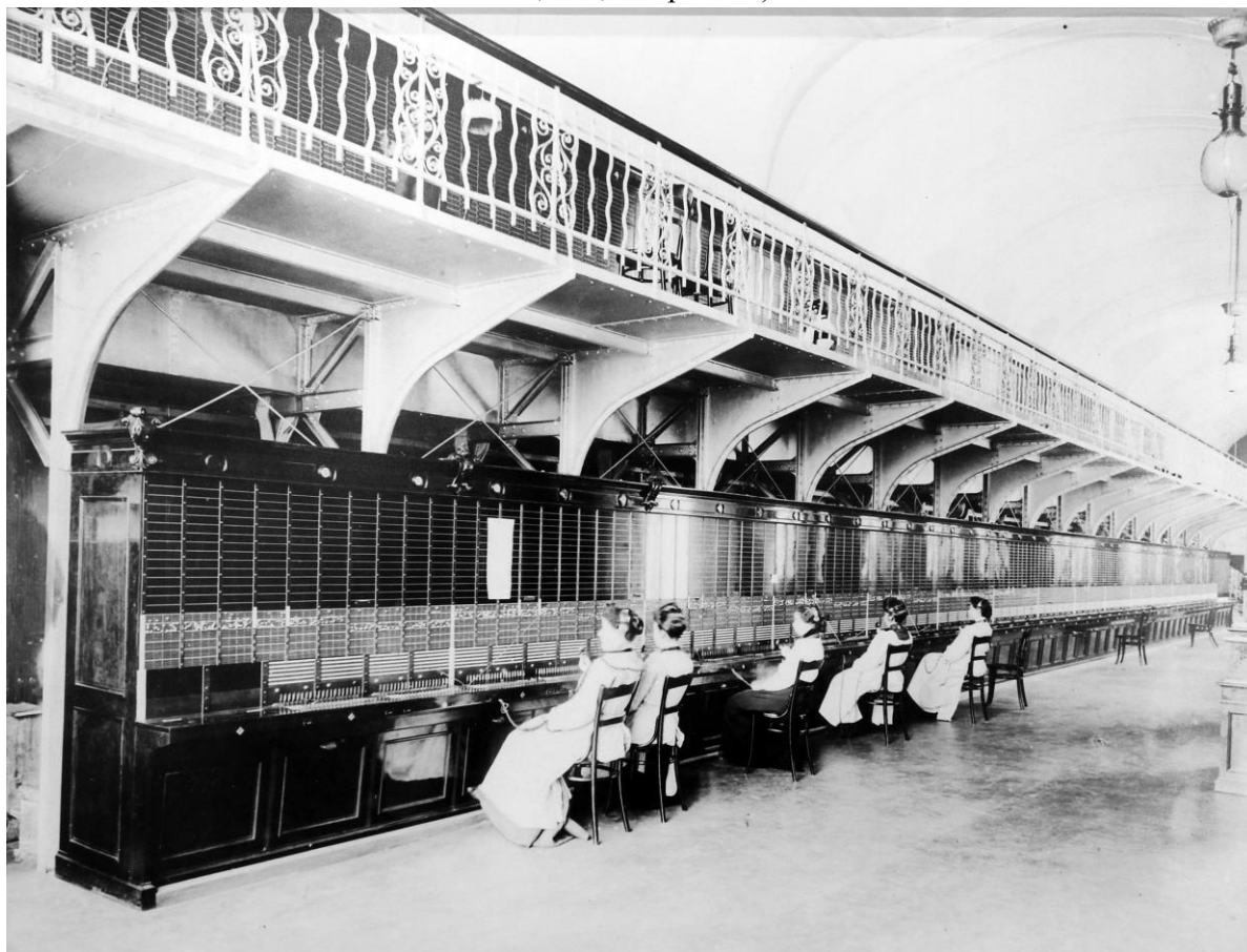
Илл. 68. Коммутаторный зал Центральной телефонной станции. 1905 г. //Источник: из фондов ЦМС им. Попова А.С.
