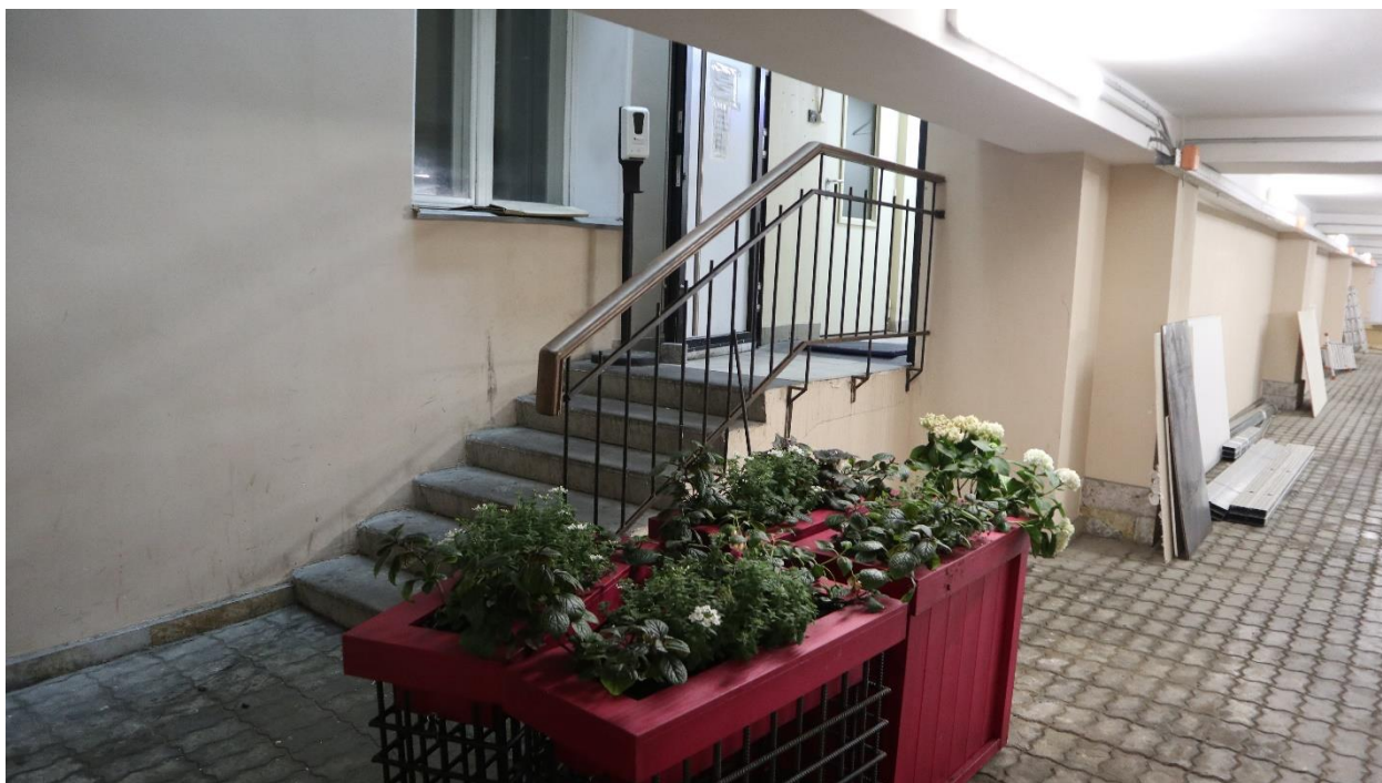
Фото 16. Перекрытый двор. Первый уровень – парковка.
