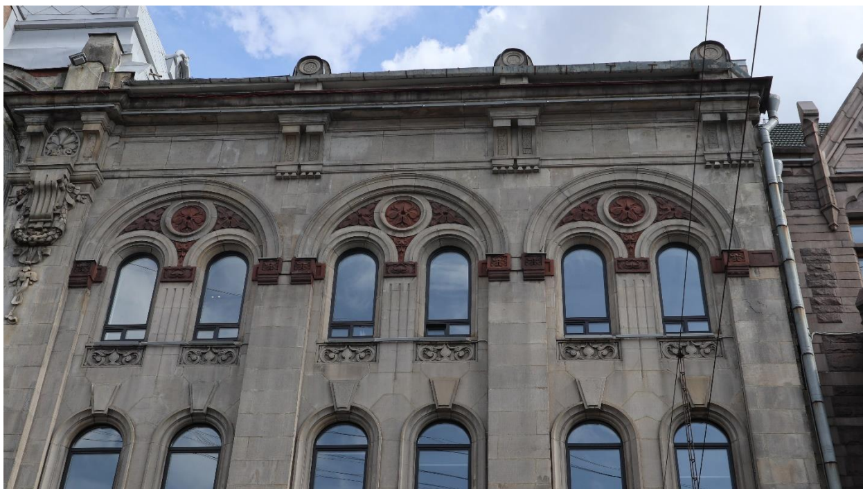
Фото 4. Лицевой фасад в уровне 3-4 этажей в правой части.
