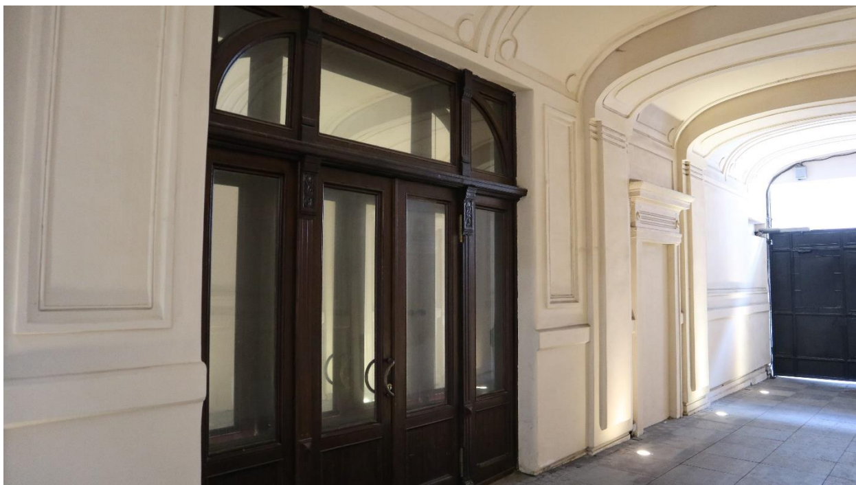
Фото 18. Воротный проезд. Дверной проем.
