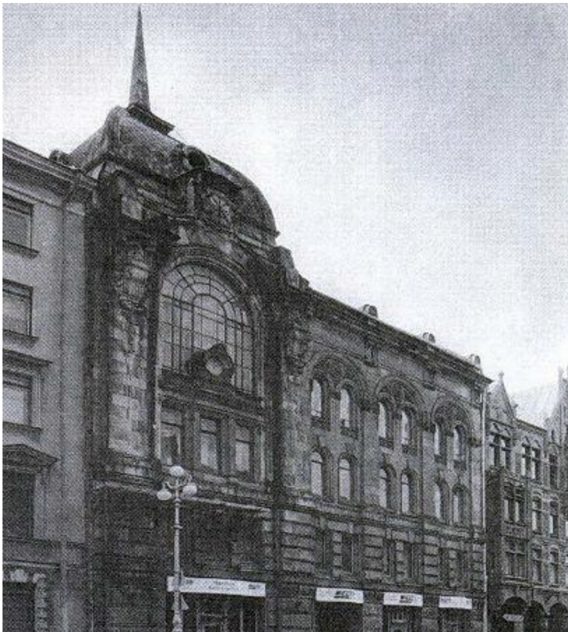
Илл. 88. Большая Морская ул., д. 22. Здание Центральной телефонной станции. Фасад здания. 2001 г. // Историческая застройка СПб: перечень вновь выявлен. объектов, представляющих ист., науч., худож. или иную культур. ценность: справочник / Науч. ред. Б.М. Кириков. – СПб.: Альт-Софт, 2001.
