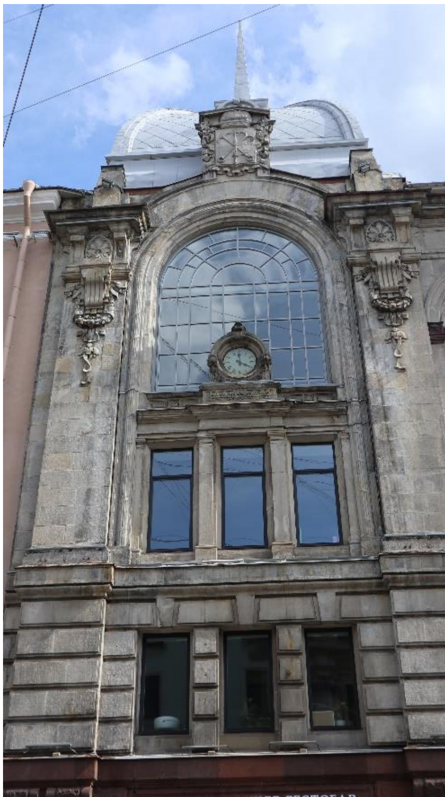
Фото 7. Лицевой фасад. Левая часть в уровне 2-4 этажей. Помещения телефонной станции.
