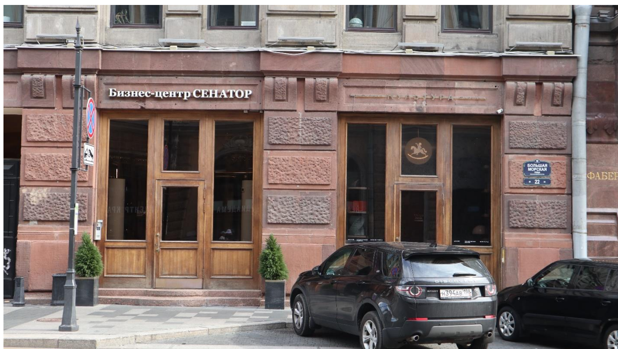
Фото 3. Лицевой фасад в уровне 1 этажа в правой части.
