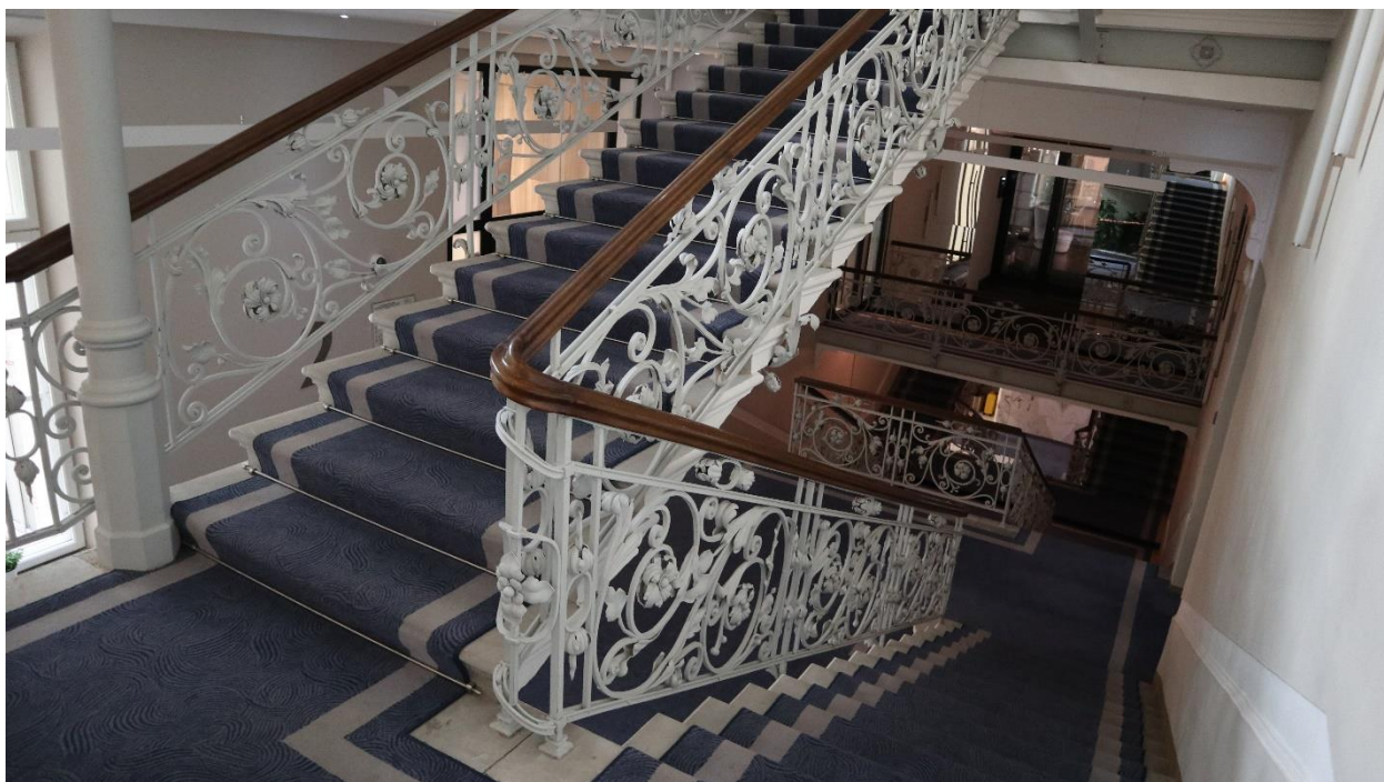
Фото 40. Лестница в лицевом корпусе
