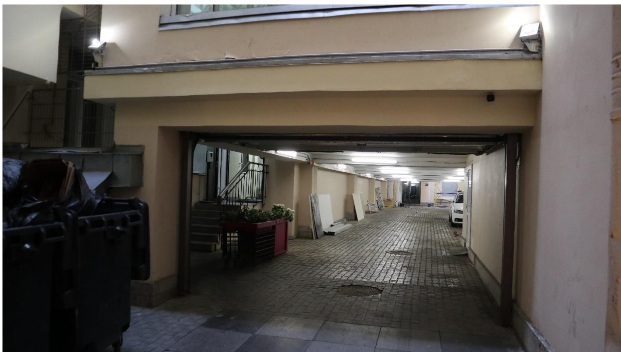
Фото 15. Перекрытый двор. Первый уровень – парковка.
