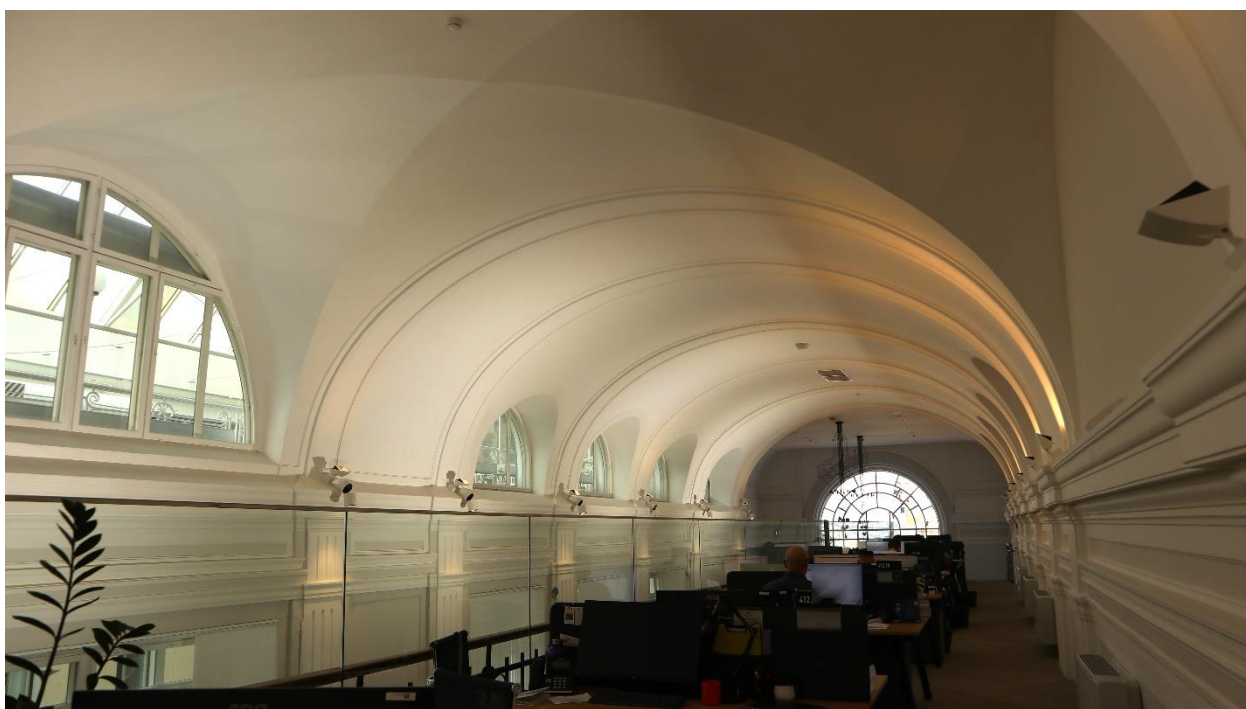
Фото 24. Помещение (б. телефонной станции). 4 этаж. Своды перекрытия.
