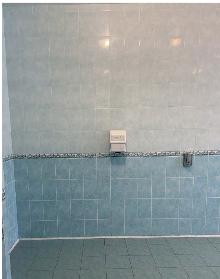
4. Вид на санузел мальчиков 2 этаж 1 корпус
