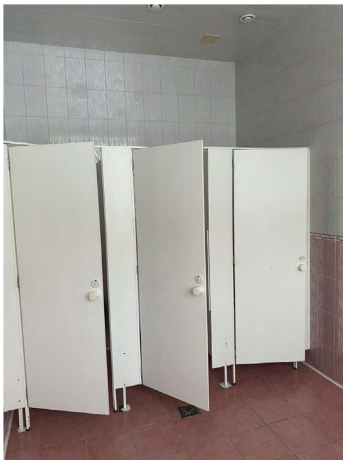
3. Вид на санузел девочек 3 этаж 1 корпус
