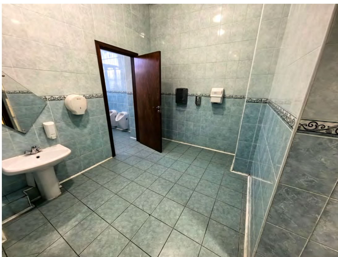
3. Вид на санузел девочек 2 этаж 2 корпус
