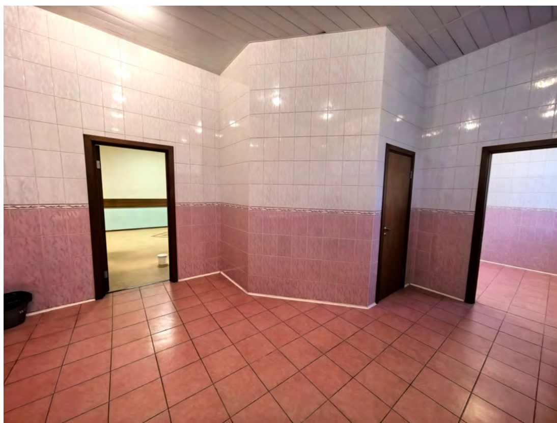
1. Вид на санузел девочек 2 этаж 1 корпус
