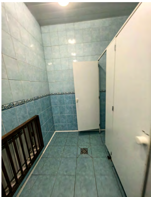
4. Вид на санузел мальчиков 1 этаж 2 корпус
