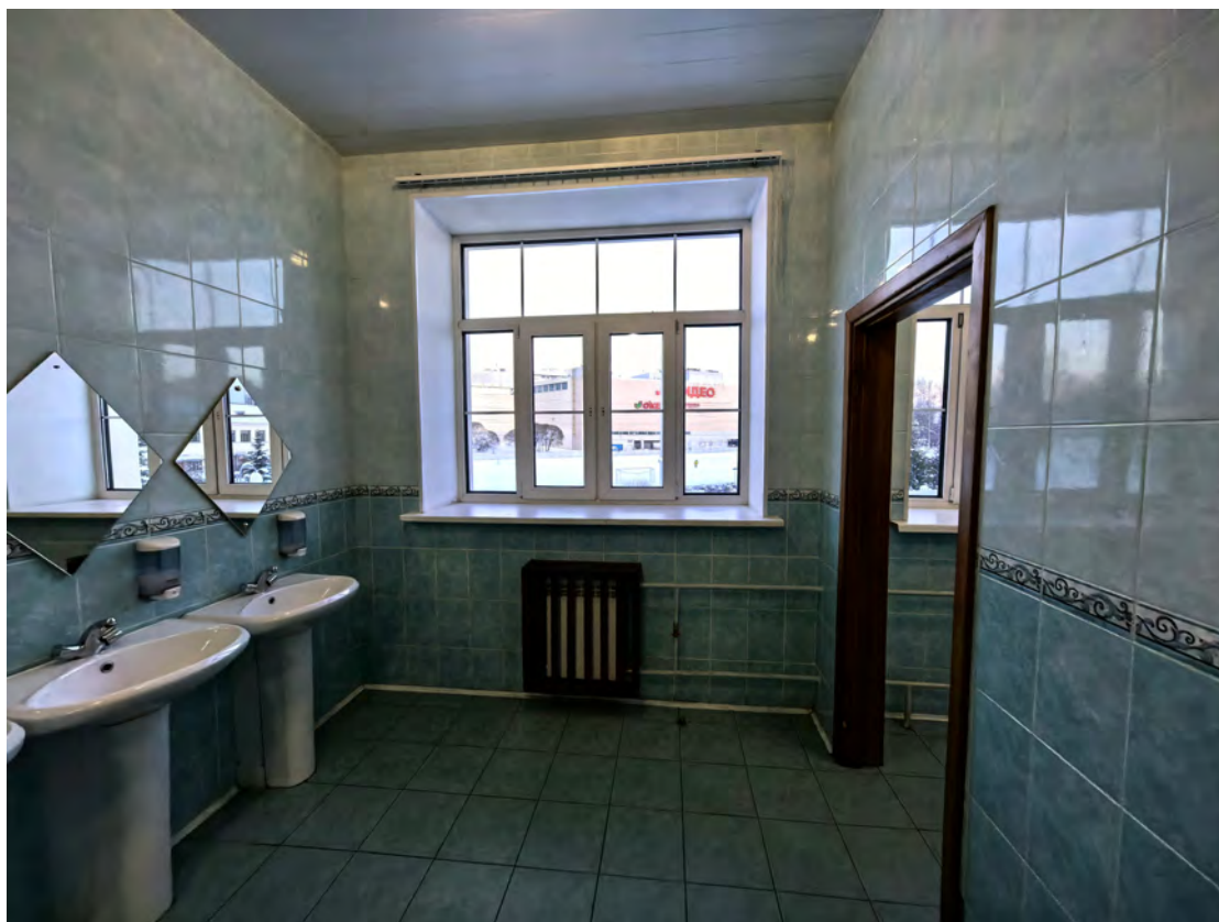
5. Вид на санузел мальчиков 2 этаж 1 корпус
