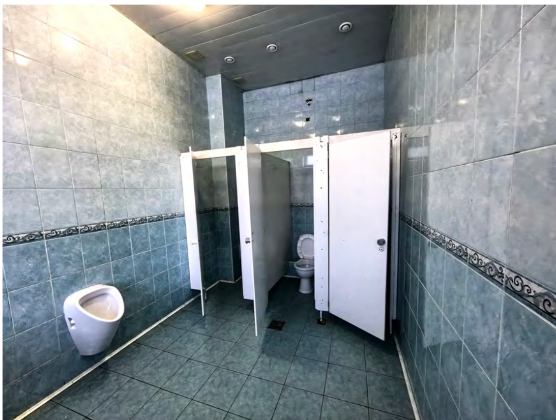
6. Вид на санузел мальчиков 2 этаж 1 корпус
