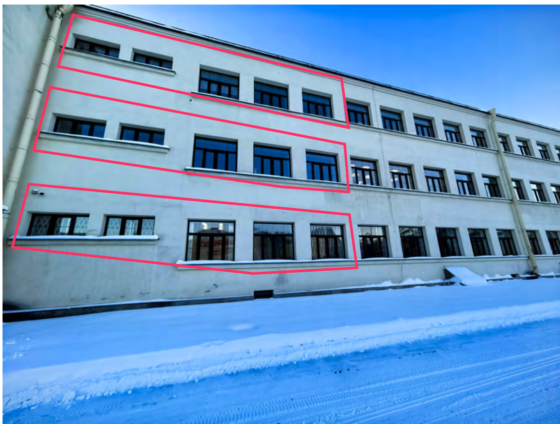
3. Вид на окна санузлов 1, 2, 3, этажей 1 корпуса
