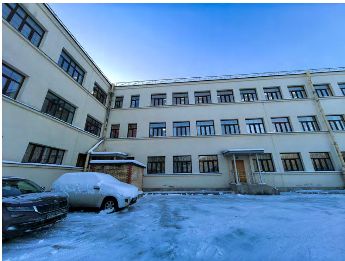
1. Вид на дворовой фасад
