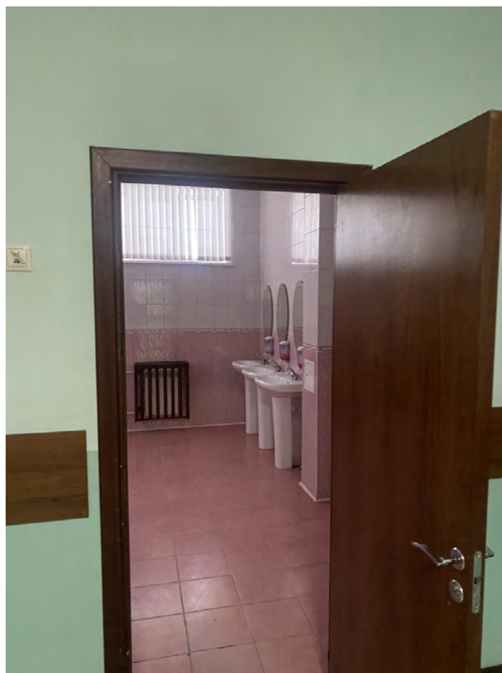
1. Вид на санузел девочек 3 этаж 1 корпус
