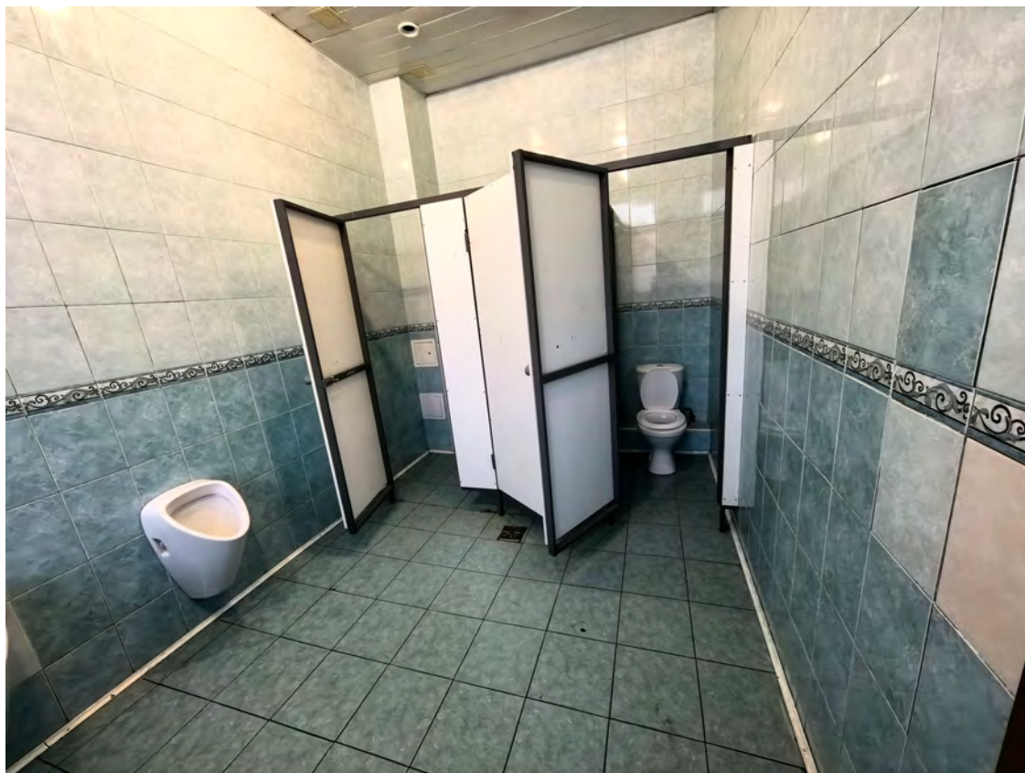
6. Вид на санузел мальчиков 3 этаж 1 корпус
