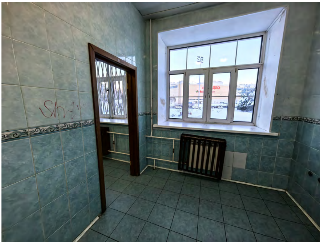
6. Вид на санузел мальчиков 1 этаж 1 корпус
