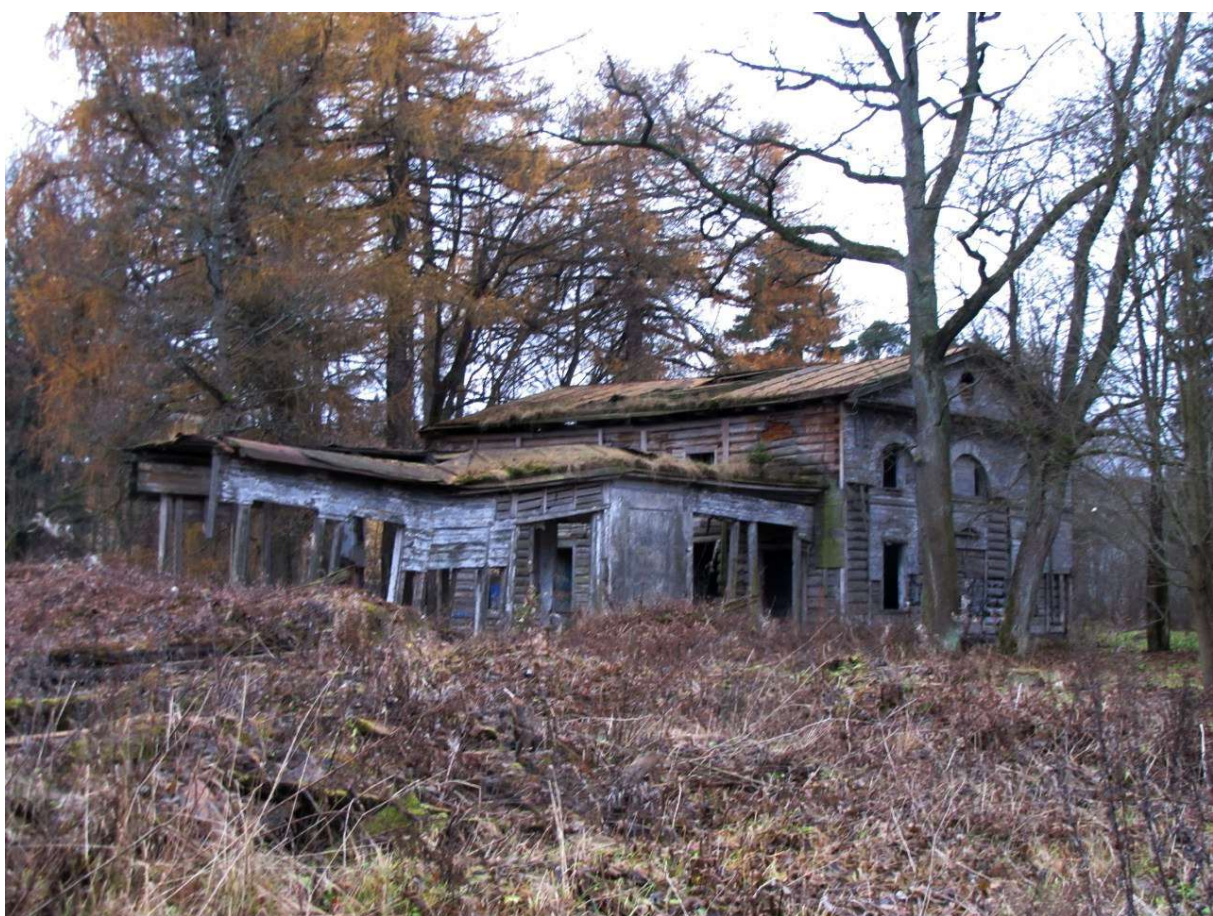
23. Современное состояние Усадьбы Вяземских (после пожара)
