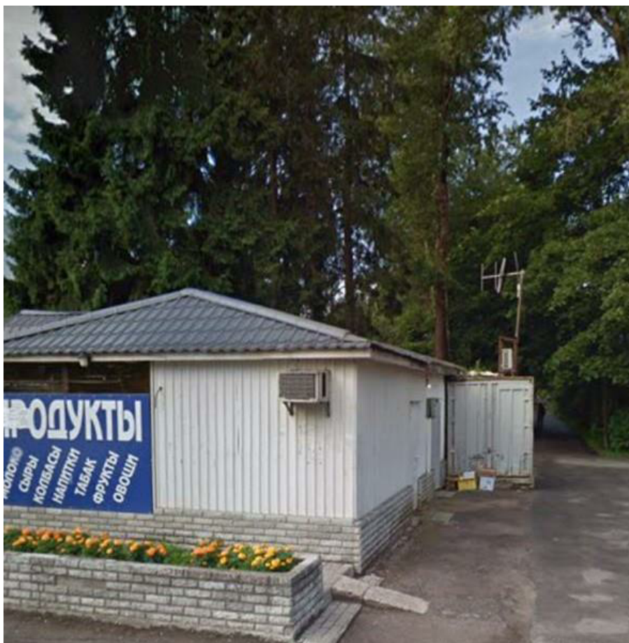
Фото № 6. СПб, Осиновая Роща, Приозерское шоссе, дом 15, корп. 6. Павильон. Боковой фасад по Межозерной улице
