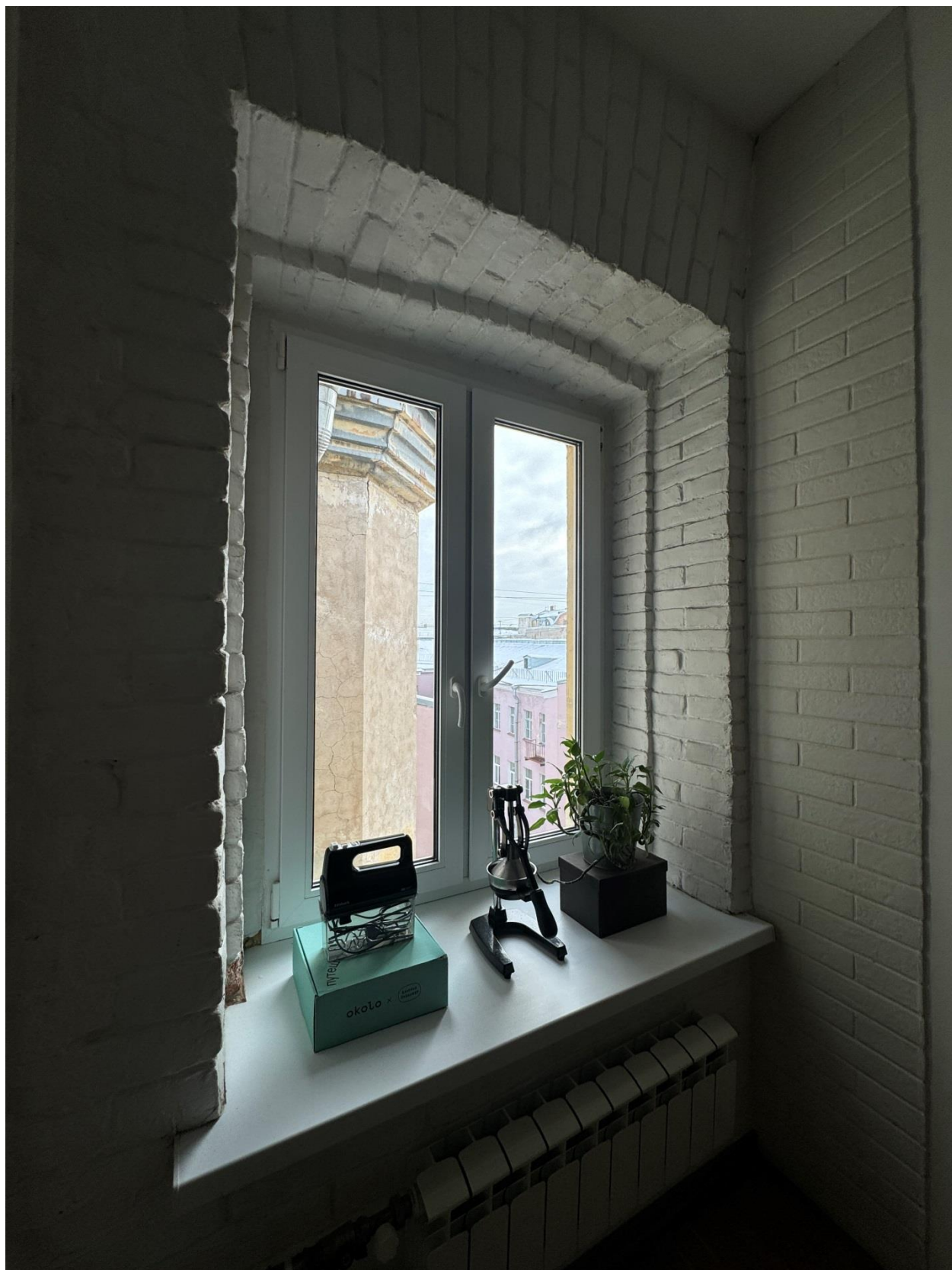
Фото 56. Вид на оконное заполнение квартиры № 32 объекта культурного наследия.
