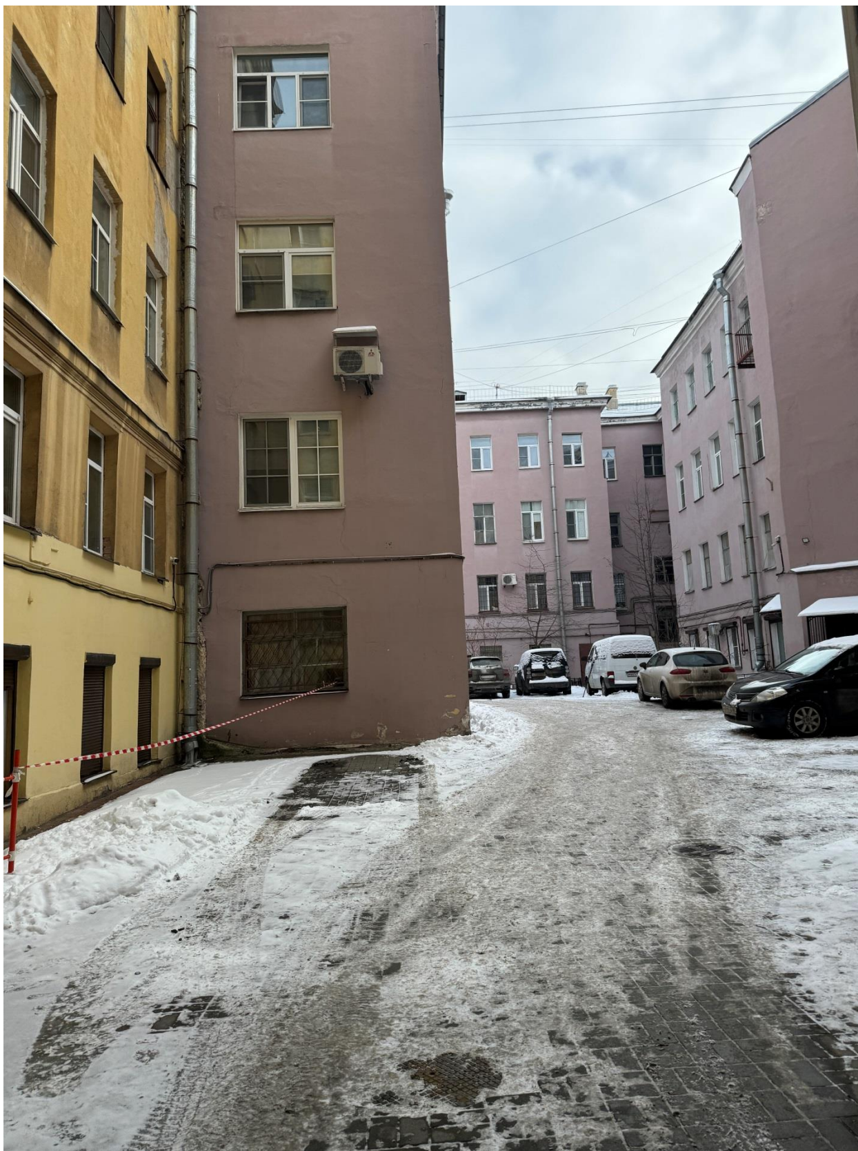
Фото 11. Общий вид восточного двора объекта культурного наследия.
