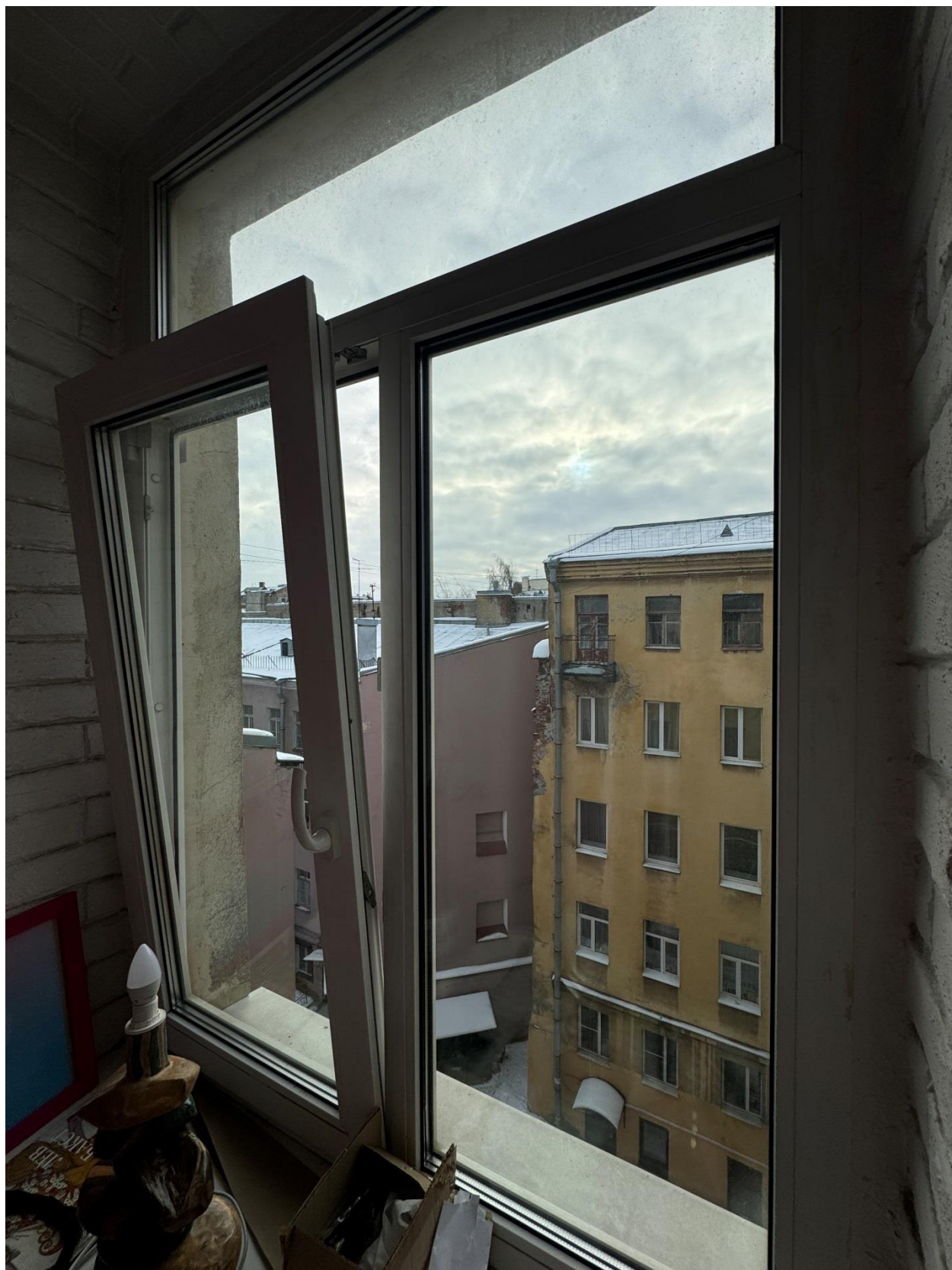
Фото 35. Вид на оконное заполнение квартиры № 32 объекта культурного наследия.
