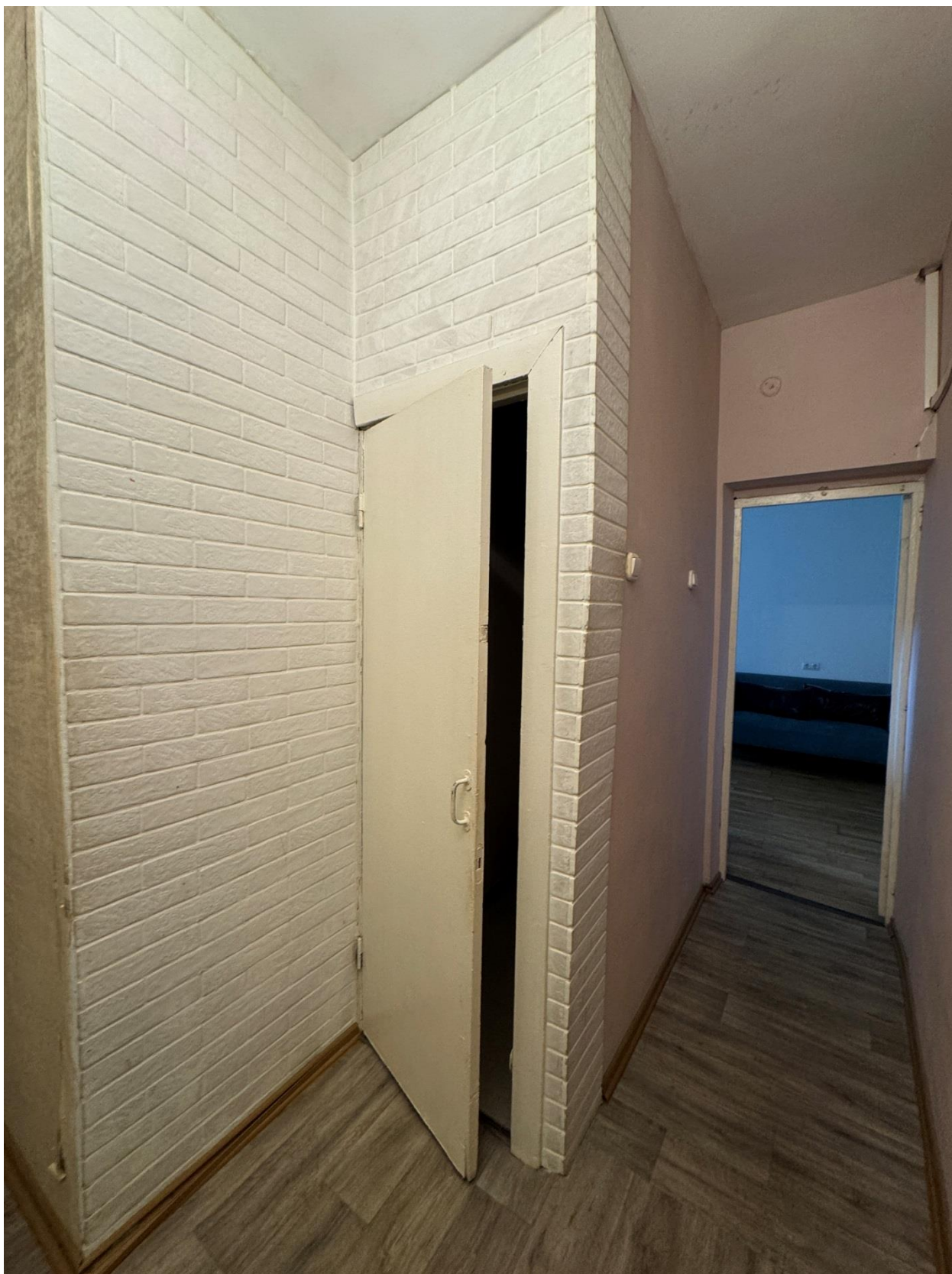
Фото 50. Вид на помещение квартиры № 32 объекта культурного наследия.
