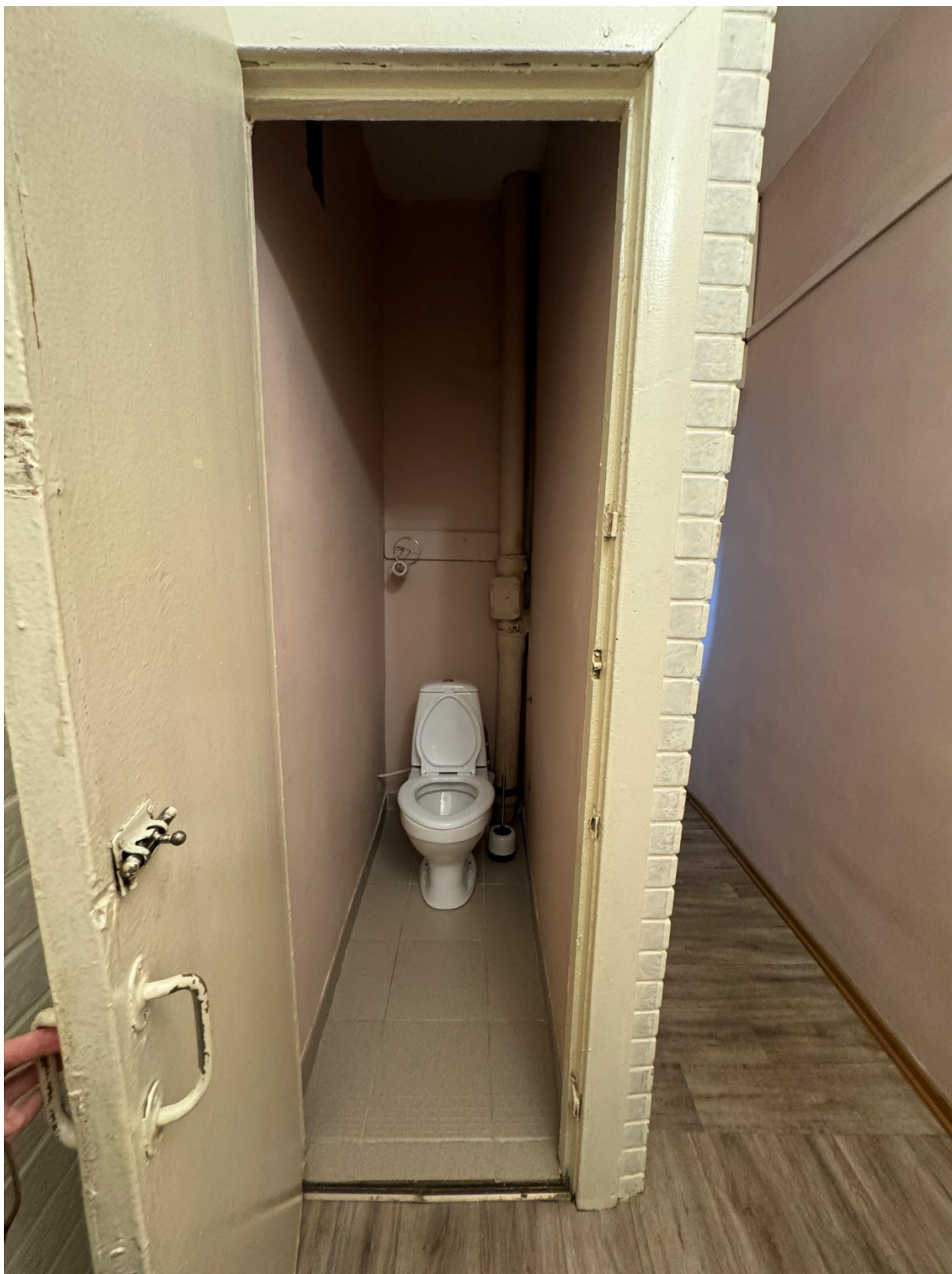
Фото 49. Вид на помещение квартиры № 32 объекта культурного наследия.
