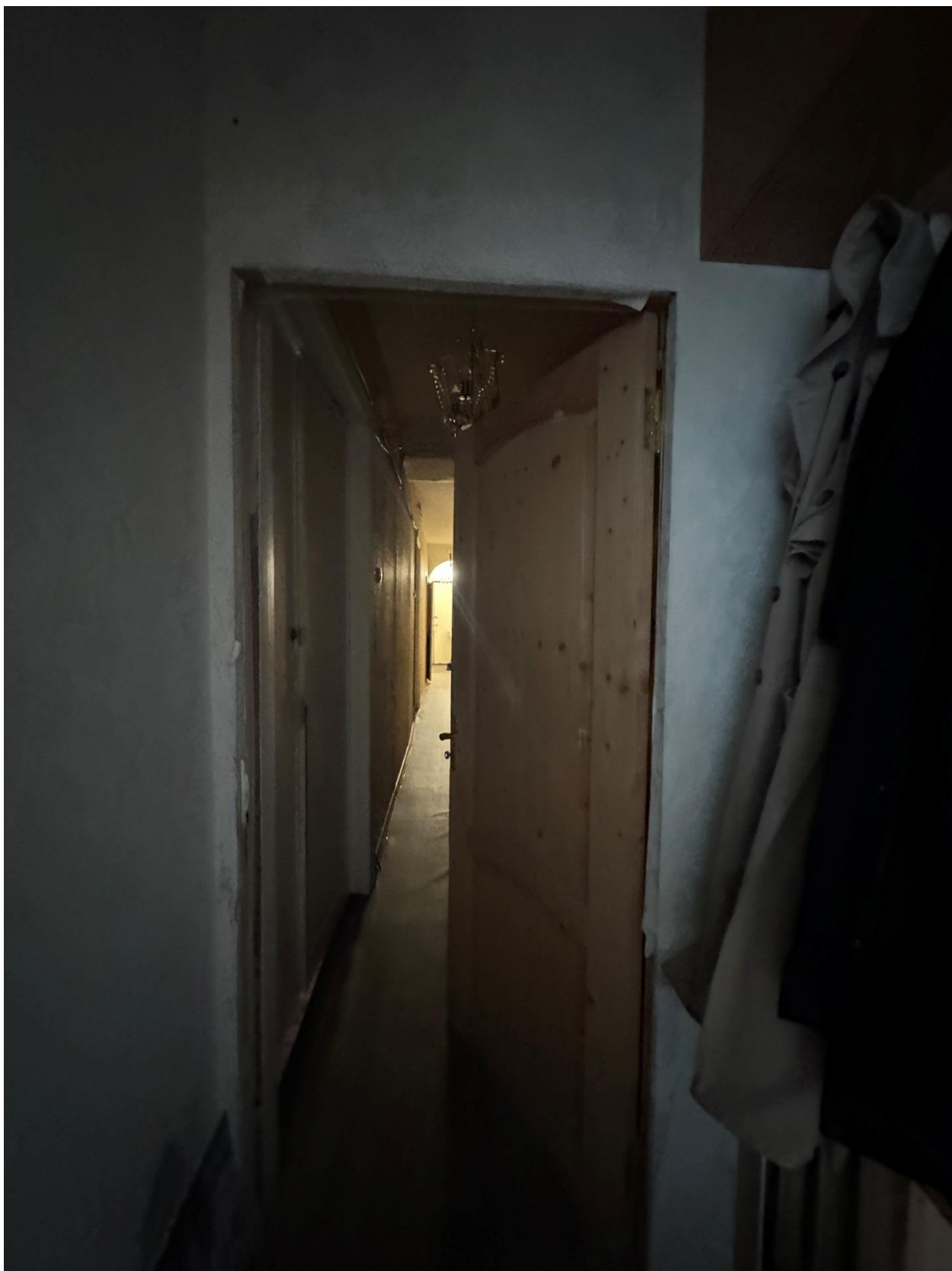
Фото 47. Вид на помещение квартиры № 32 объекта культурного наследия.
