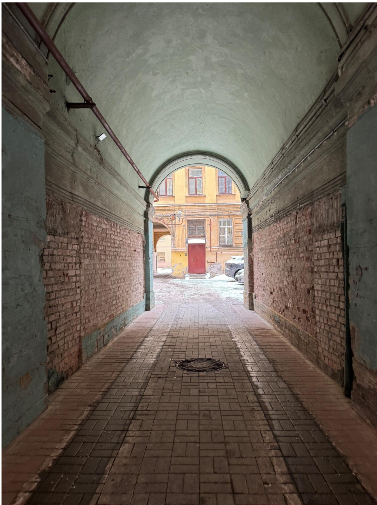
Фото 6. Вид на арку проезда объекта культурного наследия в сторону западного двора.
