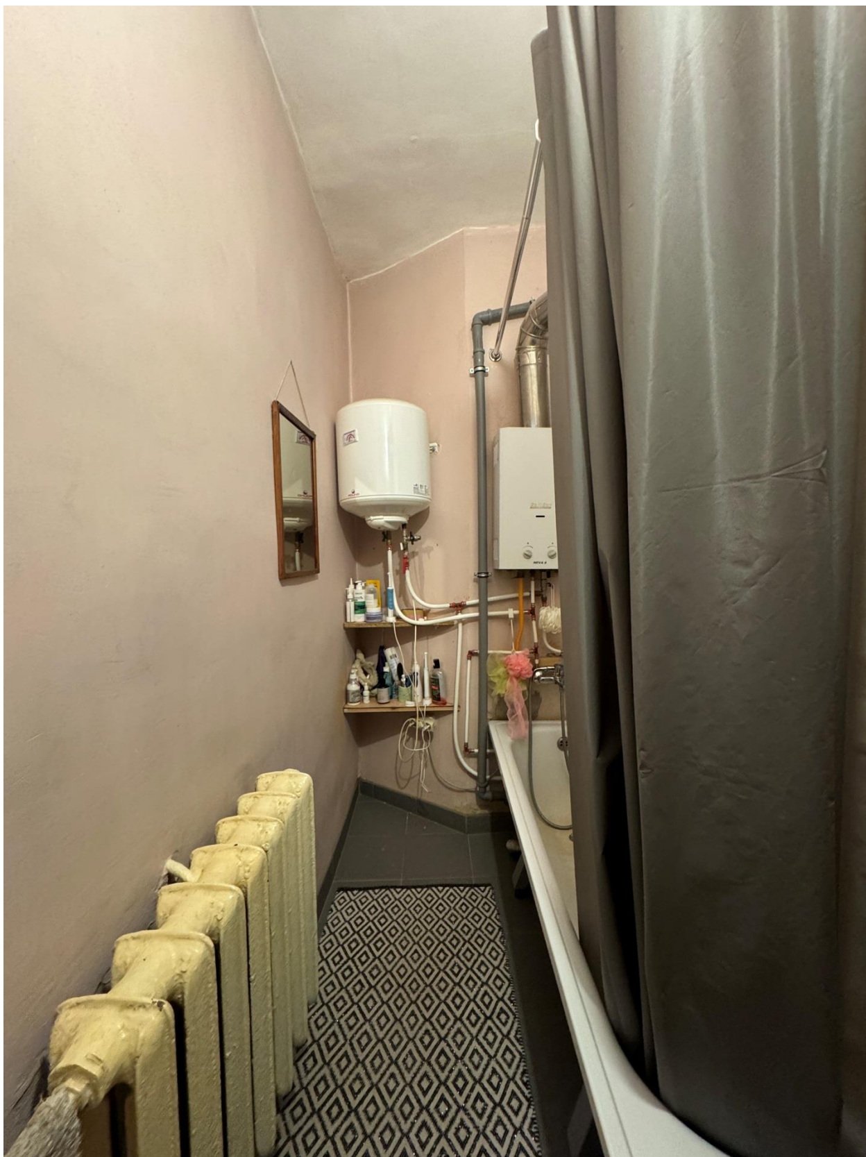
Фото 23. Вид на помещение квартиры № 32 объекта культурного наследия.
