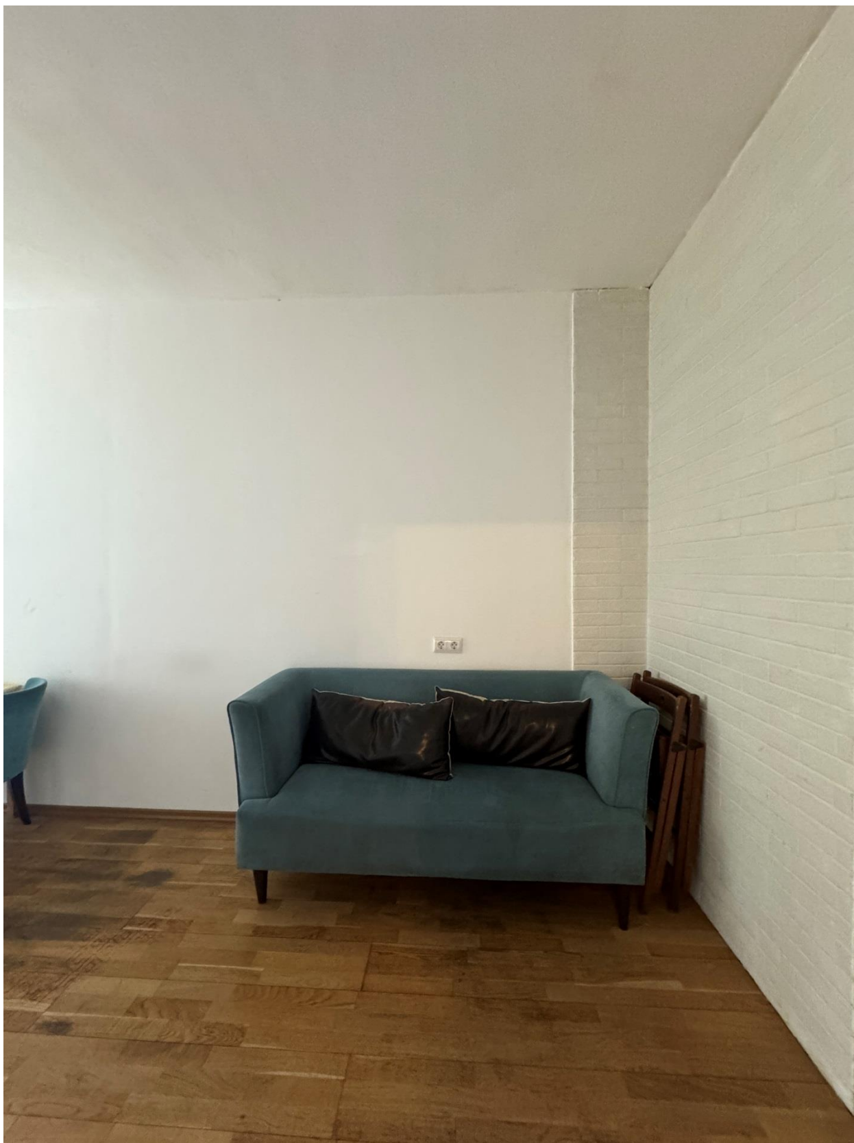
Фото 52. Вид на помещение квартиры № 32 объекта культурного наследия.
