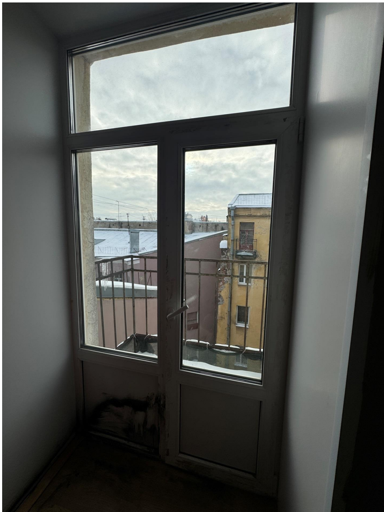
Фото 44. Вид на балконное дверное заполнение квартиры № 32 объекта культурного наследия.
