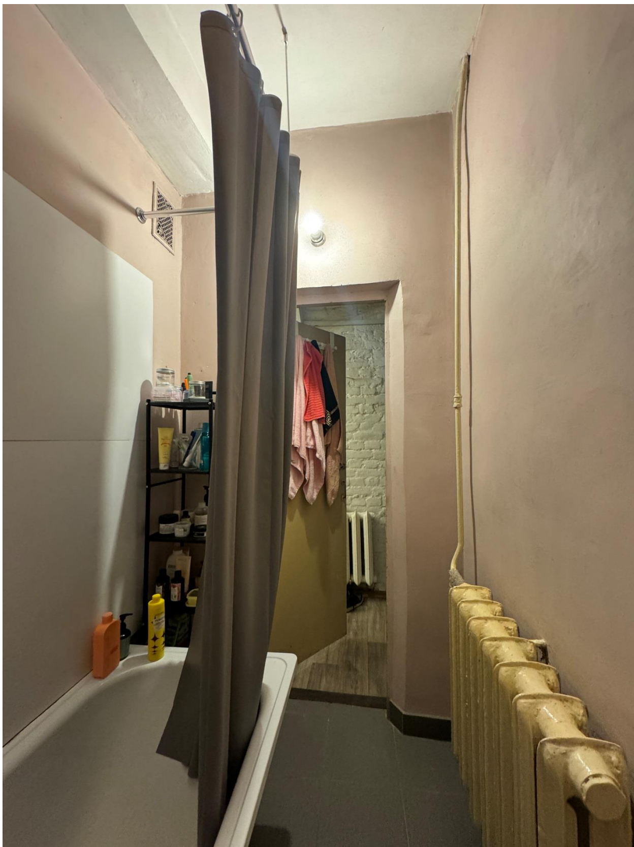
Фото 24. Вид на помещение квартиры № 32 объекта культурного наследия.
