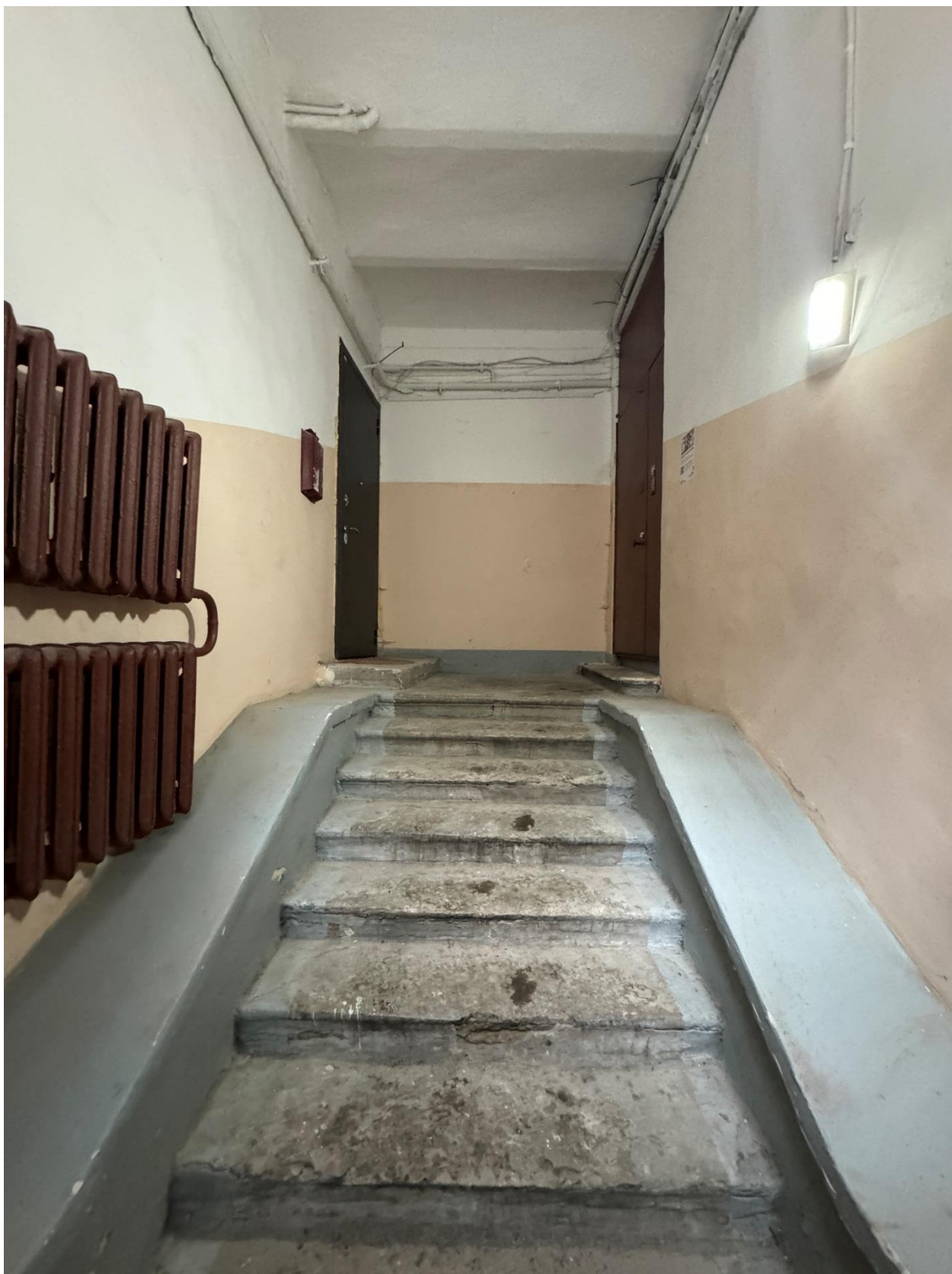
Фото 14. Вид на интерьер вестибюля, ведущего к квартире № 32, объекта культурного наследия.
