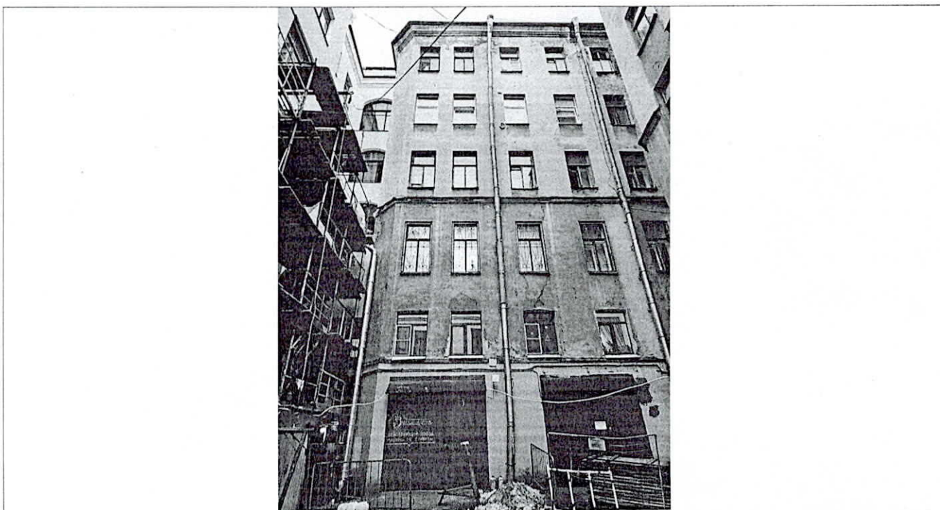
4. Дворовой фасад (в процессе производства работ по ремонту и реставрации фасадов)
