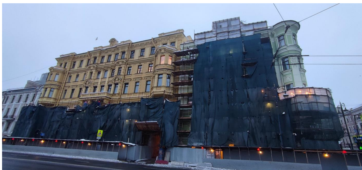
Фото 2. Лицевой фасад здания объекта культурного наследия со стороны ул. Потемкинская. Дата фотофиксации -11.01.2025 г.
