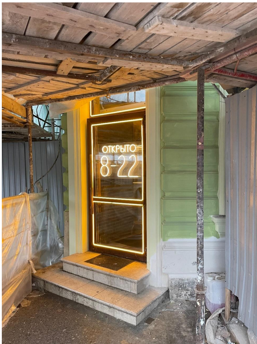
Фото 3. Вход в помещение 1-Н с угла здания. Дата фотофиксации - 11.01.2025 г.
