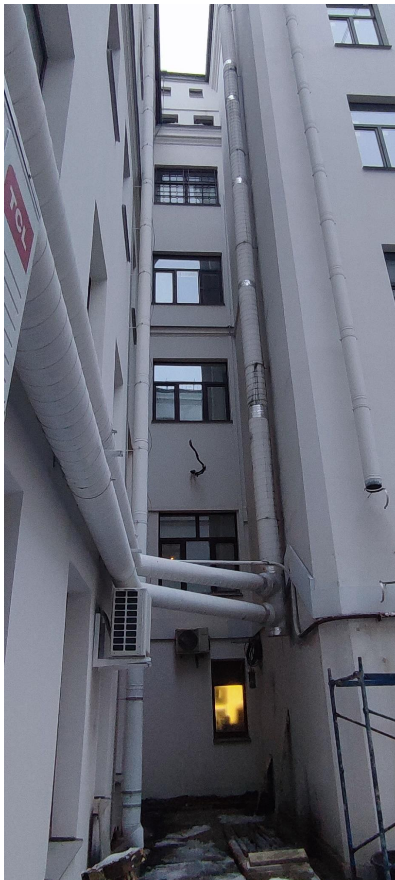
Фото 5. Часть дворового фасада. Участок проектирования. Дата фотофиксации - 11.01.2025 г.
