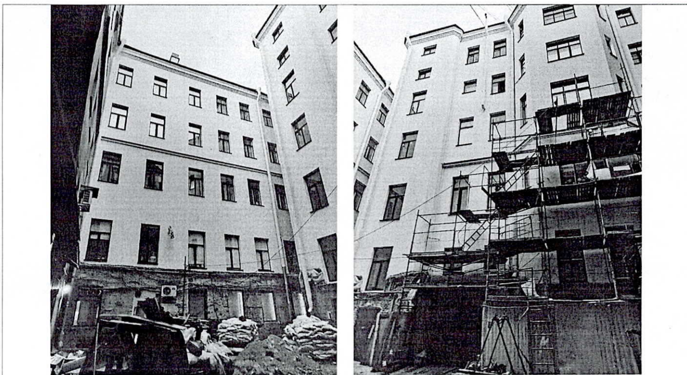
3. Дворовые фасады (в процессе производства работ по ремонту и реставрации фасадов)
