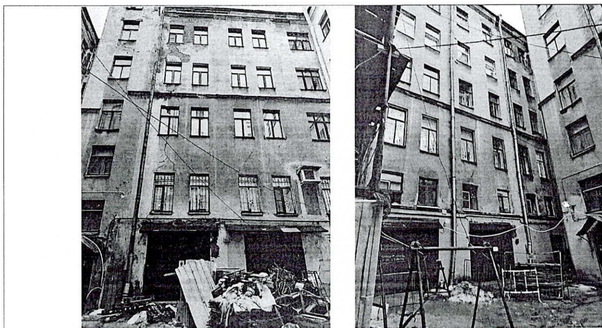
2. Дворовые фасады (в процессе производства работ по ремонту и реставрации фасадов)
