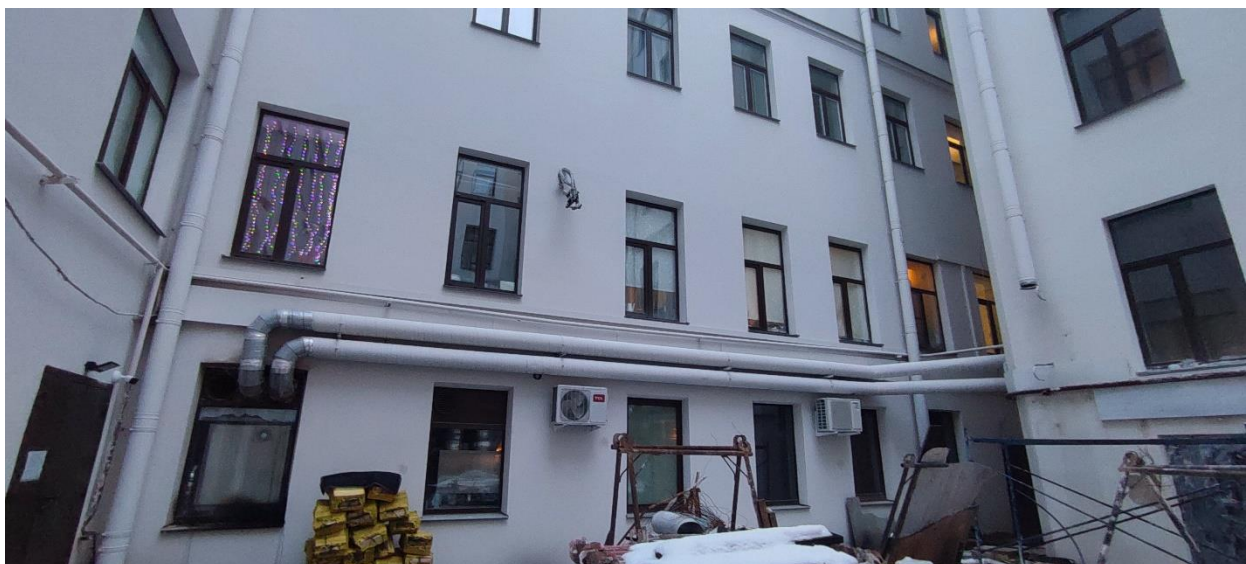
Фото 6. Часть дворового фасада. Общий вид. Дата фотофиксации -11.01.2025 г.
