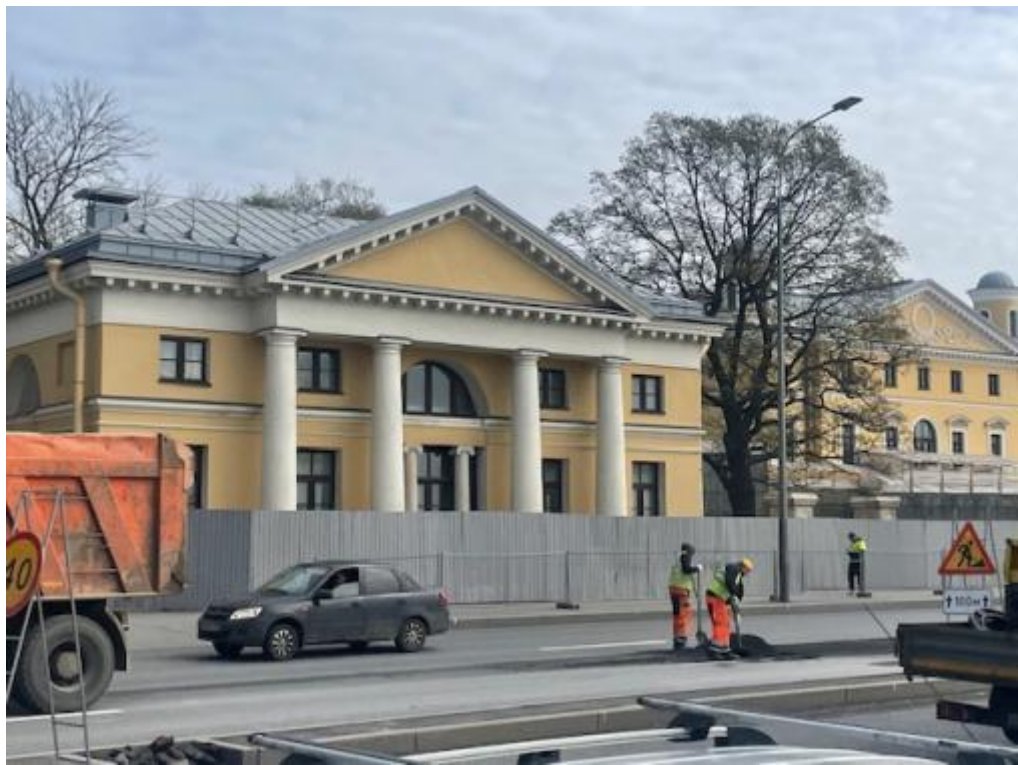
2. Вид на северо-восток от Свердловской набережной. 30.03.2024 г.
