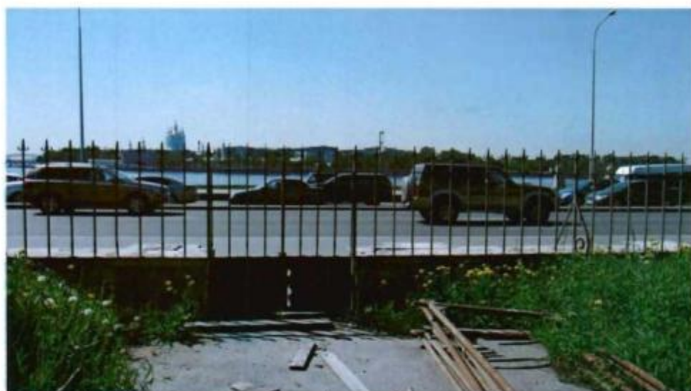
4. Фрагмент северо-восточного фасада объекта культурного наследия.
