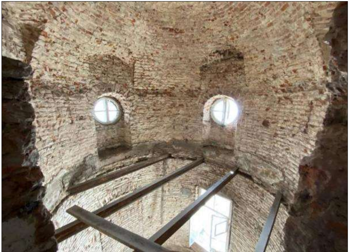
147. Центральный корпус. 3-й этаж. Купольный свод в восточной башне. Окна-люкарны. 30.03.2024 г.
