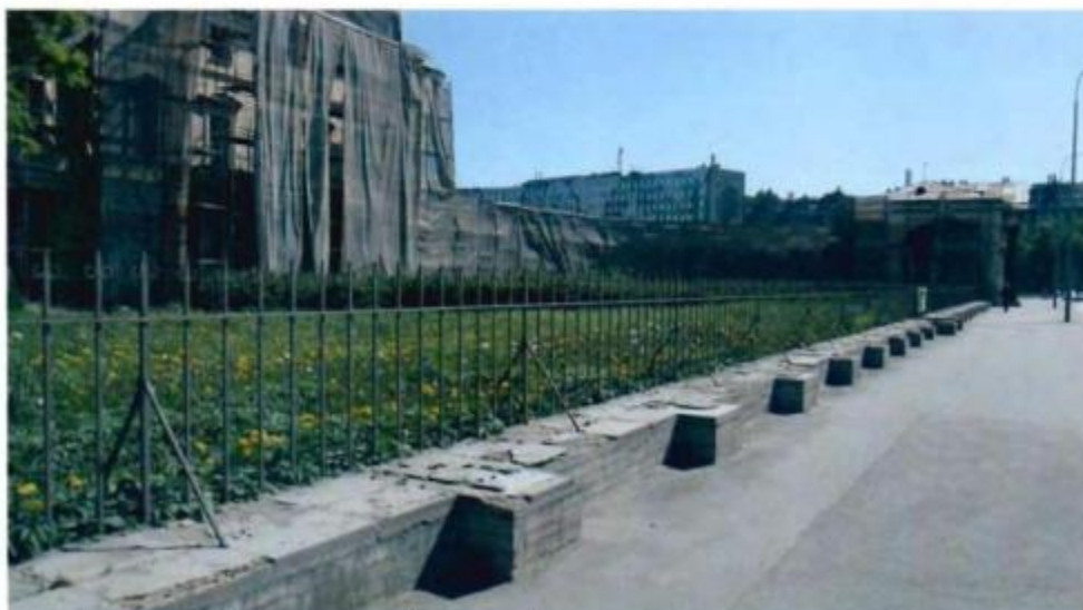
1. Известняковый цоколь объекта культурного наследия.
