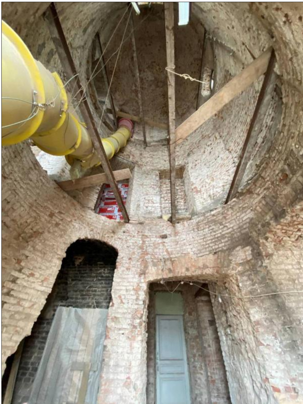
19. Центральный корпус. 1-й этаж. Восточная башня. 30.03.2024 г.
