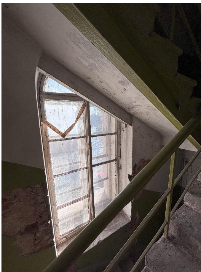
Фото 25. Лестница в юго-восточной части здания
