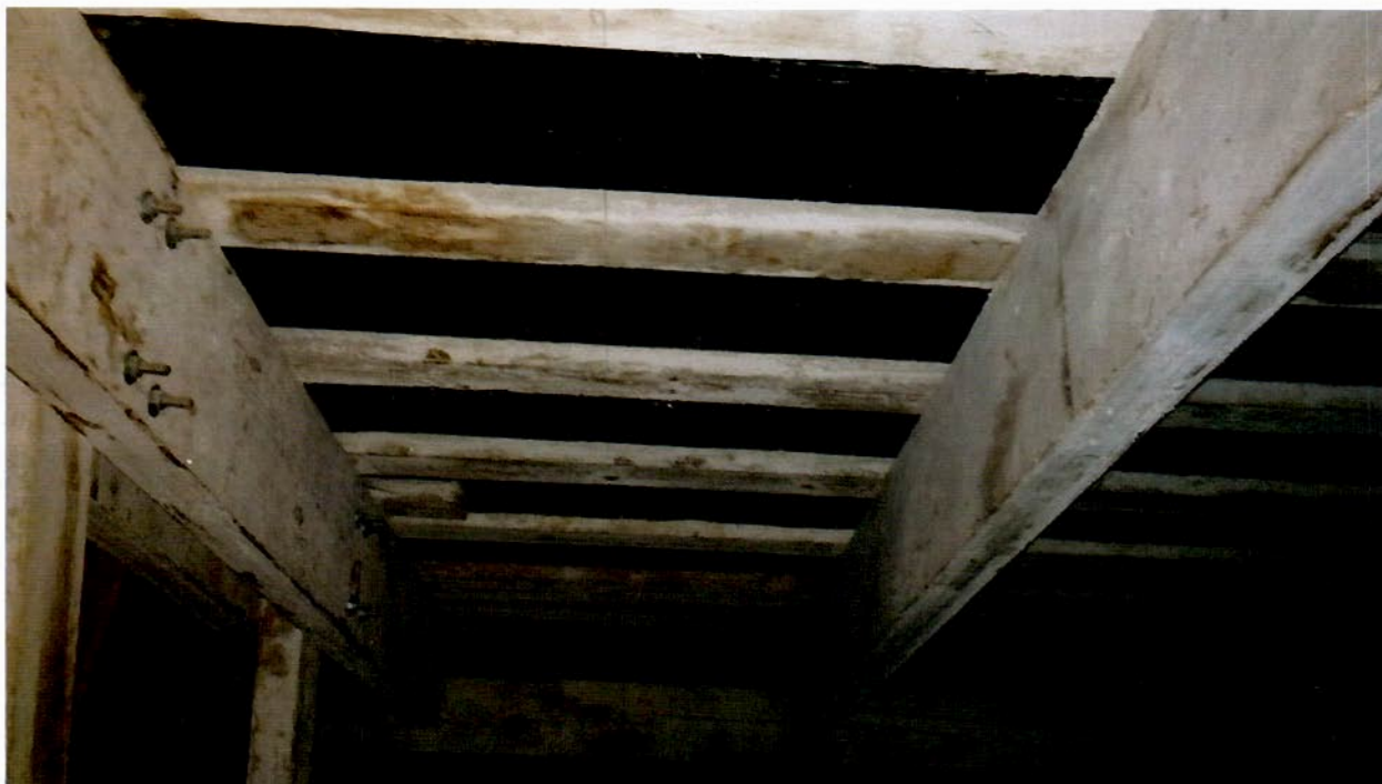
5. Стропильная система.
