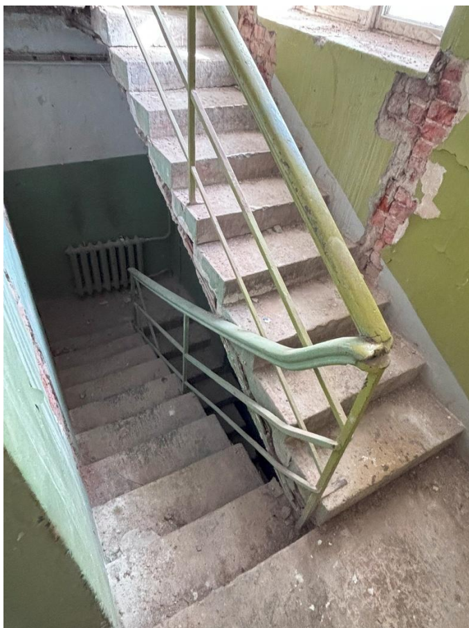
Фото 24. Лестница в юго-восточной части здания.
