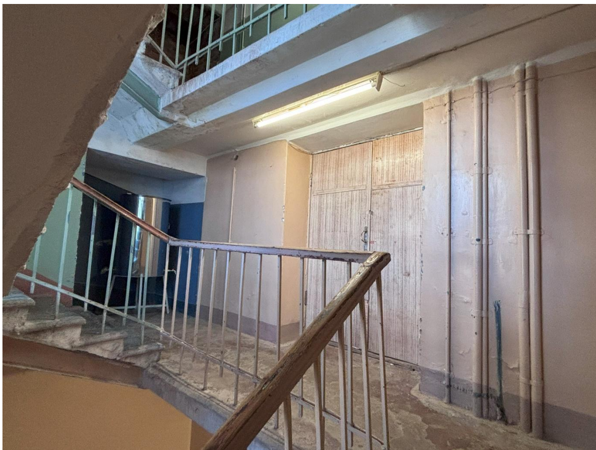
Фото 12. Лестница в северо-западной части здания
