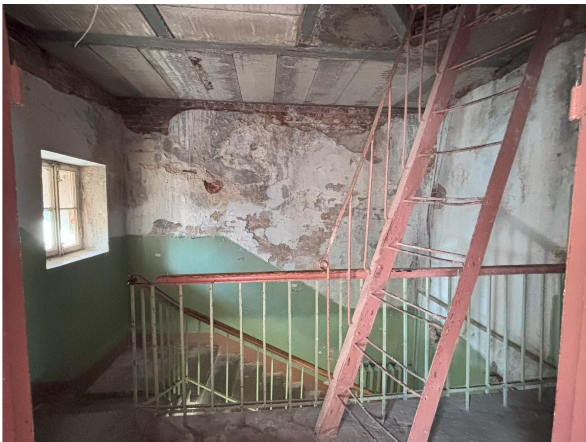
Фото 14. Лестница в северо-западной части здания.
