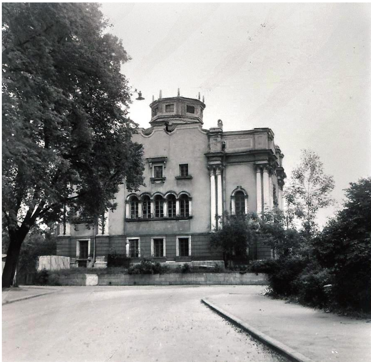
Илл. 23. Вид южного фасада бывшей Спасо-Преображенской церкви Лейб-Гвардии Гренадерского полка со стороны Инструментальной улицы, фото К.В. Овчинникова, июнь 1976 г. //ЦГАКФФД СПб., Фотодокументы, оп. 1БР-57, ед.хр.73661
