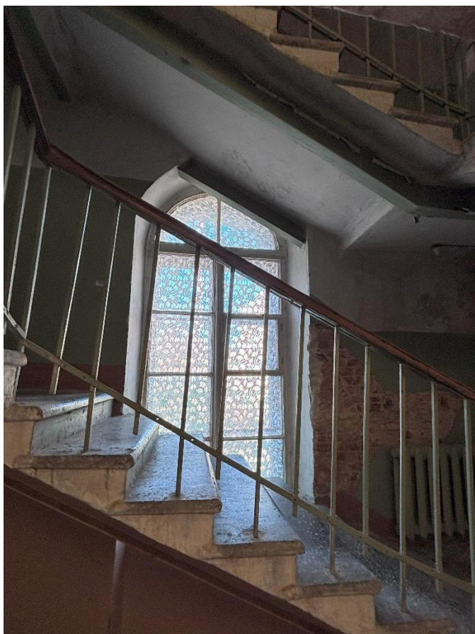
Фото 13. Лестница в северо-западной части здания.
