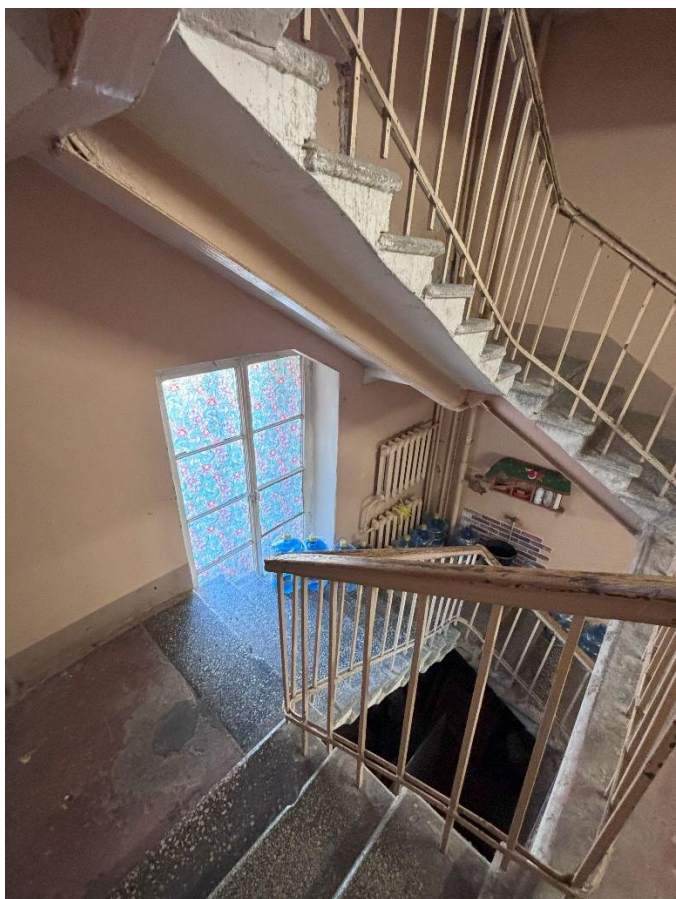
Фото 11. Лестница в северо-западной части здания.
