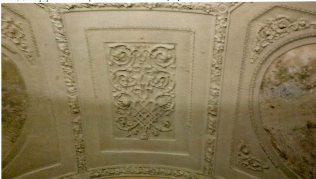
7. Лепное оформление исторического сводчатого перекрытия.
