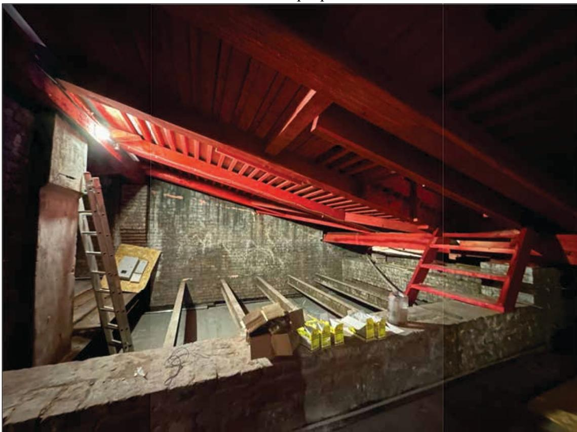
18. Юго-западная часть чердака в осях 3-5/Е-Ж. Металлические балки перекрытия.
