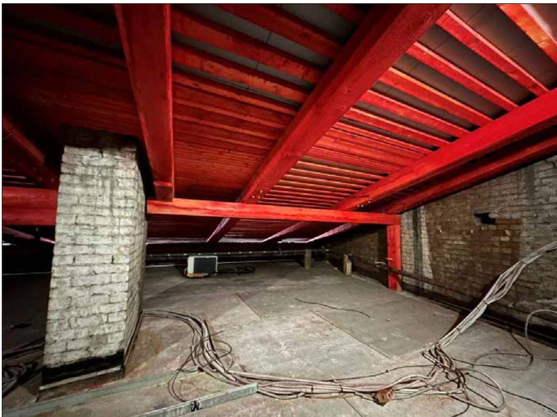
34. Северо-восточная часть чердака в осях 1-2/П-Р. Фрагмент стропильной системы. Балка из бруса. Обрешетка. 28.05.2024 г.
