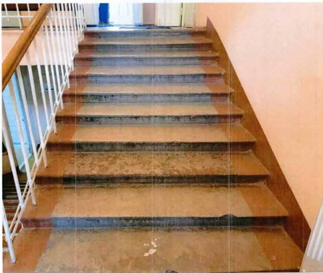
10. Лестница 7ЛК объекта культурного наследия
