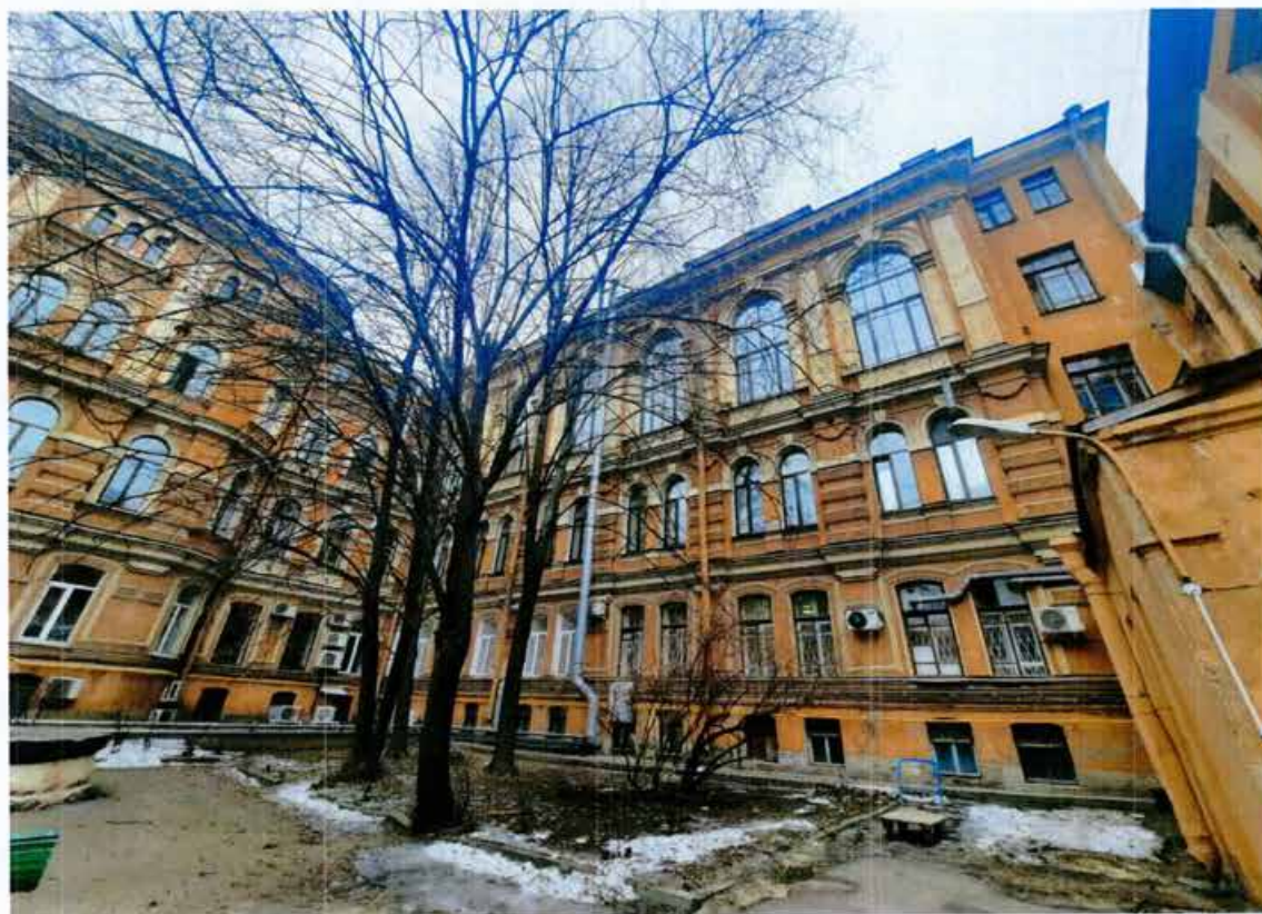
5. Дворовые фасады объекта культурного наследия
