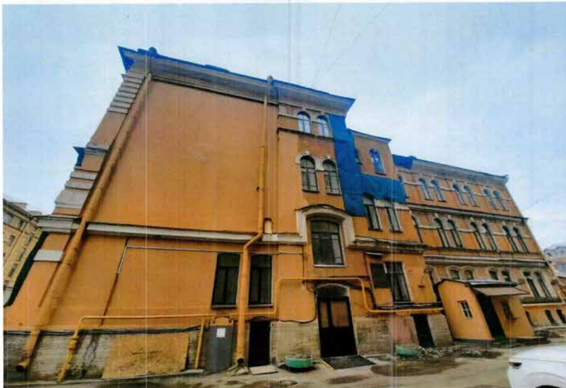
2. Общий вид на юго-восточный фасад объекта культурного наследия
