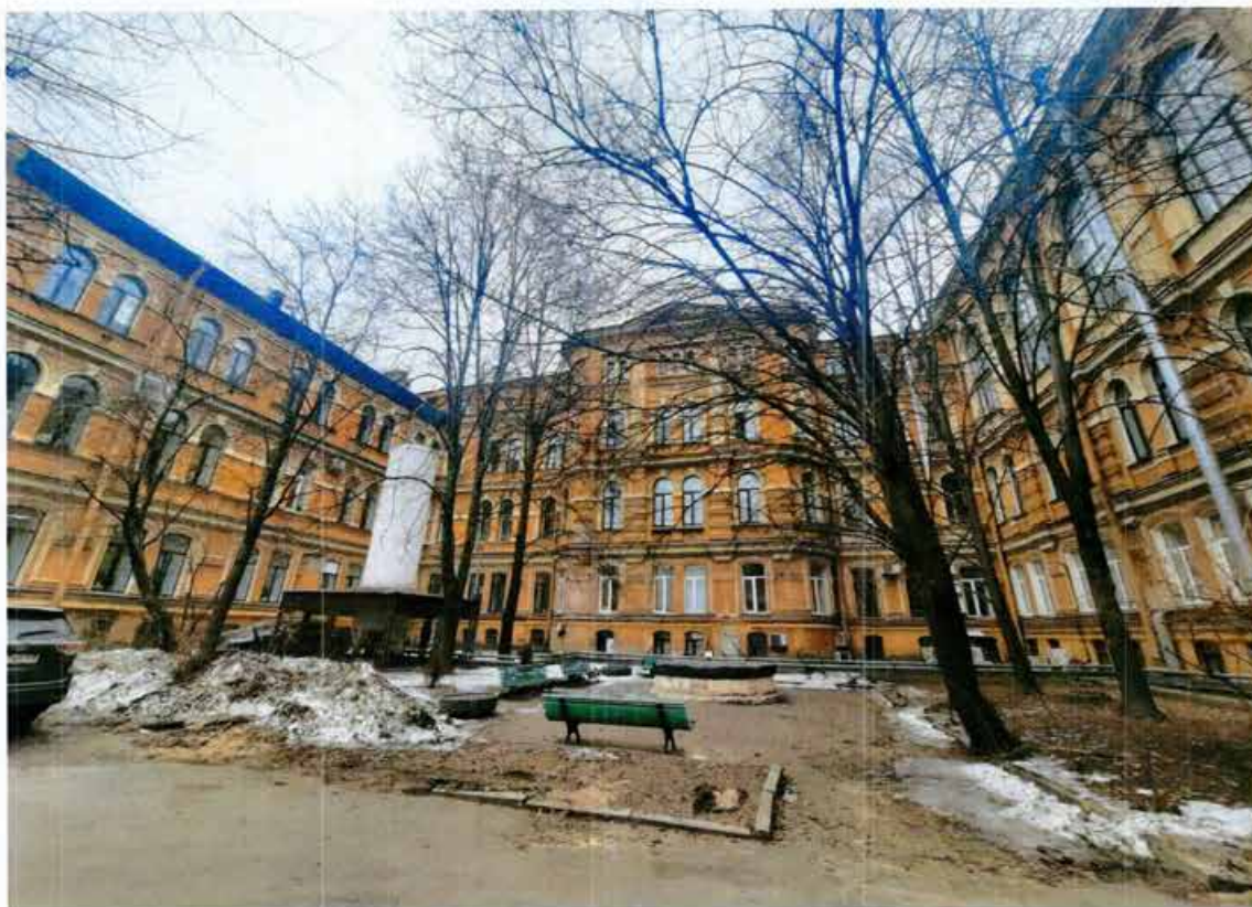
4. Дворовые фасады объекта культурного наследия
