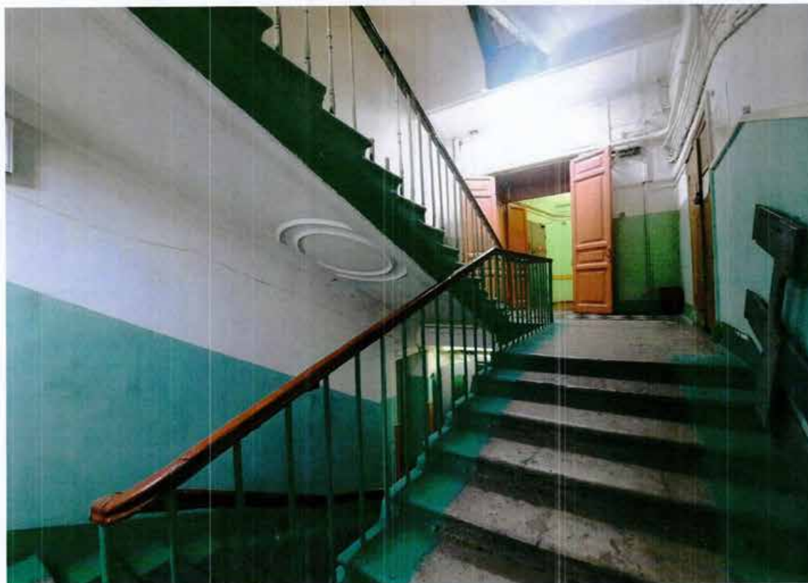
8. Лестница 4ЛК объекта культурного наследия
