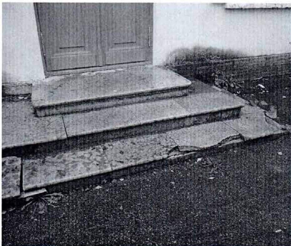
7. Северный фасад, фрагмент. Крыльцо. Повреждение ступеней.
