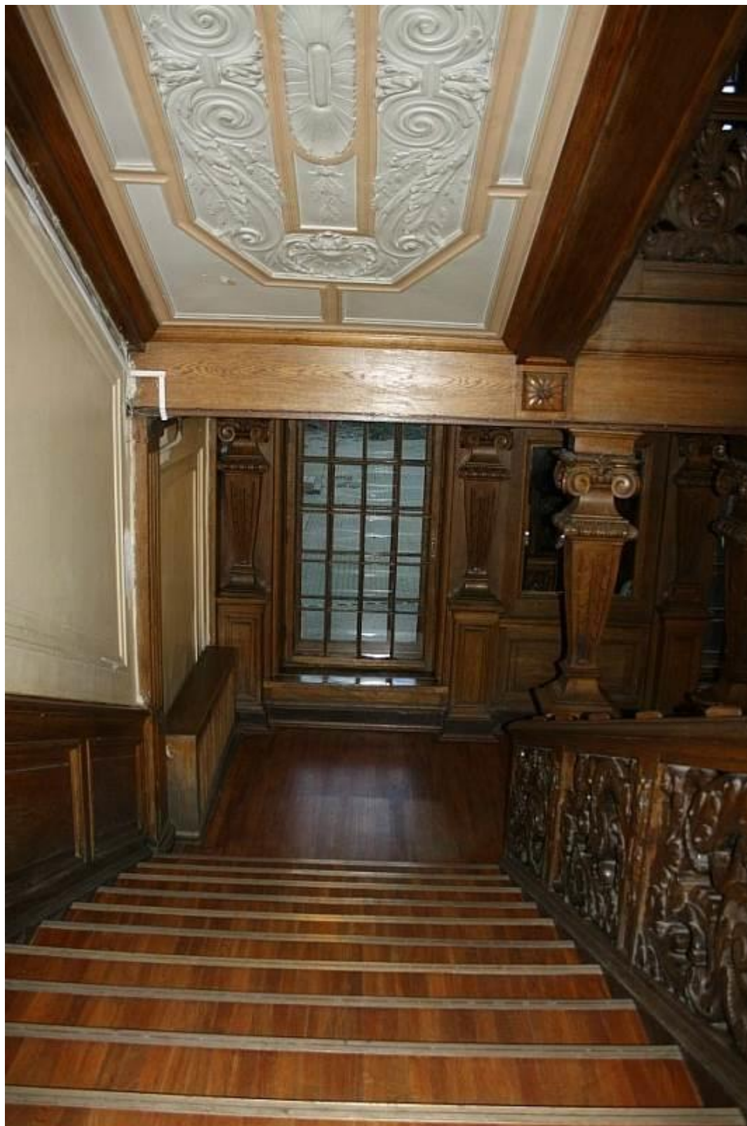
4. Главный дом (в составе «Дом Утеман Ф.Ф.») (наб. Лейтенанта Шмидта, д. 31, лит. А). Парадная лестница. 2022 (27).
