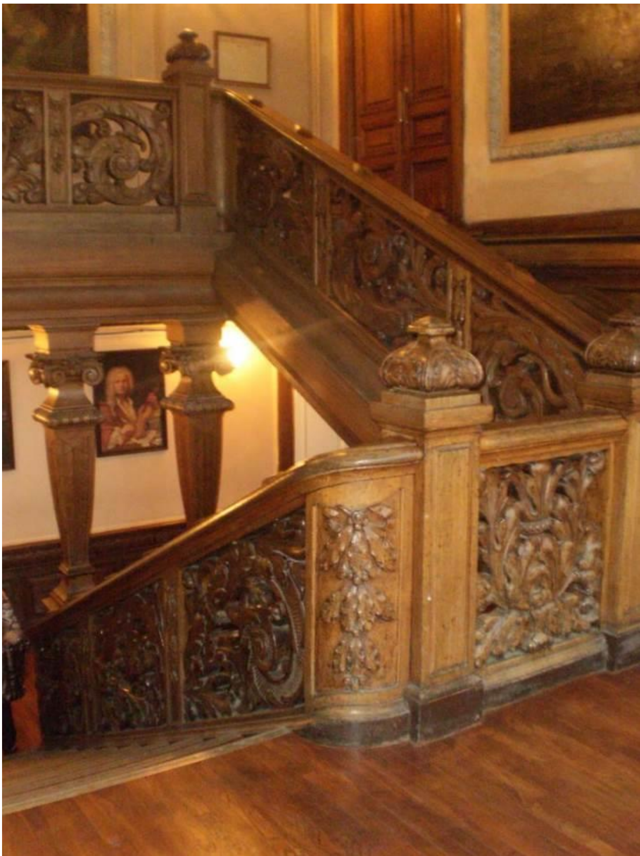
6. Главный дом (в составе «Дом Утеман Ф.Ф.») (наб. Лейтенанта Шмидта, д. 31, лит. А). Парадная лестница. 2022 (27).
