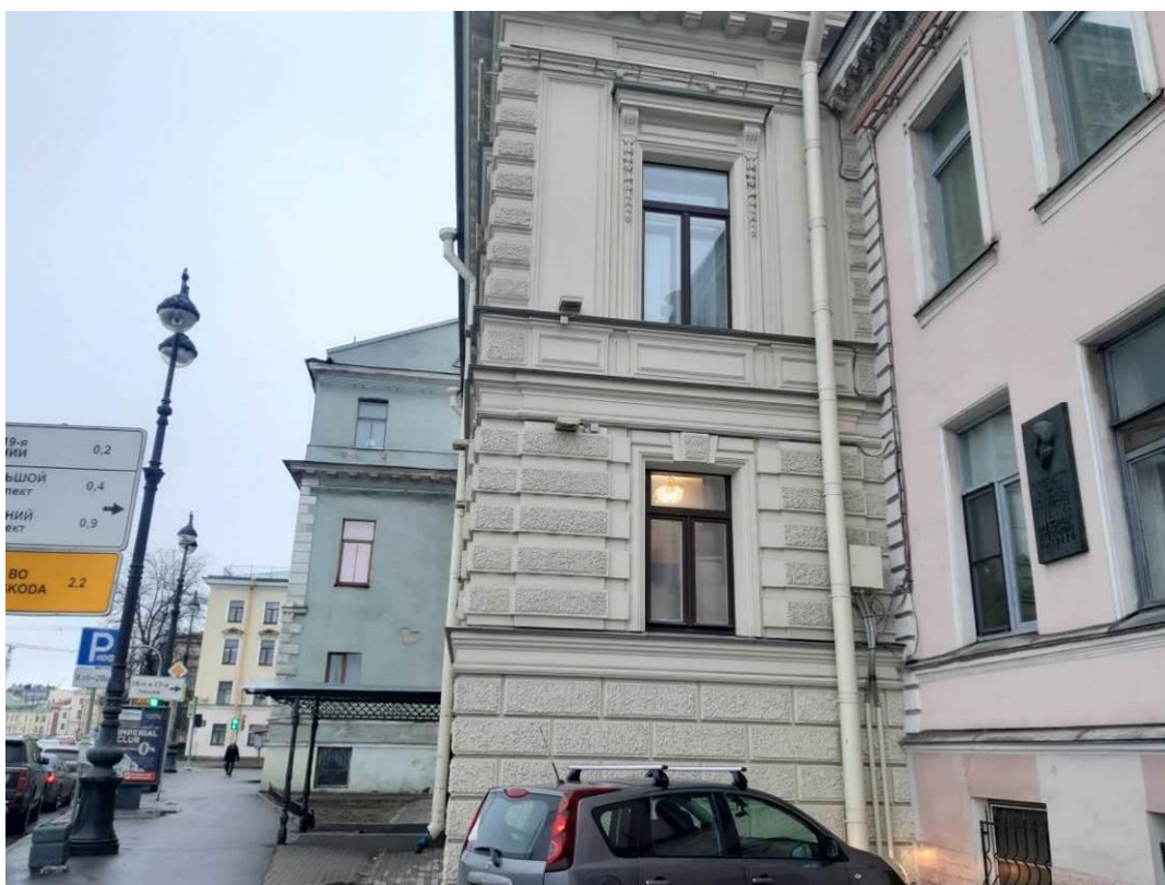
2. Главный дом (в составе «Дом Утеман Ф.Ф.») (наб. Лейтенанта Шмидта, д. 31, лит. А). Лицевой фасад. Фото мест установки оборудования и прокладки кабельных трасс. Штиглиц М.С. 06.03.2025.
