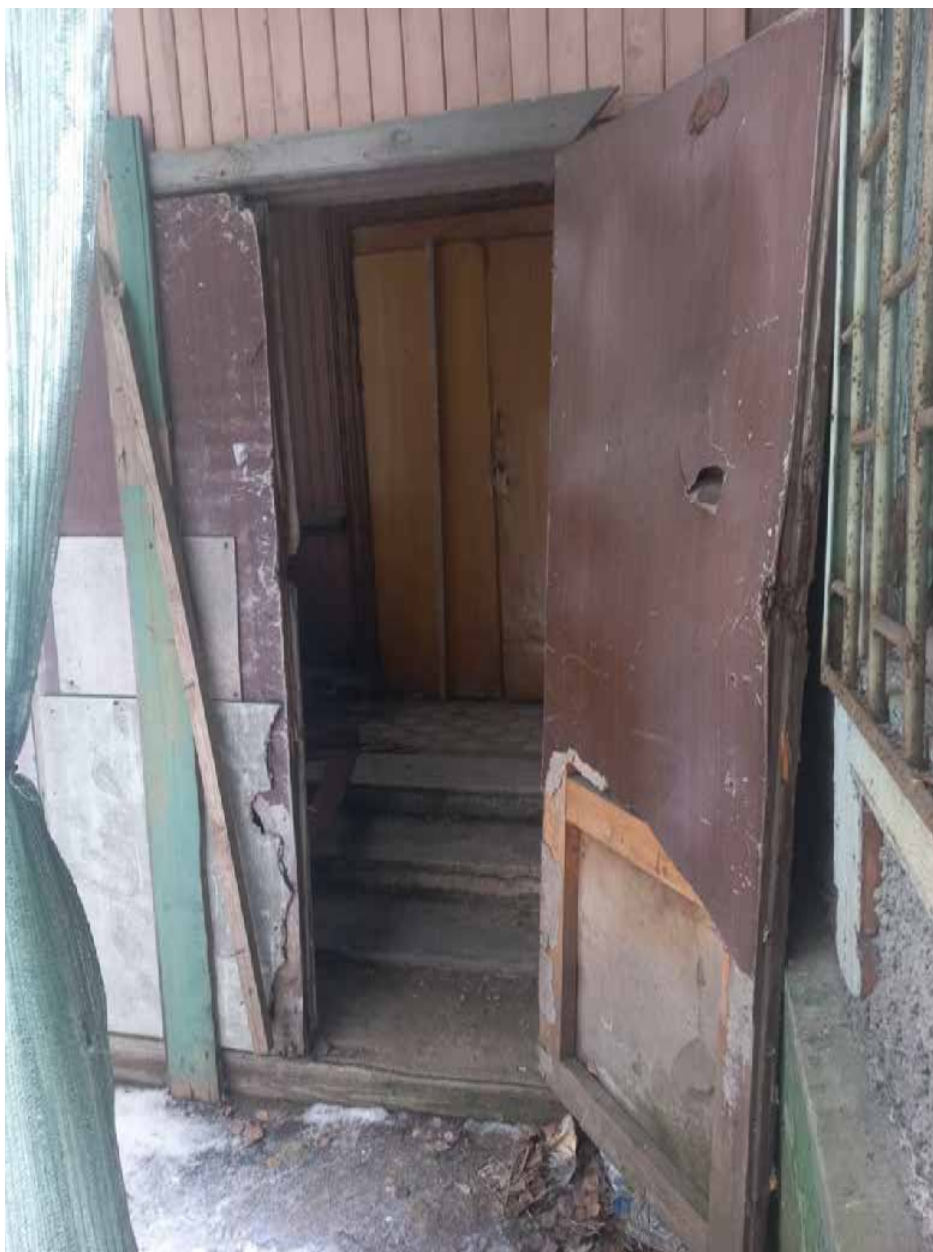
Фото 5. Главный вход в здание.
