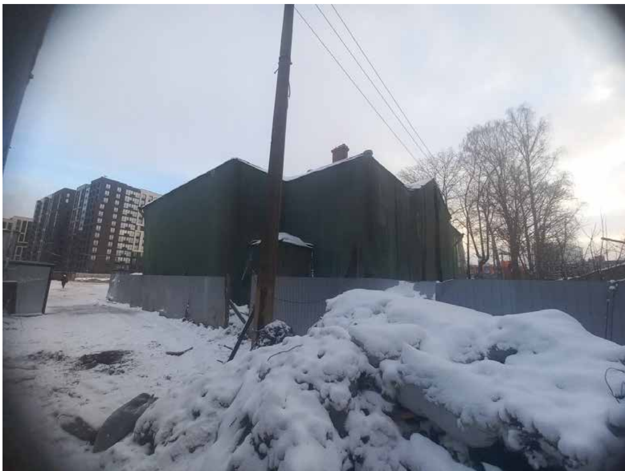
Фото 4. Юго-западный и северо-западный фасады.
