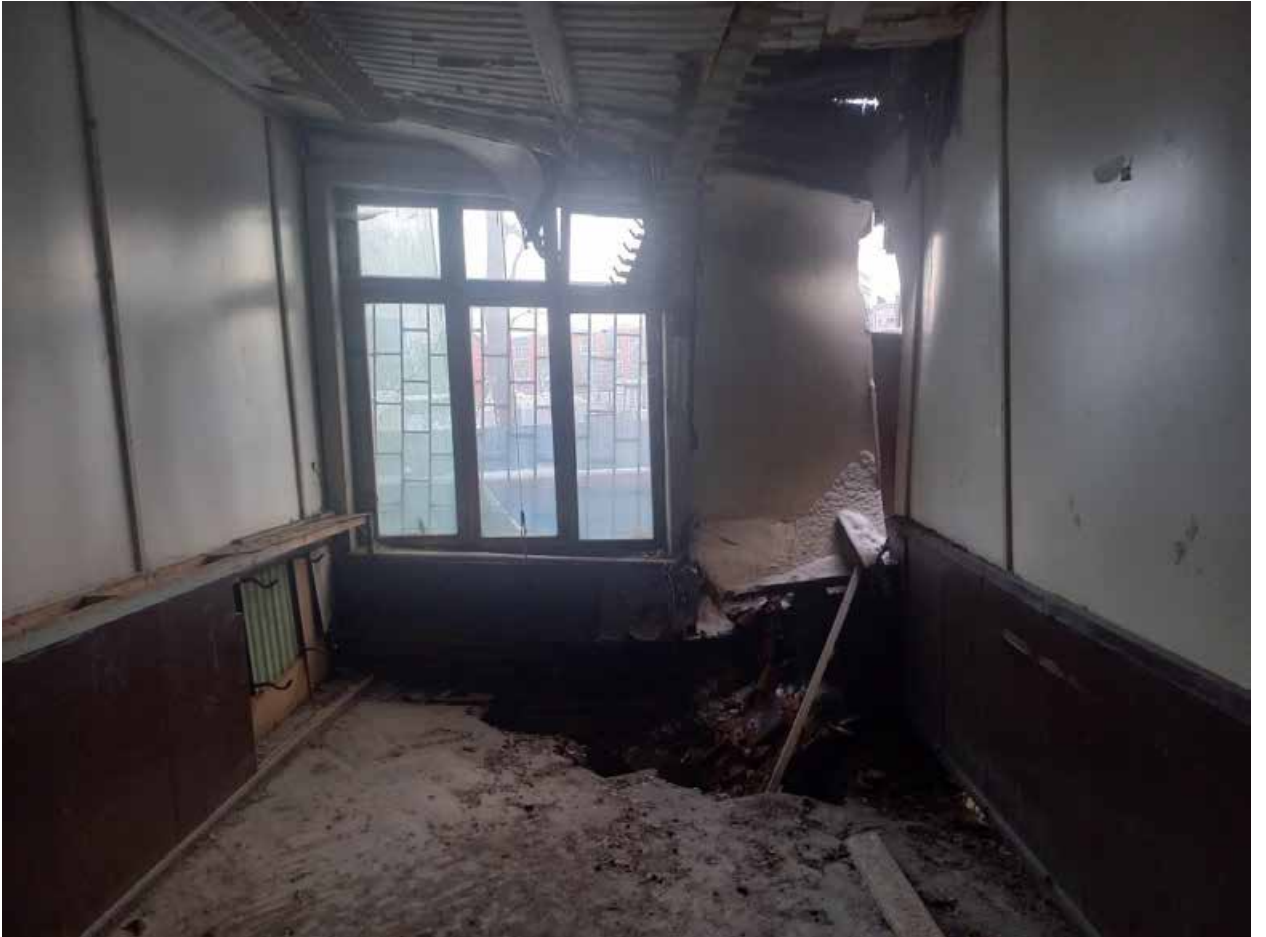
Фото 18. Внутренние помещения. 1 этаж.
