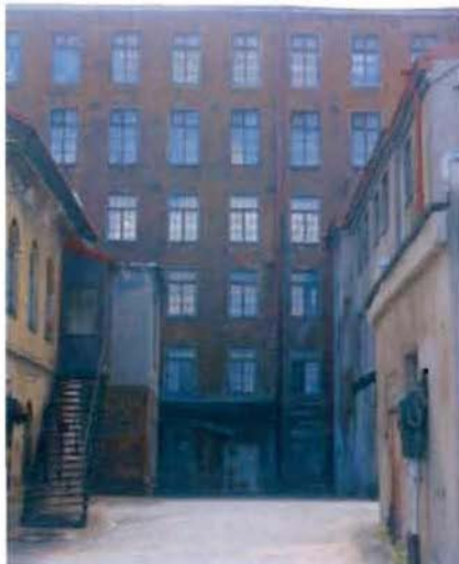
4. Фрагмент северного фасада
