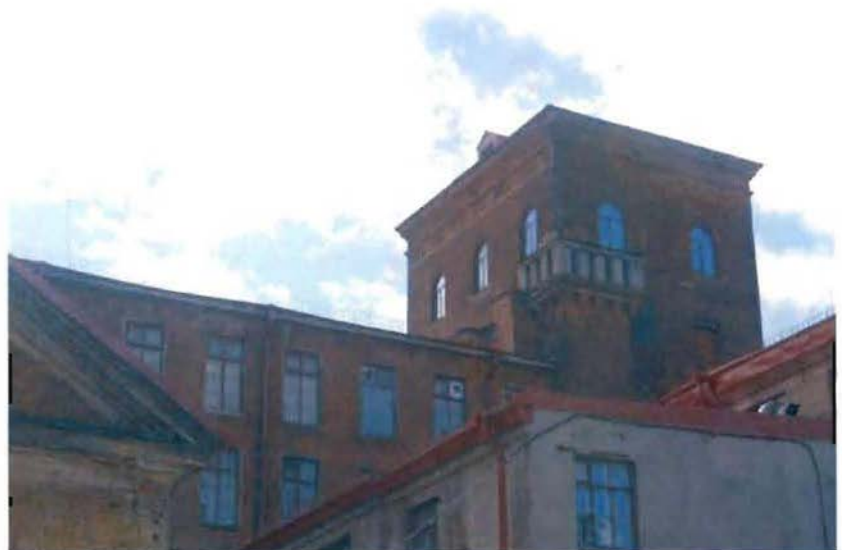
5. Фрагмент северного фасада
