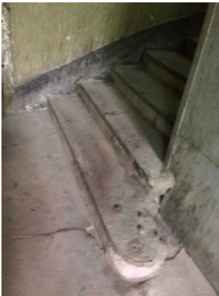
Фото 15. Объект культурного наследия регионального значения "Главное производственное здание Российской бумагопрядильной мануфактуры", расположенное по адресу: Обводного канала набережная д. 223-225, лит. С. Лестница 2
