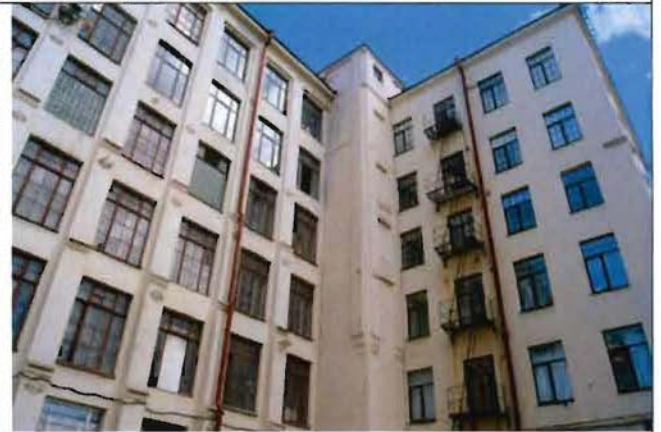
3. Фрагмент южного фасада
