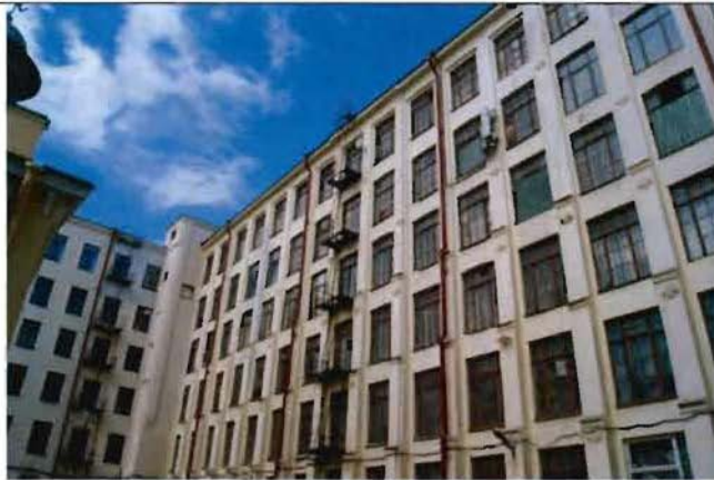
2. Фрагмент южного фасада
