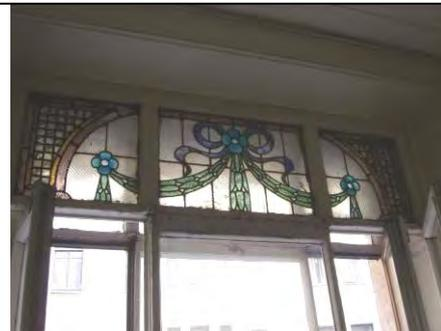
два витражных заполнения центральной части фрамуг оконных проемов межэтажных лестничных площадок – местоположение (между 2-м и 3-м, 3-м и 4-м этажами), габариты, материал (полихромное и матовое стекло, паечный металлический переплет), рисунок;
