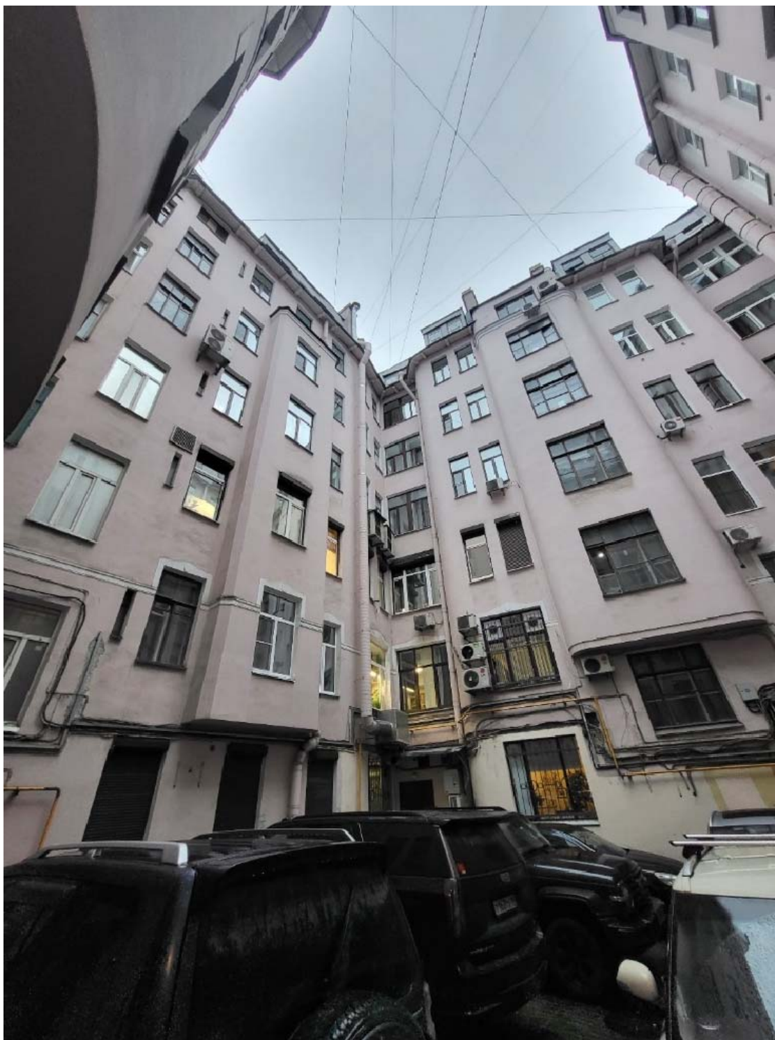
Фото №4. Юго-западный и юго-восточный дворовые фасады.
