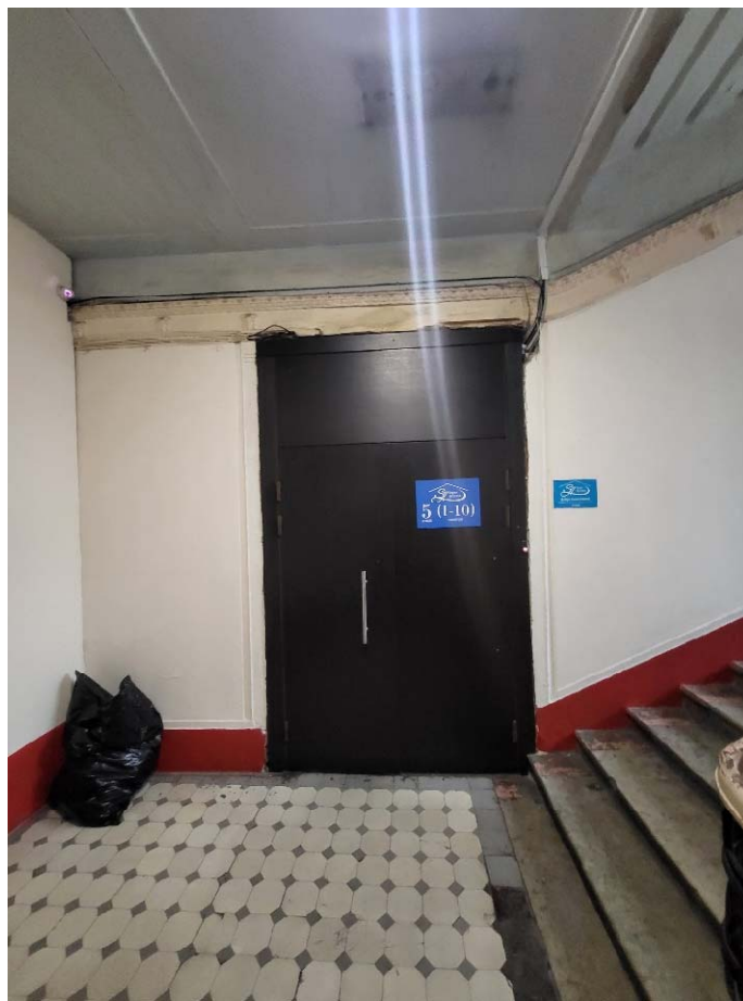
Фото №1. Вход в квартиру №8 с ЛК.
