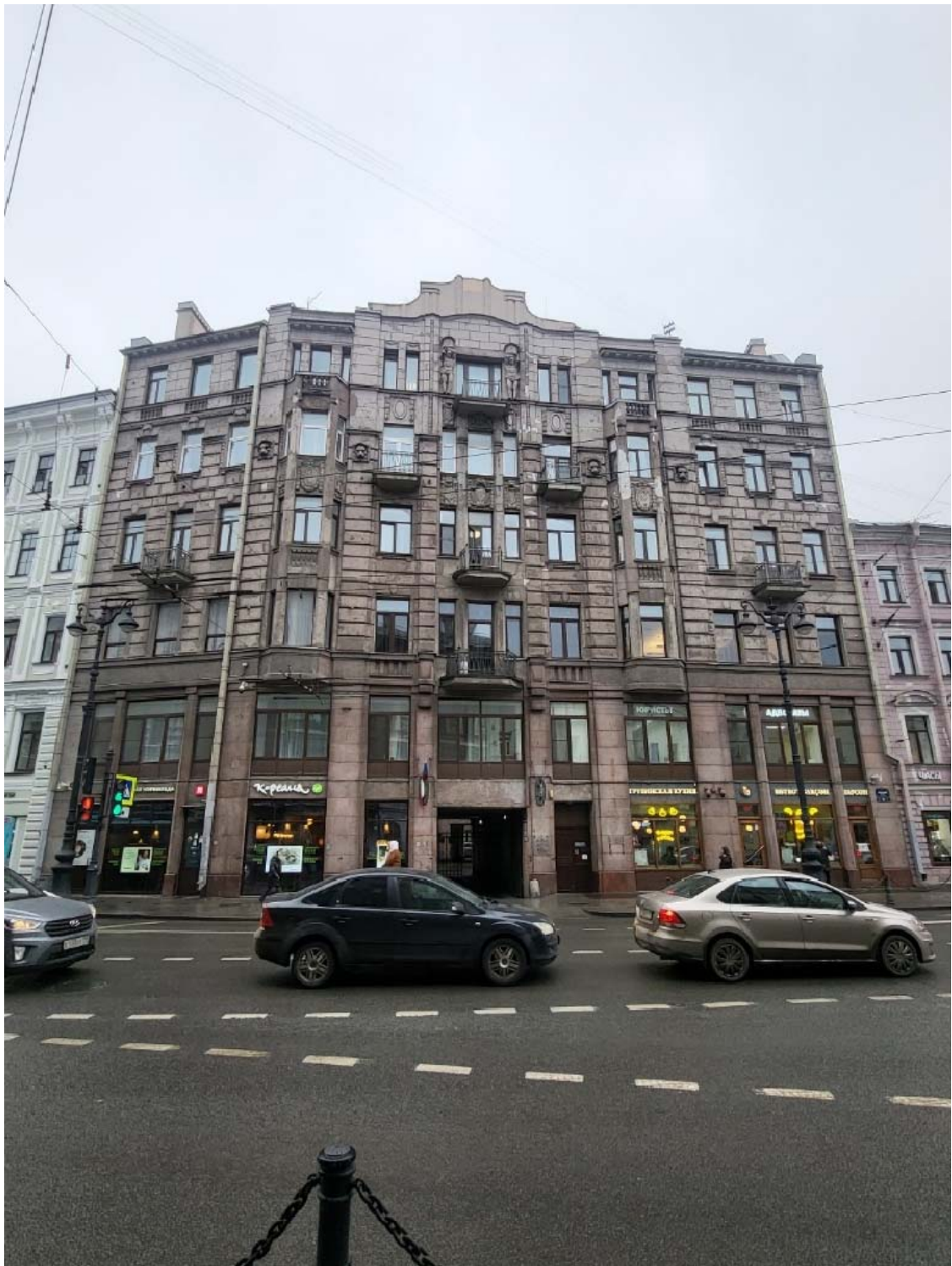
Фото №1. Северо-восточный лицевой фасад.
