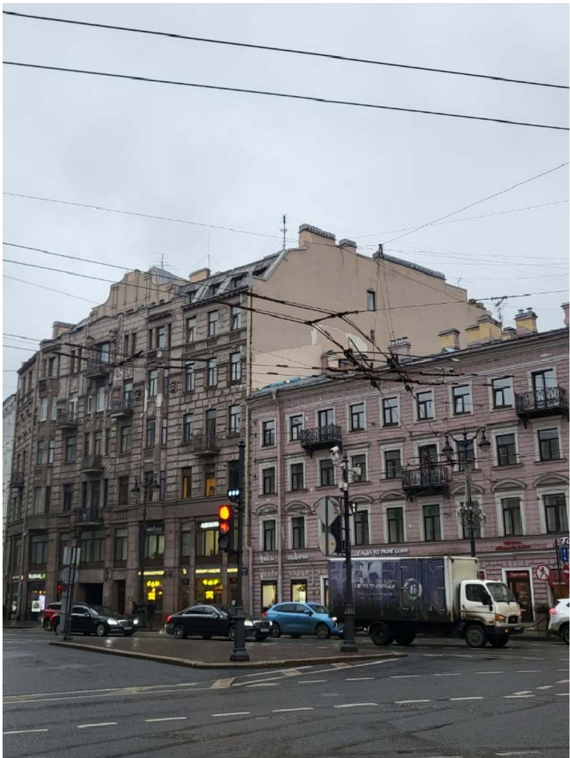
Фото №2. Северо-восточный лицевой фасад часть западной брандмауэрной стены.
