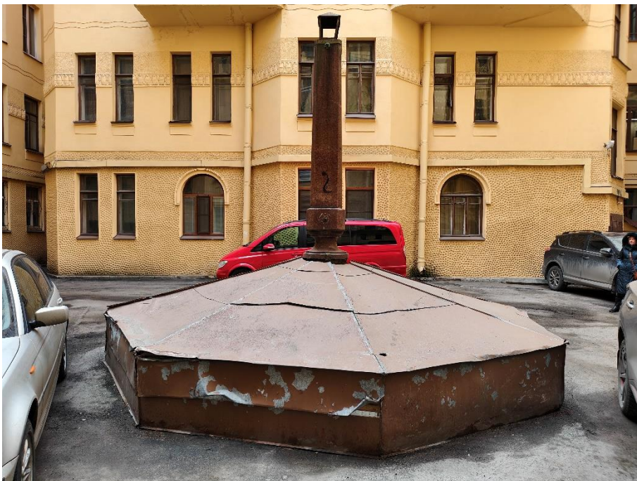
7. «Фонтан» (в составе «Дом Ф.И. Танского (с фонтаном)»), г. Санкт-Петербург, ул. Куйбышева, д. 21, лит. А. Общий вид. Фото 10.03.2025г.
