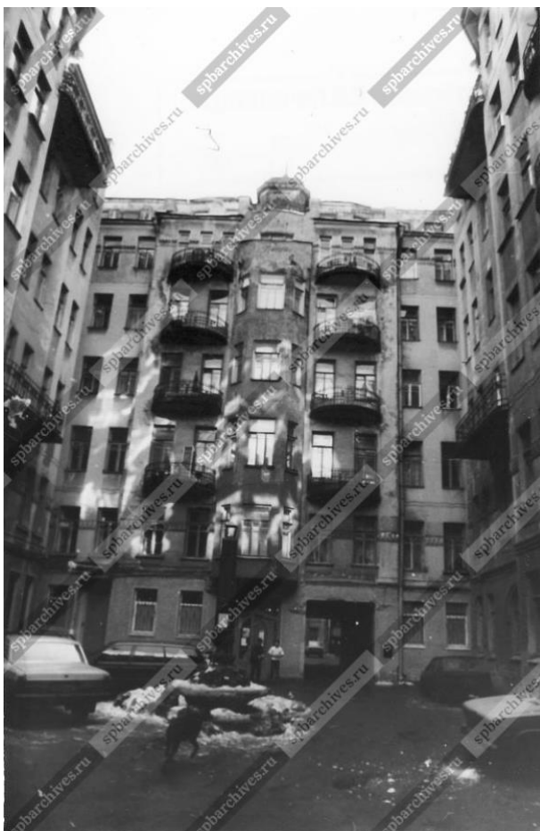
75. Вид двора - колодца жилого дома № 21 по улице Куйбышева. 2004 г. (источник: ЦГАКФД СПб. Фотодокументы. Опись 1АР-152. Ед.хр.211697).
