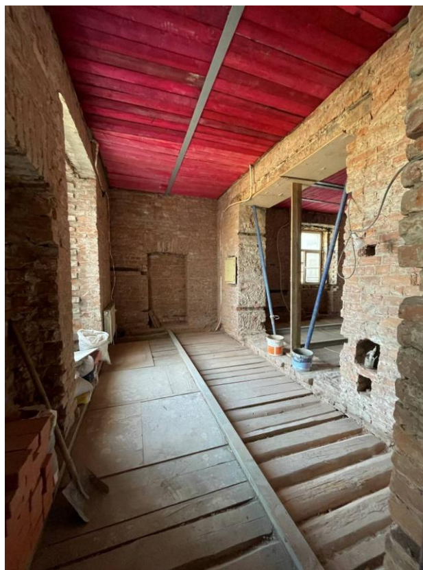
Фото 10. Интерьер квартиры № 13 объекта культурного наследия регионального значения объекта культурного наследия регионального значения «Доходный дом Р.Г. Веге»
