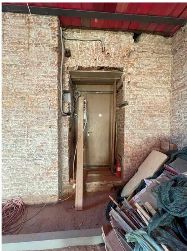
Фото 7. Интерьер квартиры № 42 объекта культурного наследия регионального значения объекта культурного наследия регионального значения «Доходный дом Р.Г. Веге»
