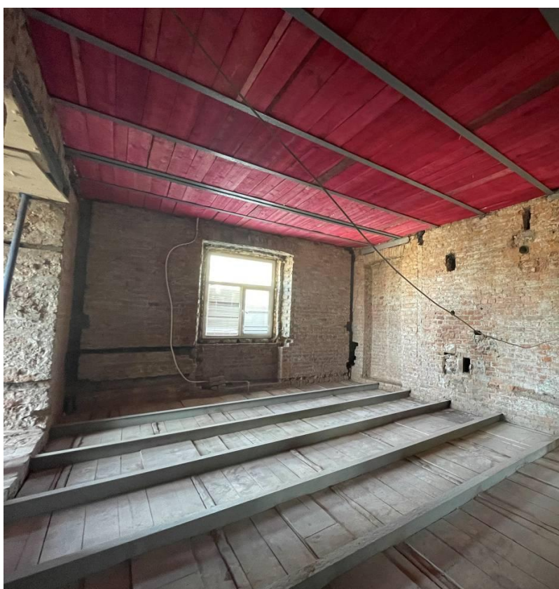
Фото 12. Интерьер квартиры № 13 объекта культурного наследия регионального значения объекта культурного наследия регионального значения «Доходный дом Р.Г. Веге»
