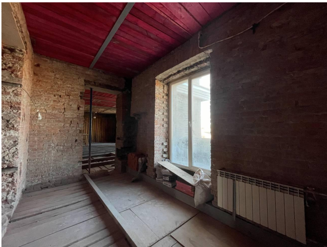
Фото 11. Интерьер квартиры № 13 объекта культурного наследия регионального значения объекта культурного наследия регионального значения «Доходный дом Р.Г. Веге»
