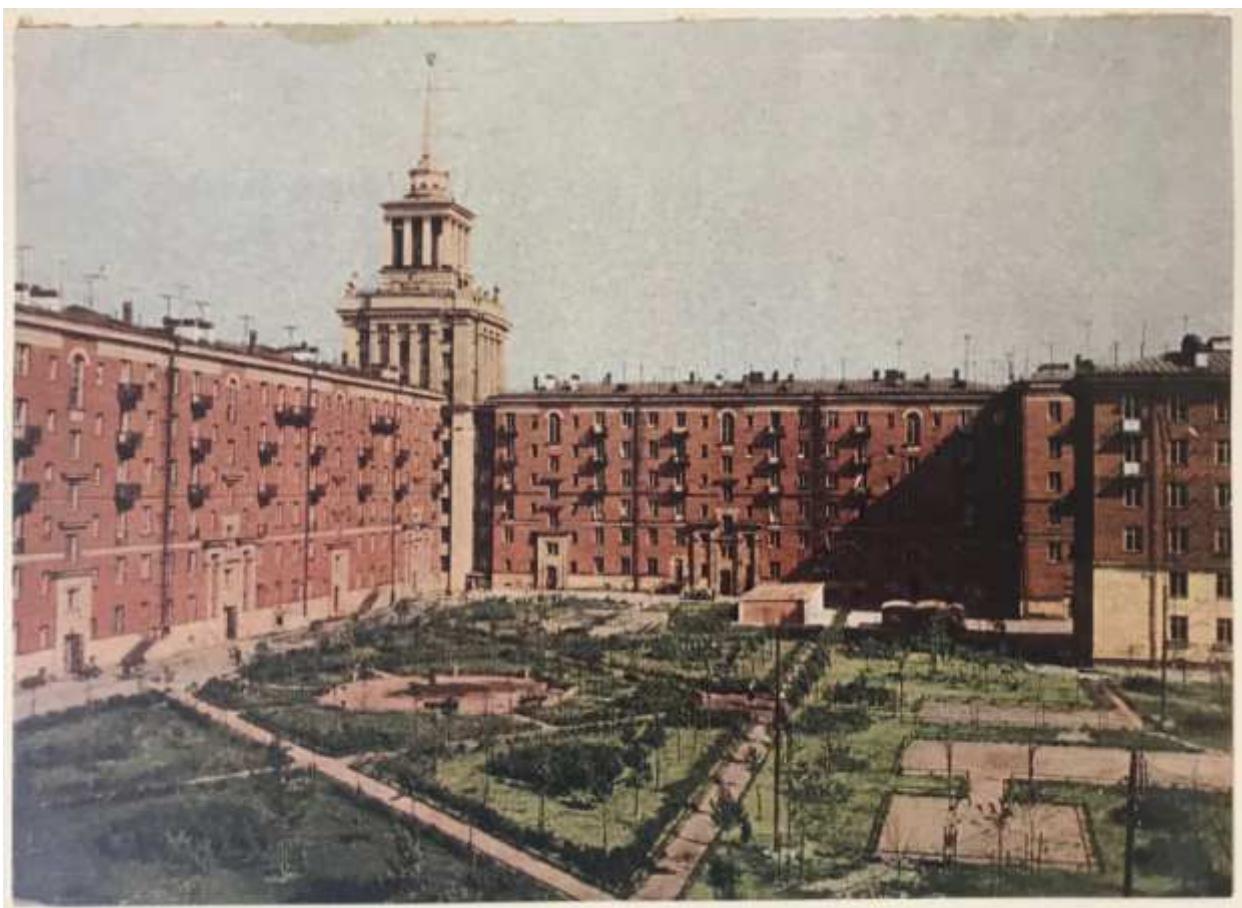
38. Вид дома со стороны двора. (Архитектура и строительство Ленинграда. 1955. №3)
