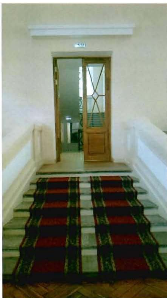
9. Дверной проем декорированный линейным сандриком в актовом зале.
