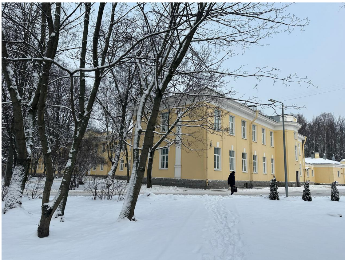
Фото 13. Вид на ОКН «Главный корпус с цандеровским флигелем, конференц-залом и кухонным флигелем». Февраль 2024г.
