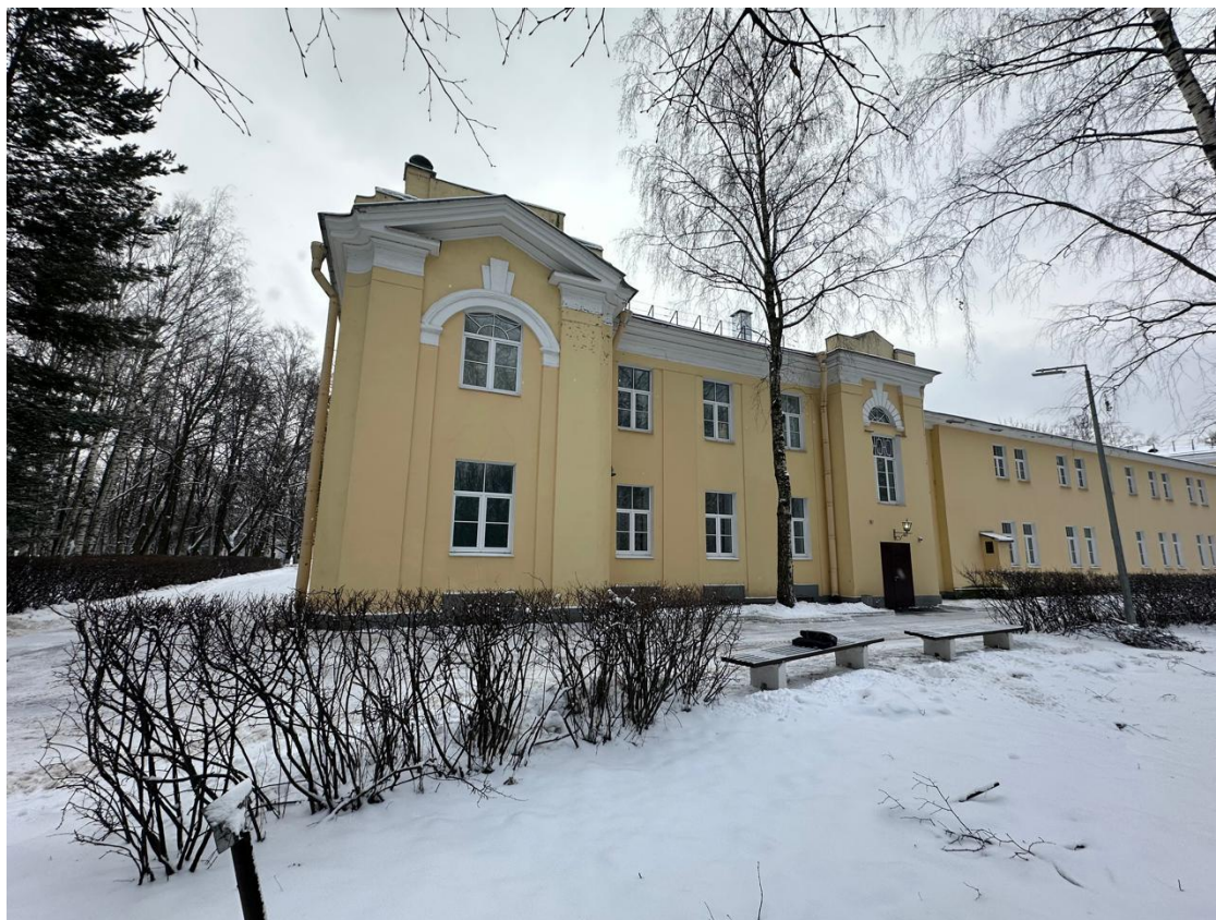
Фото 14. Вид на ОКН «Главный корпус с цандеровским флигелем, конференц-залом и кухонным флигелем». Февраль 2024г.
