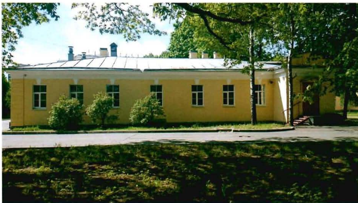
6. Северный лицевой фасад восточного флигеля.
