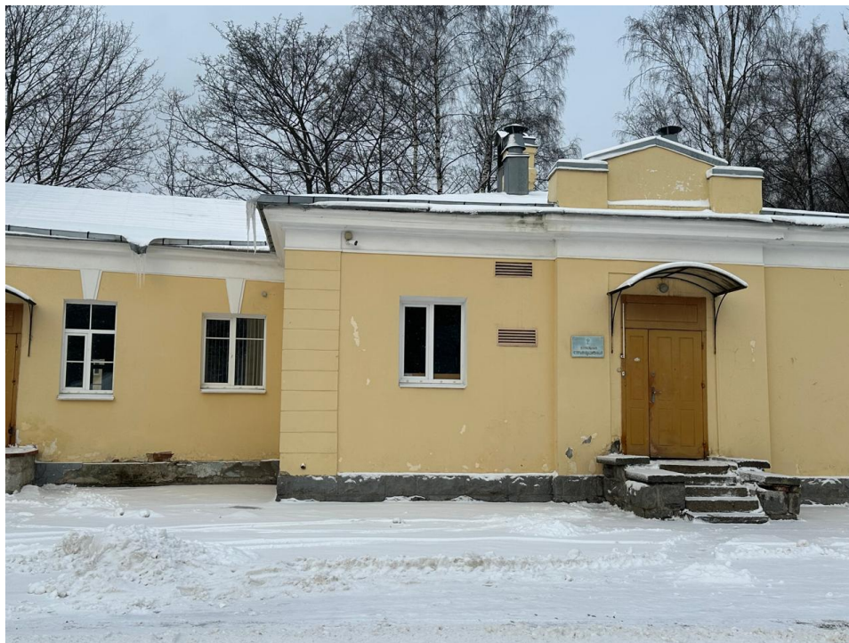
Фото 7. Вид на ОКН «Главный корпус с цандеровским флигелем, конференц-залом и кухонным флигелем». Февраль 2024г.
