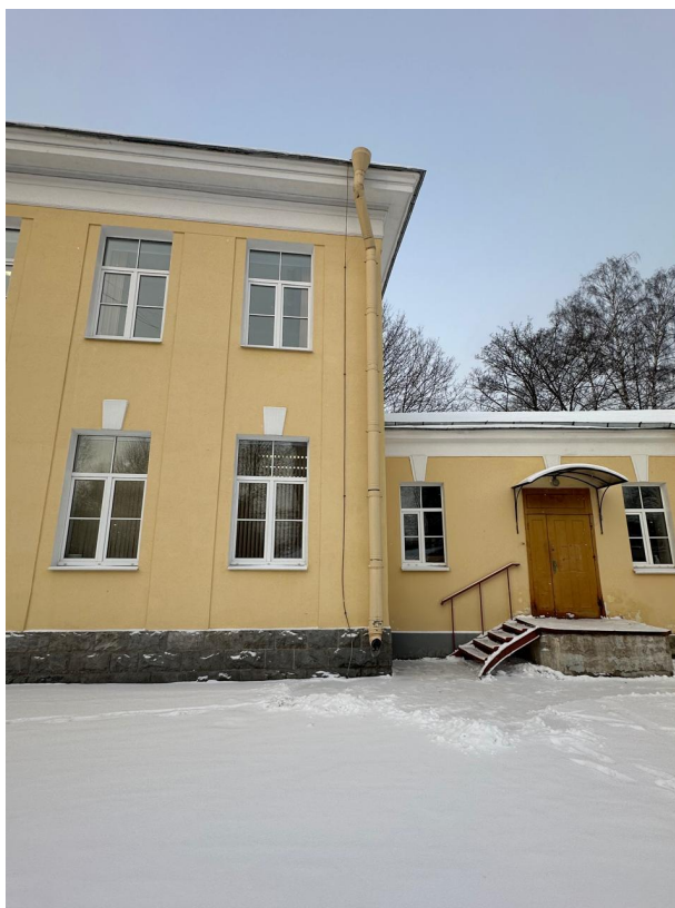
Фото 9. Вид на ОКН «Главный корпус с цандеровским флигелем, конференц-залом и кухонным флигелем». Февраль 2024г.
