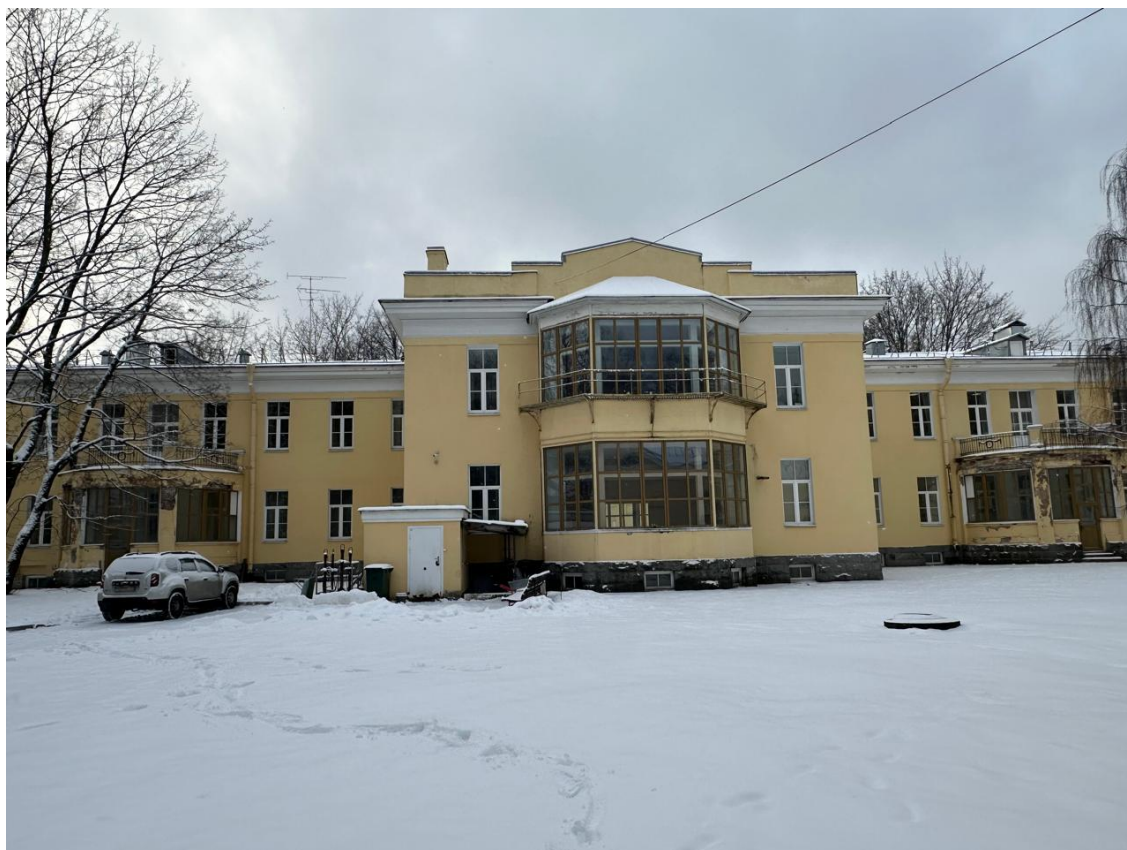
Фото 3. Вид на ОКН «Главный корпус с цандеровским флигелем, конференц-залом и кухонным флигелем». Февраль 2024г.
