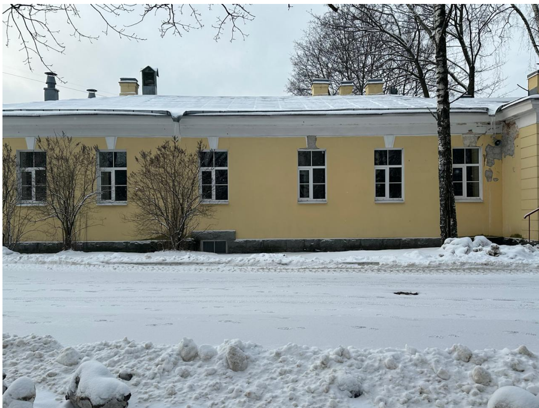
Фото 5. Вид на ОКН «Главный корпус с цандеровским флигелем, конференц-залом и кухонным флигелем». Февраль 2024г.
