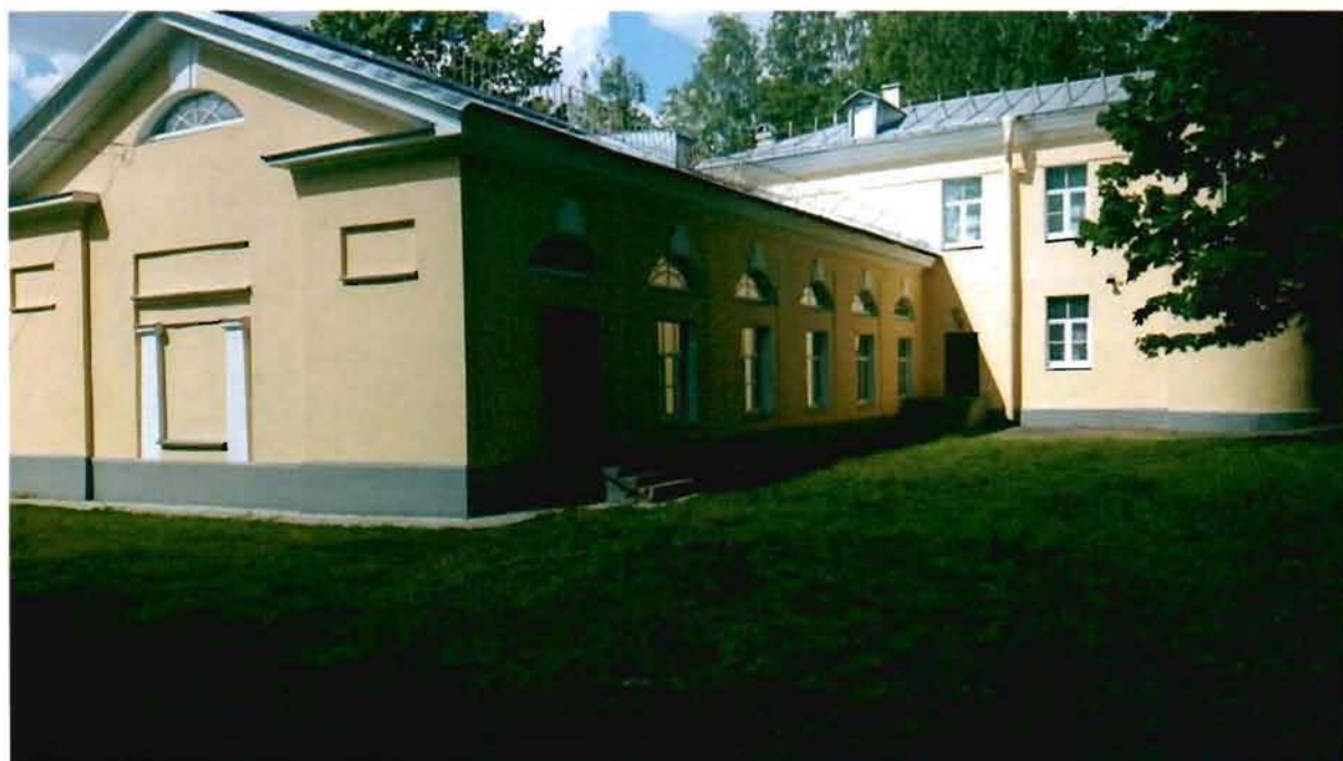
7. Северный лицевой фасад западного флигеля.
