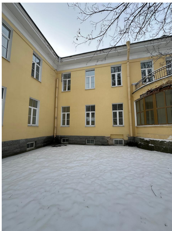
Фото 4. Вид на ОКН «Главный корпус с цандеровским флигелем, конференц-залом и кухонным флигелем». Февраль 2024г.
