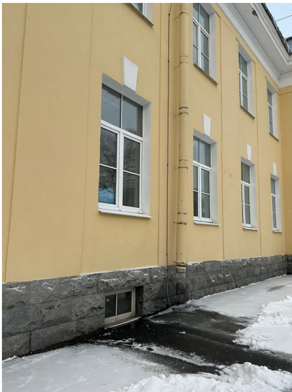
Фото 11. Вид на ОКН «Главный корпус с цандеровским флигелем, конференц-залом и кухонным флигелем». Февраль 2024г.
