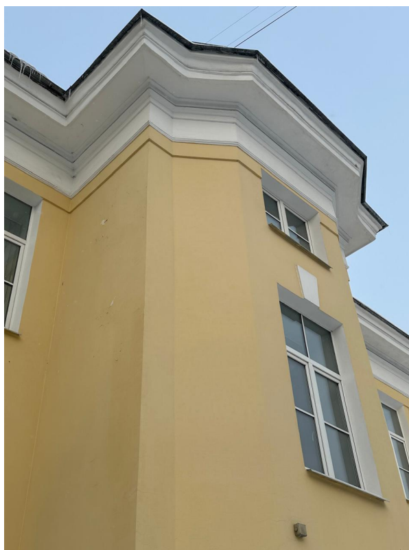
Фото 10. Вид на ОКН «Главный корпус с цандеровским флигелем, конференц-залом и кухонным флигелем». Февраль 2024г.
