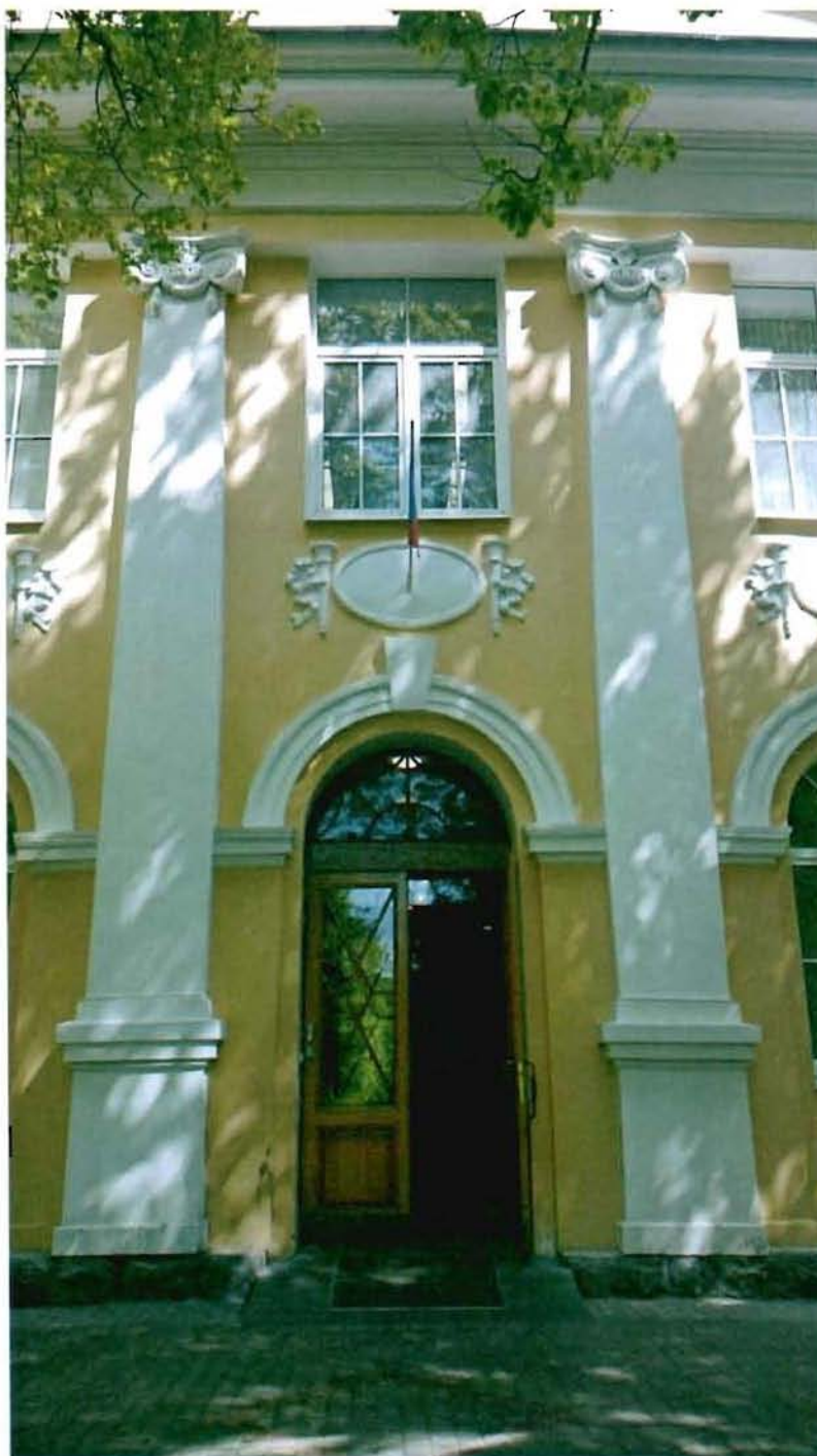
1. Дверной проем центрального ризалита южного лицевого фасада.
