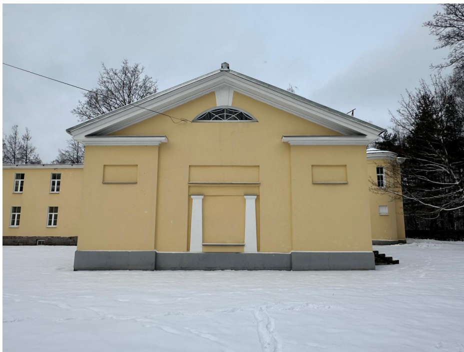
Фото 1. Вид на ОКН «Главный корпус с цандеровским флигелем, конференц-залом и кухонным флигелем». Февраль 2024г.
