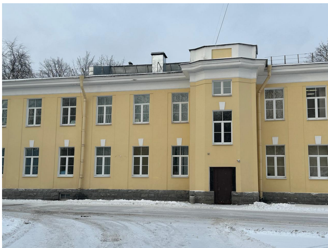
Фото 6. Вид на ОКН «Главный корпус с цандеровским флигелем, конференц-залом и кухонным флигелем». Февраль 2024г.
