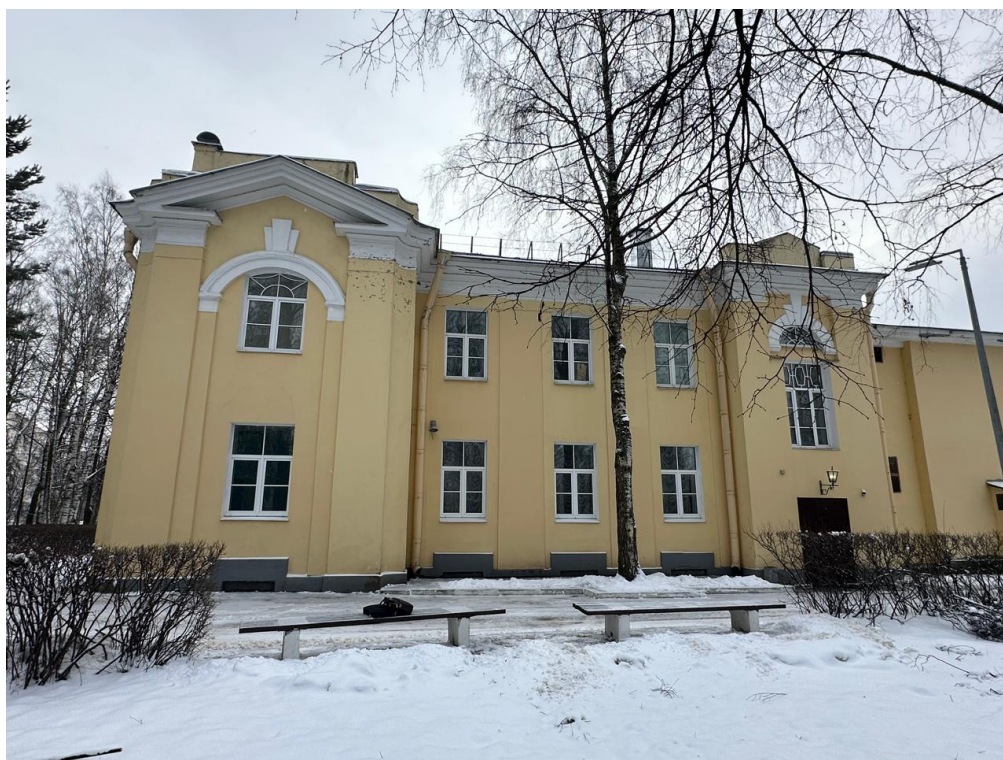
Фото 2. Вид на ОКН «Главный корпус с цандеровским флигелем, конференц-залом и кухонным флигелем». Февраль 2024г.
