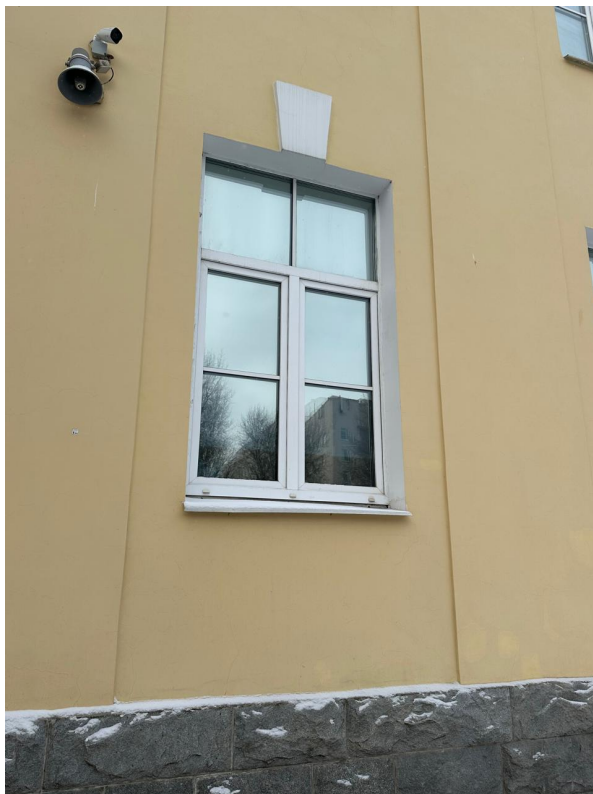
Фото 12. Вид на ОКН «Главный корпус с цандеровским флигелем, конференц-залом и кухонным флигелем». Февраль 2024г.
