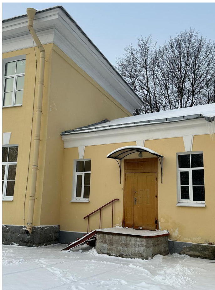
Фото 8. Вид на ОКН «Главный корпус с цандеровским флигелем, конференц-залом и кухонным флигелем». Февраль 2024г.
