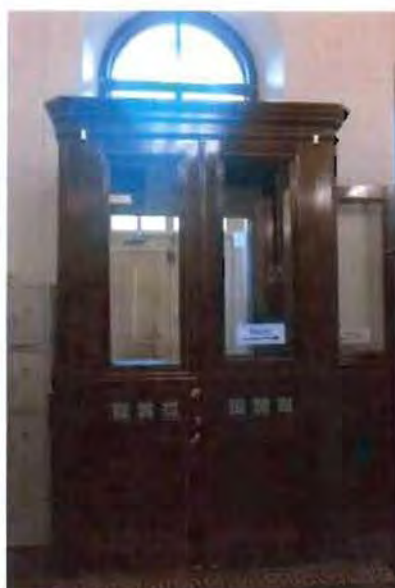
3. Тамбур главного входа.
