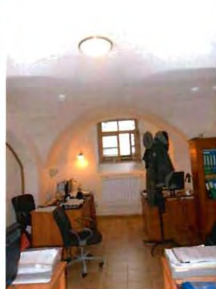
4. Свод цокольного этажа.
