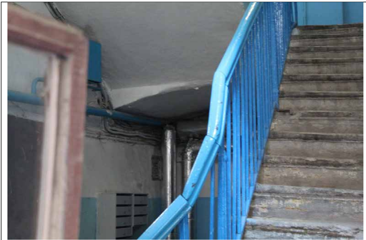
4. Дом А. Ф. Пеля. Шпалерная ул., 5. ЛК-2. Перекрытие лестничной площадки между 1 и 2 этажами. Фото: эксперт А. А. Кононов, 26.04.2021.
