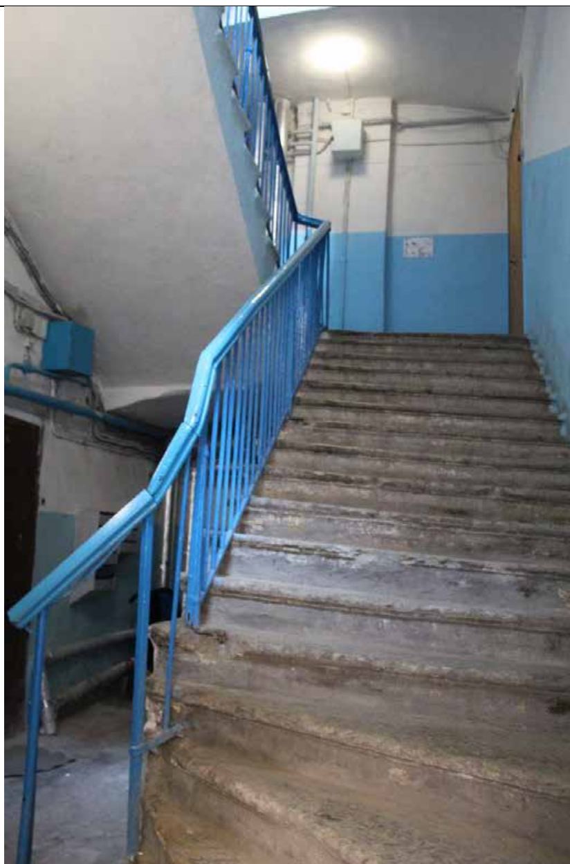
2. Дом А. Ф. Пеля. Шпалерная ул., 5. ЛК-2. Лестничный марш между 1 и 2 этажами. Фото: эксперт А. А. Кононов, 26.04.2021.
