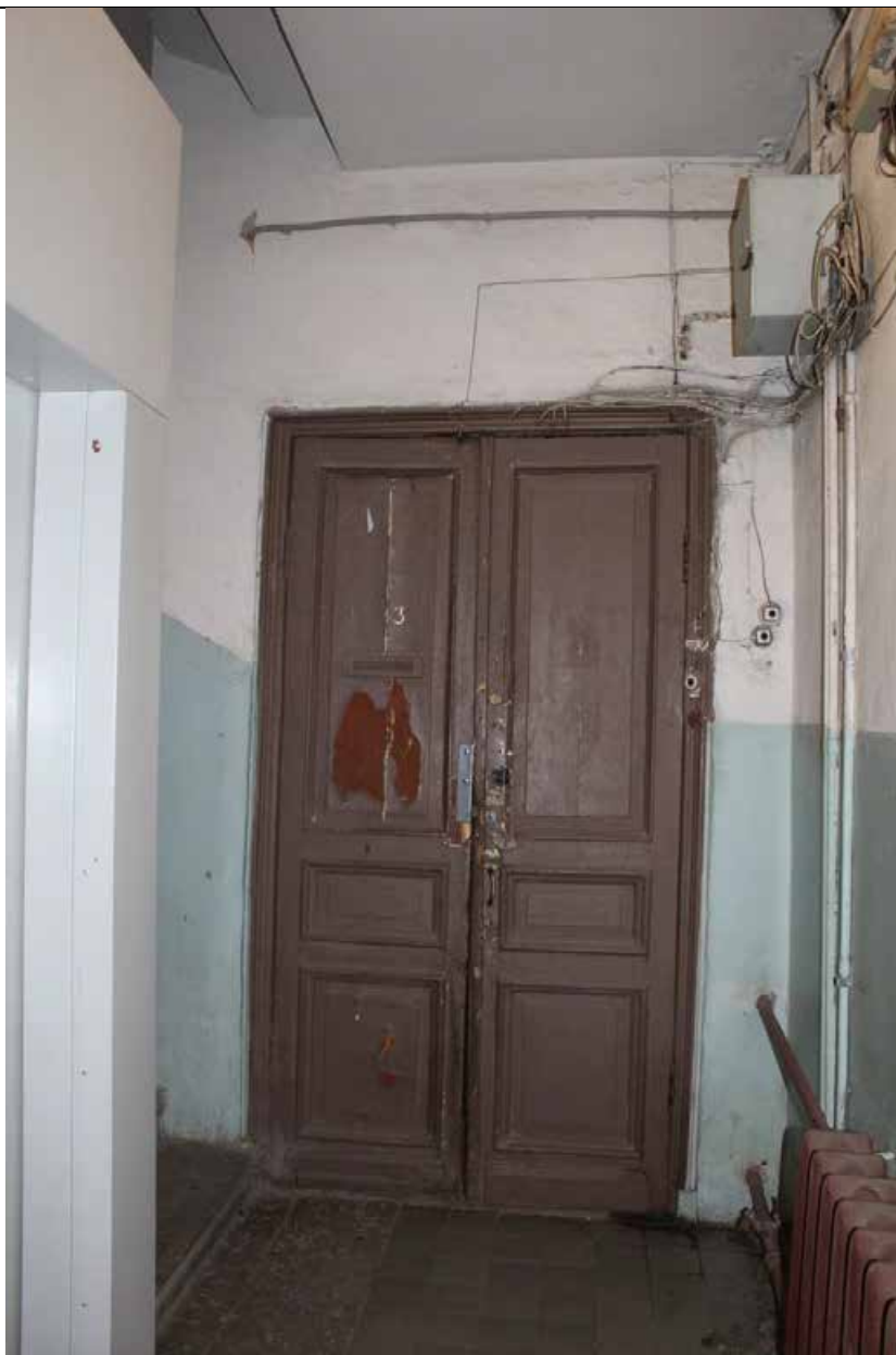
14. Дом А. Ф. Пеля. Шпалерная ул., 5. ЛК-1. Заполнение дверного проема квартиры на 2 этаже. Фото: эксперт А. А. Кононов, 26.04.2021.
