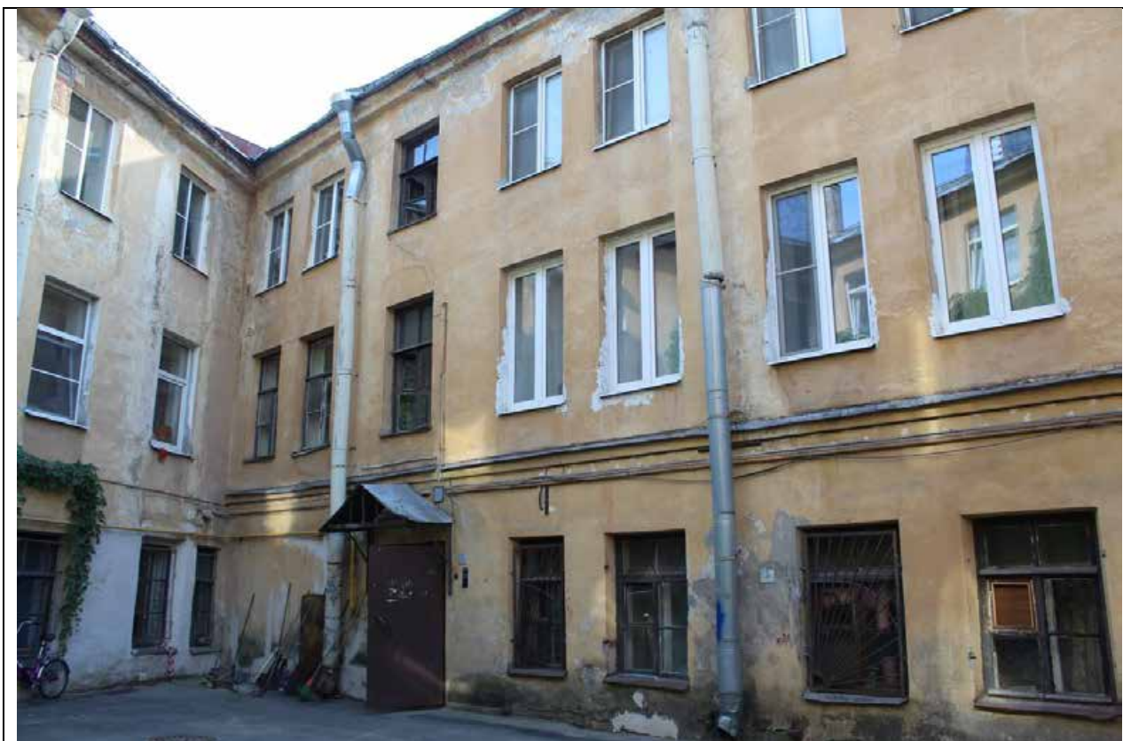
27. Дом А. Ф. Пеля. Шпалерная ул., 5. Южный двор. Юго-западный и южный (фрагмент) дворовые флигели. Вид с северо-востока. Фото: эксперт А. А. Кононов, 26.04.2021.
