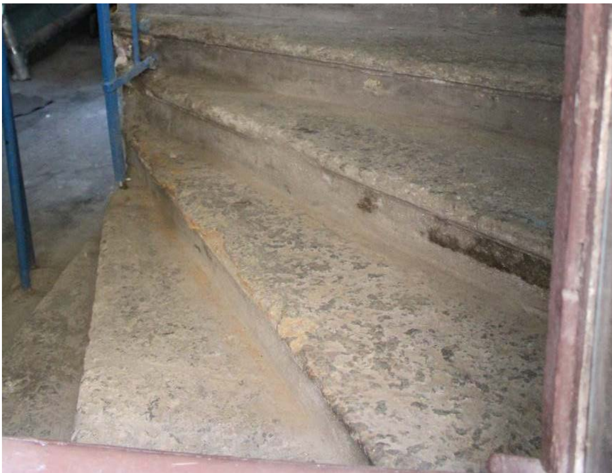
1. Дом А. Ф. Пеля. Шпалерная ул., 5. ЛК-2. Лестничный марш. Фрагмент. Забежные ступени. Фото: эксперт А. А. Кононов, 26.04.2021.
