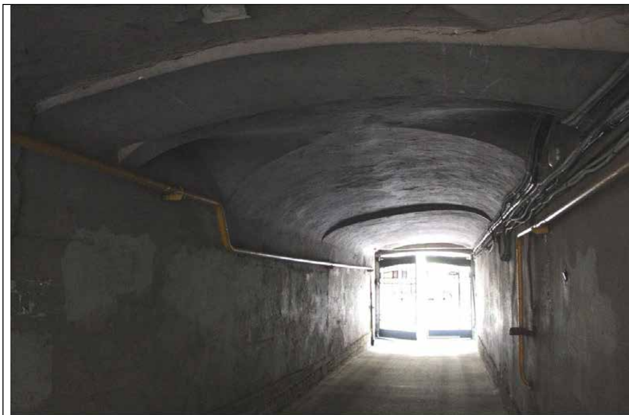
11. Дом А. Ф. Пеля. Шпалерная ул., 5. Воротный проезд. Своды. Вид со стороны двора. Фото: эксперт А. А. Кононов, 26.04.2021.
