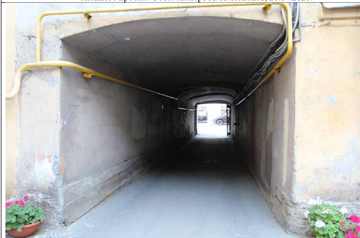
10. Дом А. Ф. Пеля. Шпалерная ул., 5. Воротный проезд. Вид со стороны двора. Фото: эксперт А. А. Кононов, 01.06.2021.
