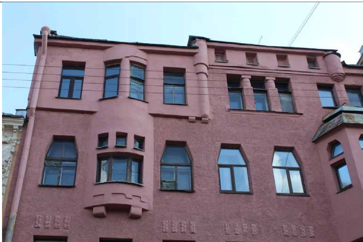
3. Дом А. Ф. Пеля. Шпалерная ул., 5. Фрагмент лицевого фасада. Вид с севера. Фото: эксперт А. А. Кононов, 26.04.2021.
