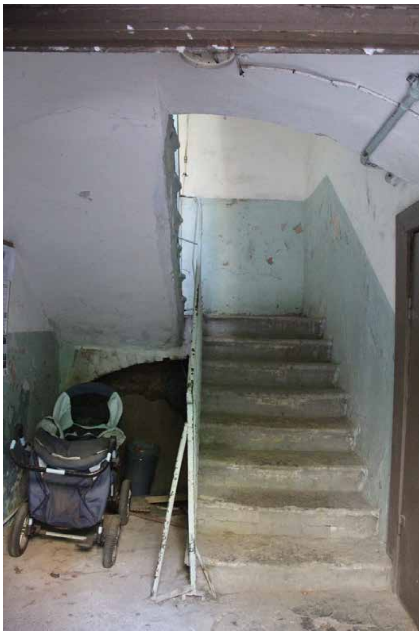
1. Дом А. Ф. Пеля. Шпалерная ул., 5. Южный двор. Юго-западный дворовый флигель. Интерьер 1 этажа. Фото: эксперт А. А. Кононов, 26.04.2021.
