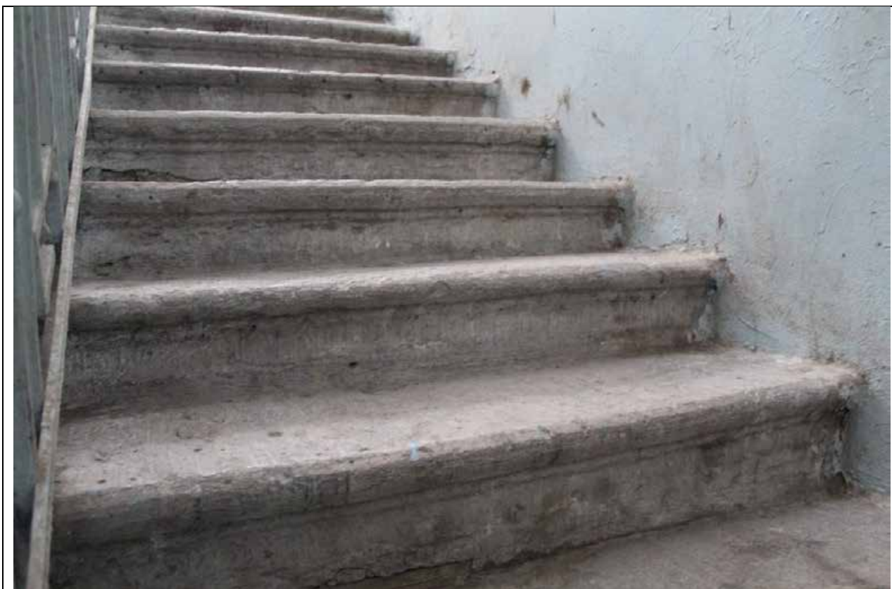
22. Дом А. Ф. Пеля. Шпалерная ул., 5. ЛК-1. Лестничный марш. Фрагмент. Ступени с валиком. Фото: эксперт А. А. Кононов, 26.04.2021.
