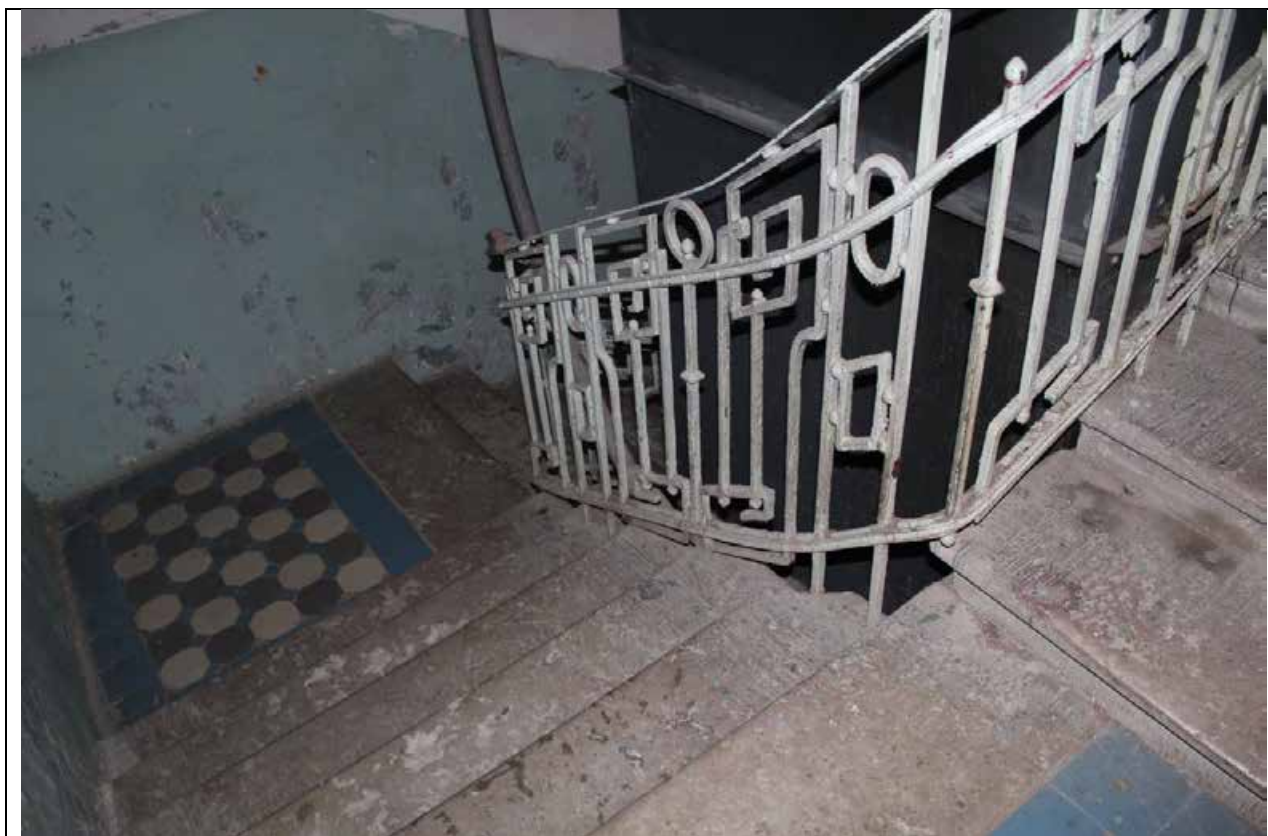
12. Дом А. Ф. Пеля. Шпалерная ул., 5. ЛК-1. Лестничные марши на 2 этаж. Фото: эксперт А. А. Кононов, 26.04.2021.
