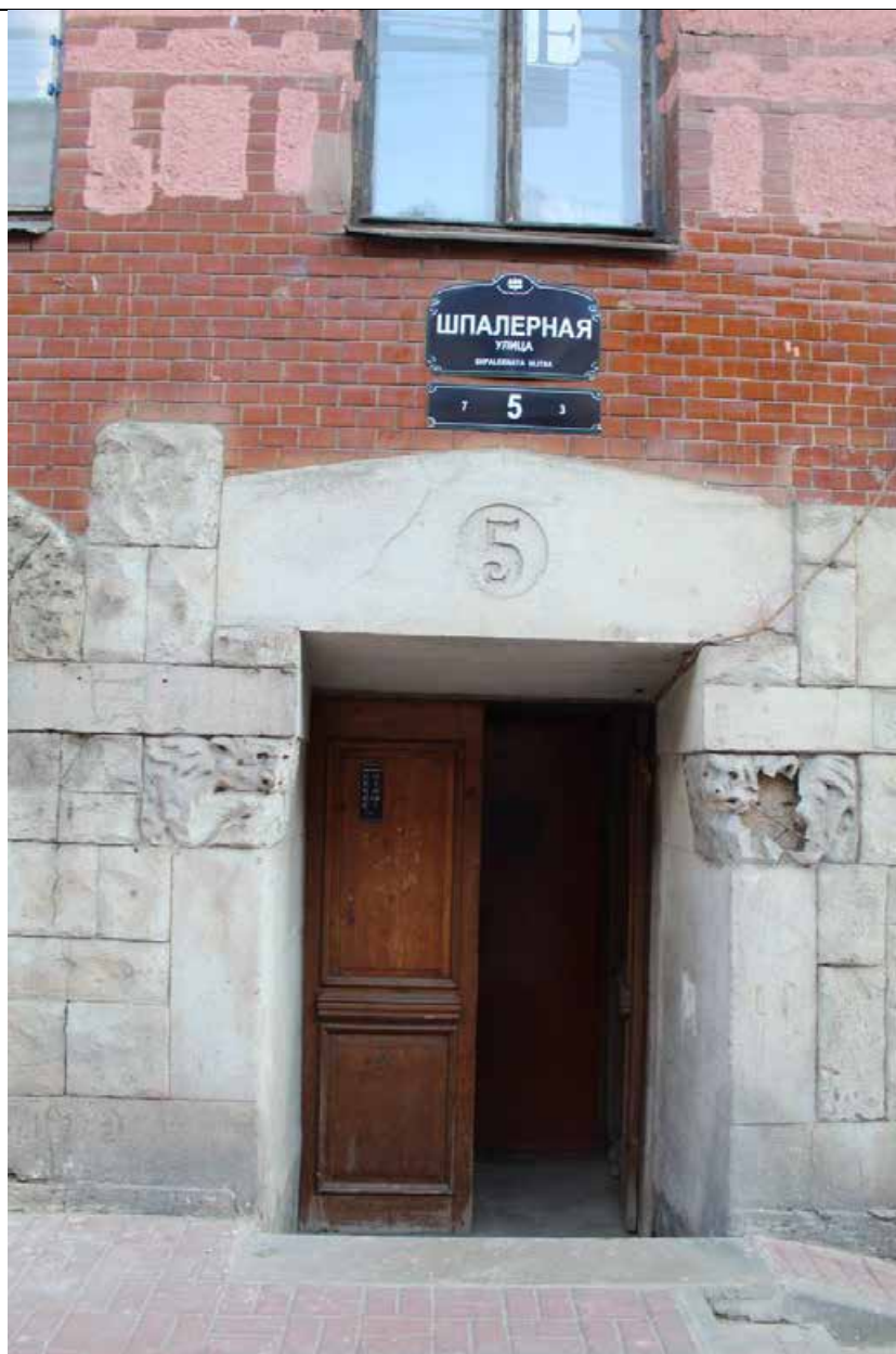
6. Дом А. Ф. Пеля. Шпалерная ул., 5. Фрагмент лицевого фасада. Дверной проем. Вид с севера. Фото: эксперт А. А. Кононов, 26.04.2021.
