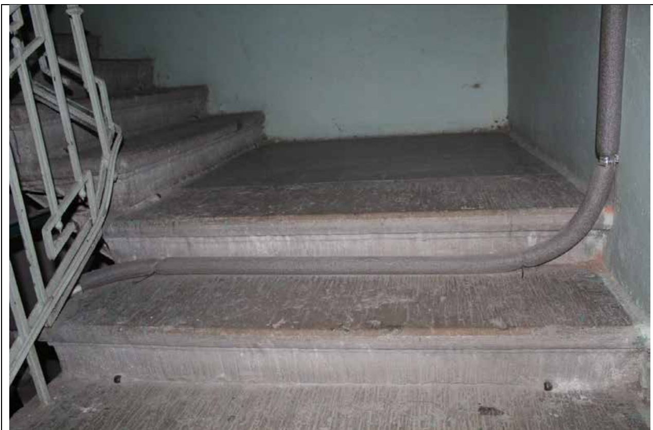
18. Дом А. Ф. Пеля. Шпалерная ул., 5. ЛК-1. Ступени лещадной плиты с валиком. Фото: эксперт А. А. Кононов, 26.04.2021.
