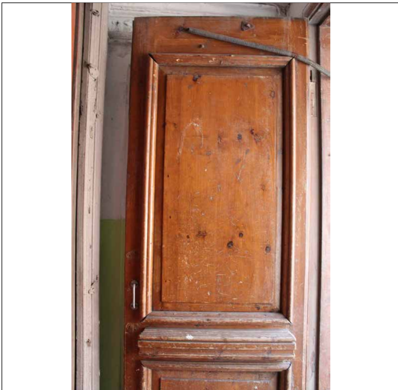
3. Дом А. Ф. Пеля. Шпалерная ул., 5. ЛК-1. Заполнение дверного проема. Фрагмент. Фото: эксперт А. А. Кононов, 26.04.2021.
