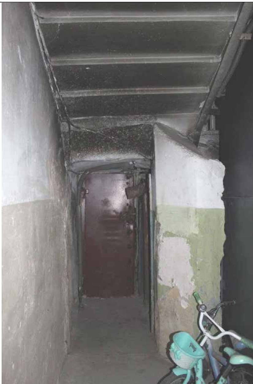
10. Дом А. Ф. Пеля. Шпалерная ул., 5. ЛК-1. Перекрытие и лестница по косоурам. Фото: эксперт А. А. Кононов, 26.04.2021.
