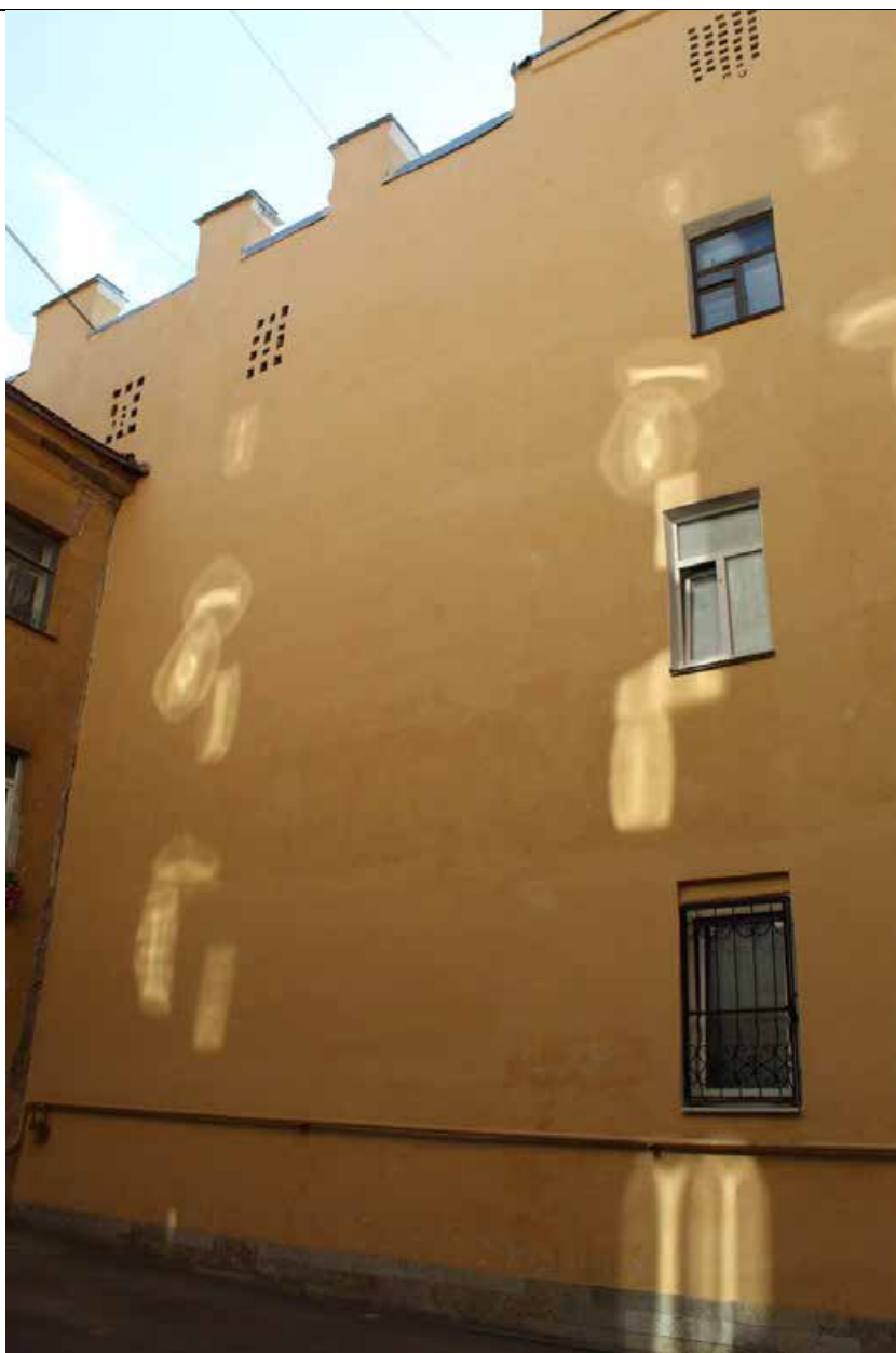
18. Дом А. Ф. Пеля. Шпалерная ул., 5. Северный двор. Западный фасад дворового флигеля здания по Шпалерной ул., 3. Фрагмент. Фото: эксперт А. А. Кононов, 26.04.2021.
