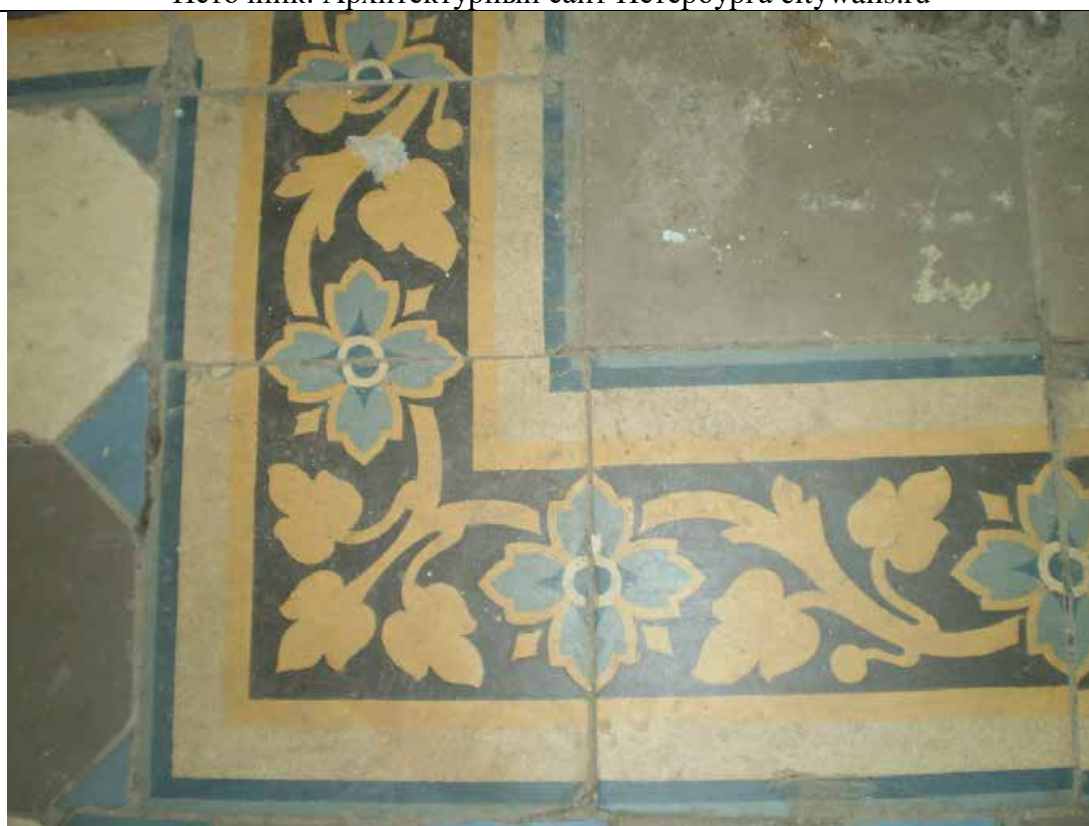
95. Дом по Шпалерной ул., д. 5. Парадная лестница. 2012. Источник: Архитектурный сайт Петербурга citywalls.ru
