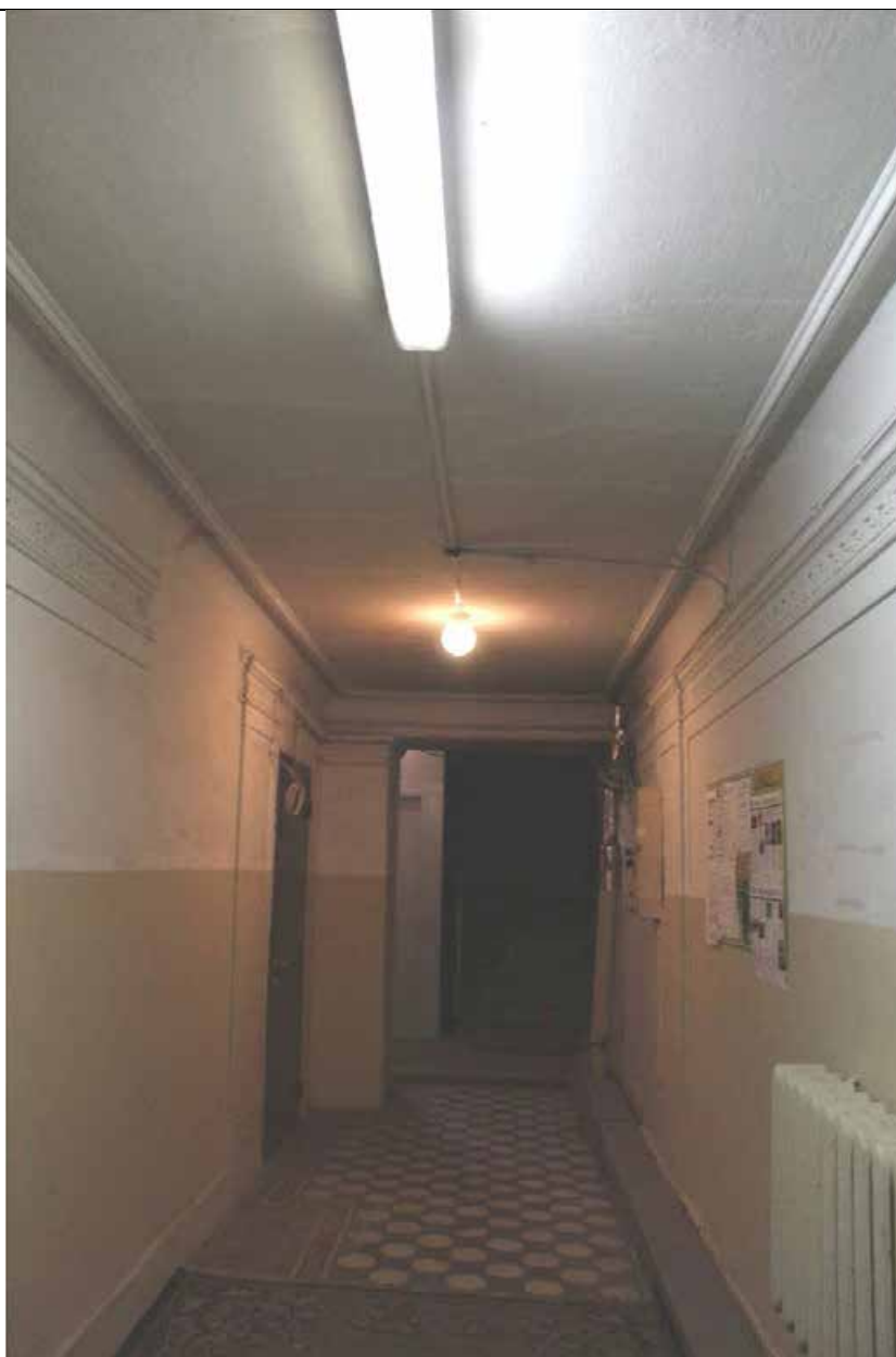
5. Дом А. Ф. Пеля. Шпалерная ул., 5. ЛК-1. Вестибюль. Фото: эксперт А. А. Кононов, 26.04.2021.
