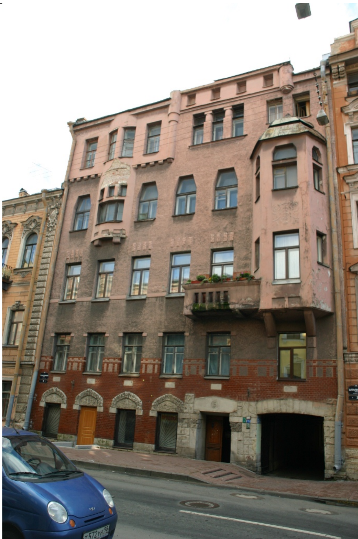
67. Фасад здания по Шпалерной ул., 5. 2011.
