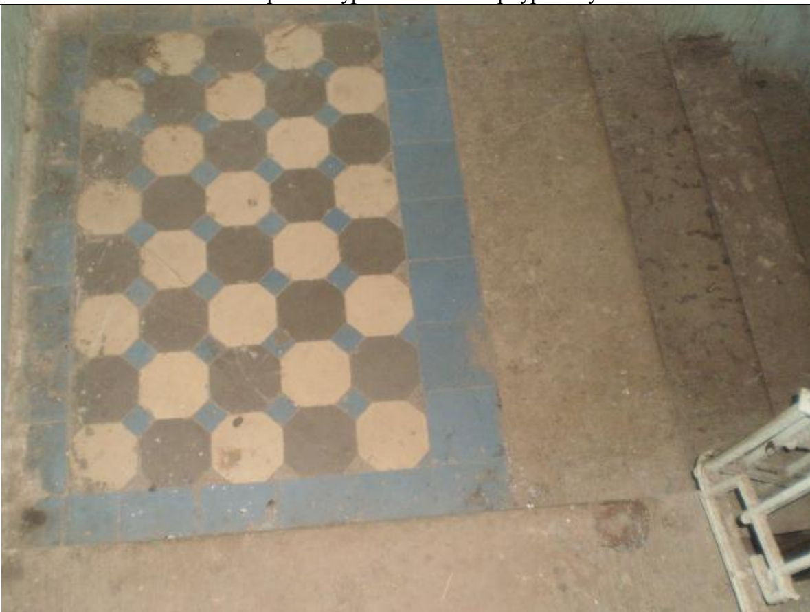
100. Дом по Шпалерной ул., д. 5. Парадная лестница. 2012. Источник: Архитектурный сайт Петербурга citywalls.ru
