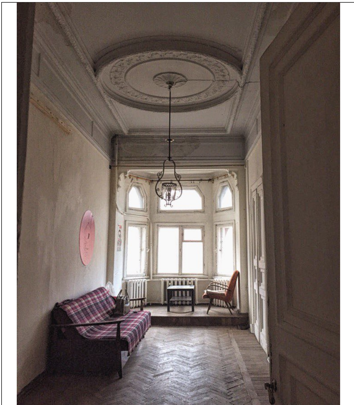
115. Дом по Шпалерной ул., д. 5. Интерьер квартиры. 2016. Источник: Группа Вконтакте «Старый фонд» https://vk.com/sf_spb
