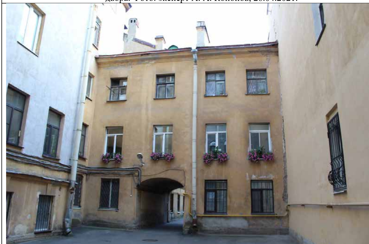
12. Дом А. Ф. Пеля. Шпалерная ул., 5. Северный двор. Центральный дворовый флигель. Общий вид. Фото: эксперт А. А. Кононов, 26.04.2021.
