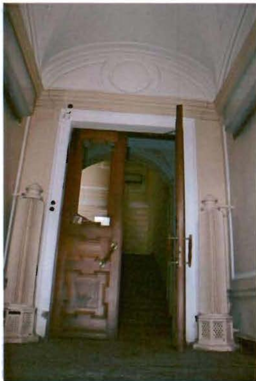
Фото №12. Вестибюль парадного входа.
