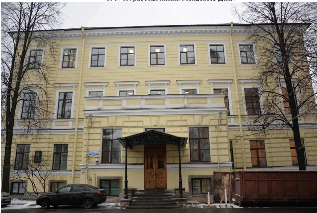
2. Восточный фасад объекта культурного наследия федерального значения «Дом, где в 1893-1907 гг. работал химик Менделеев Д.И.»
