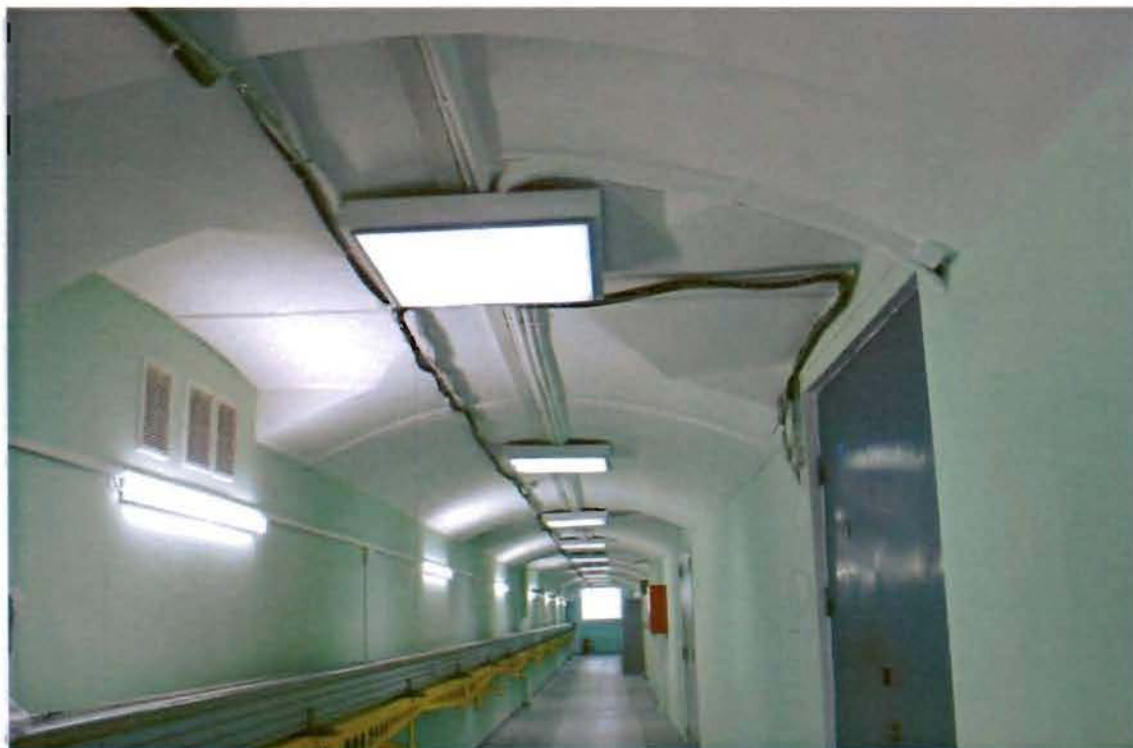
Фото №14. Цокольный этаж.
