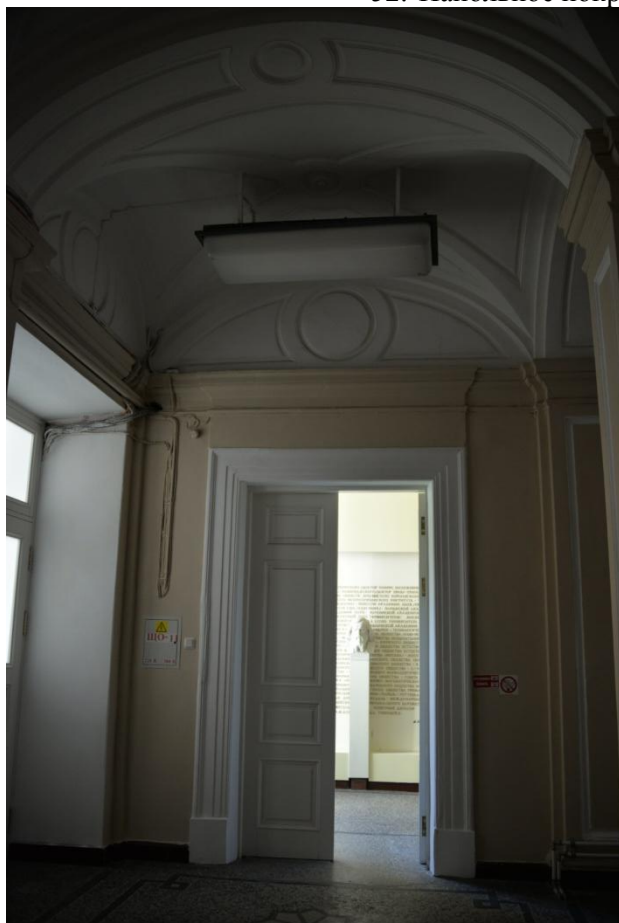
53. Интерьер помещения №51. Дверь в помещение №56
