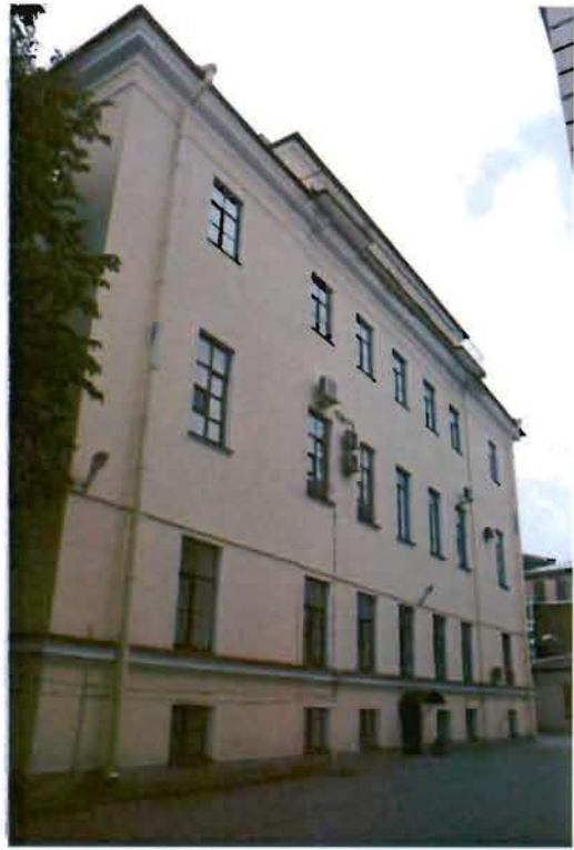
Фото №3. Вид на западный фасад.
