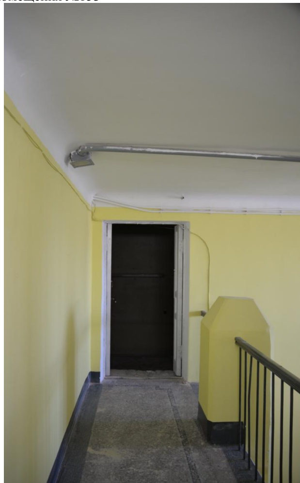
73. Вид на дверь в помещение №151
