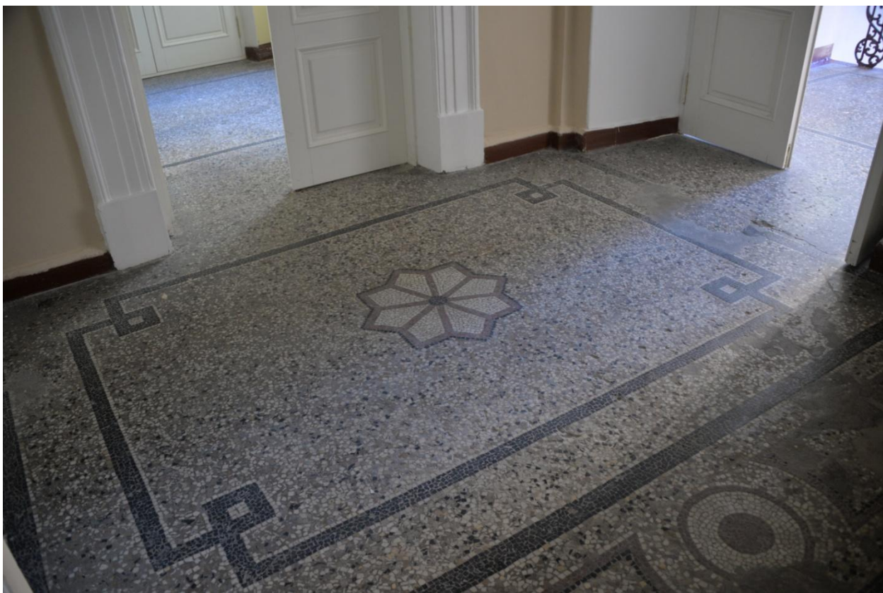
52. Напольное покрытие в помещении №51
