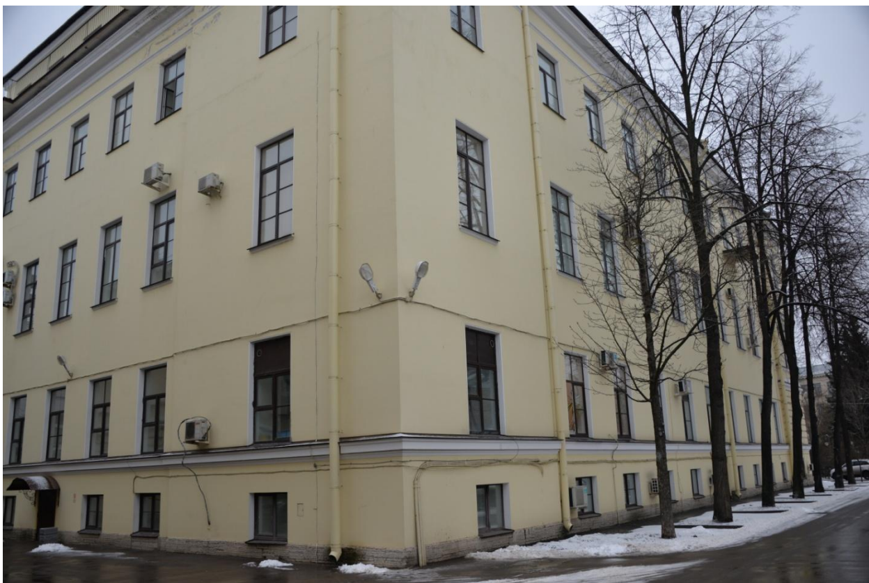
12. Фрагмент южного фасада объекта культурного наследия федерального значения «Дом, где в 1893-1907 гг. работал химик Менделеев Д.И.»
