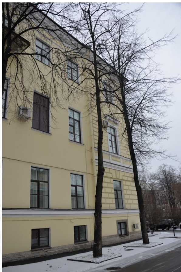
10. Фрагмент южного фасада объекта культурного наследия федерального значения «Дом, где в 1893-1907 гг. работал химик Менделеев Д.И.»
