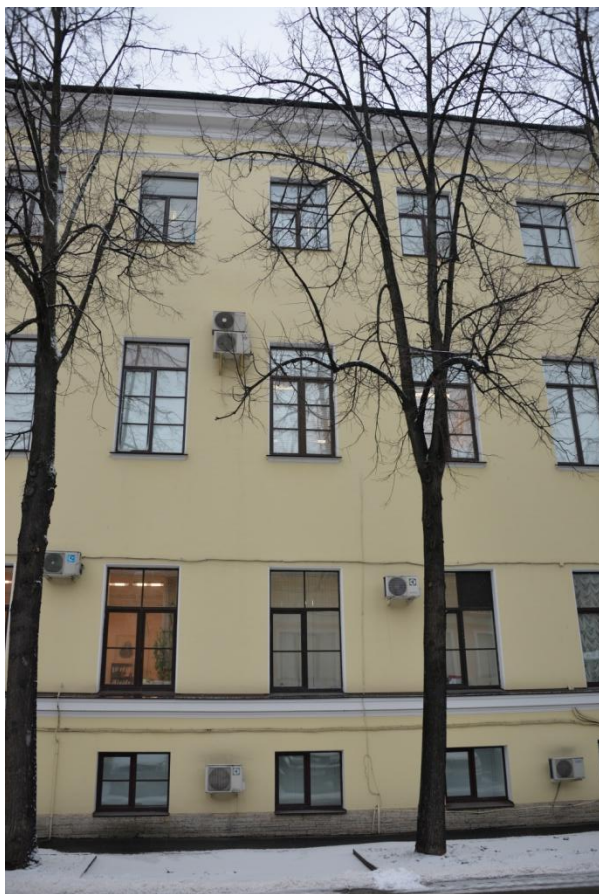
9. Фрагмент южного фасада объекта культурного наследия федерального значения «Дом, где в 1893-1907 гг. работал химик Менделеев Д.И.»
