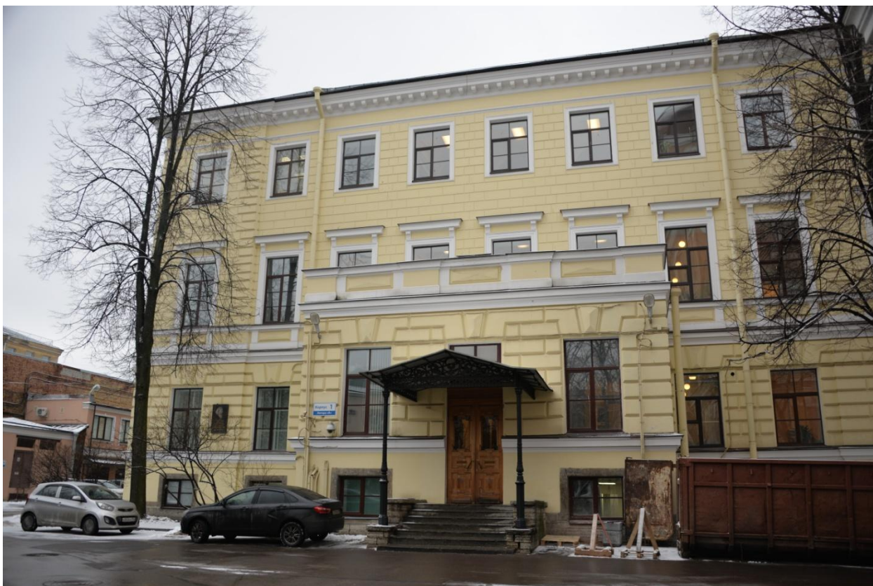
3. Восточный фасад объекта культурного наследия федерального значения «Дом, где в 1893-1907 гг. работал химик Менделеев Д.И.»
