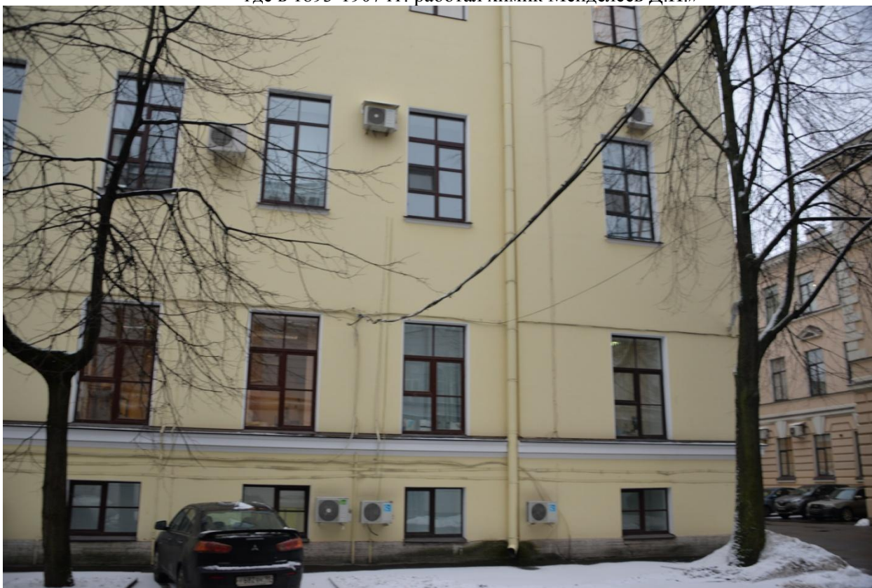
17. Фрагмент северного фасада объекта культурного наследия федерального значения «Дом, где в 1893-1907 гг. работал химик Менделеев Д.И.»
