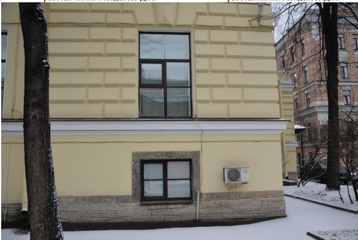
11. Фрагмент южного фасада объекта культурного наследия федерального значения «Дом, где в 1893-1907 гг. работал химик Менделеев Д.И.»
