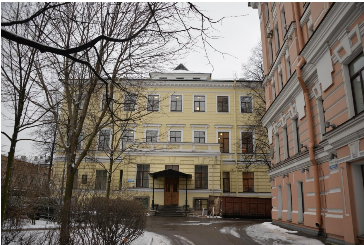
1. Восточный фасад объекта культурного наследия федерального значения «Дом, где в 1893-1907 гг. работал химик Менделеев Д.И.»
