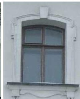
стилизированными валютами на концах, стилизованные замковые камни, фигурные разорванные сандрики с лепными композициями рокайльного характера, фигурные филенки, профилированные подоконные доски на стилизованных модульонах с гуттами и лепными композициями рокайльного характера);
