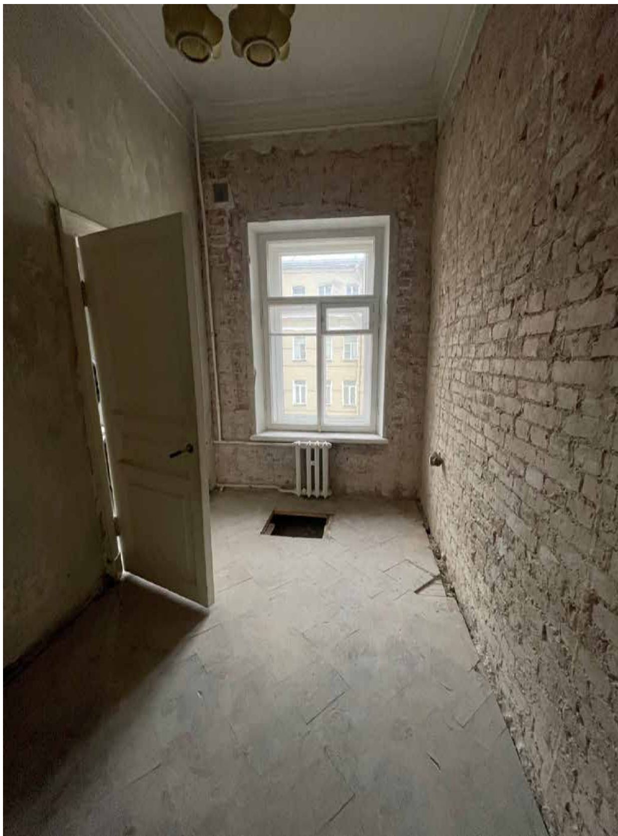
7. Фрагмент интерьера комнаты (помещение 6/8.7);
