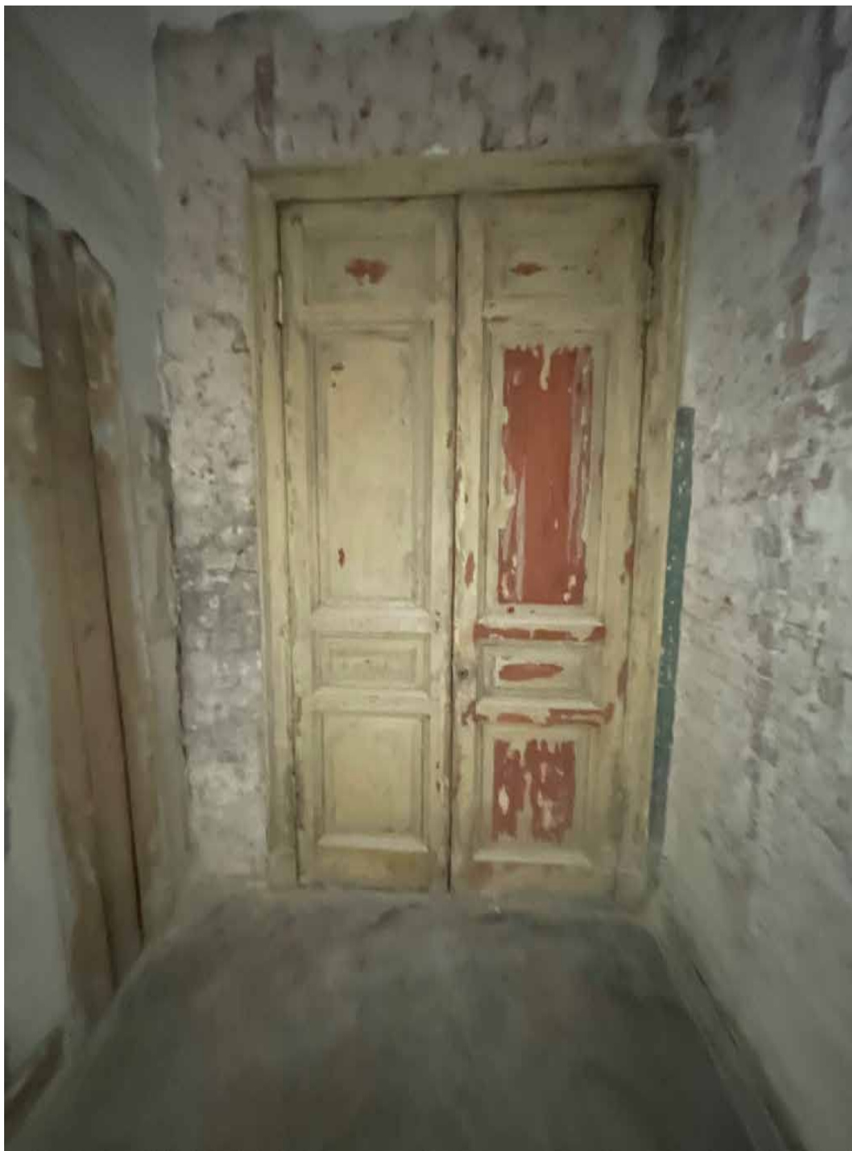
8. Вид на входную дверь в квартире;
