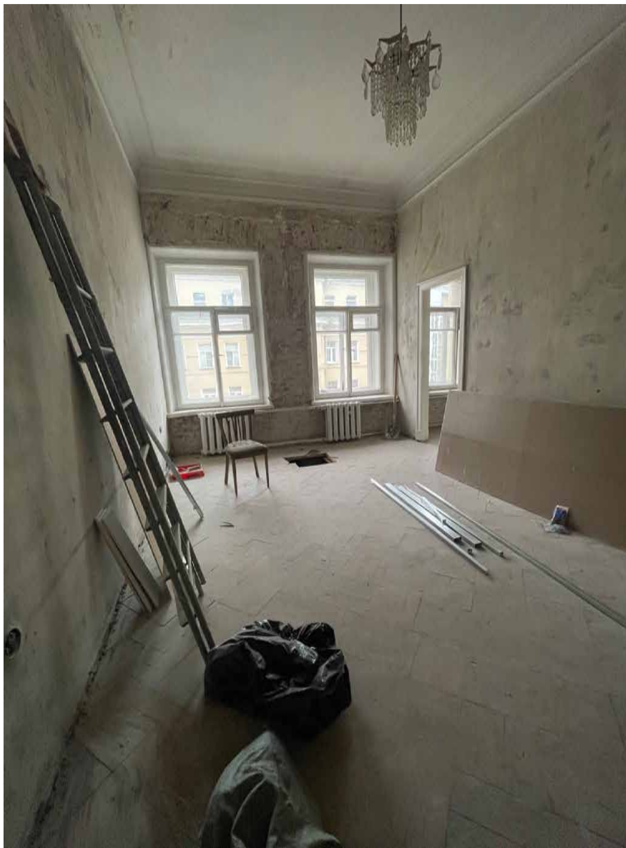
6. Фрагмент интерьера комнаты (помещение 5/21);
