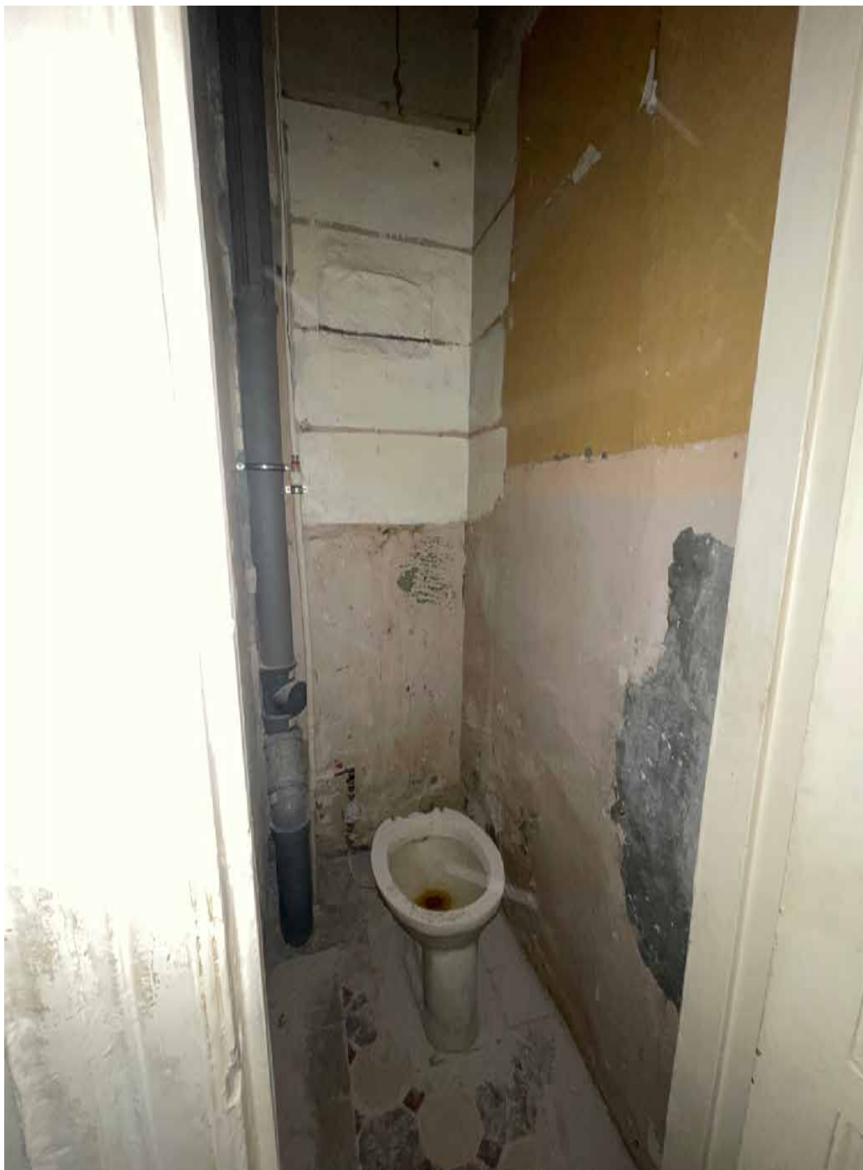
4. Фрагмент интерьера туалета (помещение 3/1);
