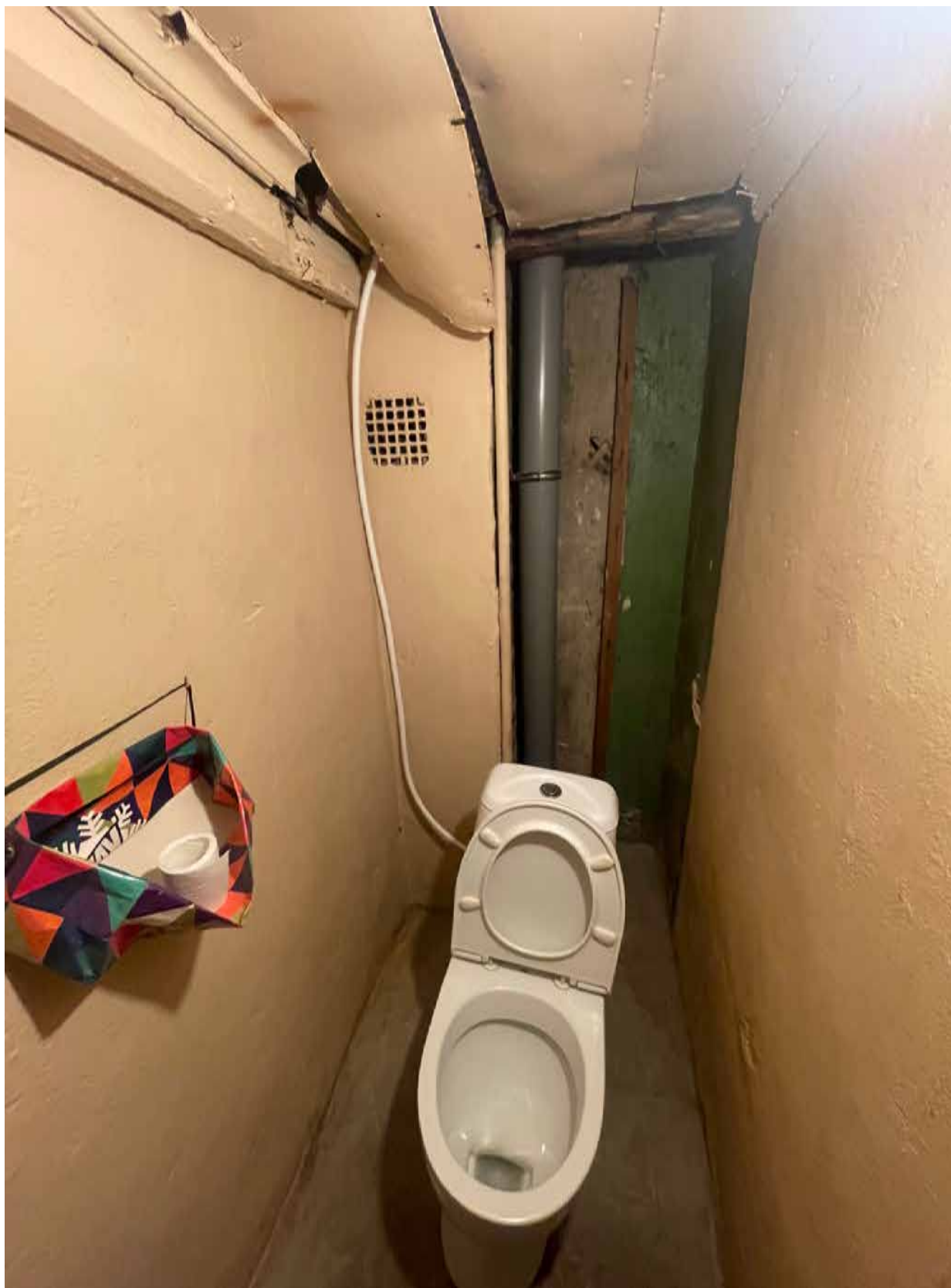
31.Фрагмент интерьера туалета (помещение 22/1.6);
