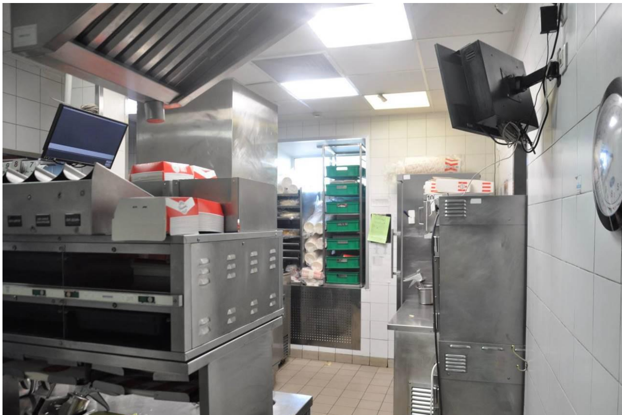
Фото 9. Рабочая зона кухни. 1 этаж.
