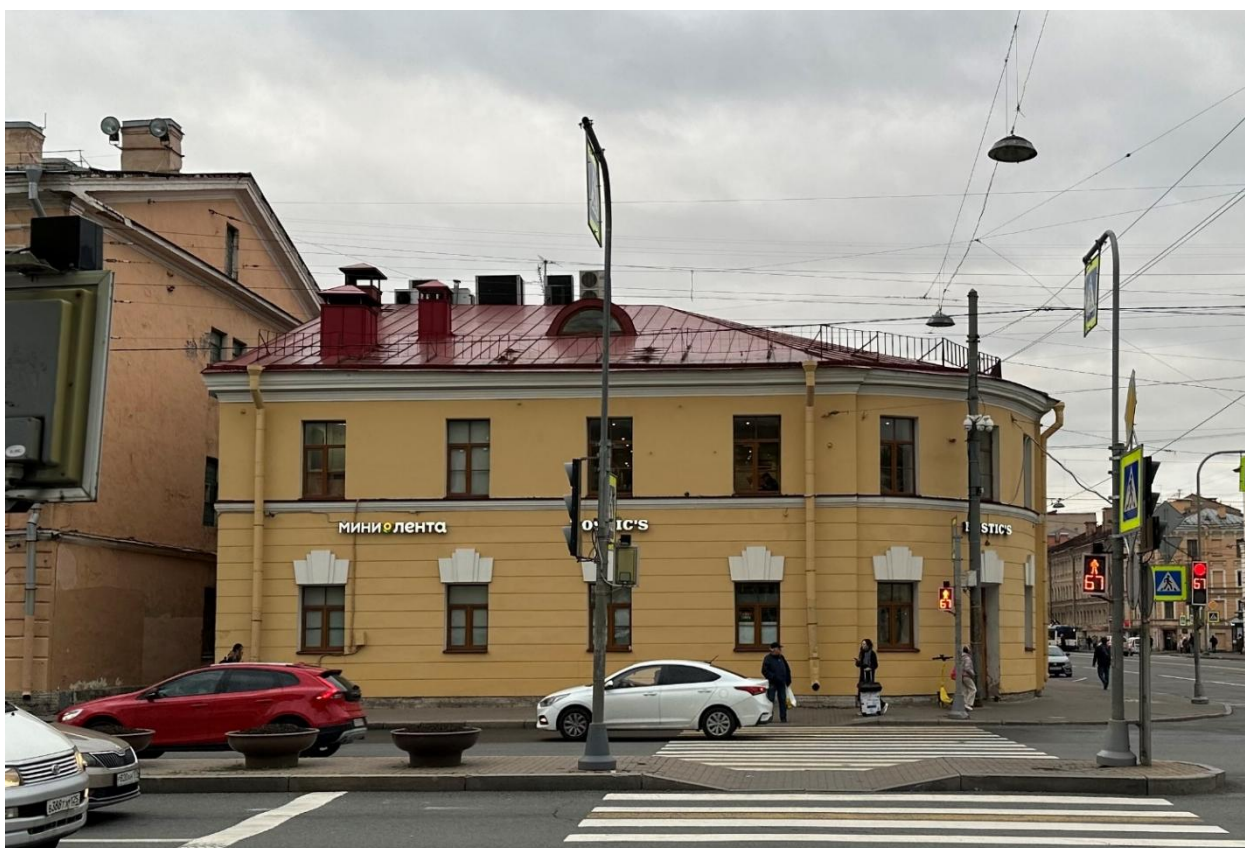
Фото 2. Общий вид фасада в осях А-В/1.
