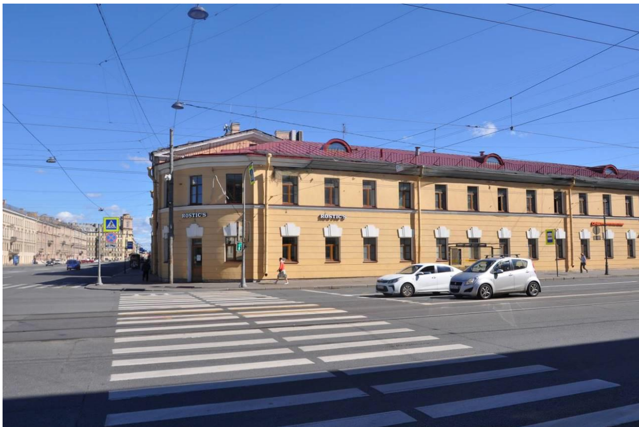
Фото 1. Общий вид фасада в осях А/1-2.
