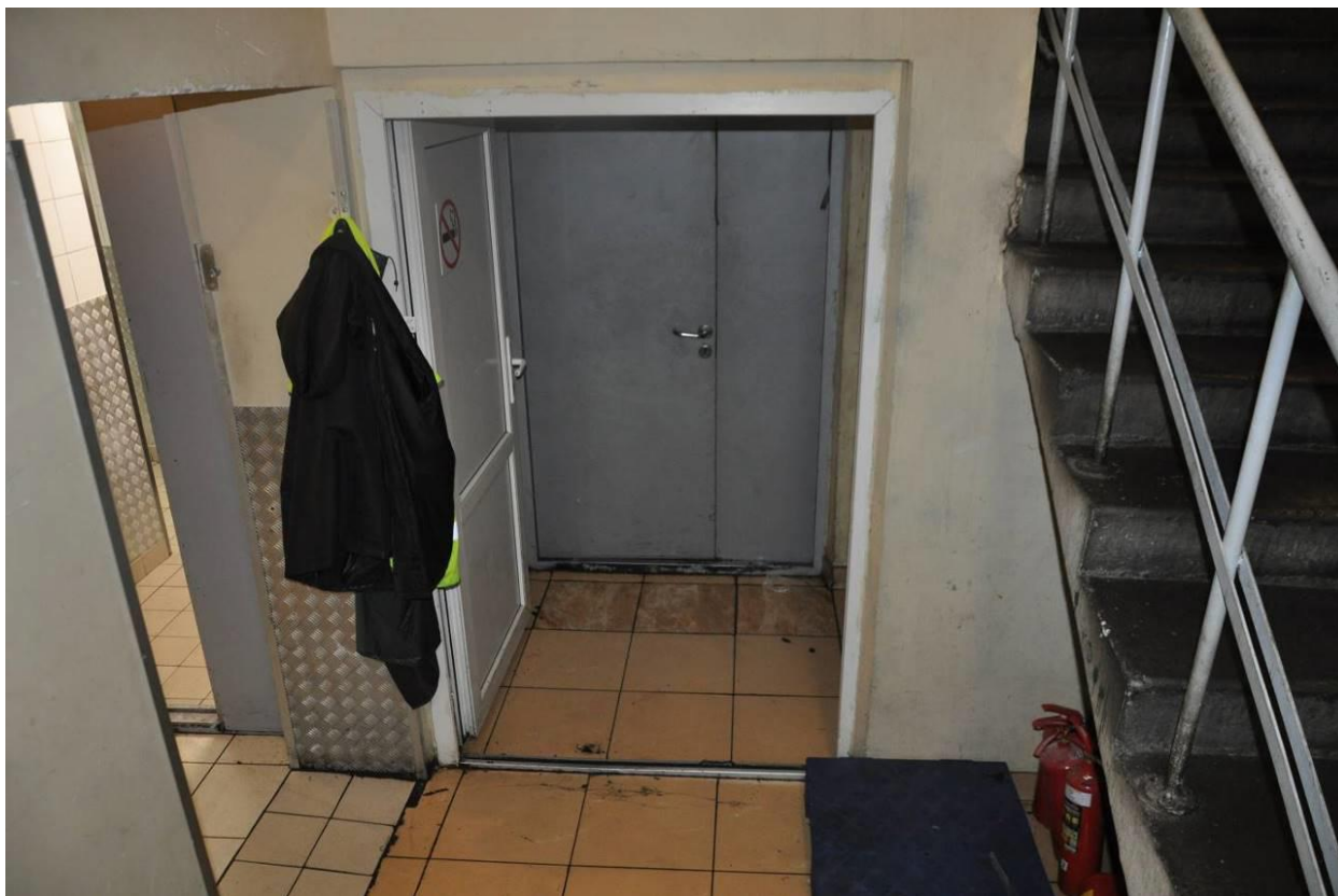
Фото 17. Запасной выход в осях В/4.
