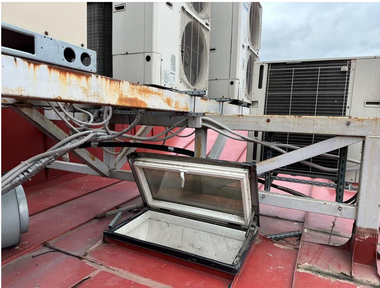
Фото 23. Лаз на кровлю. Металлическая рама под наружные блоки кондиционеров и оборудование.
