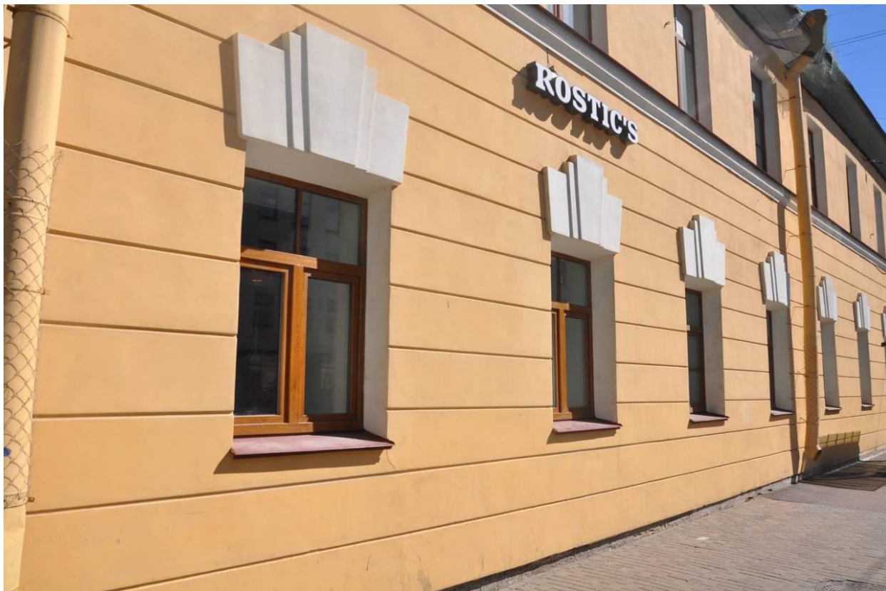
Фото 3. Фрагмент фасада в осях А/2-4.
