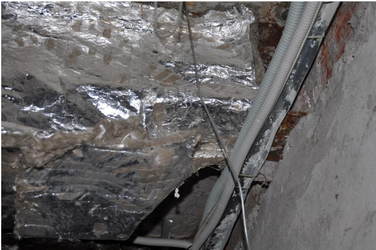
Фото 11. Перекрытие 1-го этажа. Несущие элементы перекрытия укрыты огнезащитным материалом.
