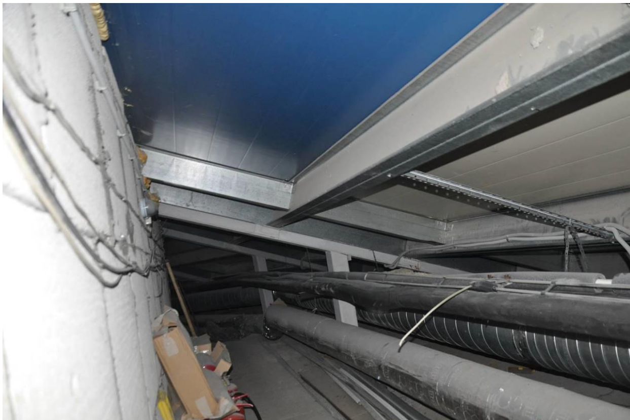
Фото 19. Элементы стропильной системы. Общий вид.
