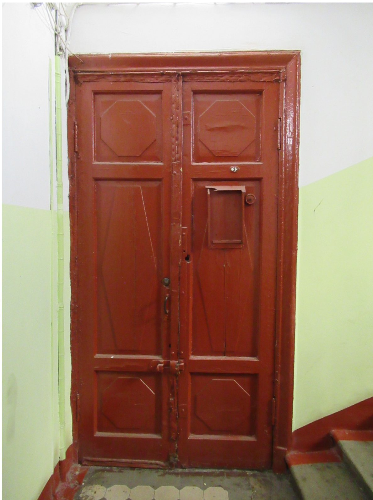
63. 12-я линия В.О., 19. Дом О.М. Фогт и Б.А. Попова. 1ЛК, дверь квартиры с историческим деревянным заполнением.
