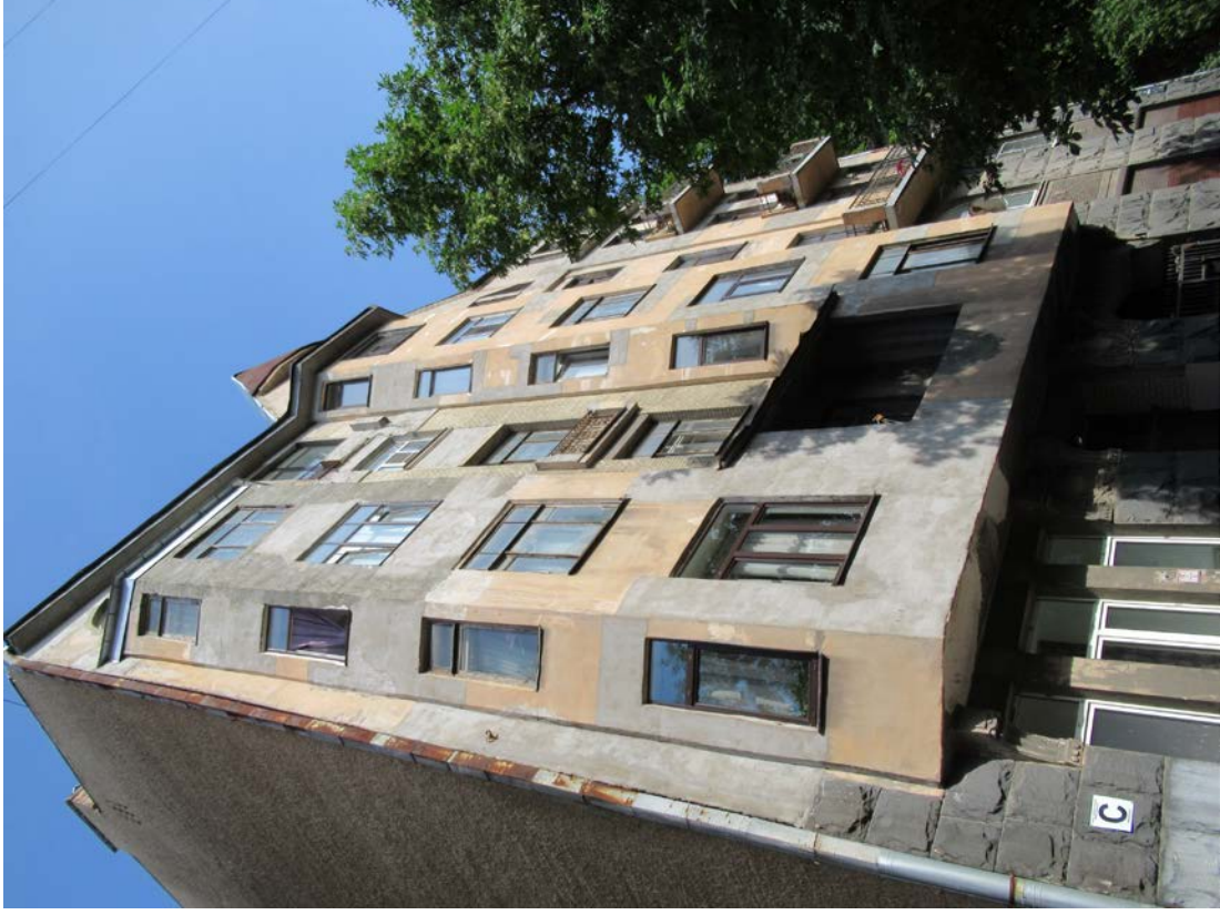
5. 12-я линия В.О., 19. Дом О.М. Фогт и Б.А. Попова. Вид на северную часть лицевого фасада снизу.
