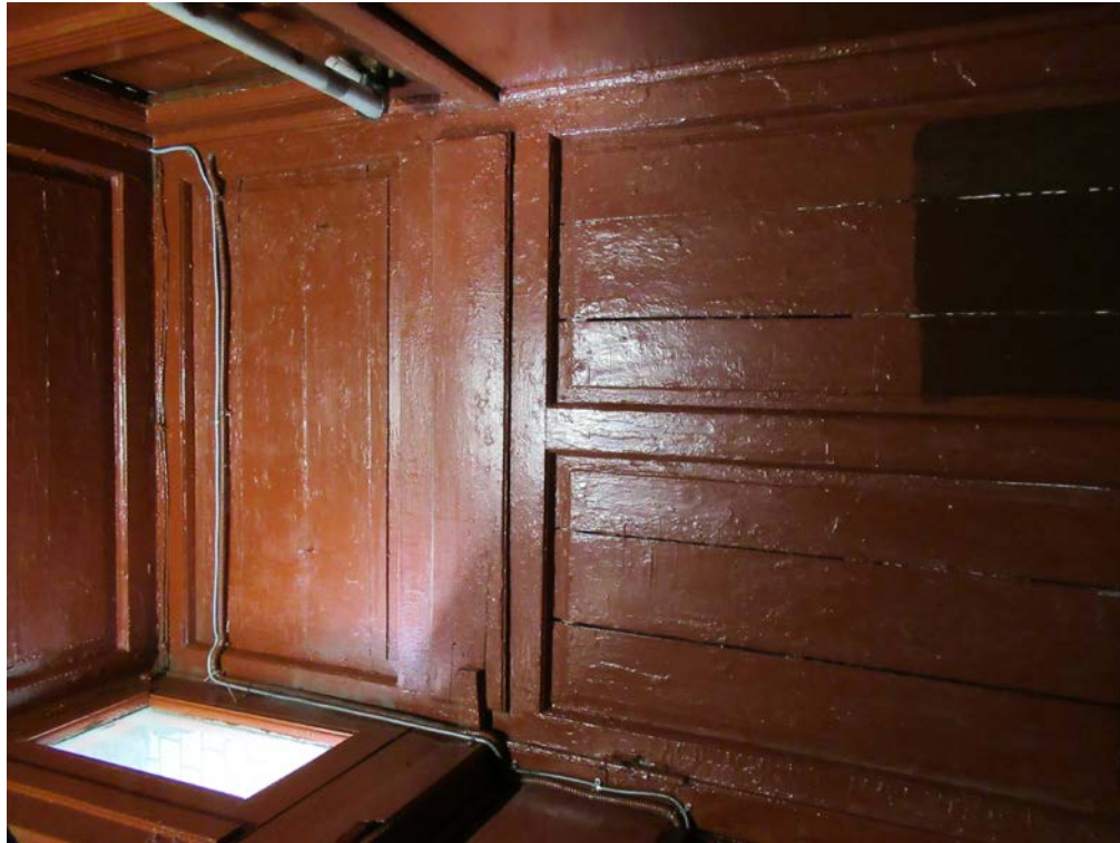
48. 12-я линия В.О., 19. Дом О.М. Фогт и Б.А. Попова. 1ЛК, фрагмент отделки стен тамбура.
