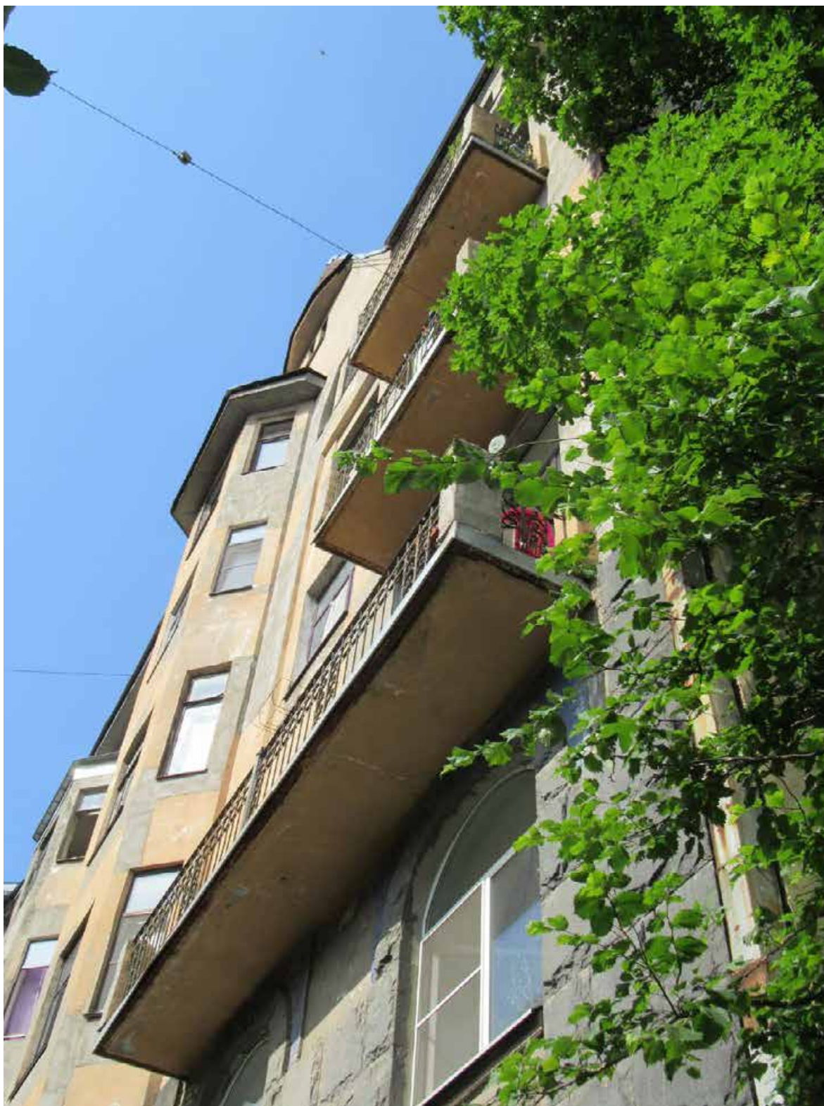
6. 12-я линия В.О., 19. Дом О.М. Фогт и Б.А. Попова. Вид на верхнюю часть южной части лицевого фасада снизу.
