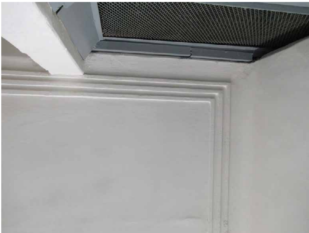
89. 12-я линия В.О., 19. Дом О.М. Фогт и Б.А. Попова. ЗЛК, фрагмент профилированной штукатурной тяги потолка 6-го этажа.
