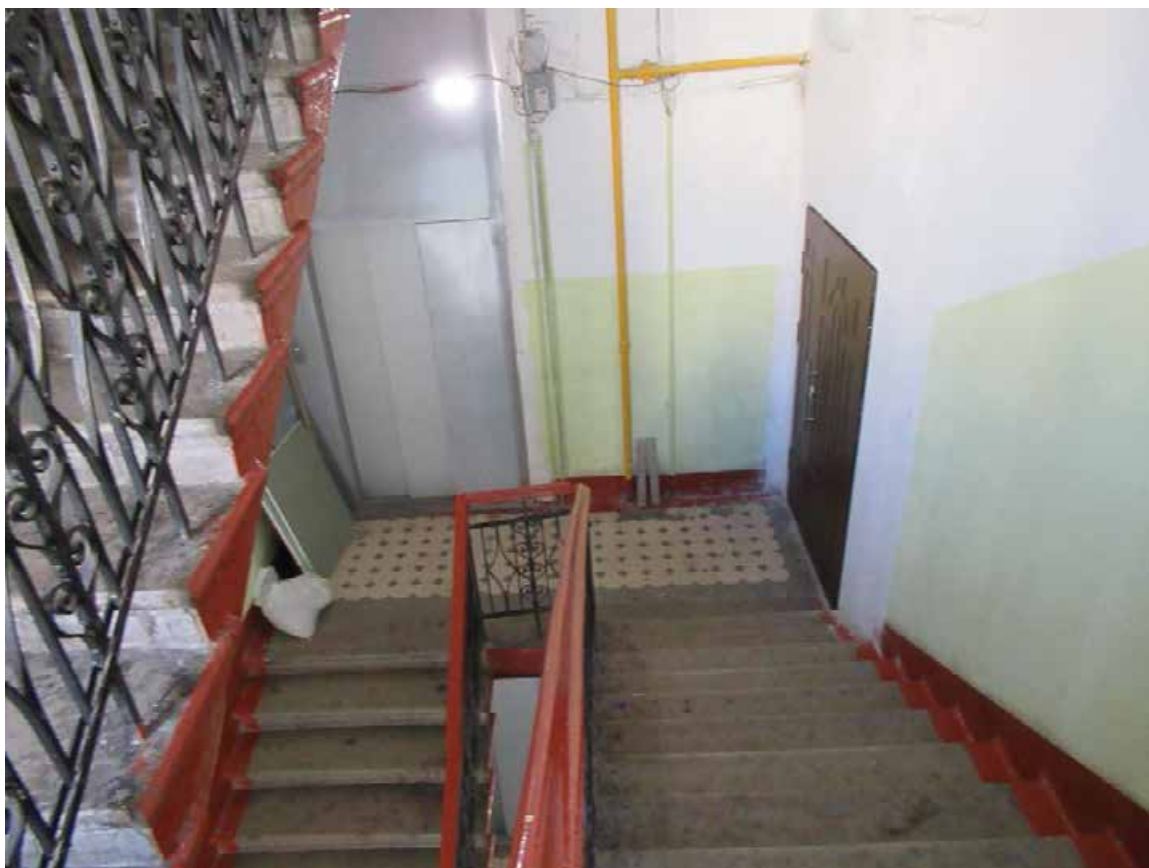
66. 12-я линия В.О., 19. Дом О.М. Фогт и Б.А. Попова. 1ЛК, вид сверху на лестничную клетку с квартирами и лифтом.
