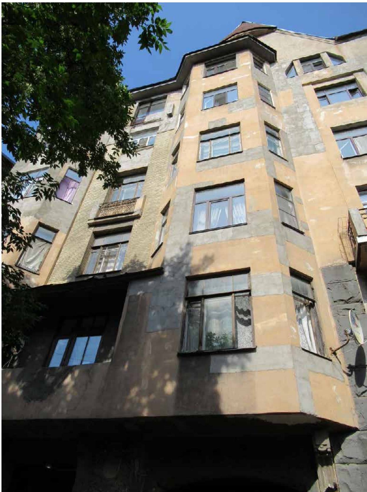
17. 12-я линия В.О., 19. Дом О.М. Фогт и Б.А. Попова. Вид снизу на эркер центральной части лицевого фасада.
