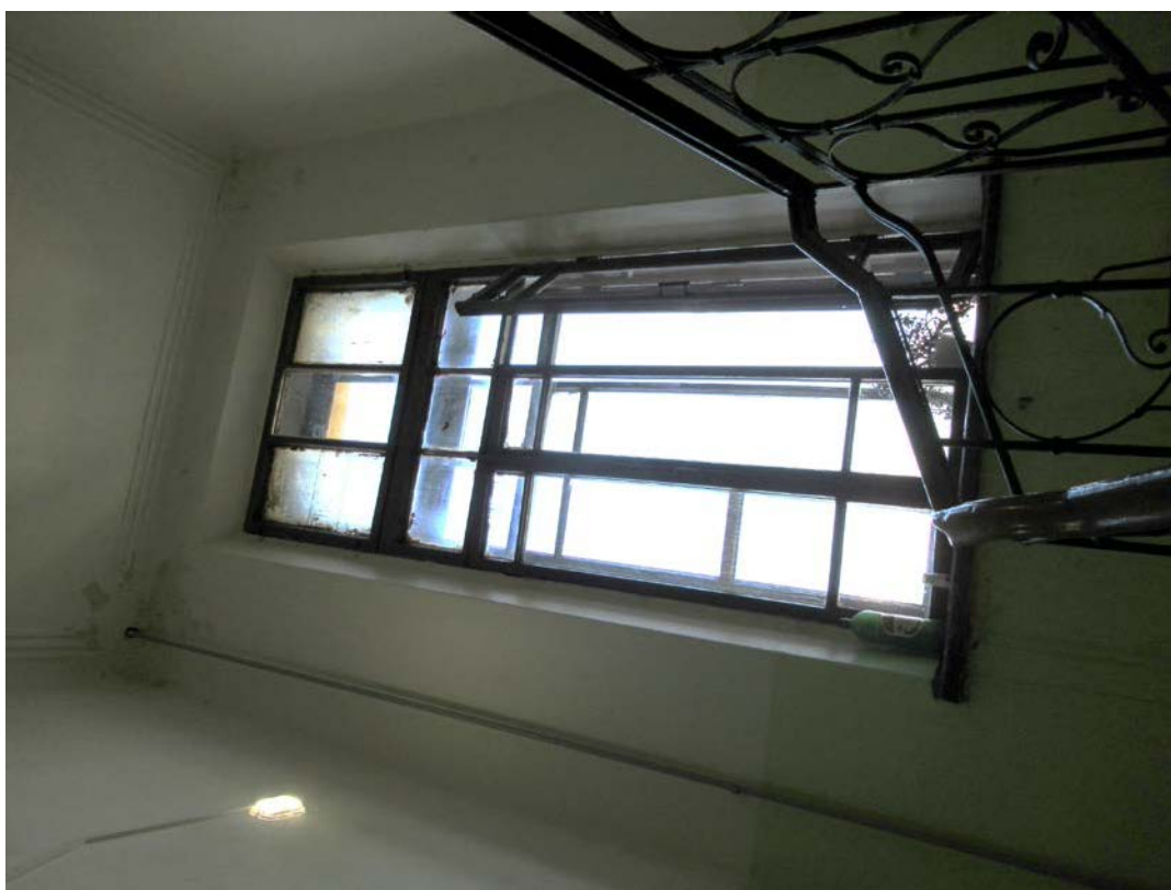
86. 12-я линия В.О., 19. Дом О.М. Фогт и Б.А. Попова. 3ЛК, окно во двор с историческим заполнением между 5-м и 6-м этажами.
