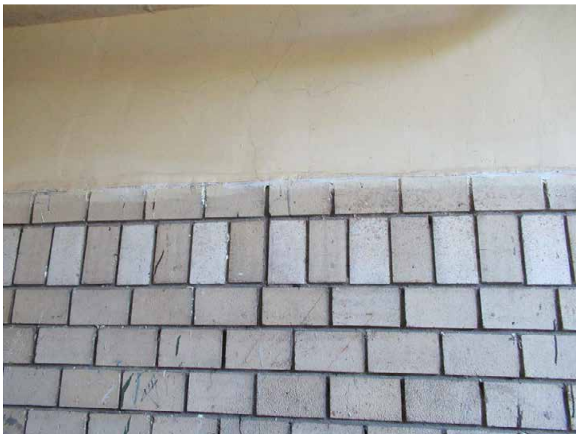
42. 12-я линия В.О., 19. Дом О.М. Фогт и Б.А. Попова. Фрагмент отделки стенки воротного проезда поперечного корпуса – декоративная плитка и штукатурка.
