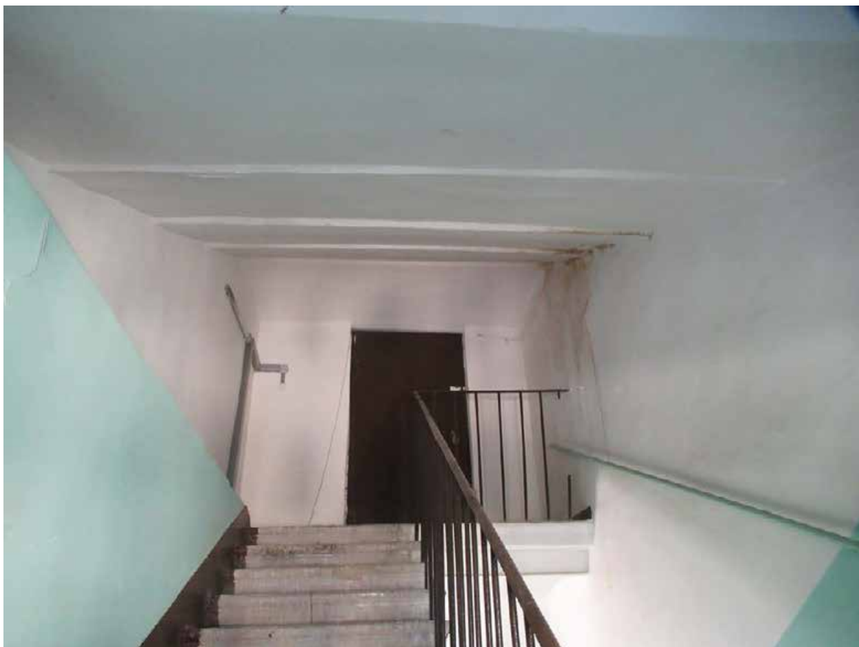
102. 12-я линия В.О., 19. Дом О.М. Фогт и Б.А. Попова. 5ЛК, вид сверху на лестничную площадку чердака.
