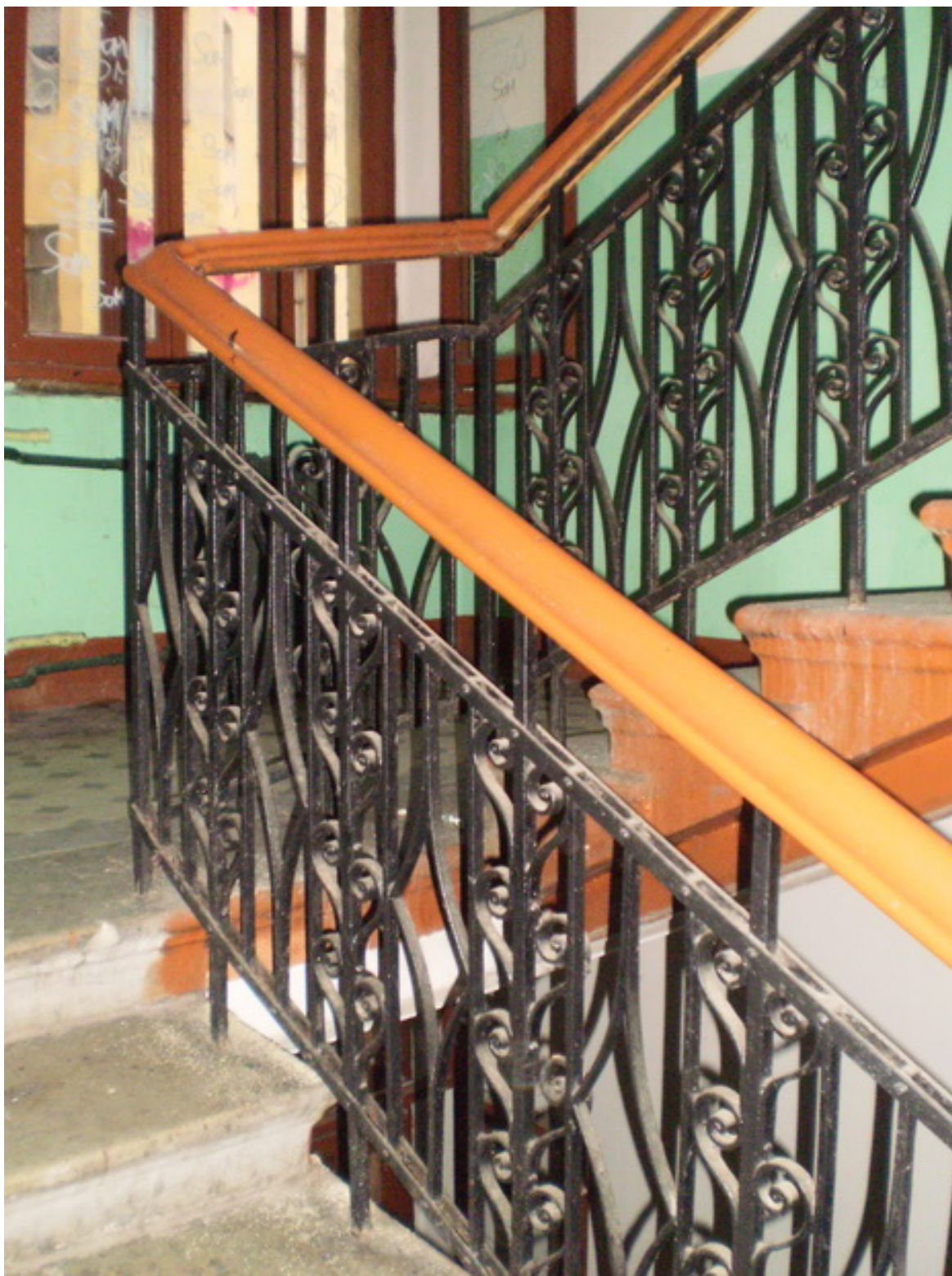
39. Парадная лестница (1ЛК). Вид на лестничную площадку с металлическим ограждением и метлахской плиткой. Фото 2011 г. https://www.citywalls.ru/house5879.html
