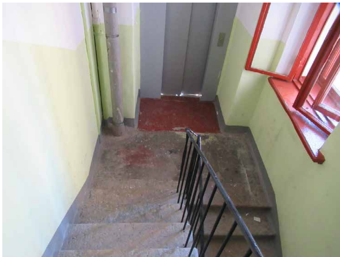
92. 12-я линия В.О., 19. Дом О.М. Фогт и Б.А. Попова. 2ЛК, вид сверху на лестничную клетку с лифтом.
