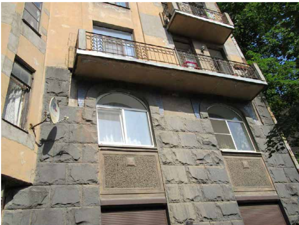
7. 12-я линия В.О., 19. Дом О.М. Фогт и Б.А. Попова. Вид снизу на нижнюю часть южной части лицевого фасада.
