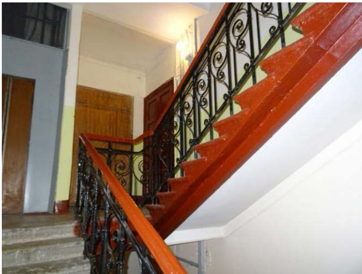
45. ЗЛК. Вид снизу на лестничную площадку. Фото 2015 г. https://www.citywalls.ru/house5879.html
