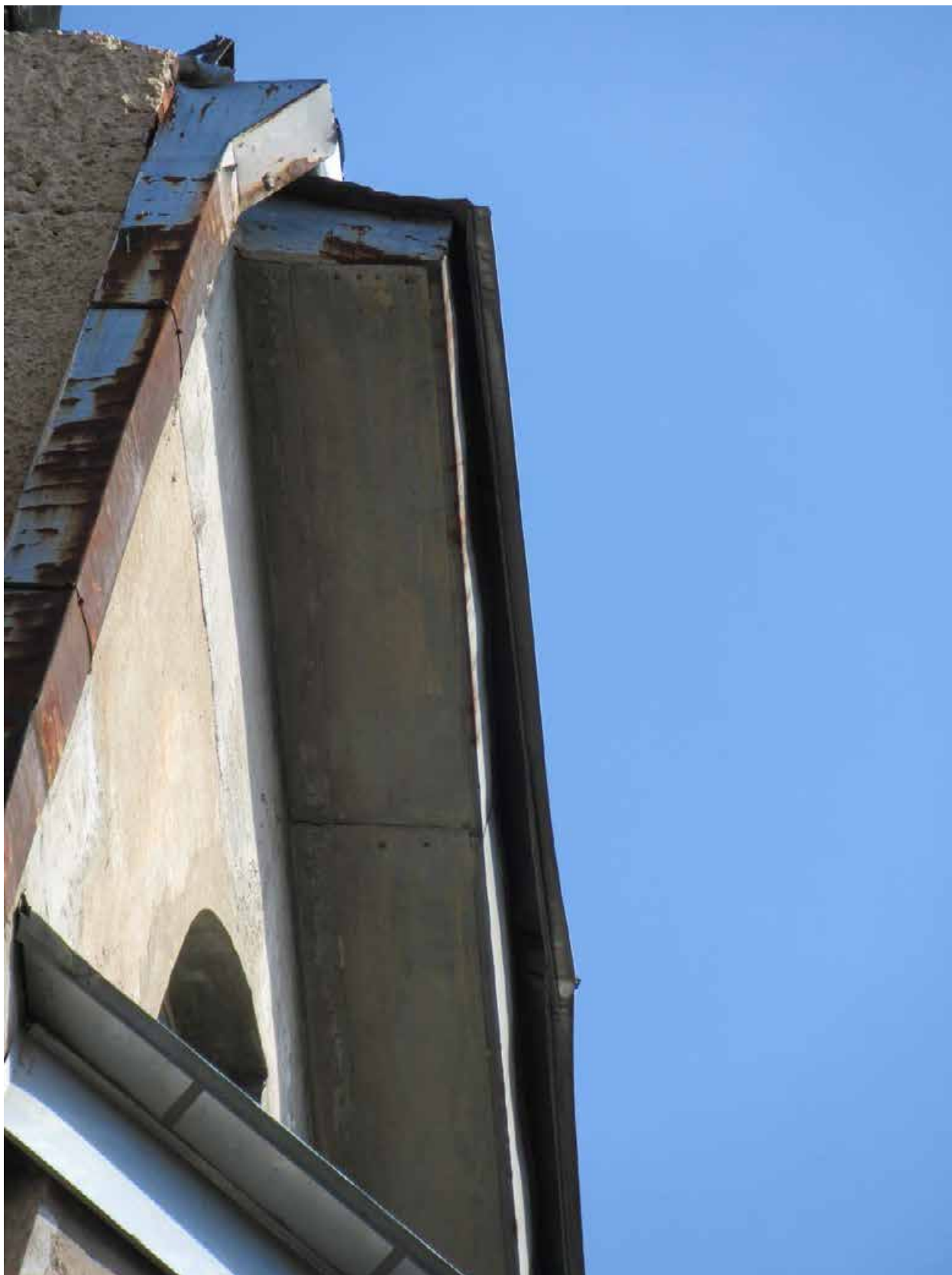
25. 12-я линия В.О., 19. Дом О.М. Фогт и Б.А. Попова. Венчающий карниз лицевого фасада.
