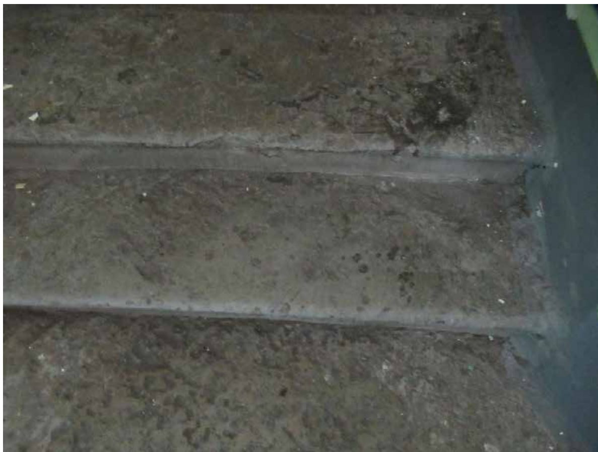
91. 12-я линия В.О., 19. Дом О.М. Фогт и Б.А. Попова. 2ЛК, ступени лещадной плиты.
